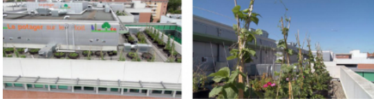
Figure 1. 200 jardinières et 500 m2 de surface potagère recouvre le toit de l'atrium, un bâtiment de cancérologie de la CP.
