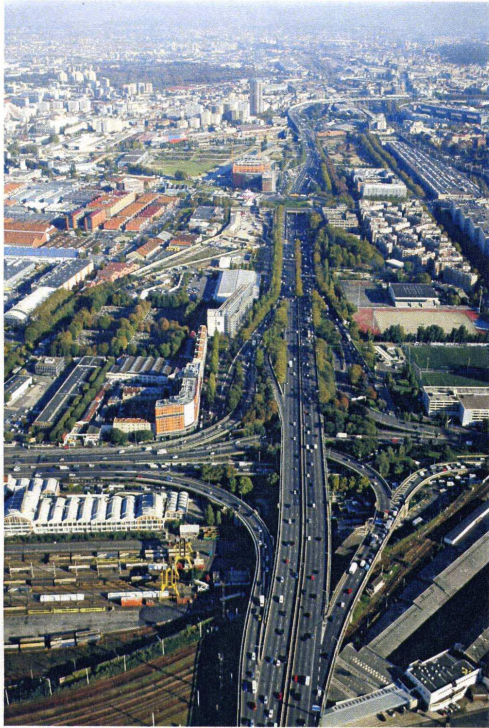
Photos aériennes périphérique depuis la Porte de la Chapelle vers l'Est
