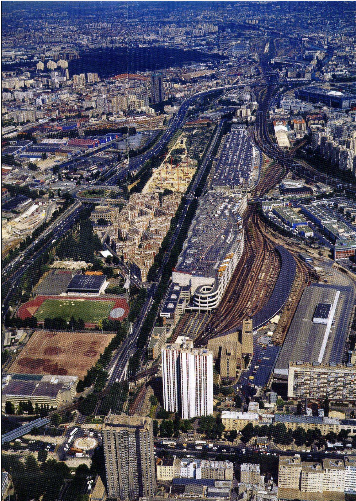
Photographie aérienne du secteur Paris Nord-Est. Document Agence Dusapin/Leclercq.
