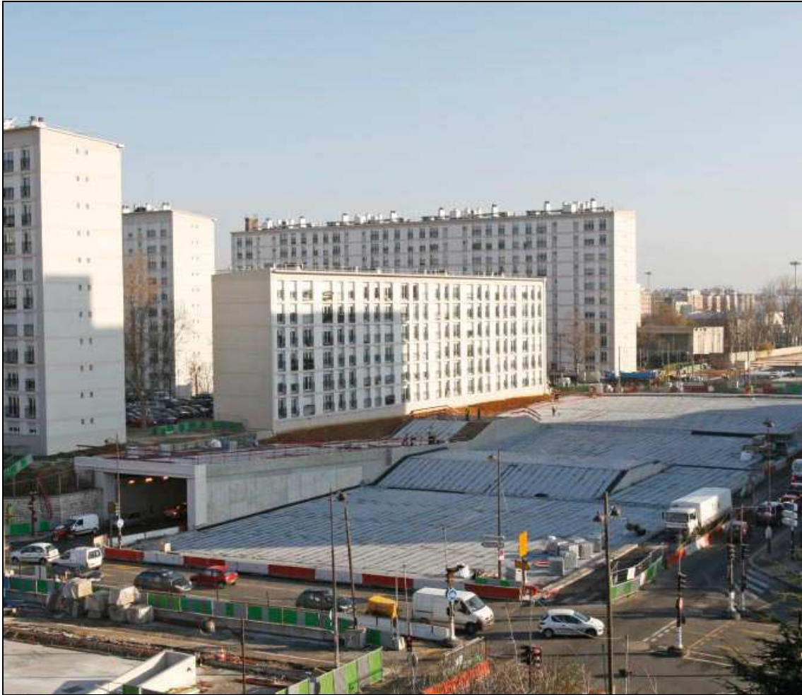
Les travaux de construction de la couverture démarrés en juin 2006 et achevés en janvier 2008. PARIMAGE – Photo : DR.
