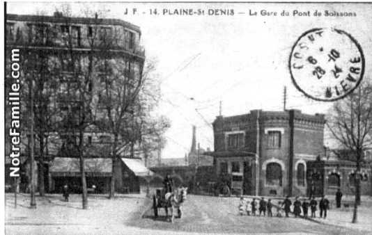
La gare du Pont de Soissons (ex gare RER B)
