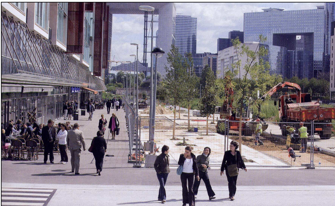
Images de synthèse des premiers secteurs des Terrasses et photographie sur chantier. Documents TGT - EPASA.
