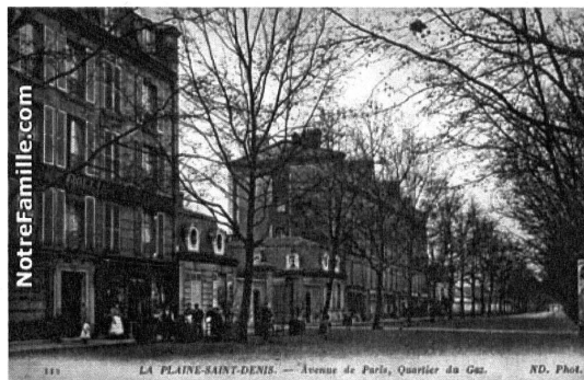
Le quartier du gaz, avenue de Paris (en démolition)
