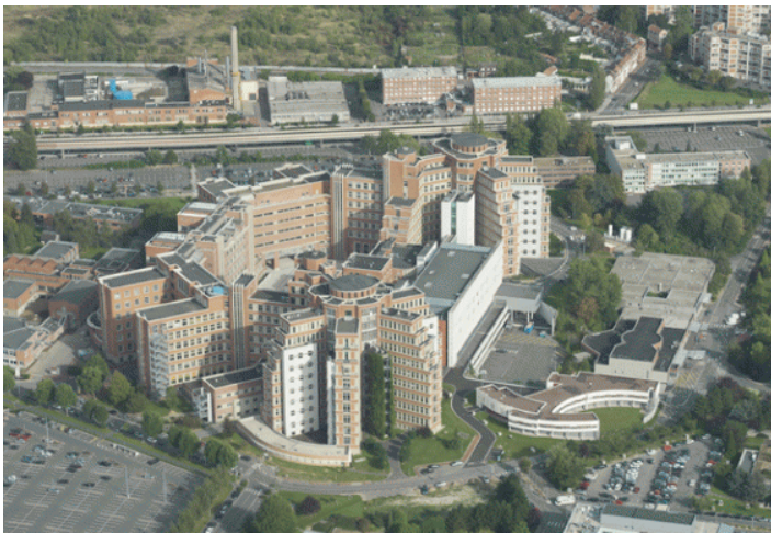
La cité hospitalière (Cassan, Madeline et Walter, architectes)
