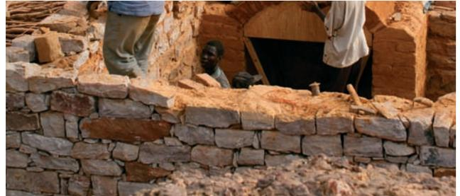
Ce type de mur, réalisé à Koundou, a un aspect pierres sèches calées par des petites pierres à l'extérieur, et est enduit à la terre à l'intérieur. Il est maçonné à la terre entre les deux parois de pierre en faisant attention de ne pas faire déborder le mortier côté extérieur.
