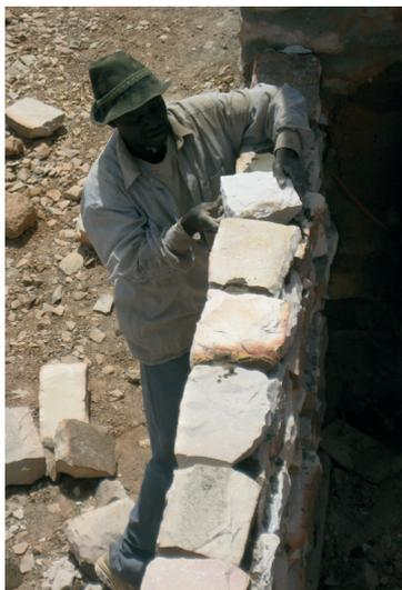
Il est préférable de poser le rang de pierres à sec pour trouver leur bonne disposition avant de mettre le mortier.
