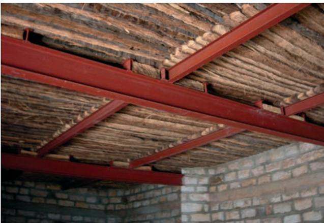
Sur les murs en briques ou en terre, il faut installer une planche ou une pierre plate assez longue sous les poutres pour répartir les charges de la poutre sur une plus grande portion de mur.
