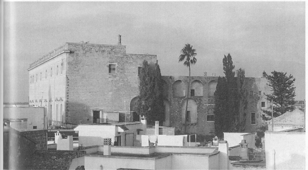
Cortile del "castello" (foto L. Manni). Veduta del "castello".
