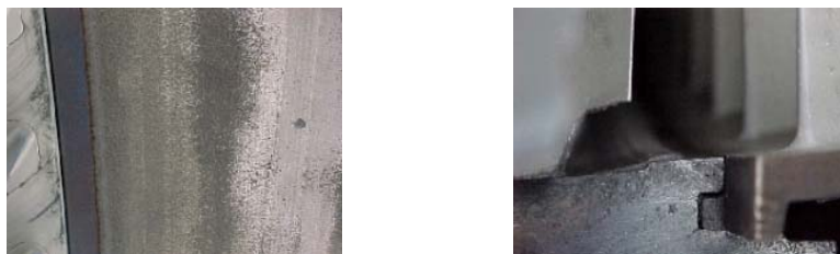
Figure 1. Dégradations observées sur les composants d'un compresseur de TAC lors d'un rubbing : (à gauche) trace de frottement => perte de rendement, (à droite) dégradation du sommet des aubes => risque de dégradation des étages supérieurs du compresseur et voire même de la turbine de détente.
