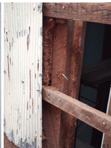
Fig. 10 Imagen revestimiento exterior del tabique-adobillo, fuente: autores
