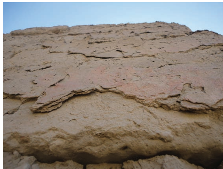
Fig. 7 Superficie conservada después de la aplicación en campo
