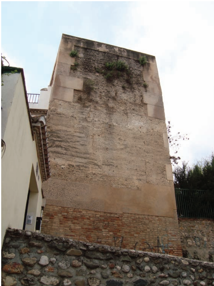
Fig. 8 Intervención en el Castillo de Aroche
