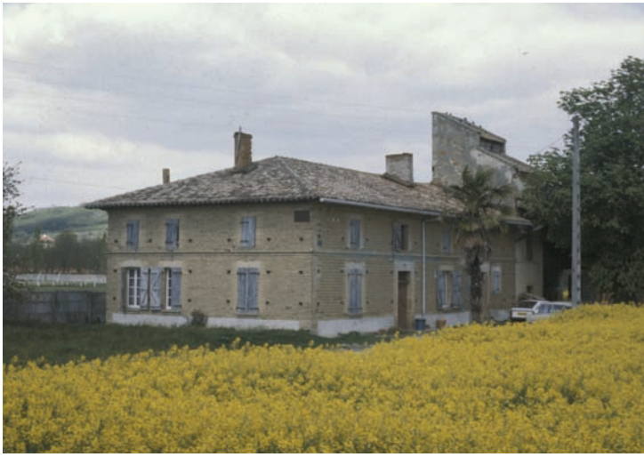
Fig. 9 Ferme en brique crue (adobe) dans le Gers, sud-ouest de la France, photo : Hubert Guillaud
