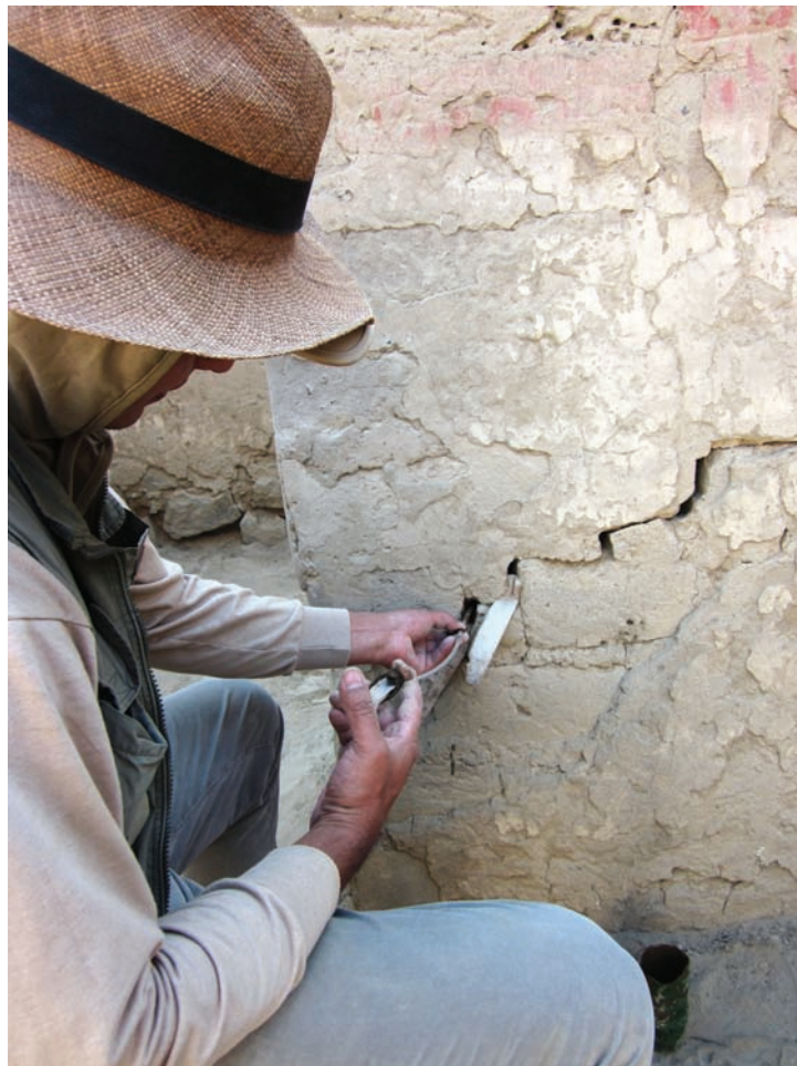
Fig. 5 Conservación estructural aplicando grouts de barro liquido en grietas
