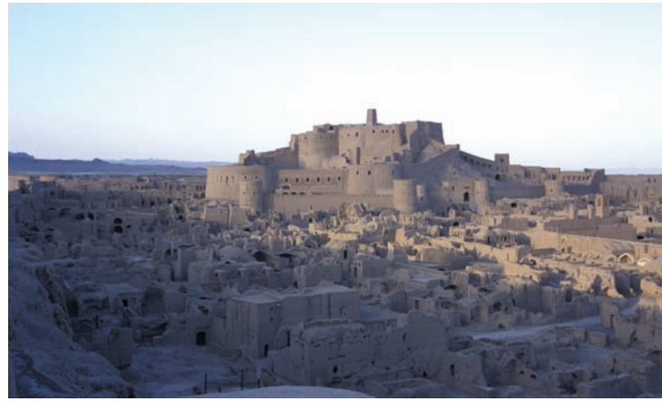
Fig. 4 La citadelle de Bam en Iran avant le séisme de 2003, photo : CRAterre, H. Guillaud, 2002
