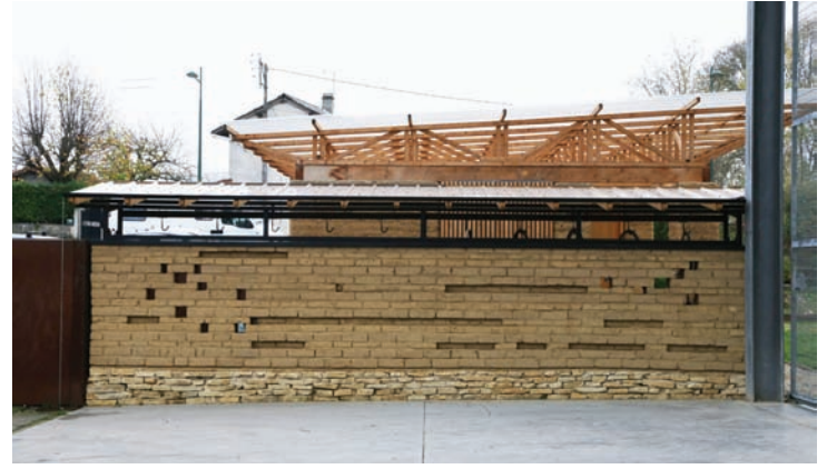
Fig. 2 Abri à vélo résultat de l'atelier « Jeux d'adobes » autour de l'exploration de la brique de terre crue, photo : amàco
