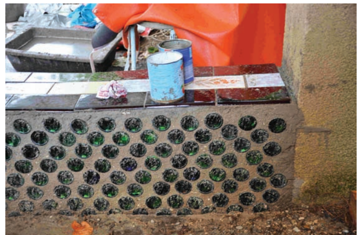
Fig. 3 Mur de soubassement (terre et bouteilles)
