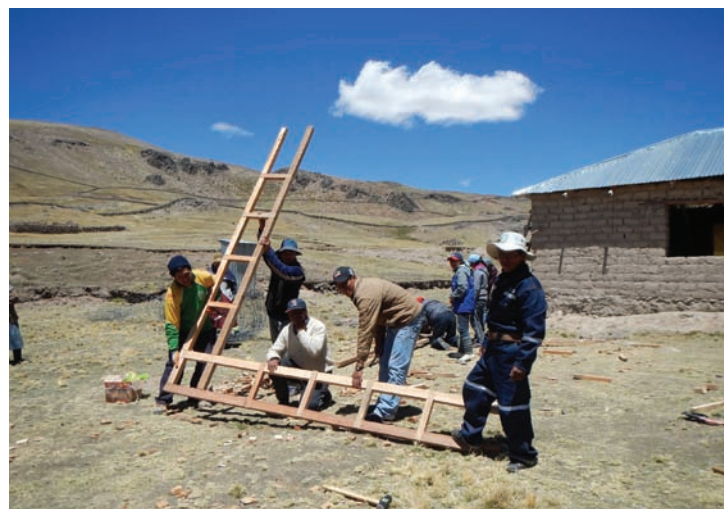
Fig. 5 Taller de refuerzos sismo resistentes
