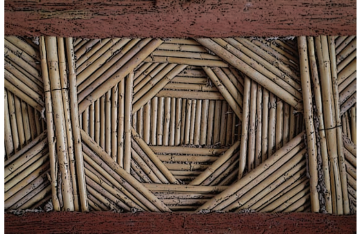
Fig. 6 Plafond en roseaux composé de six lits, photo : Boussalh
