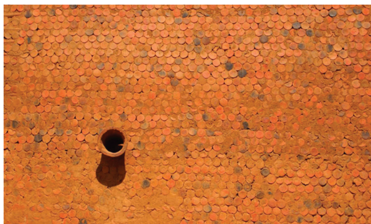
Fig. 8 Parement de mur réalisé par des cônes en poterie
