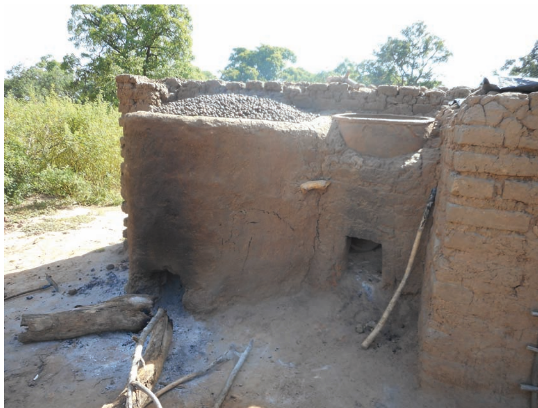
Fig. 1 La terre sert aussi pour des constructions à vocation technique, ici des fours utilisés pour le séchage des noix de karité
