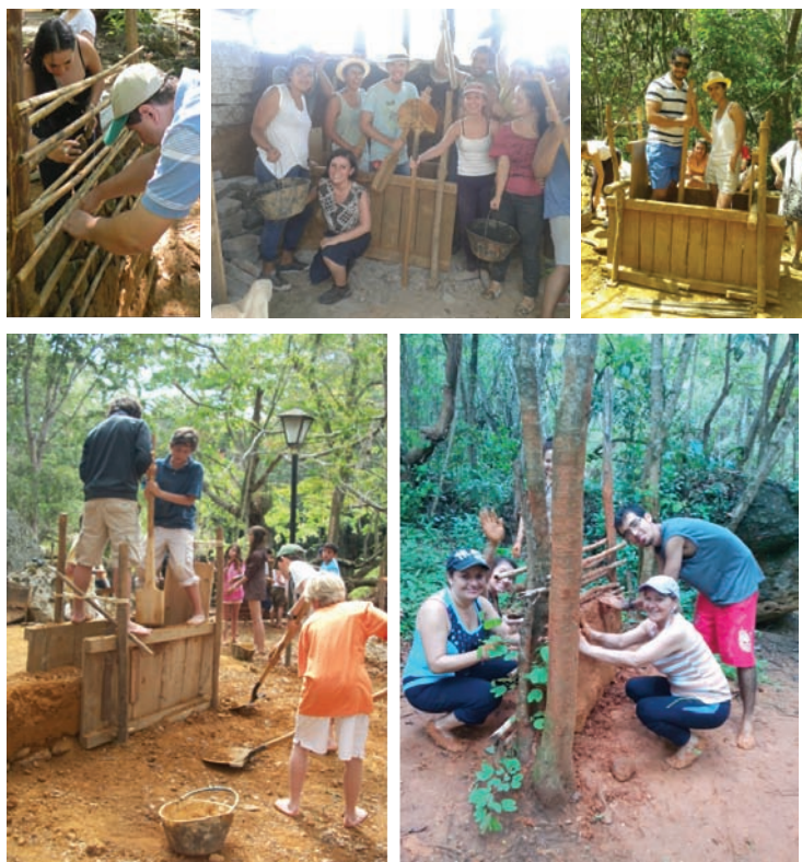
Fig. 8 - 9 Talleres de construcción con tierra
