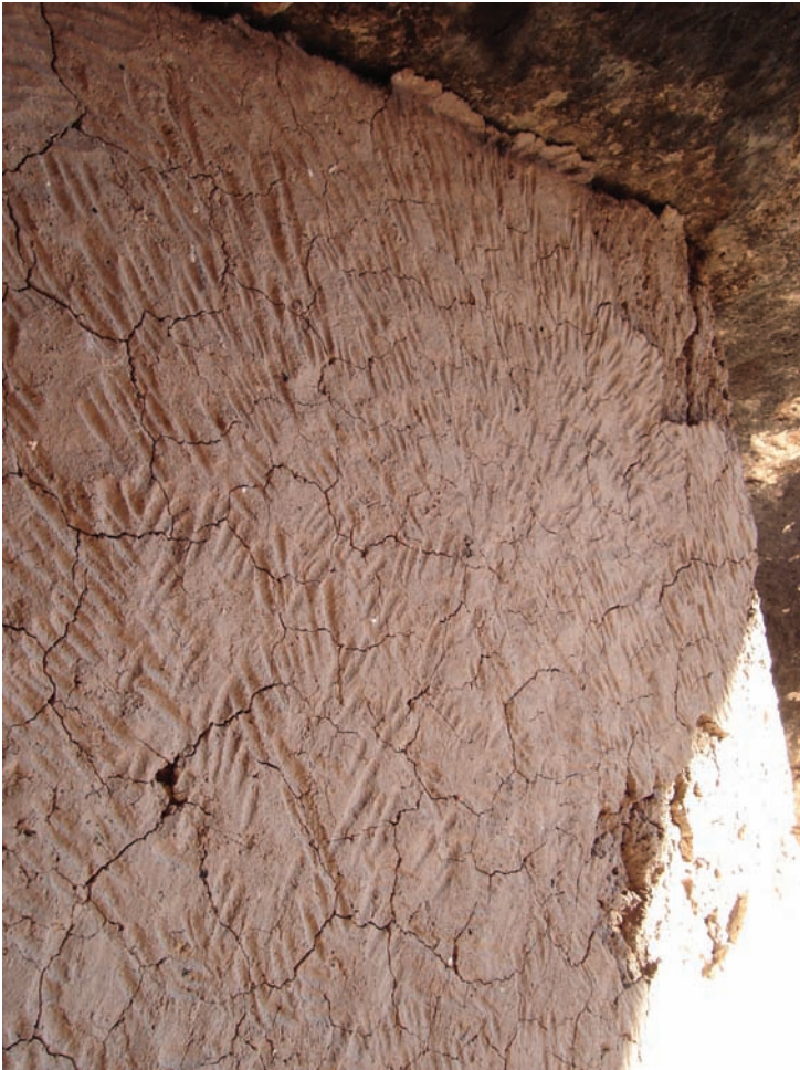
Fig. 5 Huellas presentes en el revestimiento de un muro. Cuevas de El Embudo, Chihuahua, foto: Autor, 2014
