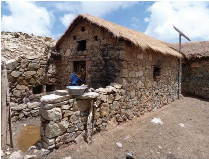
Fig. 3 Detalle una cocina construida en piedra y barro en una casa rural del área puneña, foto: propia
