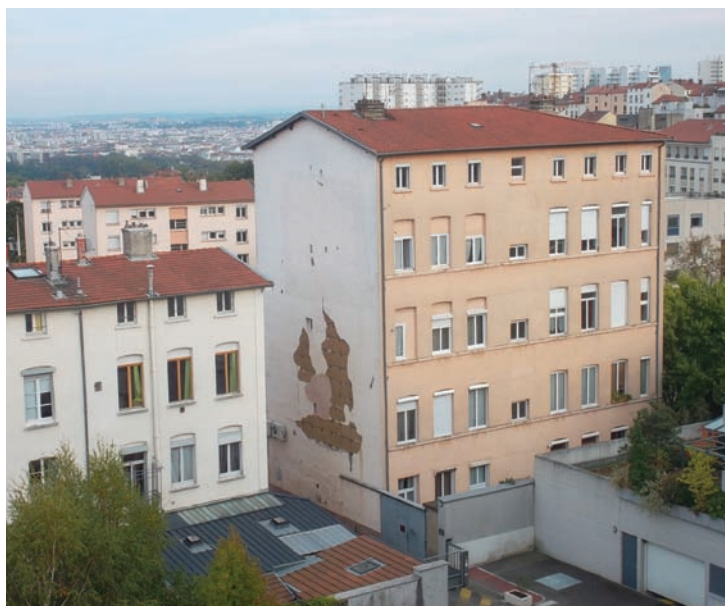
Fig. 6 Immeuble d'habitation de cinq niveaux autrefois utilisé par des tisserands (canuts lyonnais) situé au 43, rue Coste à Caluire-et-Cuire. Le mur pignon est en pisé de terre et de mâchefer. Photo : Emmanuel Mille
