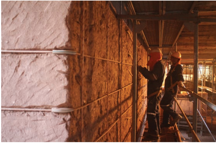
Fig. 5 Colocación de sogas tensadas
