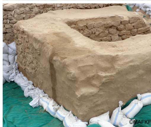
Fig. 10 Réfections 2014 et 2015 au mortier de terre laissé à nu, Tour 2, photo : ©MAFKF
