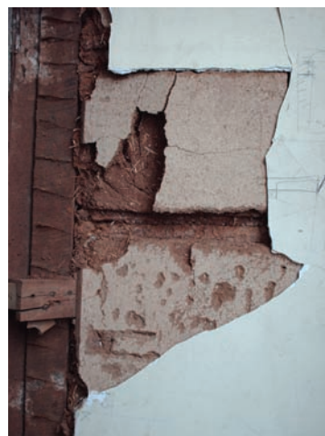
Fig. 9 Imagen revestimiento interior del tabique-adobillo, fuente: autores
