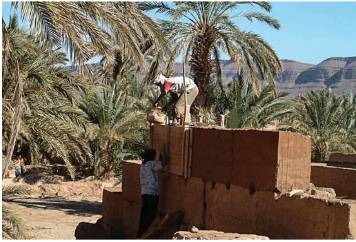
Fig. 2 Louh/about/technique de construction utilisée largement dans l'Atlas et les vallées, photo : Barjali
