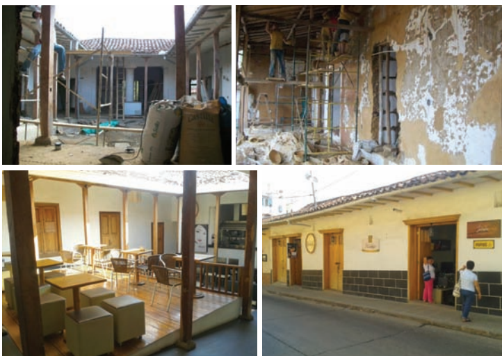
Fig. 5 - 6 Casa Jairo Cordero antes y después de la intervención, respectivamente
