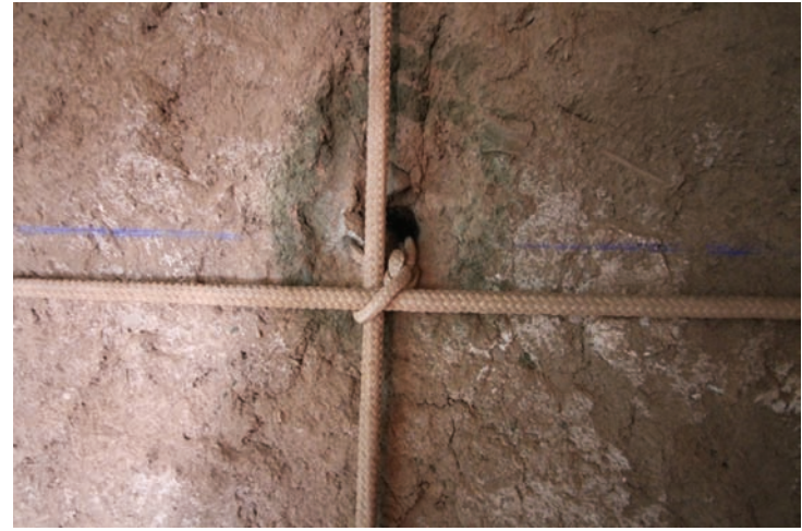
Fig. 6 Las mallas de cada cara se unen entre sí
