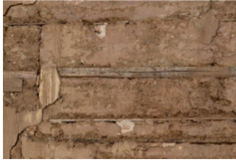
Fig. 7 Tapia del caso 1, con elementos horizontales de madera
