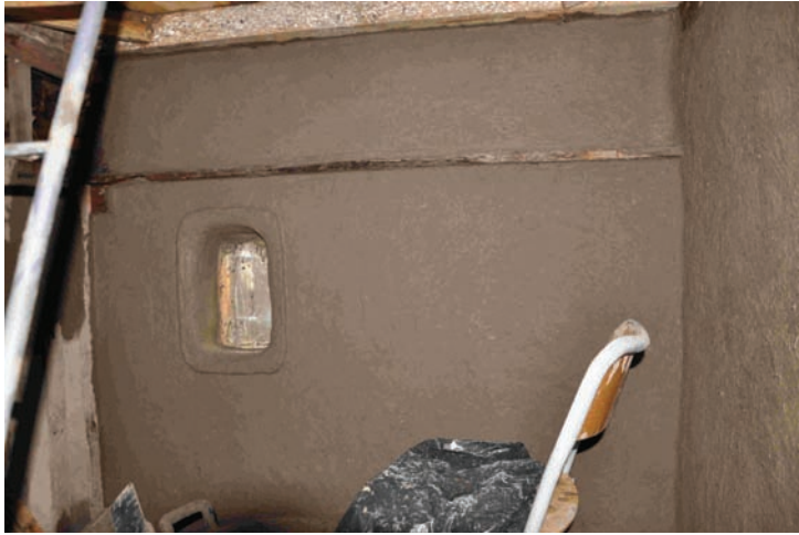
Fig. 1 Torchis et enduit terre dans la cabane palette
