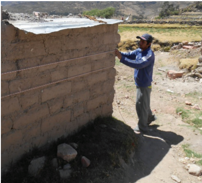
Fig. 6 y 7 Sesión práctica de colocación de cuerdas horizontales y verticales en muro de cerco
