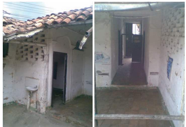
Fig. 2 Casa Bárbara Rodríguez antes de la intervención
