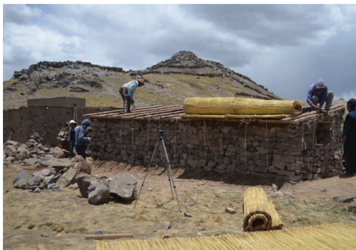
Fig. 4 Intervención en cabaña Quella Quella
