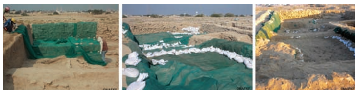
Fig. 9 Consolidation et protection réversible sur le rempart nord, photo : ©MAFKF
