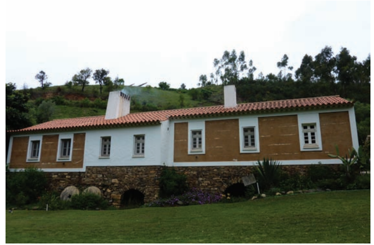
Fig. 4 Monte do Reguenginho. T. Beirão project
