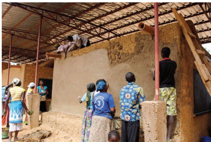
Fig. 4 Les apprentis travaillent avec les artisans sur la première couche des enduits
