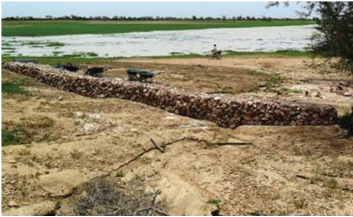
Fig. 10 Réalisation d'un mini barrage sur le site de Djenné Djeno
