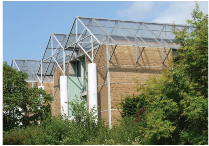
Fig. 10 Le Domaine de la terre, 65 logements sociaux en terre, Villefontaine, Isère, construits en 1985, photo : Thierry Joffroy
