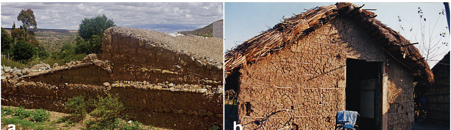
Fig. 3a Vivienda en Yavi Chico, Jujuy (tapial y adobe) / 3b Vivienda en Bella Vista, Tucumán (Entramado de quincha)
