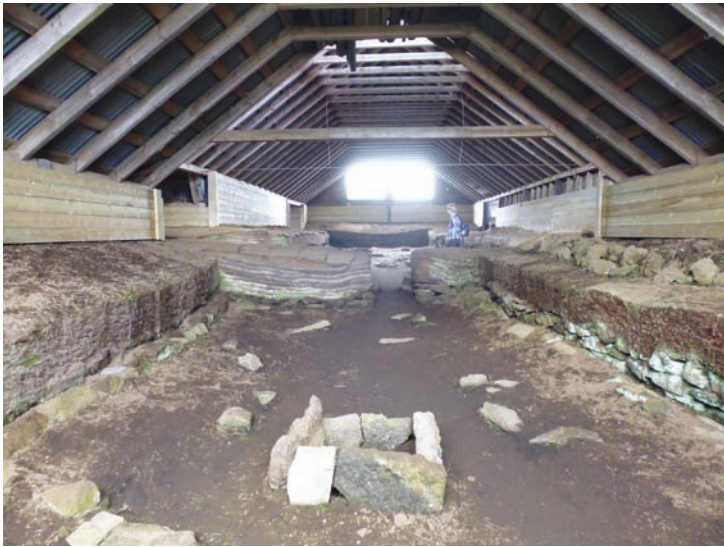
Fig. 5 Le site de Stöng recouvert d'une structure en bois
