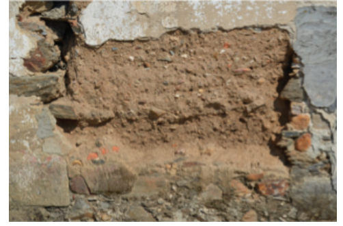
Fig. 8 Tapia del Caso 3, sin refuerzos estructurales
