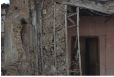
Fig. 6 Tapia del caso 2, pallabarro con cantos rodados
