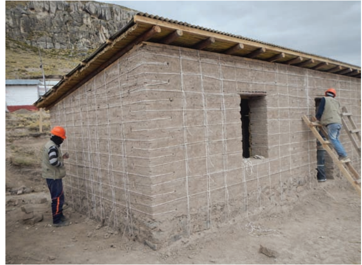
Fig. 7 Prototipo de vivienda en construcción
