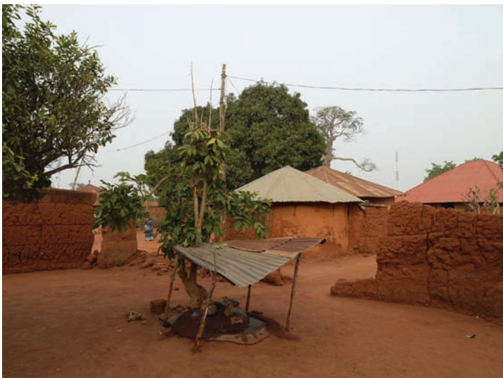
Fig. 8 et 9 Vue de l'intérieur de Dossoeme avant et après les travaux
