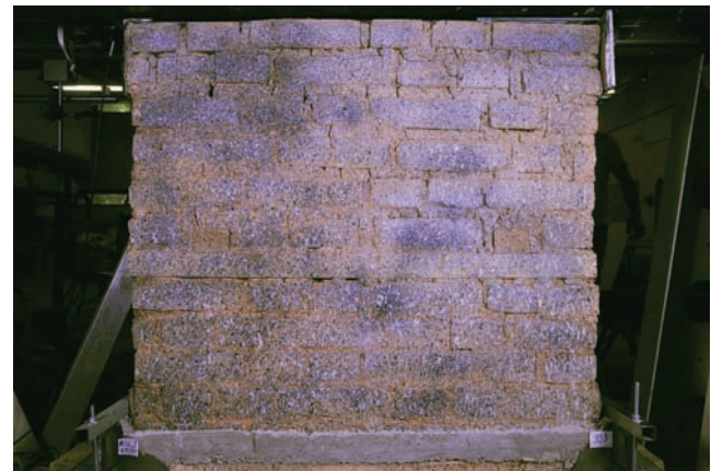
Fig 10 Échelle réelle essai cyclique (a. mur en adobe, b. champs de déplacement)
