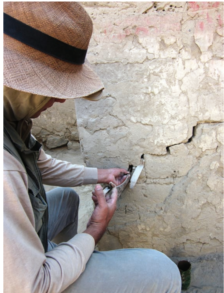
Fig. 5 Conservación estructural aplicando grouts de barro liquido en grietas
