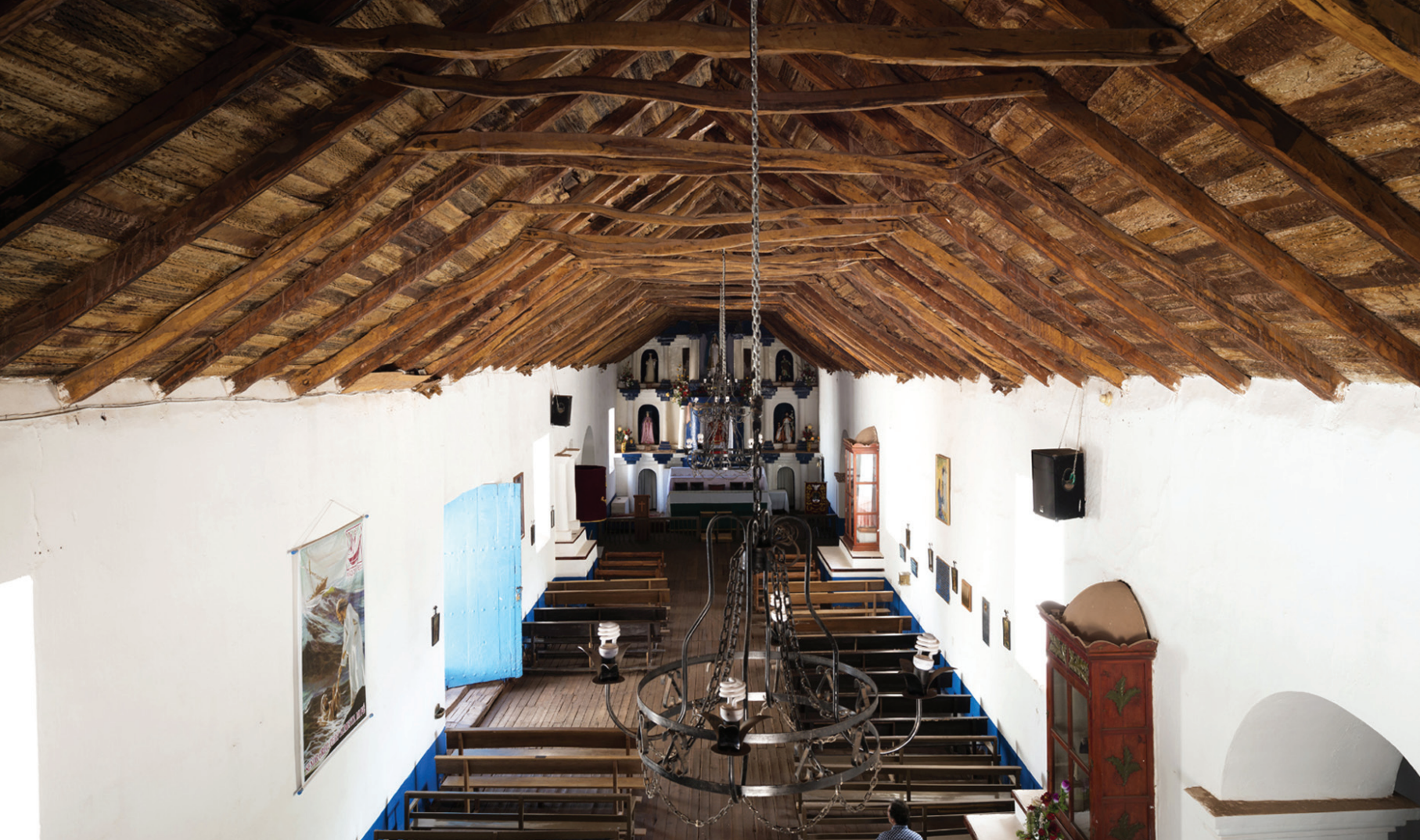
Fig. 3 Techo de par y nudillo con entablado de cactus
