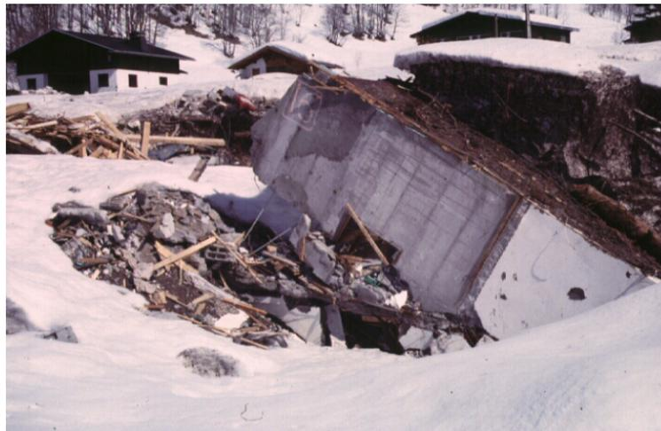
Figure 9 : Mur en béton globalement intègre mais basculé et déplacé faute d'appuis suffisants (défaut de stabilité externe)
