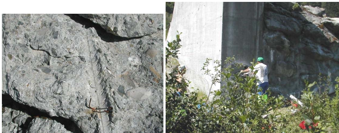
Figure 17 : Empreinte d'armature et granulats rompus dans les zones de fracture, prélèvement de béton
