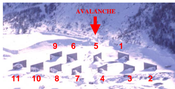
Figure 12 : Numérotation des dents déflectrices de Tacconnaz
