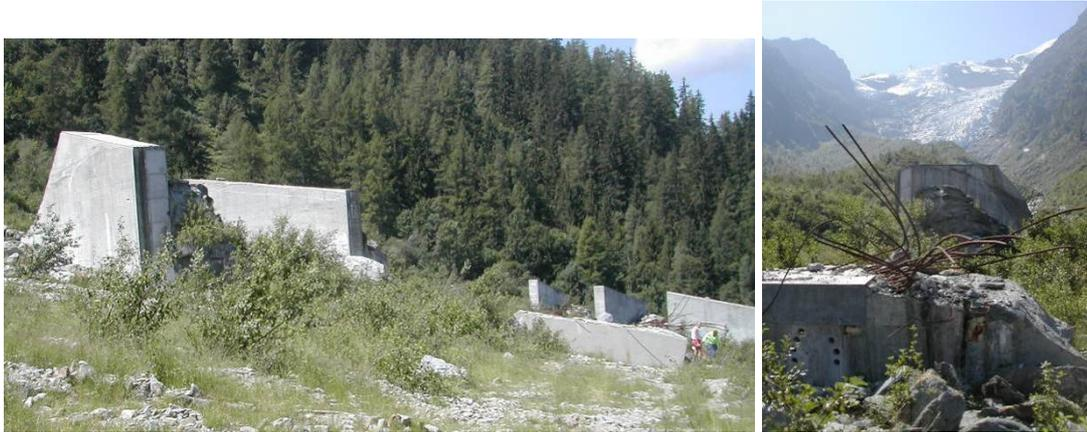
Figure 13 : Dent amont (9) et son coin arraché, vue latérale et aval (PBR)
