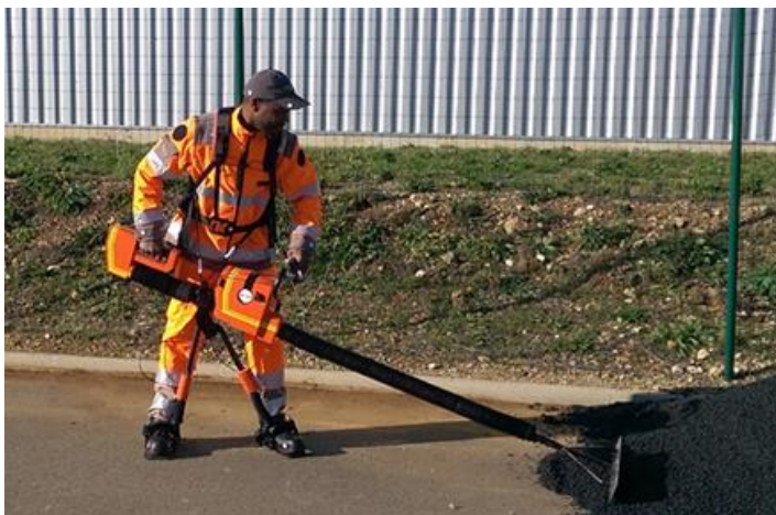
Figure 37. Travaux de BTP assistés par Exopush 2 (Crédits RB3D)
