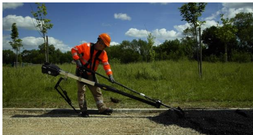
Figure 40. Travaux de TP assistés par Exopush 4 (Crédits Colas -Sphère communication)
