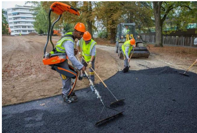
Figure 14. Exopush 1 avec bras et jambes robotisés (Crédits photos Colas)
