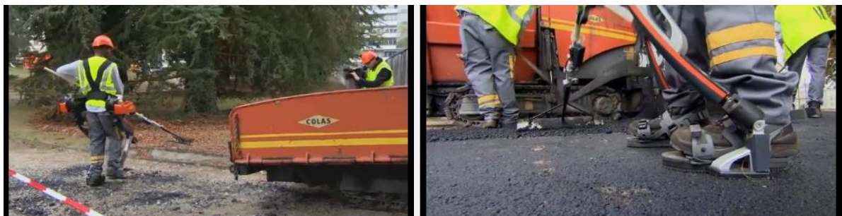
Figure 19. Utilisation de l'exosquelette Hercule par Colas (Crédits photos Colas)
