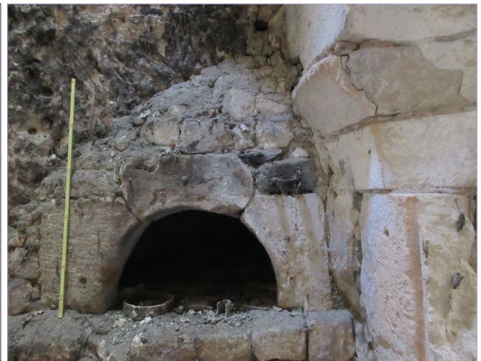
Fig. 100 à 102 - La cheminée de la grande salle (15 e s. ?), avec détail du corbeau de gauche (en bas à gauche) et de l'ouverture du four (en bas à droite)
