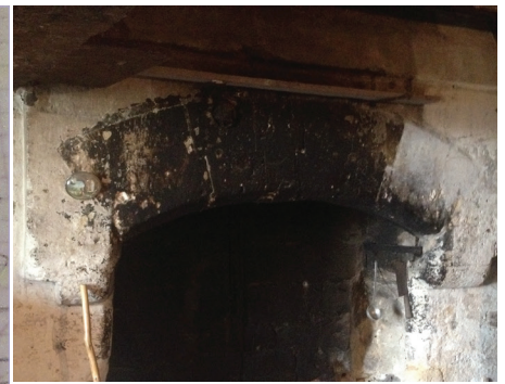
Fig. 103 - Cheminée à arc surbaissé du Moulin Blanc (SP_019), datée du 14 e s. (Déodat 2016)
