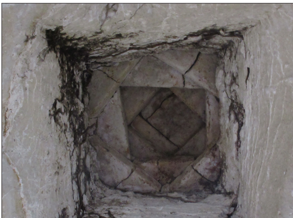
Fig. 109 et 110 - Vestiges de la grande salle seigneuriale : conduit de cheminée et ouverture en tronc de pyramide
