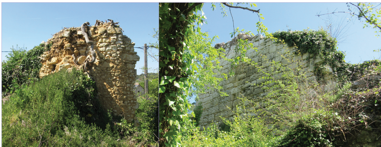
Fig. 111 et 112 - Vestiges extérieurs de la Seigneurie de Sarreau : à droite, mur en petit appareil de tuffeau, avec deux meurtrières médiévales
