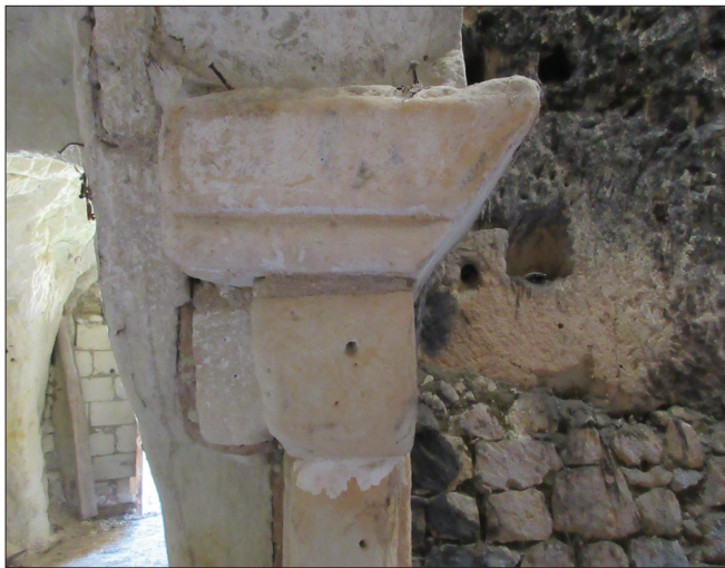
Fig. 100 à 102 - La cheminée de la grande salle (15 e s. ?), avec détail du corbeau de gauche (en bas à gauche) et de l'ouverture du four (en bas à droite)
