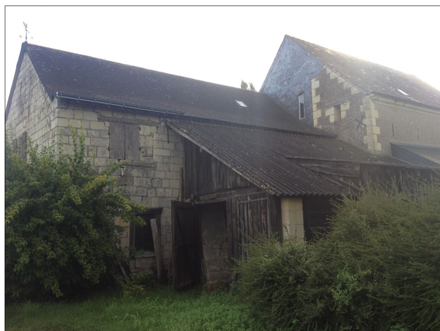
Fig. 12 - Le mur nord du bâtiment avec sa baie d'origine à l'étage, remodelée. Un des contreforts 19 e s. est visible derrière la porte - cliché R. Pichot
