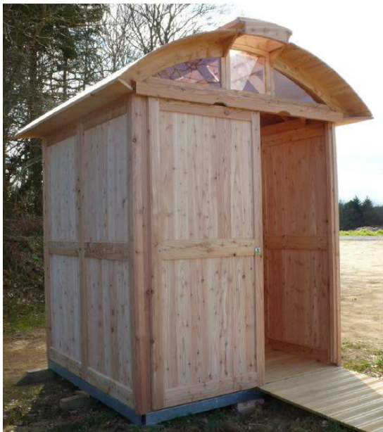
Figure 11: Cabine en bois démontable, TLB accès PMR. Photographie : Humusséo
