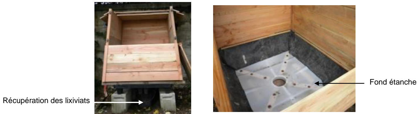
Photo 1 : Composteur de Gigondas, aire étanche à gestion optimisée (vues extérieure et intérieure)
