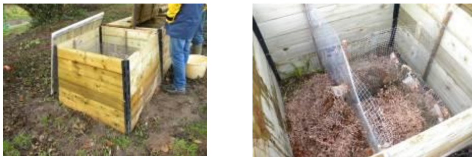
Photo 2 : Composteur de Kergrist, aire non étanche (vues extérieure et intérieure) à gestion à minima (3 compartiments)
