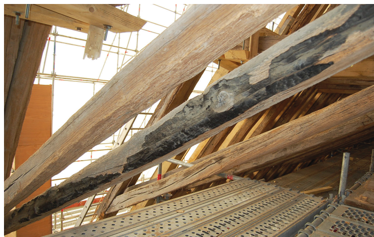
Fig. II-3 > Traces de carbonisation de l'écharpe nord de F49 (1230 BF).
