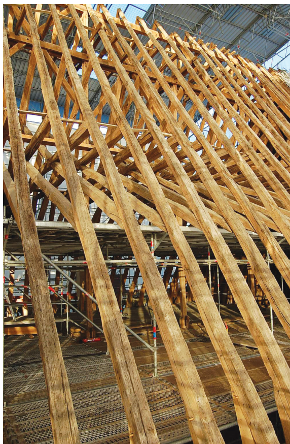
Fig. II-8 > Chevrons du chœur, avant restauration.
