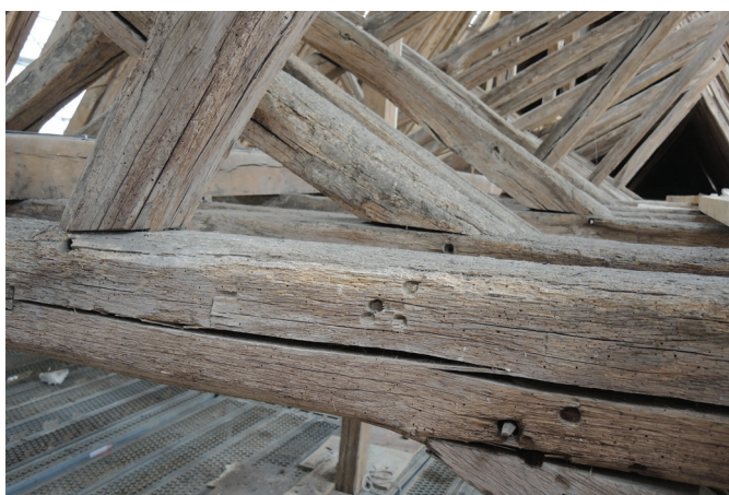
Fig. IV-1 > Cupules au droit des assemblages sur le faux-entrait de la ferme principale 142. Celles situées entre l'aisselier et la contrefiche correspondent au percement des pieds d'écharpe de fermes secondaires (au second plan) tandis qu'elles sont absentes au droit de la contrefiche.
