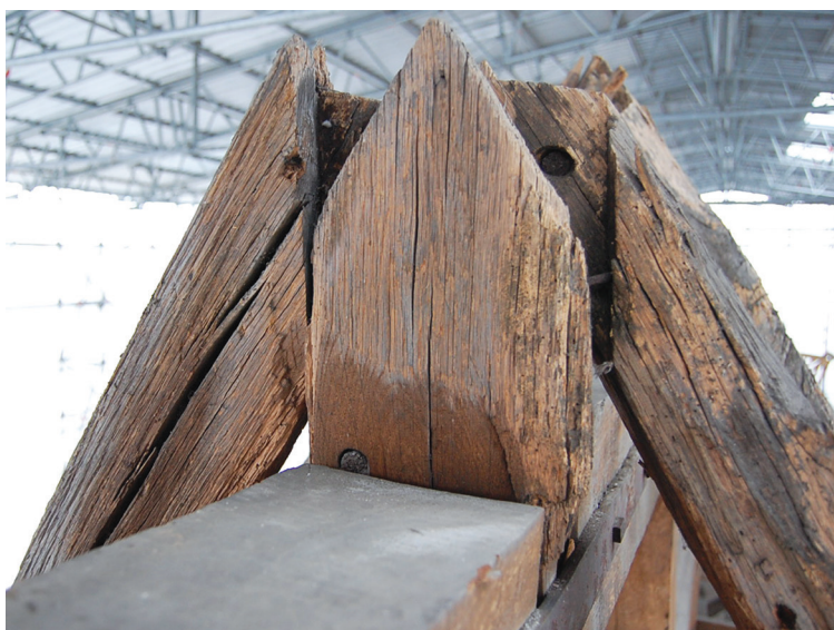
Fig. III-9 > Descente du poinçon de F117.
