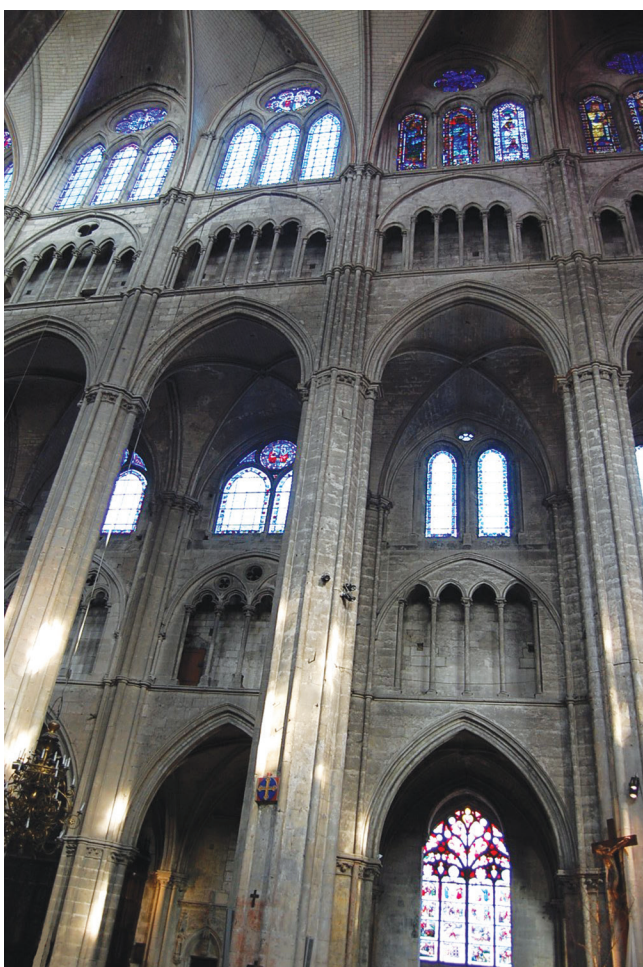
Fig. 1-6 > 8 e pile nord, marquant l'arrêt de chantier en partie haute entre le chœur à droite et la nef à gauche.
