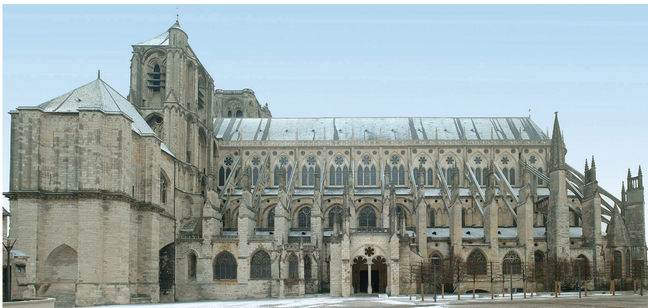
Fig. 1-5 &gt; Façade sud de la cathédrale.
