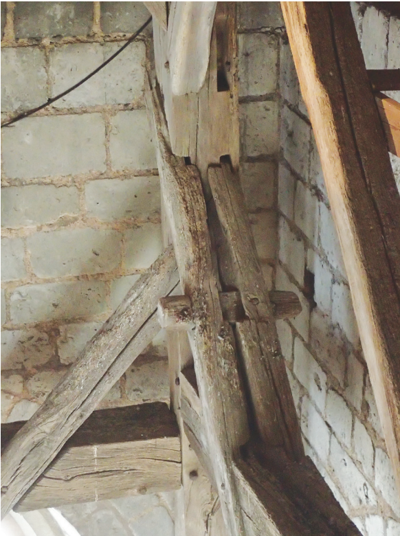
Fig. V-7 &gt; Écharpes doubles assemblées par des clavettes chevillées.
