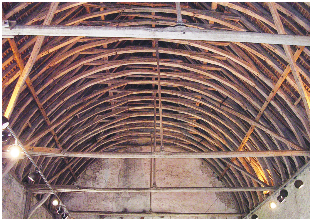
Fig. 11-37 > Charpente du XIII e siècle du logis comtal de Crépy-en-Valois (60), avec ses entrails et ses poinçons d'une extrême finesse.
