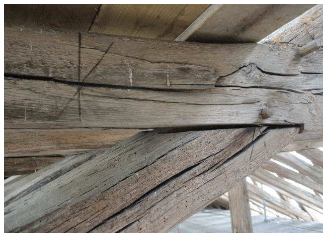
Fig. IV-9 > F134, marque X inscrite sur l'entrain retroussé et sur l'extrémité de l'aisseleur et de l'écharpe où elle est recoupée par la taille de l'assemblage.
