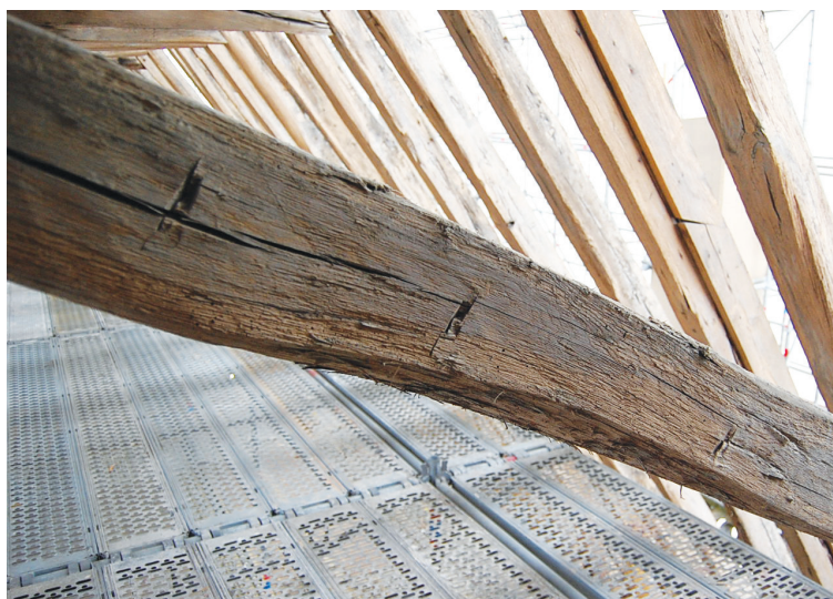
Fig. II-15 > Ferme 124, aisselier nord, traces d'ébauchage.
