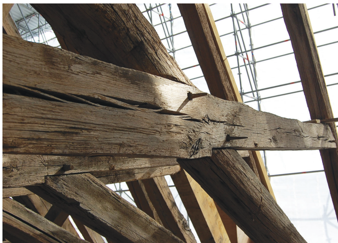
Fig. II-17 > Ferme 65, entrail retroussé délardé.
