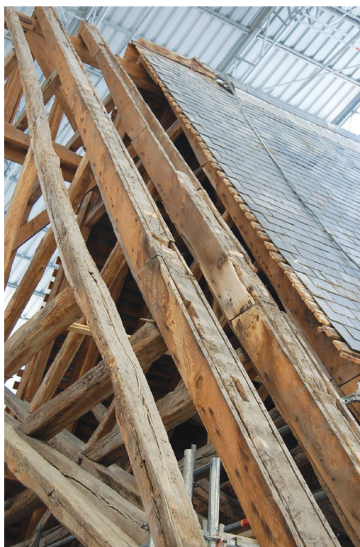
Fig. III-12 › Chevrons moisés par des planches, garnis d'une fourrure de pièces diverses en réemploi (au centre et à droite) et chevron mis à nu pendant la restauration (à gauche).
