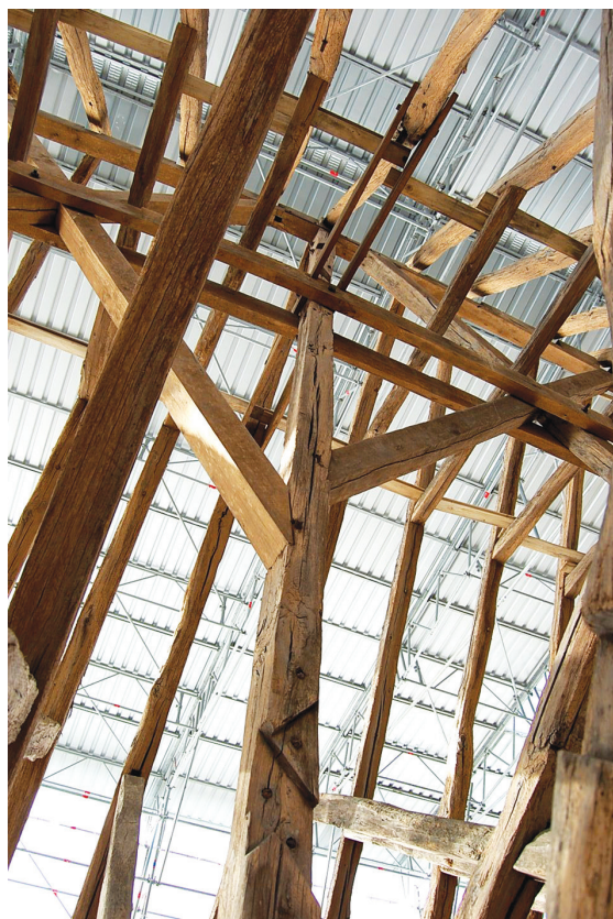
Fig. II-11 > Poinçon de la ferme 112, face nord.
