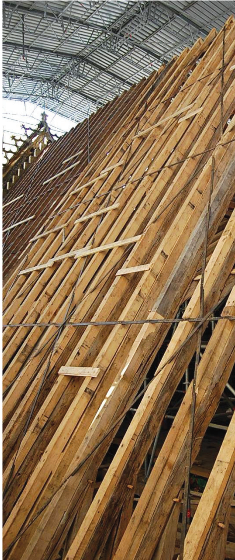
Fig. I-25 > Après restauration, les planches sont déposées et substituées par des fourrures qui viennent en appui sur les chevrons, déjà fortement fléchis, doublant leur épaisseur. Remplacement systématique d'un chevron d'un cinq avec des bois neufs. Pose de feuillards métalliques.
