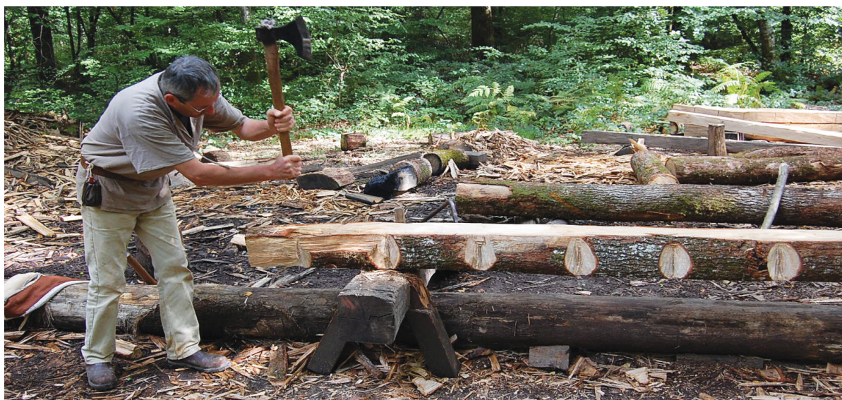
Fig. II-16 > Équarrissage d'une grume après ébauchage, chantier de Guédelon (Yonne).
