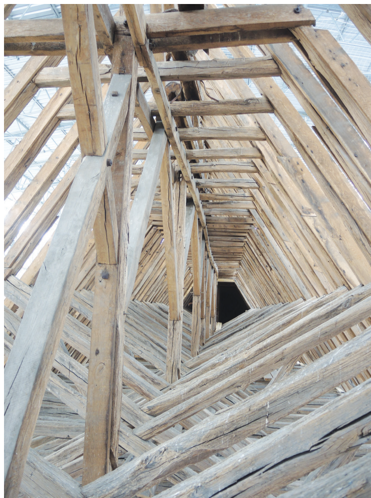
Fig. III-6 › Charpente de la nef, avec sa succession de fermes principales et secondaires.
