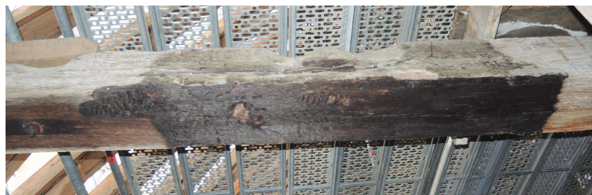
Fig. II-3 > Traces de carbonisation de l'écharpe nord de F49 (1230 BF).
