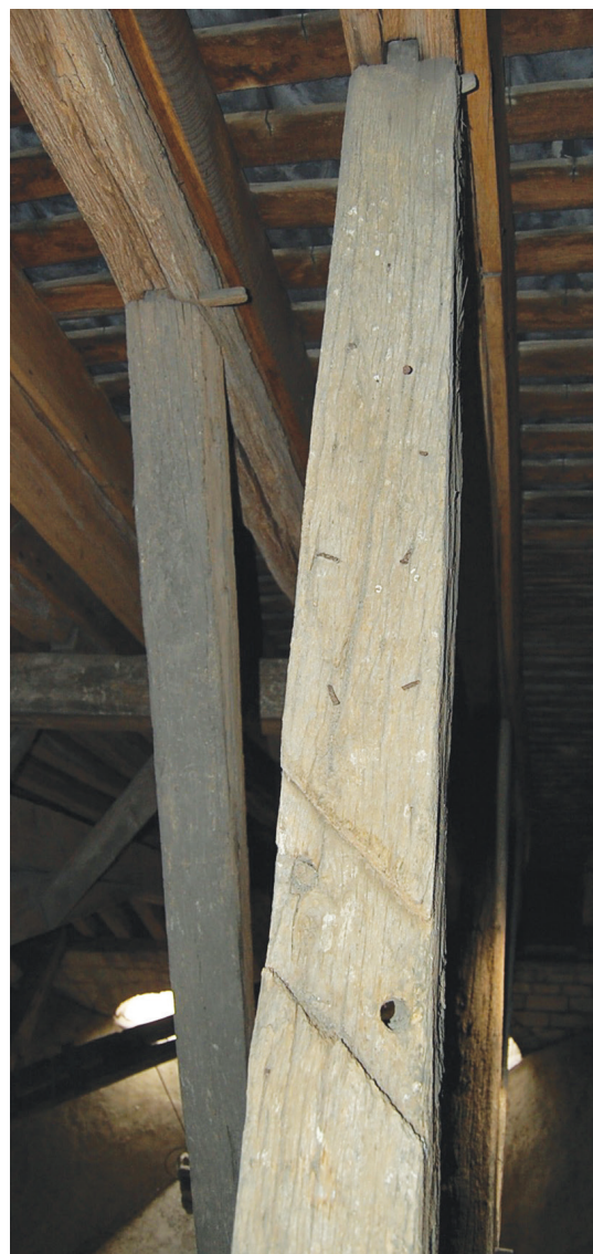
Fig. III-11 > Chevron de 1256 en réemploi dans la charpente de 1263. On distingue nettement les clous de fixation du lattis de la couverture et l'entaille à mi-bois pour une longrine du contreventement oblique.
