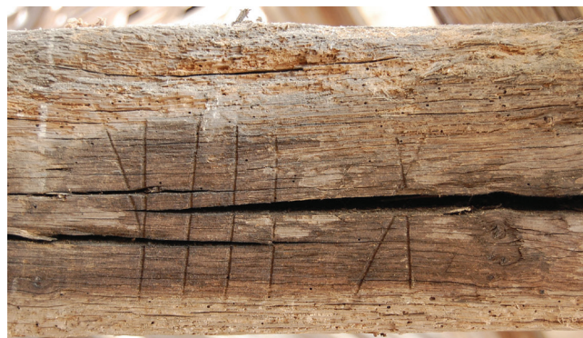
Fig. II-1 > Marque de l'entrait retroussé de F28 (bois abattu entre 1241 et 1243) recoupée par une fente de dessiccation.
