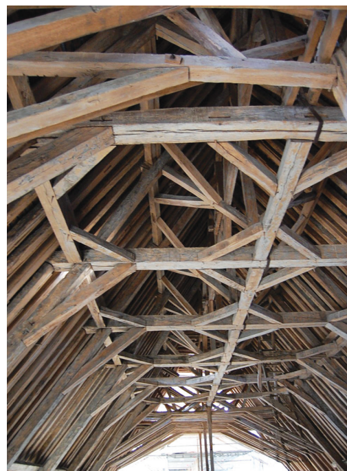
Fig. I-18 > Vue des fermes à portique de la charpente de 1747.
