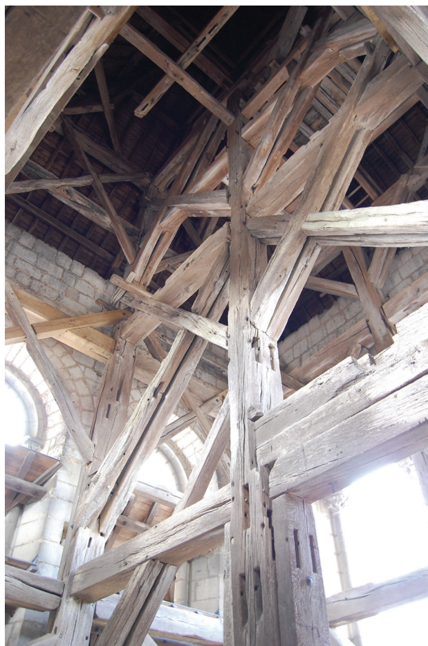
Fig. V-2 > Vue intérieure du beffroi.
