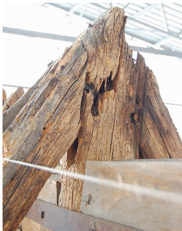
Fig. III-25 &gt; Rupture du poinçon de F51.
