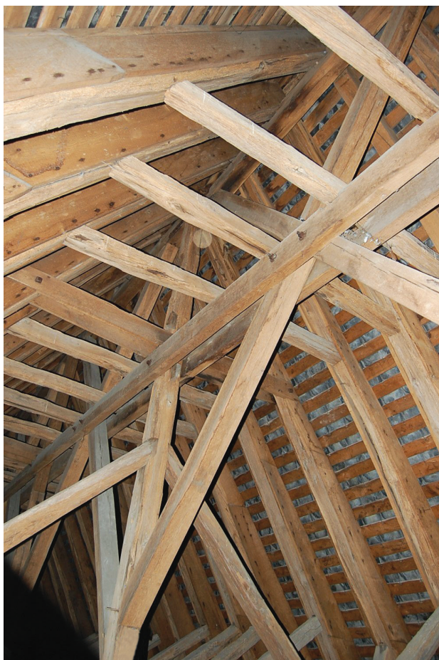
Fig. I-23 > Contreventement mis en place en 1882.
