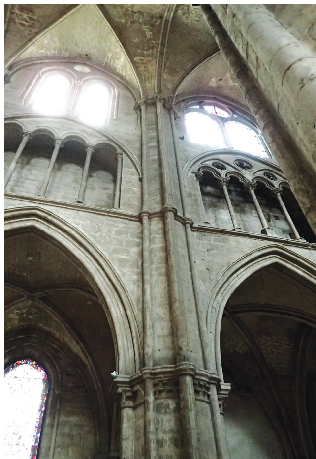
Fig. I-9 > 8 e pile du collatéral interne sud, arrêt de l'enduit blanc du chœur (à gauche) au droit de la colonnette centrale de la pile.
