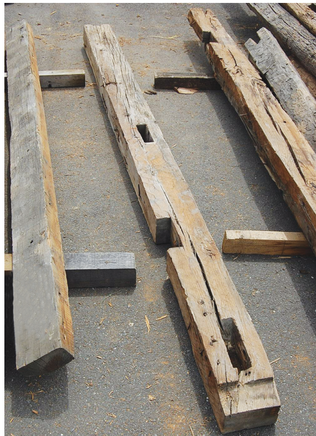
Fig. III-17 > Lierne longitudinale basse provenant des fourrures (F41 S2M), datée de l'automne-hiver 1254-1255.
