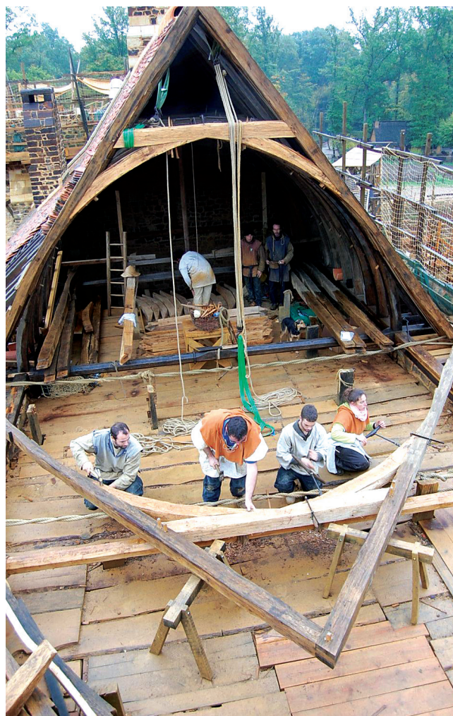
Fig. IV-12 > Reconstitution d'une charpente du XIII e siècle avec remontage puis levage des fermes depuis un plancher de travail en haut des murs. Chantier de Guédelon (Yonne), 2010.
