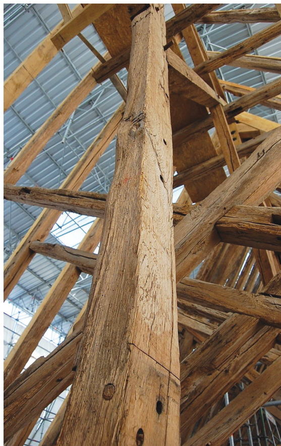
Fig. II-12 > Sur-équarrissage du poinçon de la ferme 62.
