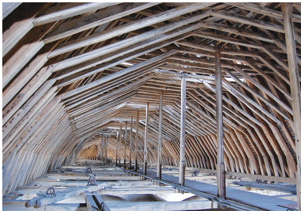
Fig. III-1 > Vue de la charpente gothique du vaisseau principal, depuis la nef.
