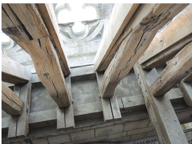
Fig. I-22 > Pied de fermes avec les blochets en moises et sablières du XIX e siècle (fermes 33 et 34).
