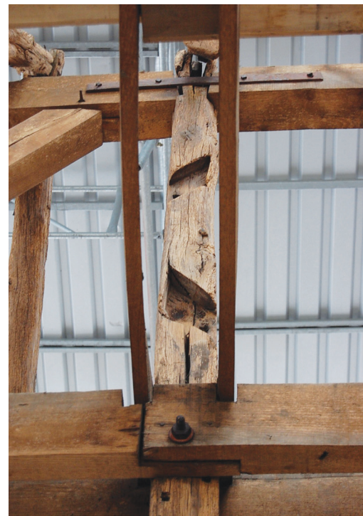
Fig. III-16 > Entailles d'assemblages à mi-bois de la tête du poinçon de F17.
