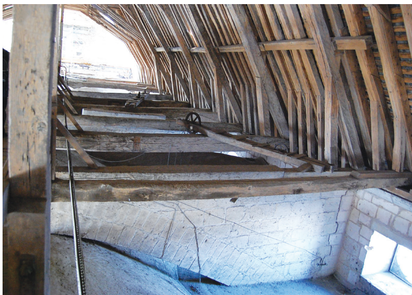
Fig. I-12 > Arc doubleau situé au droit de la 8 e pile, enjambant la voûte, et destiné à porter la base de la flèche.
