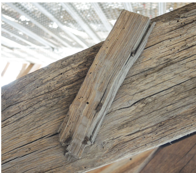
Fig. IV-13 > Chevillage des chevrons en face inférieure, à 50 cm sous les faux-entraits.
