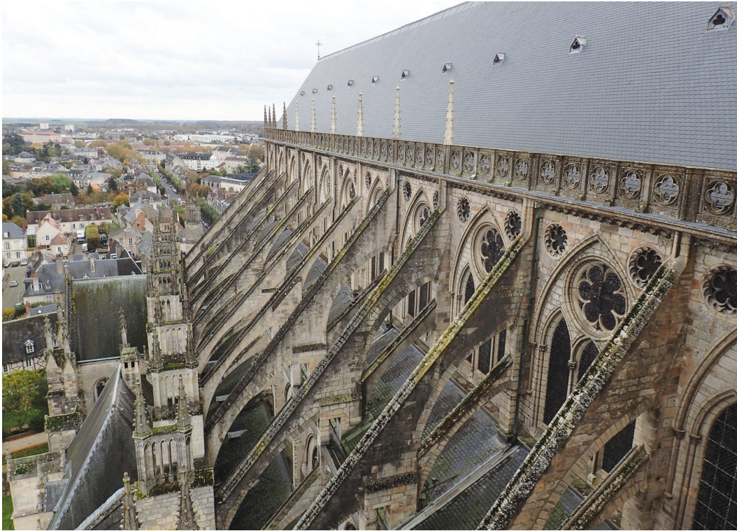
Fig. III-4 > Vue des arcs-boutants avec leur volée supérieure destinée à contenir les poussées latérales générées par les vents.
