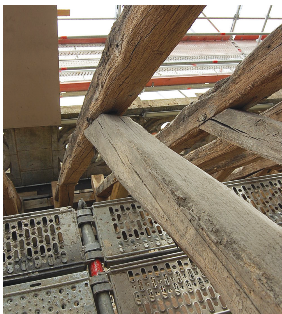
Fig. II-18 > Ferme 116, aisselier sud vrillé.
