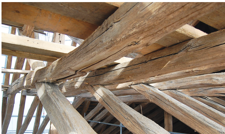
Fig. II-14 > Charpente du chœur. Vue des entrants retroussés des fermes secondaires.
