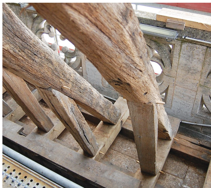
Fig. II-19 > Ferme 63, chevron sud taillé dans un bois tors déformé au séchage.
