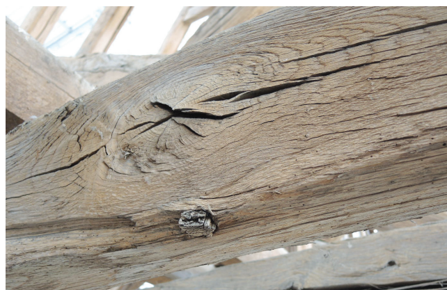
Fig. II-5 > Chevillage dans l'arête d'un entrail retroussé.
