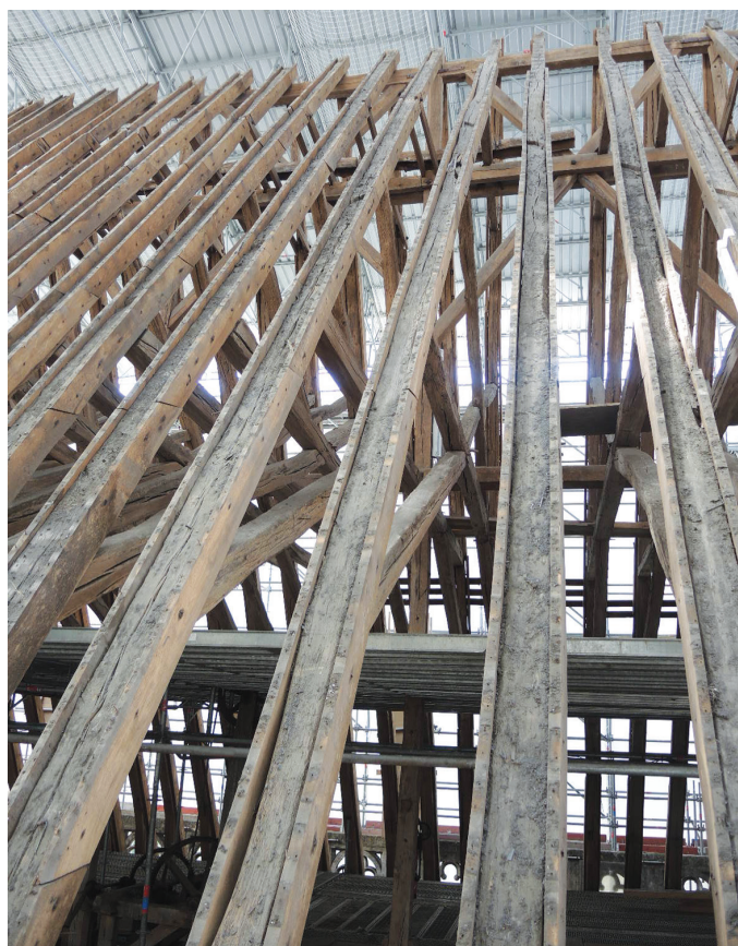
Fig. I-24 > Avant restauration, chevrons moisés en 1882 par des planches épaisses en chêne.
