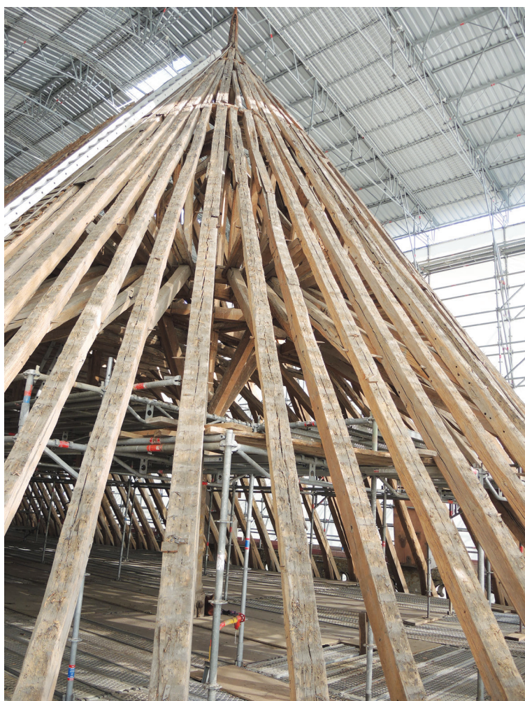
Fig. III-20 > Vue de la croupe absidiale mise à nue.
