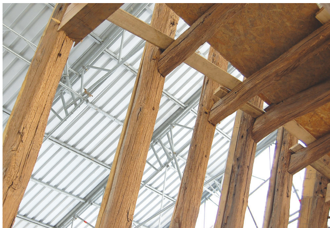
Fig. IV-13 > Chevillage des chevrons en face inférieure, à 50 cm sous les faux-entraits.
