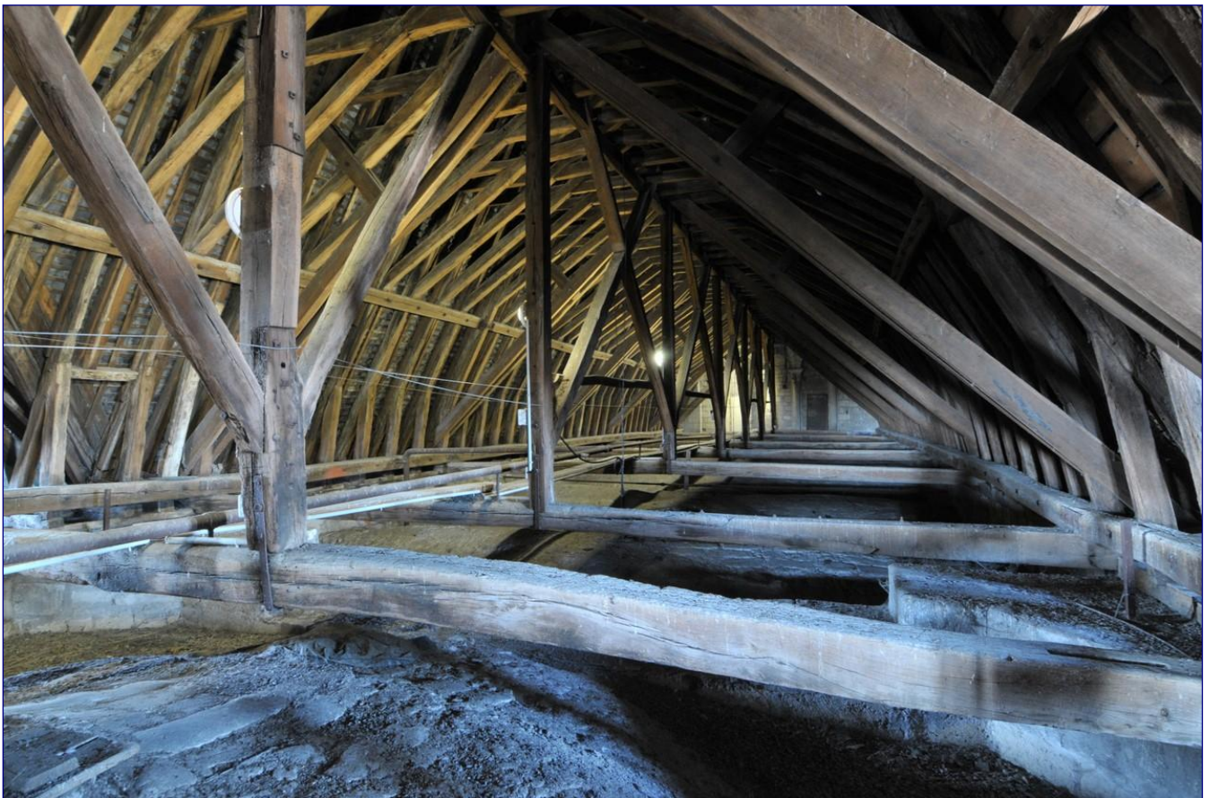
Fig. 3 : charpente de la nef, vue générale vers l'ouest
