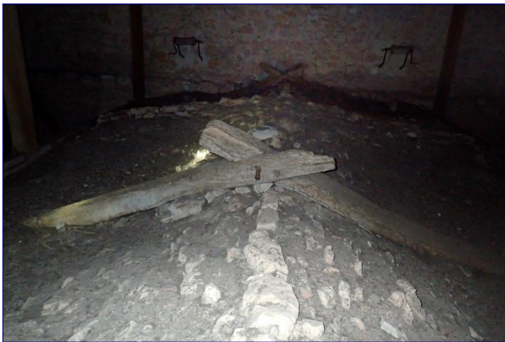
Fig. 9 : partie orientale de la charpente, vestiges d'écharpes croisées d'une ancienne ferme
