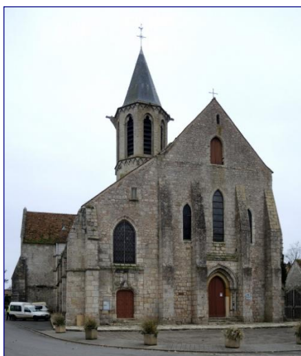
Façade ouest de l'église
