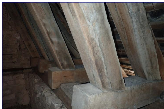
Charpente du chœur, blochets
