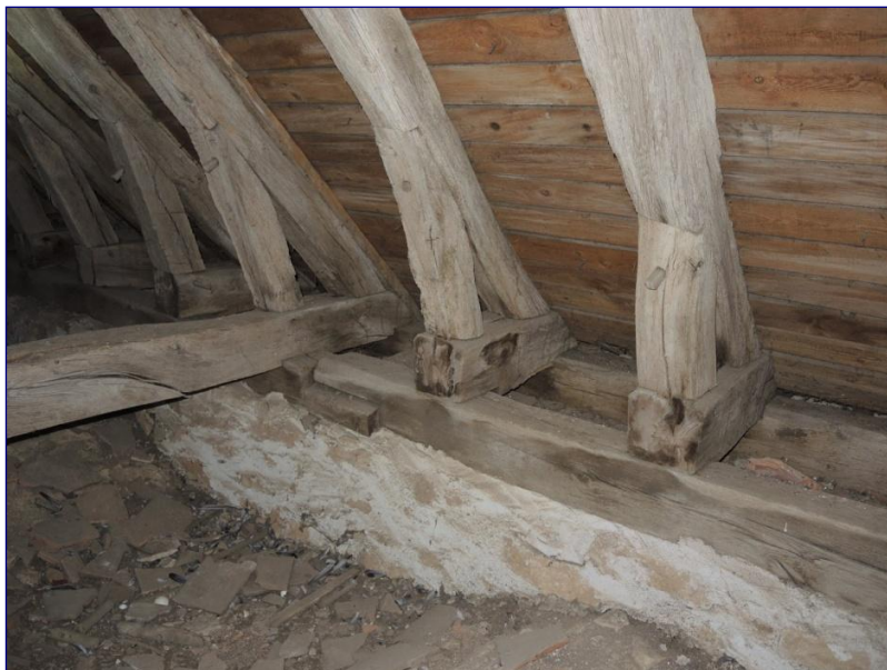
Fig. 11 : charpente de la nef, pieds de fermes
