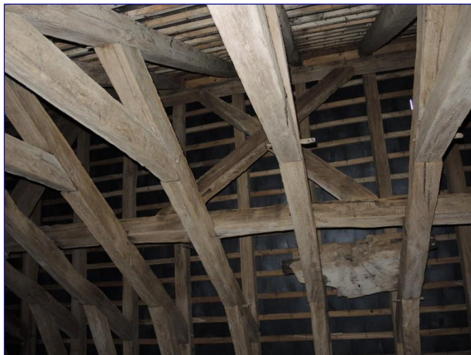
Charpente de la nef, contreventement
