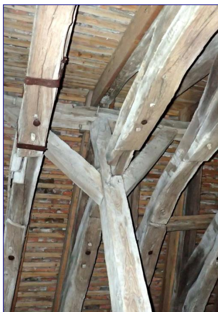
Fig. 10 : charpente des travées occidentales, contreventement postérieur
