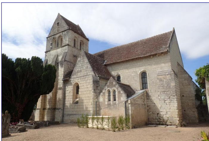
Vue générale de l'édifice vers le nord-est
