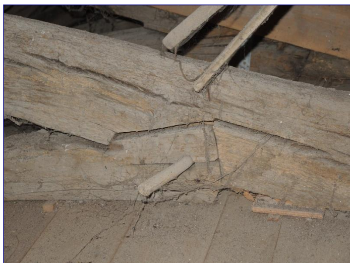
Fig. 11 : charpente de la nef, assemblage à mi-bois aisselier/faux-entrait
