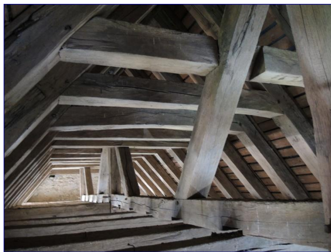
Fig. 21 : charpente de la travée ouest de la nef, contreventement
