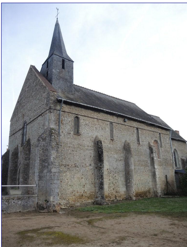
Fig. 1 : vue générale de la nef au sud-ouest
