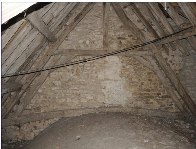
Fig. 5 : charpente du chœur, ferme ouest de la travée droite
