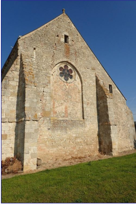
Mur pignon du chevet
