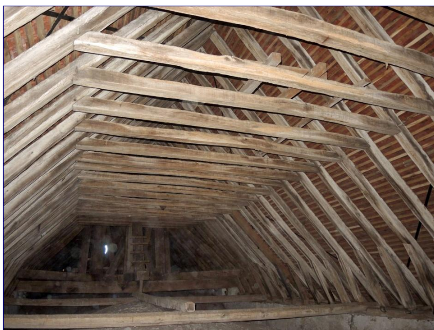
Fig. 13 : charpente ouest du chœur vers l'ouest
