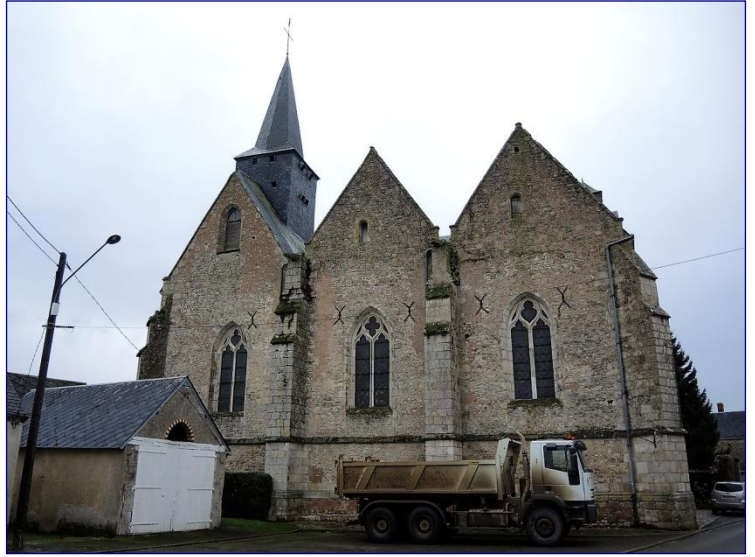
Gouttereau nord : les trois travées sont individualisées par leur pignon
