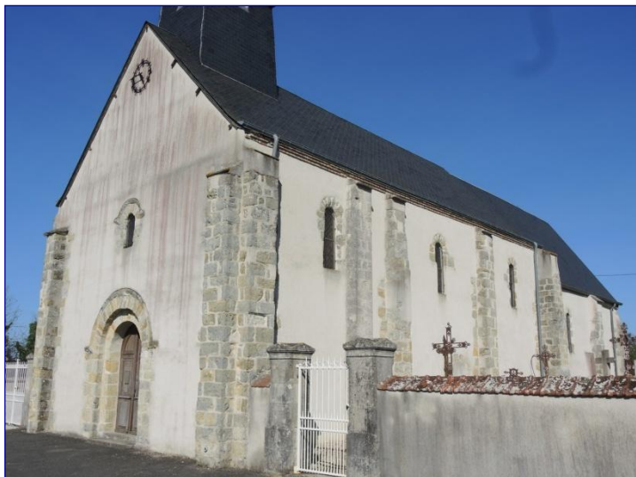
Fig. 1 : vue générale de l'église vers le nord-est
