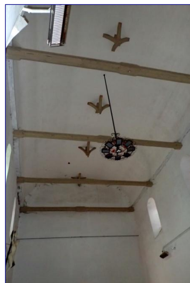
Charpente de la nef
