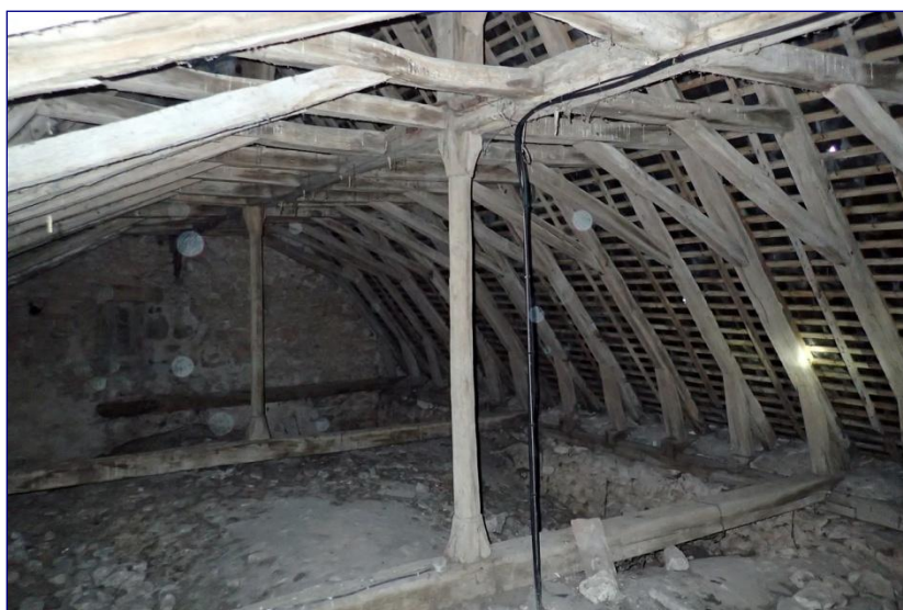
Charpente de la nef
