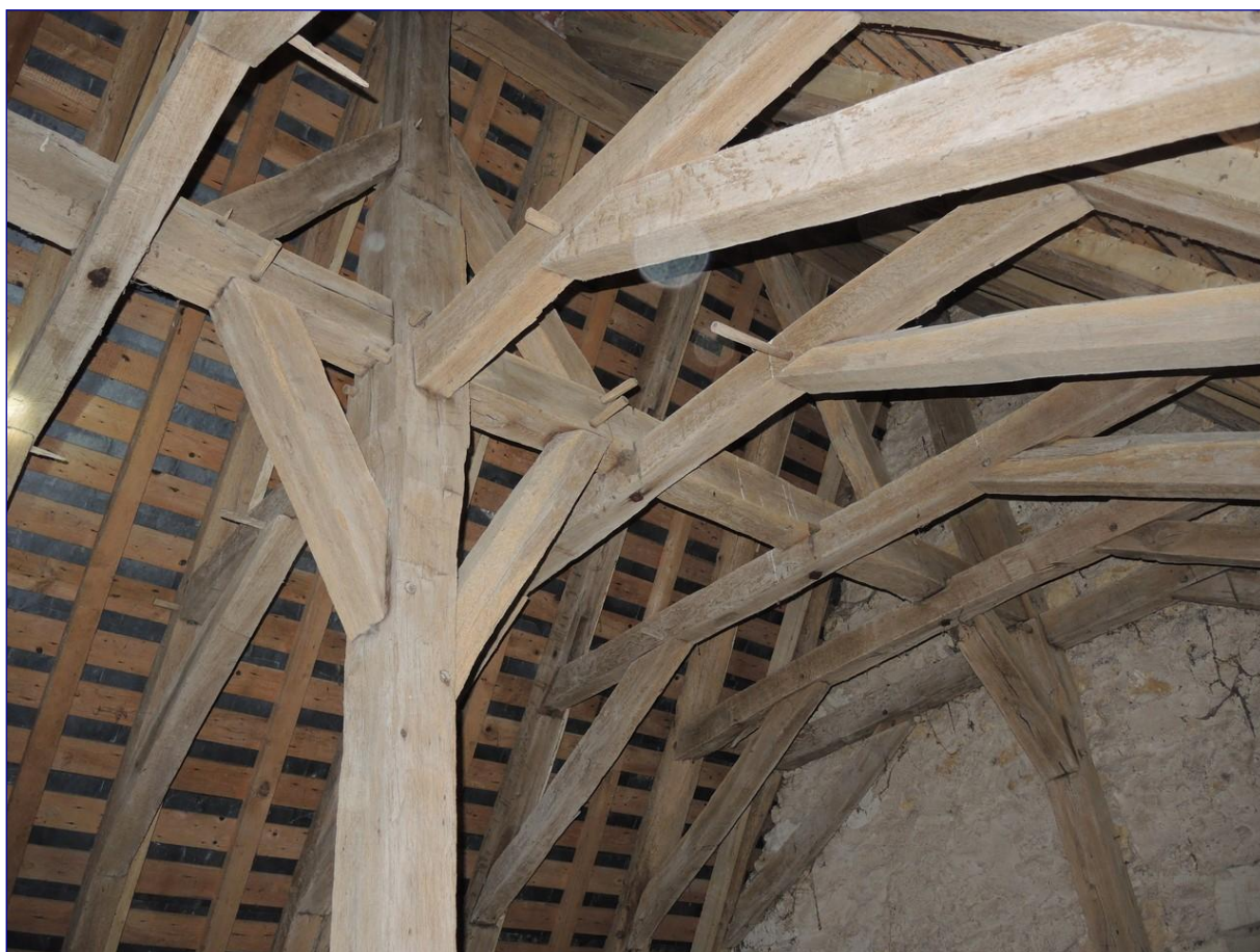
Fig. 14 : charpente de la chapelle nord, vue générale du contreventement
