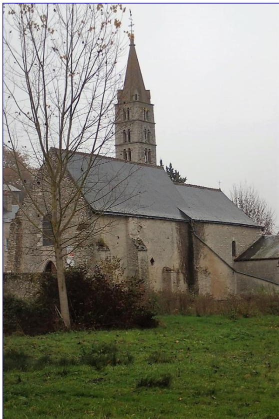
Fig. 3 : vue générale de l'édifice vers le nord-est
