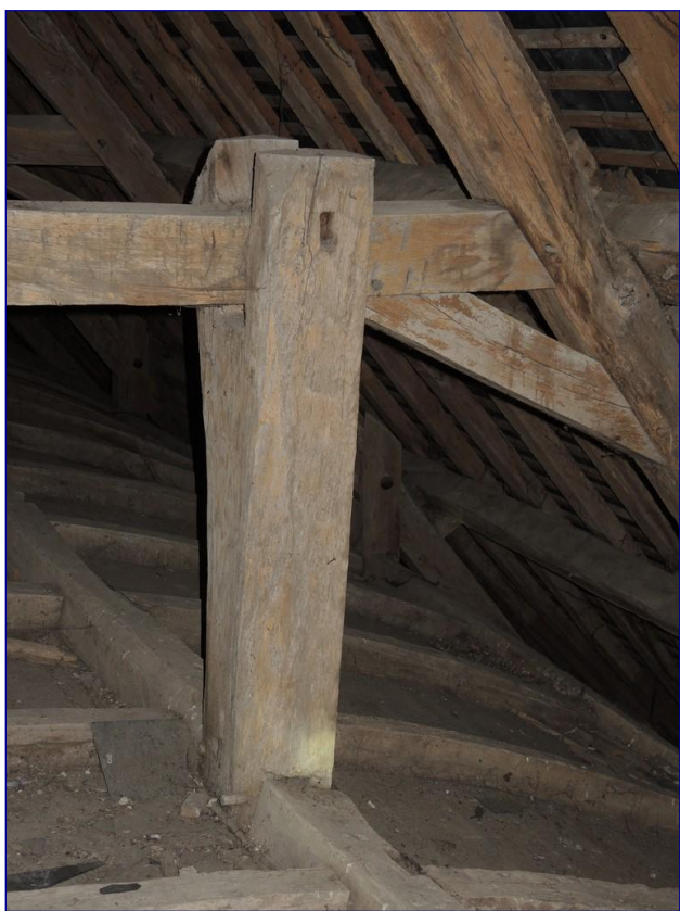
Fig. 17 : charpente de la nef, potelet soutenant la voûte lambrissée
