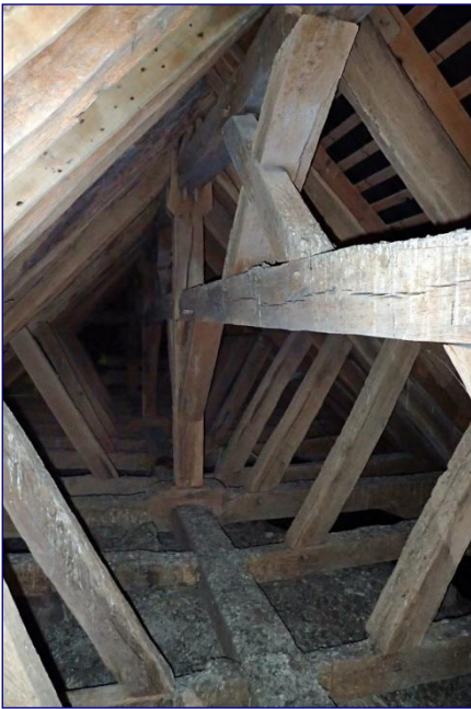
Structure orientale vers l'ouest
