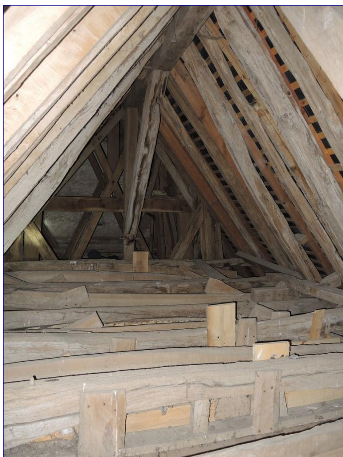
Fig. 4 : charpente de la nef, vue générale vers l'ouest
