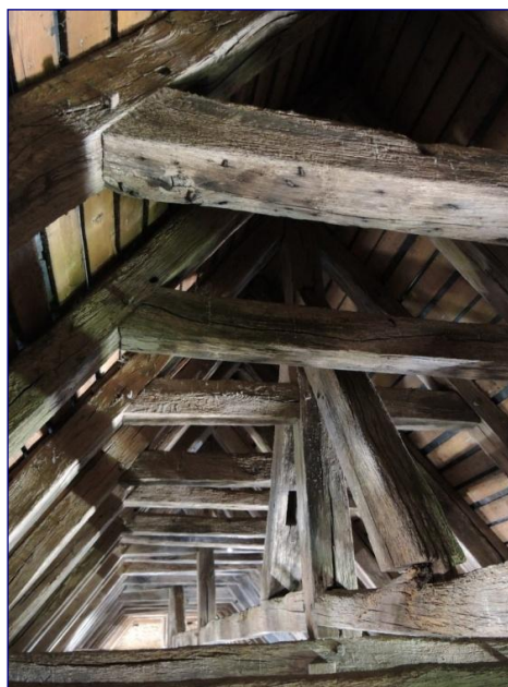
Fig. 17 : charpente de la nef (2 e et 3 e travées), contreventement
