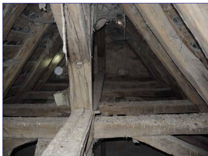
Fig. 14 : charpente du bras nord du transept, contreventement longitudinal
