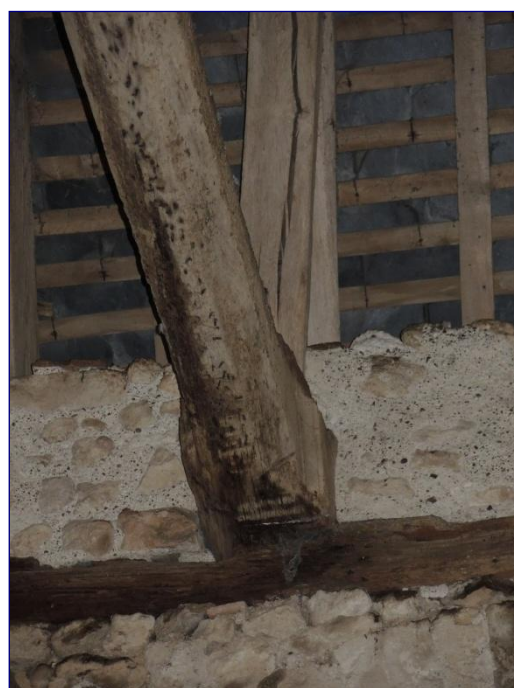
Charpente, about d'entrait
