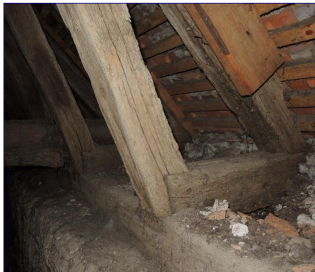
Fig. 11 : charpente occidentale, assemblage blochet-jambette
