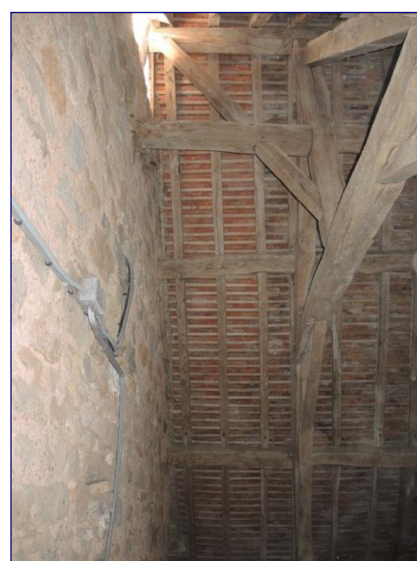
Charpente du chevet, 1 ère travée nord
