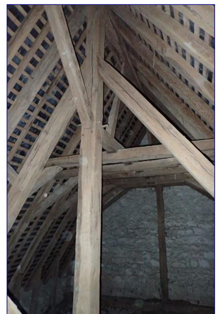
Charpente du bras nord du transept
