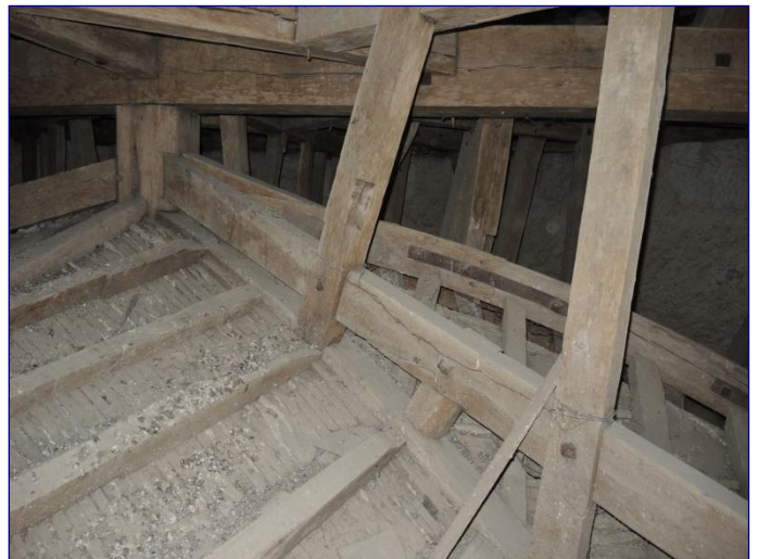
Charpente du chœur, voûte suspendue en bois
