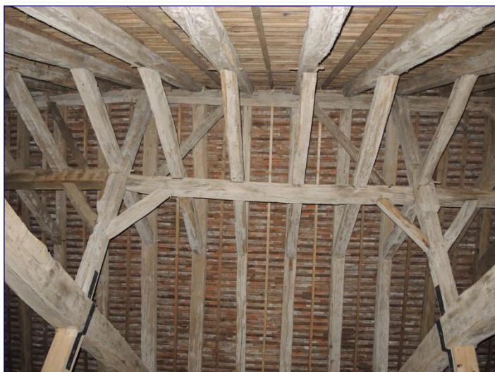
Fig. 13 : charpente du chœur, contreventement
