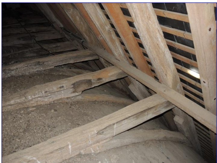
Fig. 10 : charpente du chœur, entrails retroussés délardés
