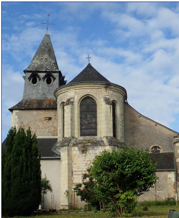
Fig. 3 : vue générale du chevet
