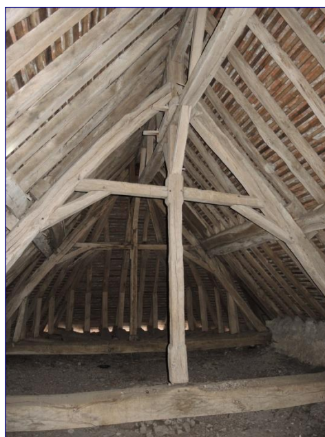
Fig. 16 : charpente du chœur vers l'ouest
