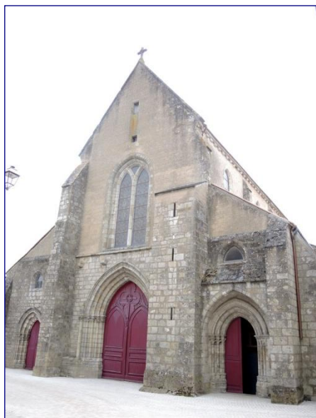
Façade ouest de l'église
