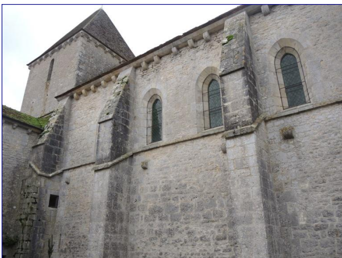
Fig. 3 : mur nord de la nef
