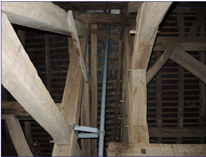
Limite entre les charpentes de la nef et du chœur
