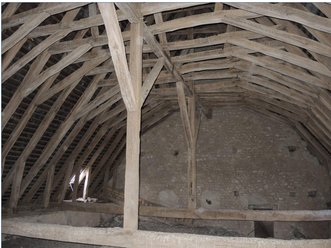
Fig. 5 : charpente du chœur vers l'ouest
