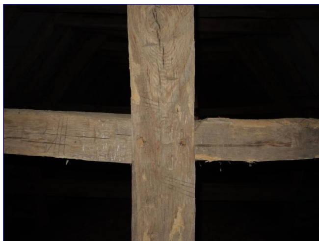
Marquage en sous-face des entrants retroussés et de la lierne
