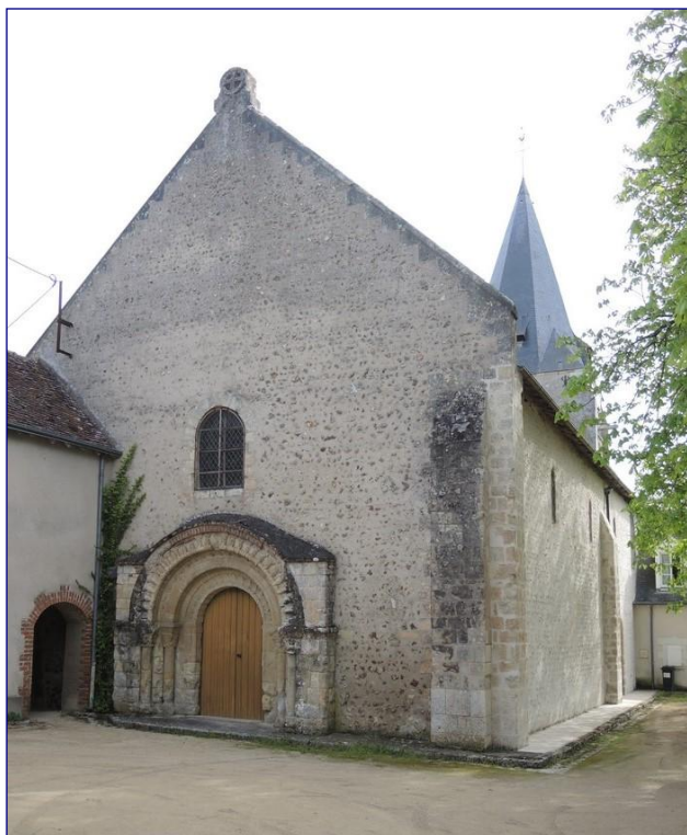
Façade occidentale avec son portail monumental
