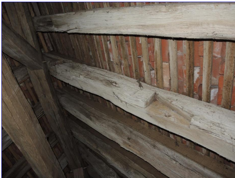
Fig. 9 : charpente du chœur, chevrons en remploi avec mi-bois en demi-queue d'aronde
