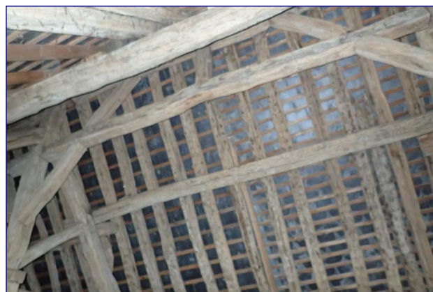
Charpente, détail du contreventement
