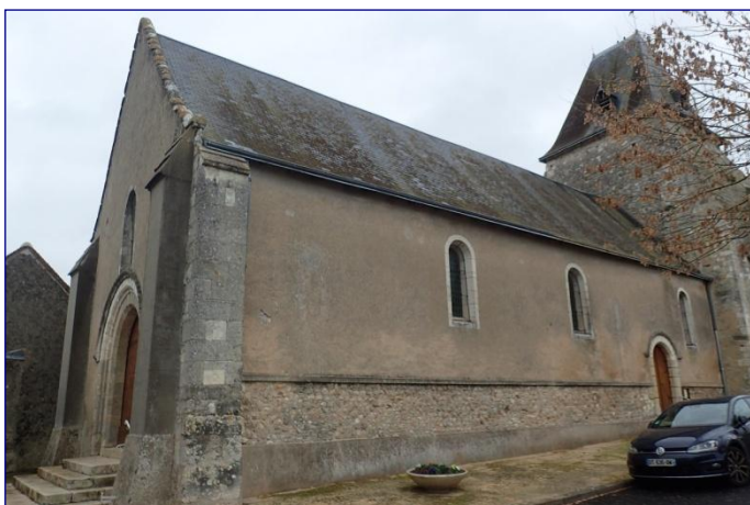
Nef vue du sud-ouest
