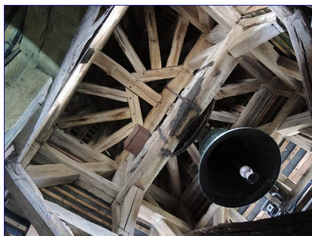
Fig. 14 : cage des cloches et enrayure de la flèche du clocher
