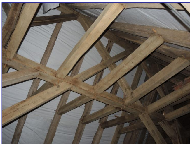
Charpente, détail du contreventement
