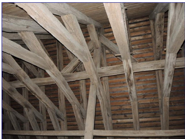
Fig. 14 : charpente de la nef (2 e et 3 e travées), contreventement
