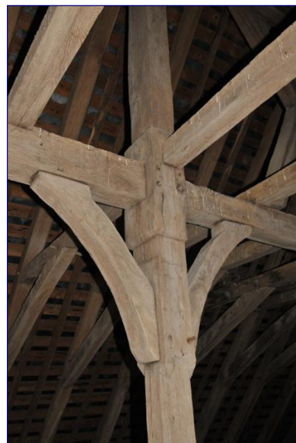
Charpente de la nef, détail d'un poinçon
