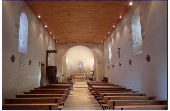
Charpente est, assemblage par enture des sablières
