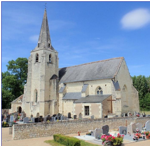
Vue générale de l'église au sud-est
