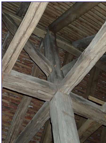
Charpente ouest, tenon passant
