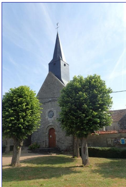
Vue générale de l'église vue du sud-ouest
