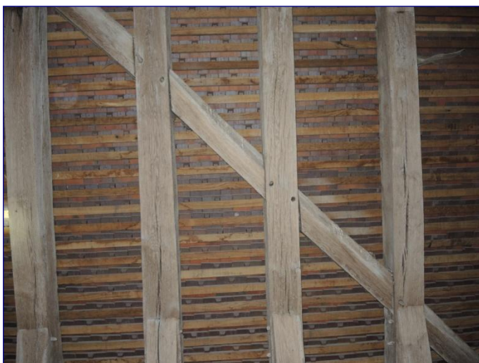
Charpente du vaisseau, lisse de toiture
