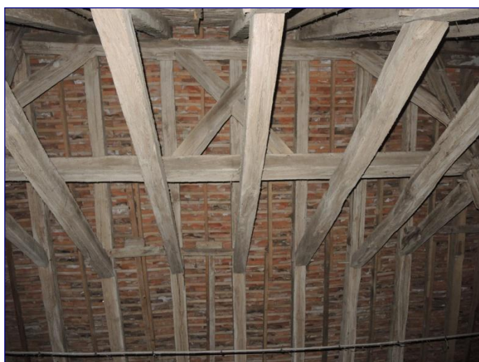
Charpente de la nef, contreventement longitudinal
