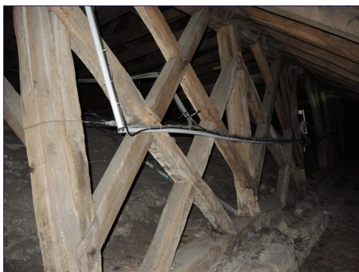
Fig. 8 : charpente de la nef, pan-de-bois longitudinal sud
