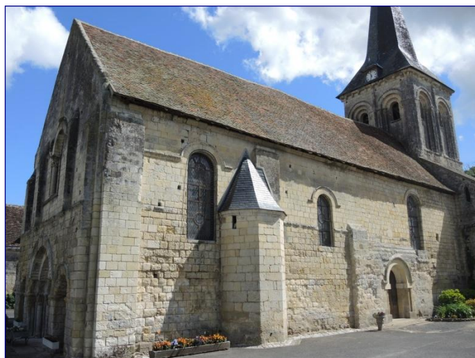
Eglise vue du sud
