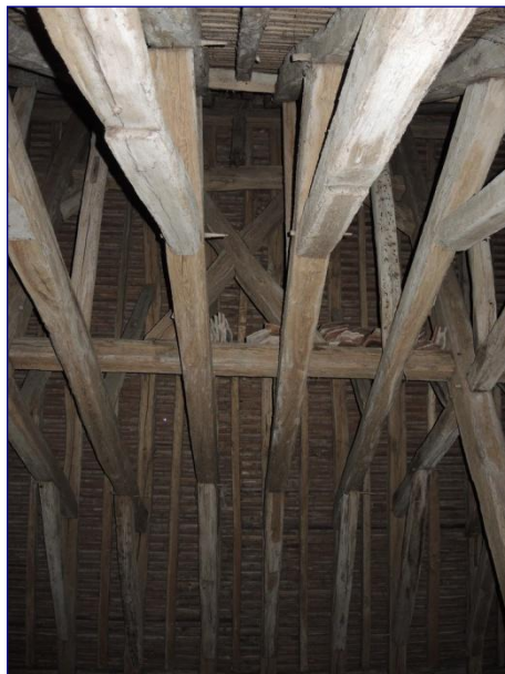
Charpente du chœur, contreventement
