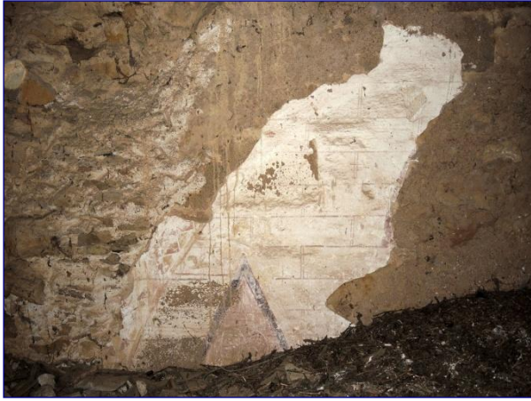
Pignon est dans le comble, peintures murales
