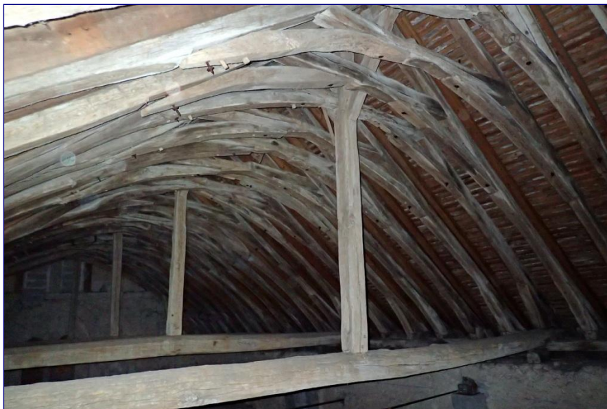
Fig. 8 : charpente des travées occidentales vers l'ouest
