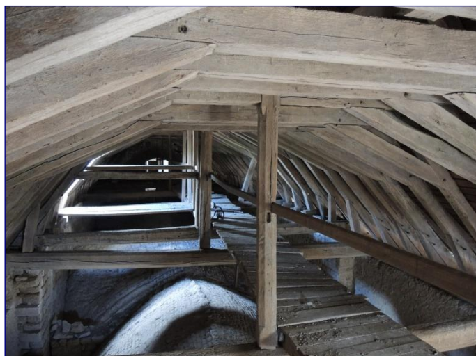
Fig. 20 : charpente de la travée ouest de la nef
