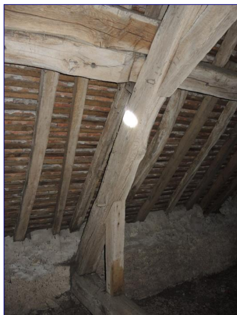
Fig. 18 : charpente du chœur, pied d'une ferme
