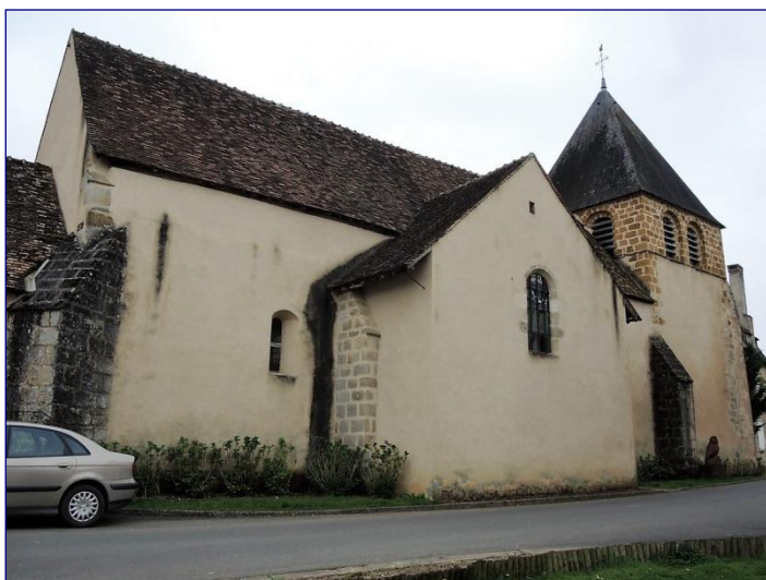
Vue générale de l'église vers le sud-ouest
