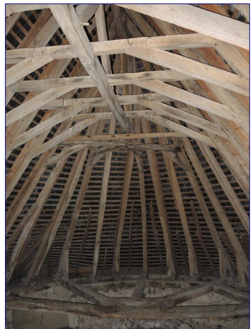
Fig. 14 : charpente du chœur vers l'est
