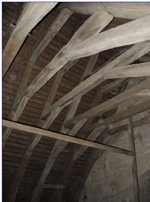
Fig. 13 : charpente de la nef (2 e et 3 e travées), partie est
