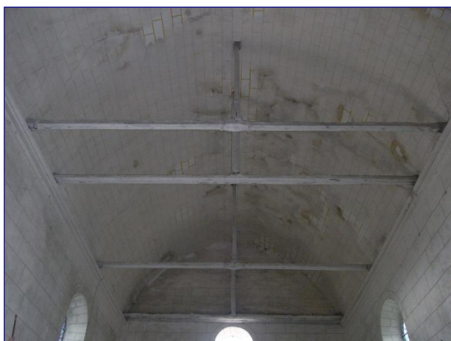
Charpente de la nef vers l'ouest
