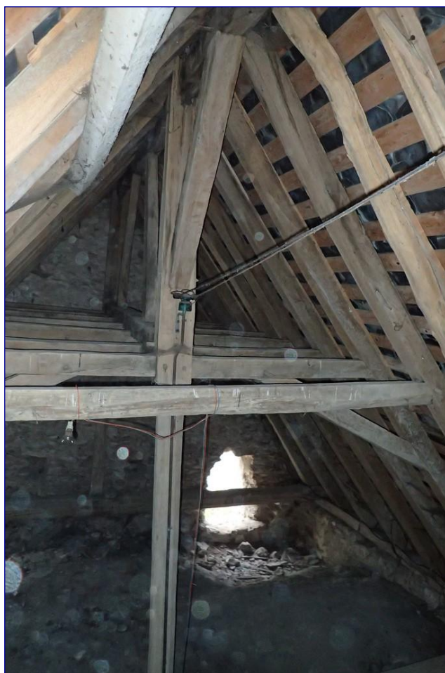
Fig. 13 : charpente de la chapelle nord, vue générale vers le nord
