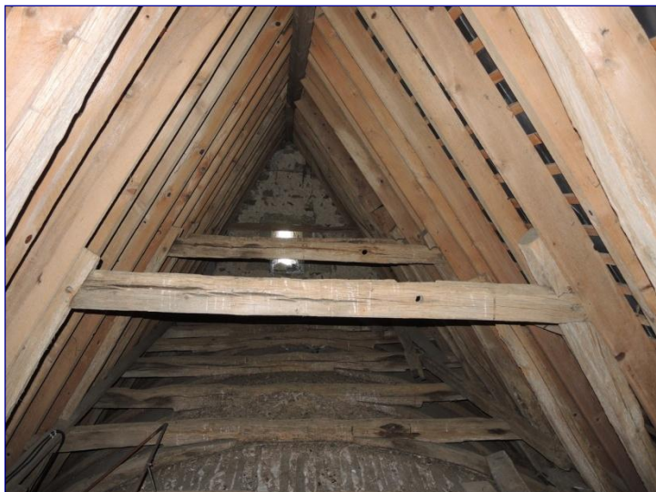
Fig. 6 : charpente du chœur, vue générale vers l'est
