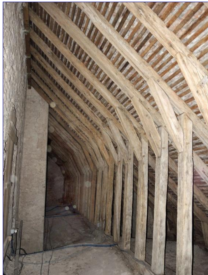
Fig. 16 : charpente du bas-côté nord
