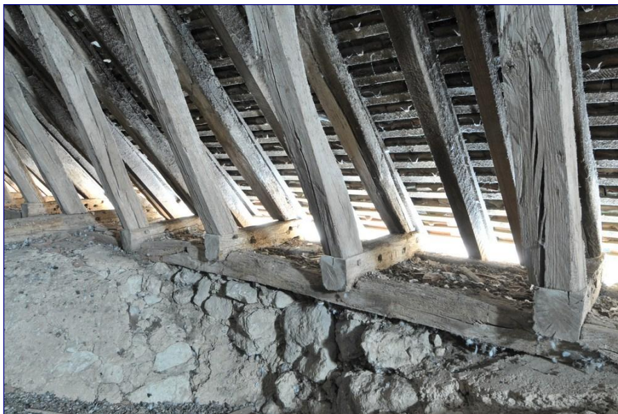
Fig. 11 : charpente de la nef, double cours de sablières au sud
