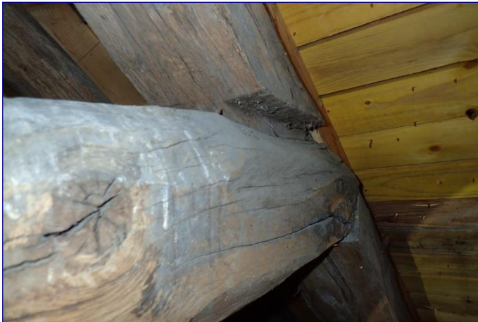
Charpente du vaisseau, assemblage d'un entrain retourné « pinçant » le chevron
