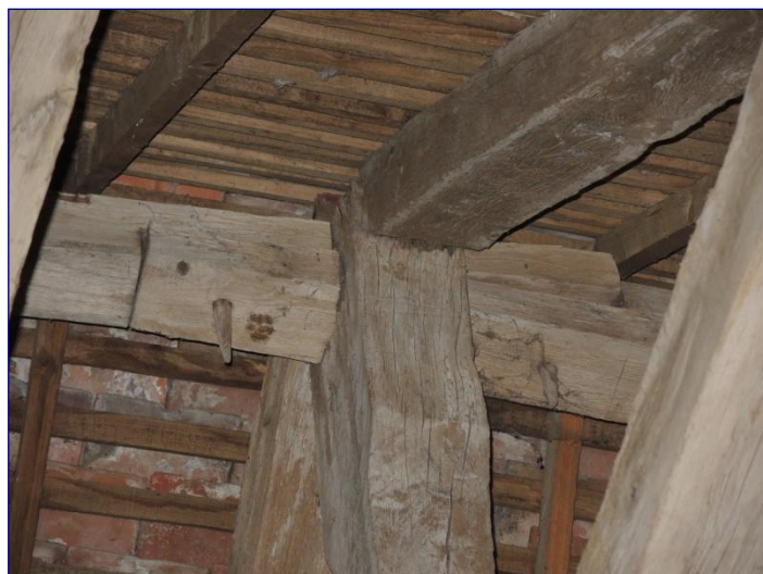
Fig. 14 : charpente du chœur, assemblage d'une tête de poinçon et de la faîtière
