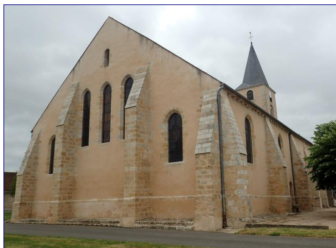
Fig. 2 : vue générale du chevet
