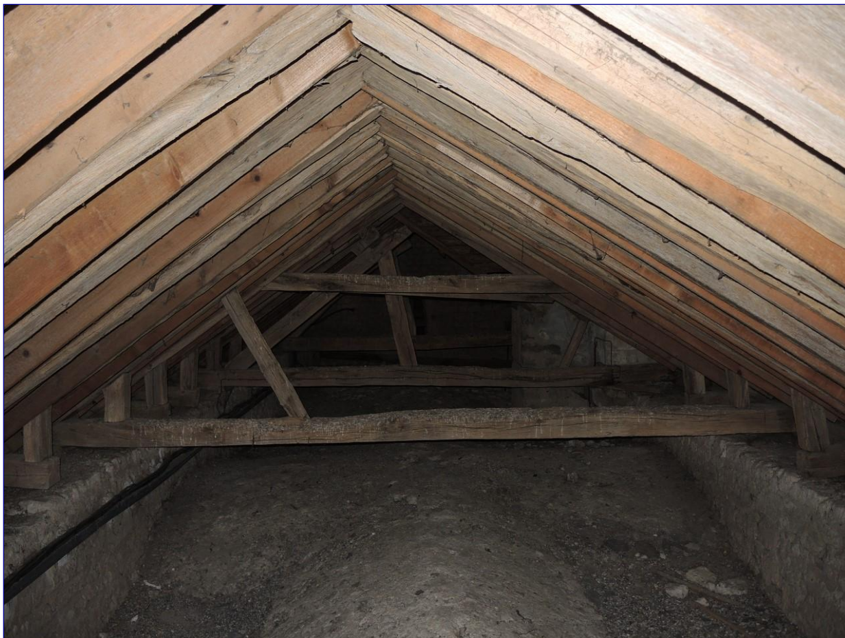
Fig. 8 : chœur, charpente du vaisseau central, vue vers l'ouest
