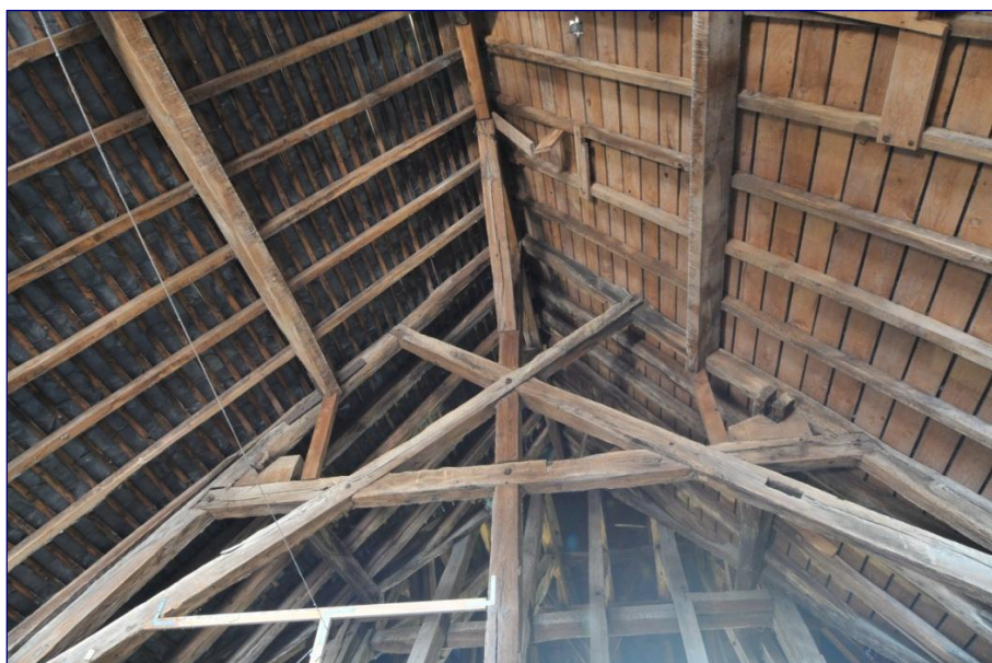
Fig. 14 : charpente du bras sud, ferme nord
