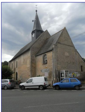
L'église vue du sud-est
