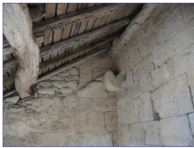
Fig. 23 : comble du bas-côté sud, corbeau et solin de la charpente en appentis antérieure
