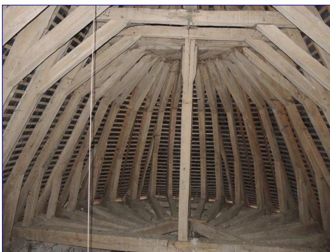
Charpente du chœur, croupe à l'est
