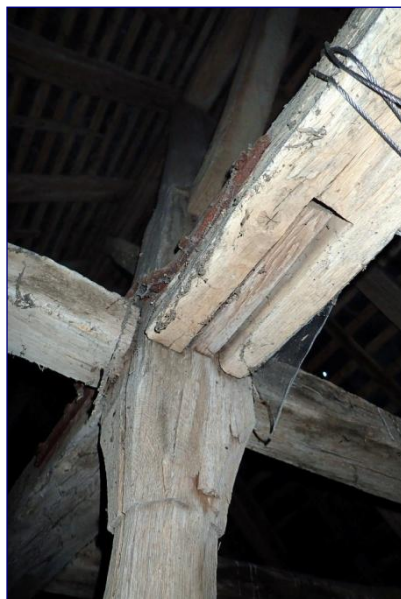
Charpente de la nef, assemblage à tenon passant de la sous-faîtière dans le poinçon
