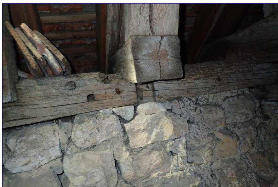
Fig. 7 : charpente des travées orientales, détail d'un assemblage de sablières par enfourchement
