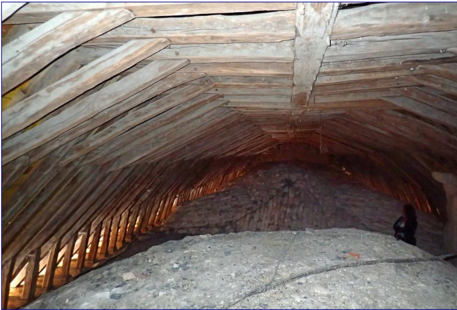
Charpente du vaisseau (nef et travée droite du chœur)
