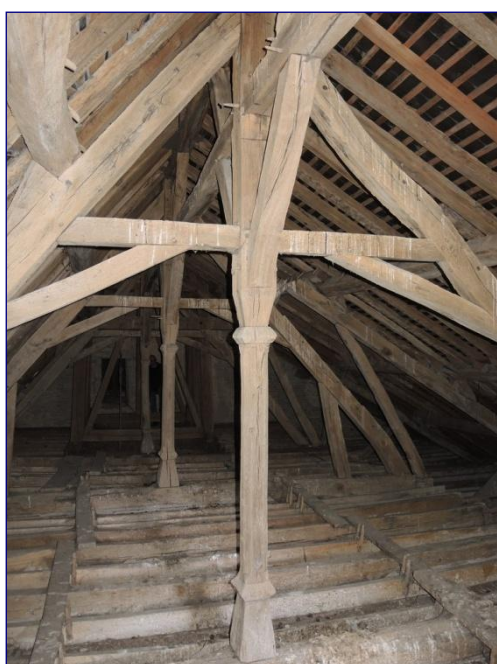
Charpente de la nef vers l'est
