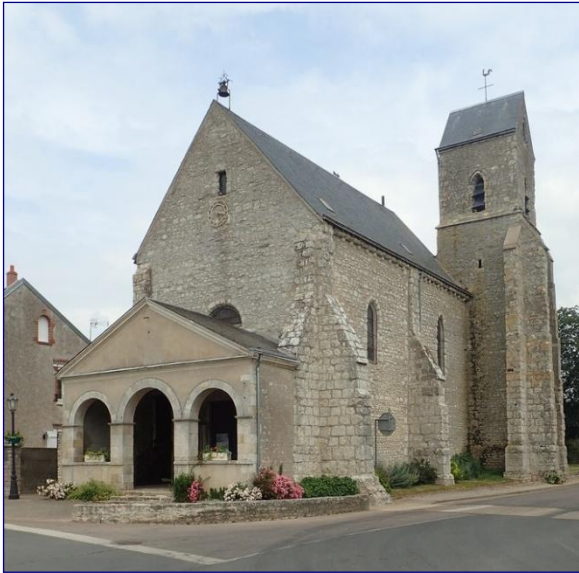
Vue générale de l'église depuis le sud-ouest
