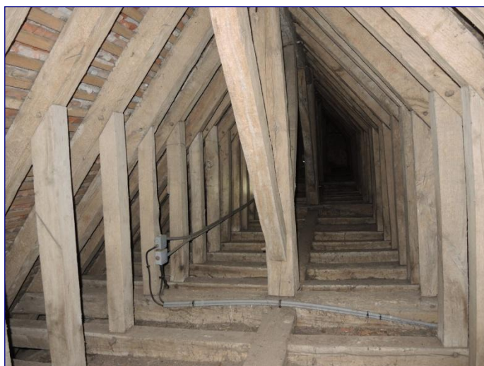
Charpente de la nef, partie au-dessus du lambris
