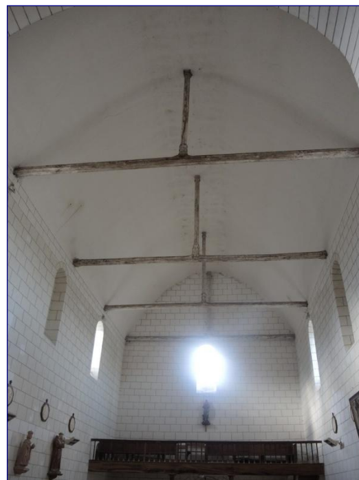
Vue générale de la nef vers l'ouest
