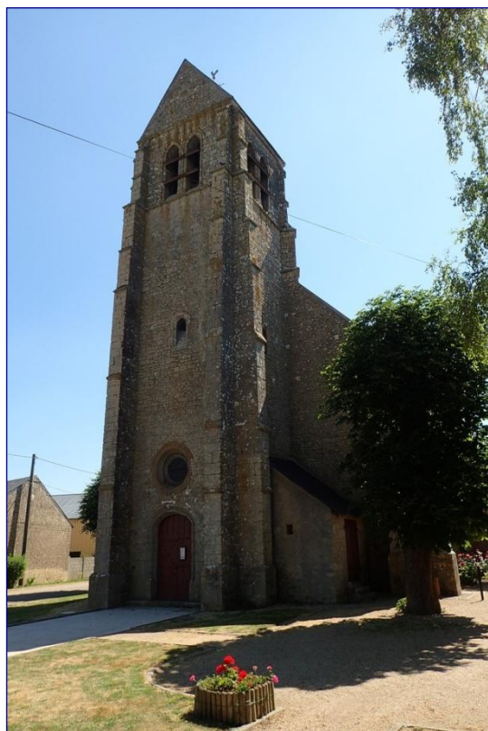
Vue de la tour-porche occidentale
