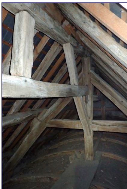
Charpente de la nef, contreventement
