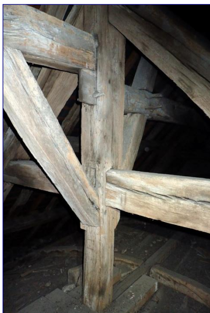
Charpente de la nef, détail d'un poinçon
