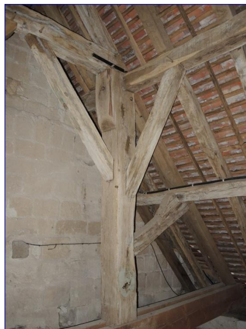
Fig. 16 : charpente du chœur, un poteau d'angle
