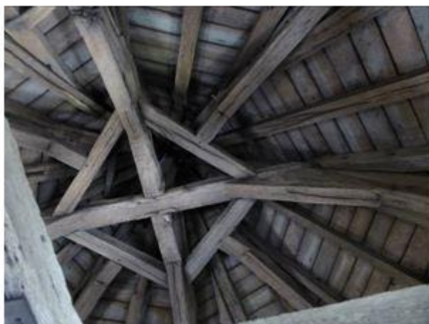
Fig. 16 Charpente de toit
