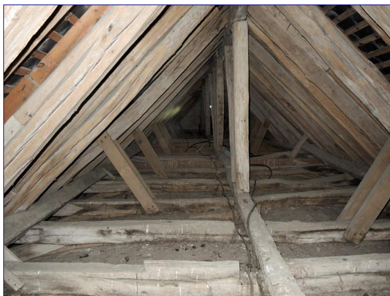
Fig. 10 : charpente de la nef vers l'ouest
