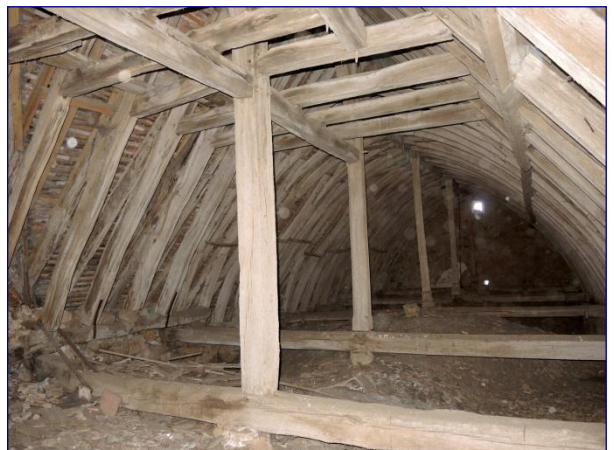
Structure ouest vers l'est
