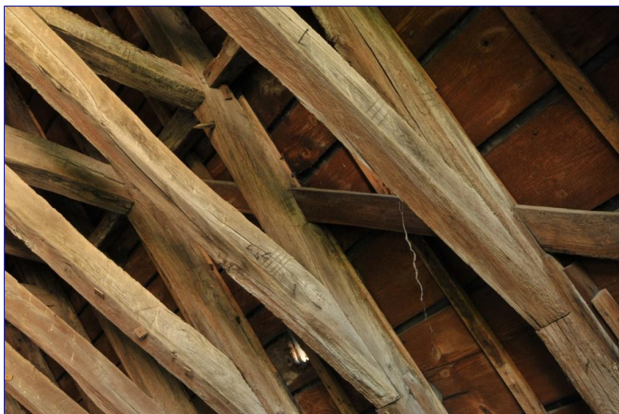
Fig. 12 : charpente du bras nord, marquage sur les faces nord
