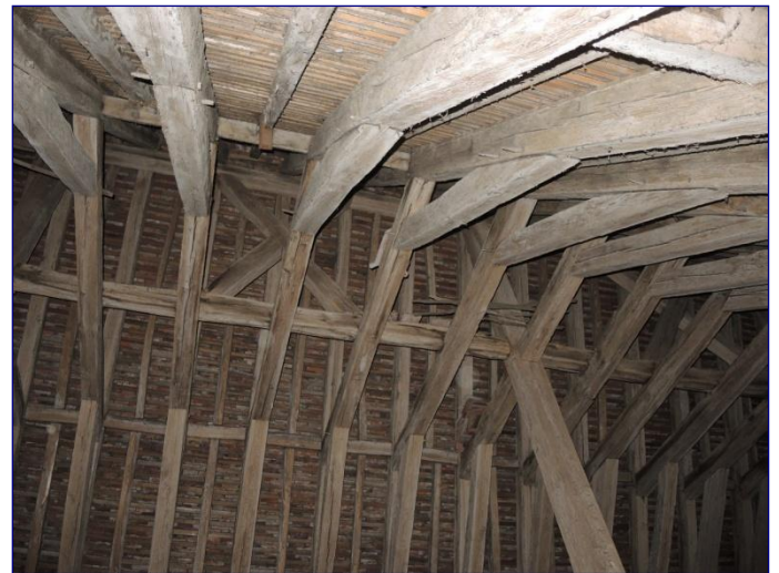
Charpente de la nef, versant sud avec entretoises entre chevrons
