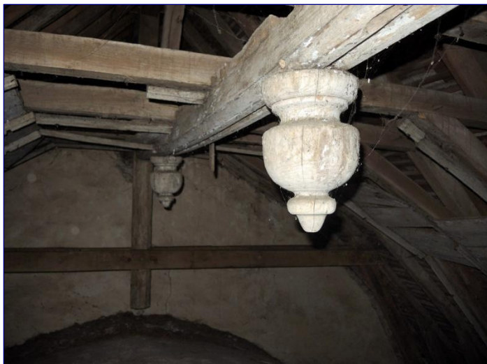
Fig. 7 : charpente de la nef, clefs pendantes
