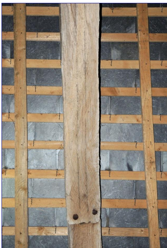
Charpente de la nef, lignage au noir en sous-face
