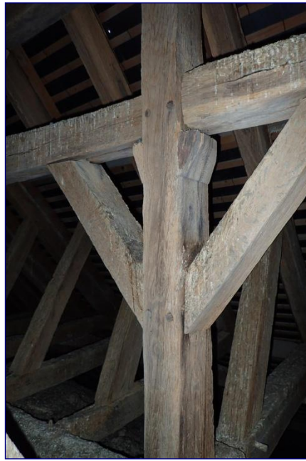
Structure orientale, détail d'un poinçon
