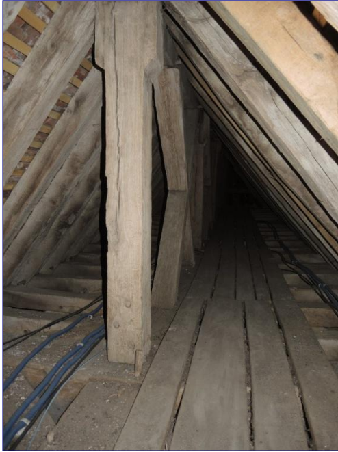
Charpente de la nef, contreventement
