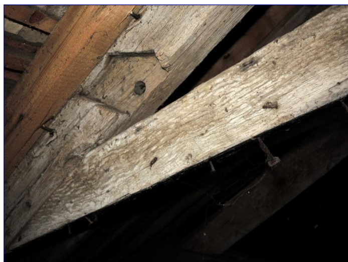
Fig. 10 : charpente de la nef, entaille à mi-bois sur un chevron
