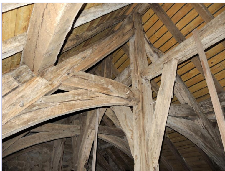
Fig. 7 : charpente de l'avant-chœur
