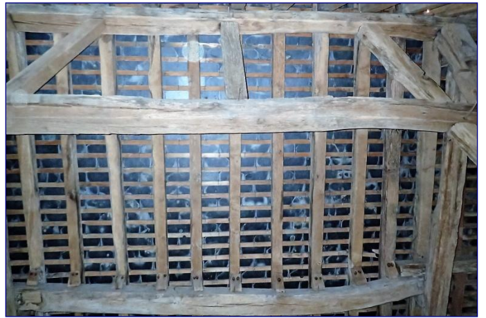
Charpente est, assemblage par enture des sablières
