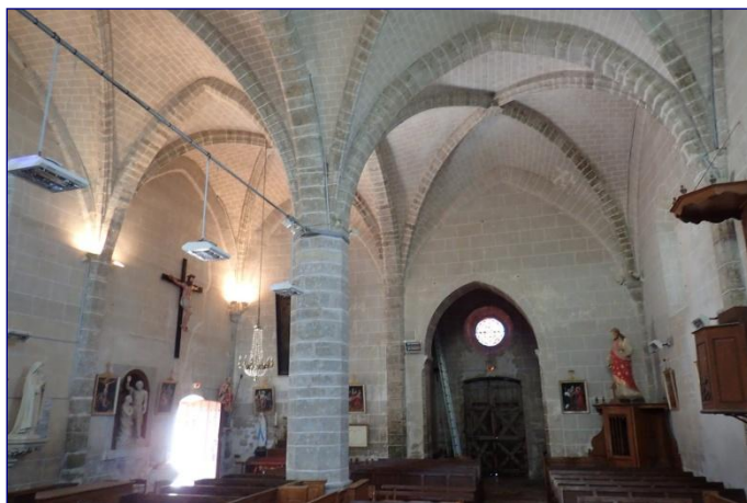
Vue des travées occidentales
