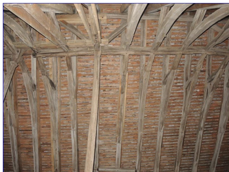
Fig. 6 : charpente occidentale, versant sud
