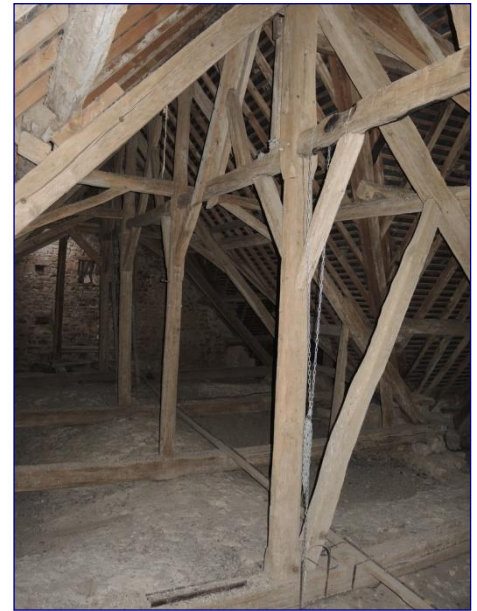
Charpente de la nef, vue vers l'ouest
