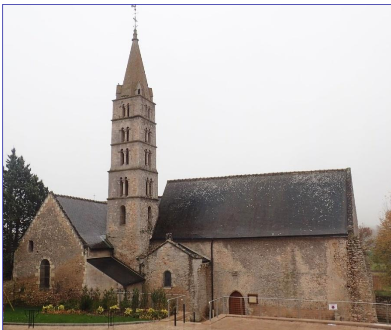
Fig. 1 : vue générale de l'église vers le sud
