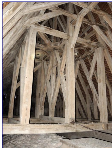
Charpente (base) de l'ancienne flèche
