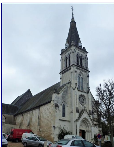
Façade néogothique de l'église et mur gouttereau en moyen appareil
