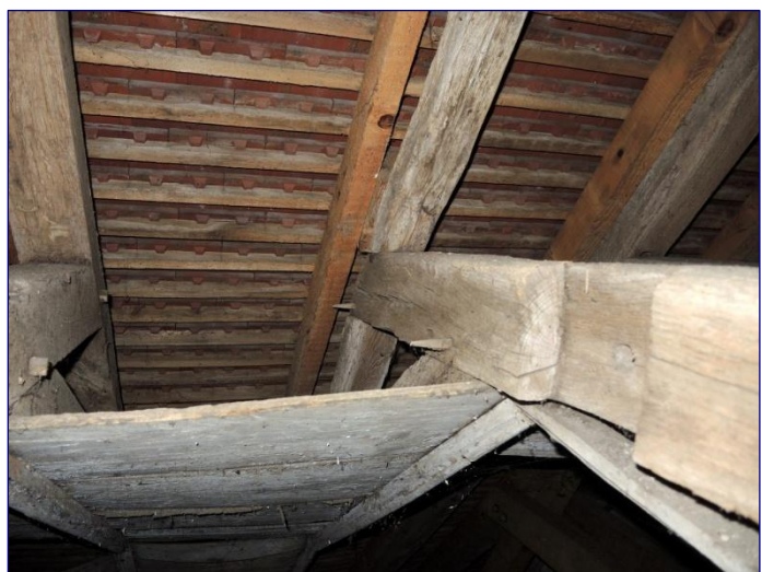
Fig. 9 : charpente de la nef, assemblages à mi-bois sur faux-entrait
