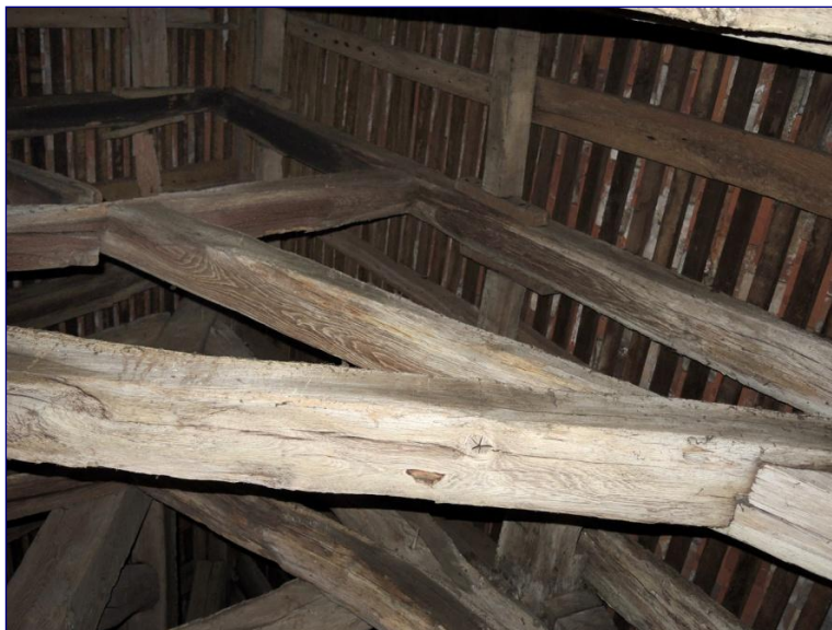
Fig. 10 : charpente de la nef, structure ouest, écharpes
