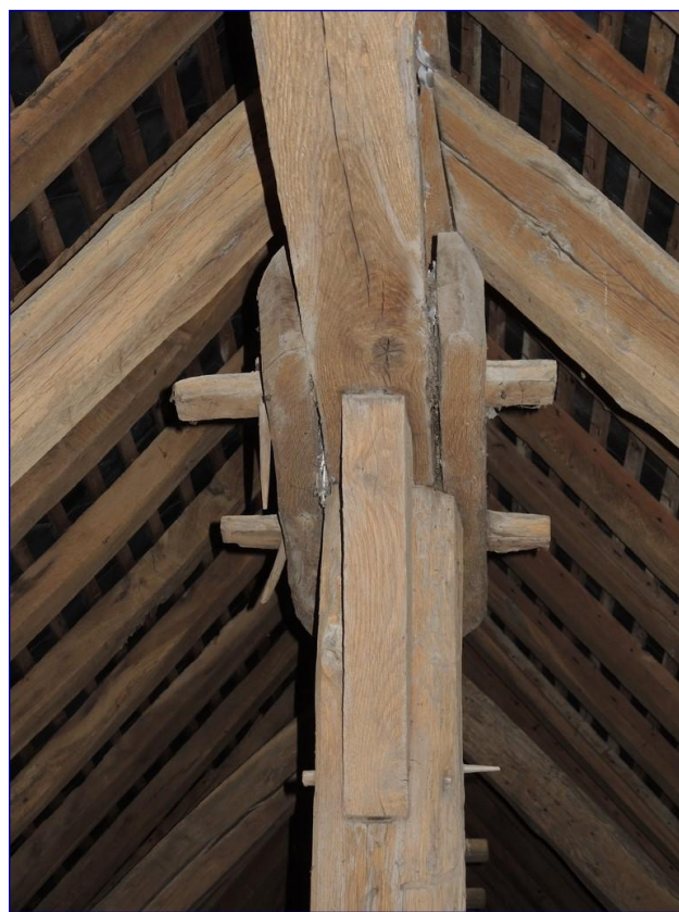
Fig. 18 : charpente de la nef, amoisés solidarisés par des clavettes
