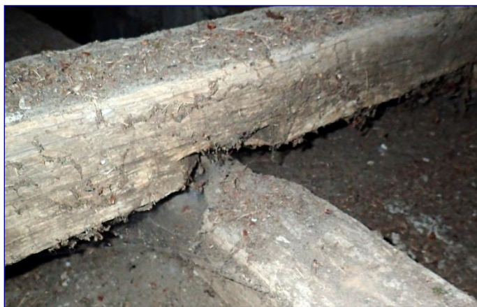
Charpente de la travée droite, assemblage de la sous-faîtière et de l'entrait retroussé
