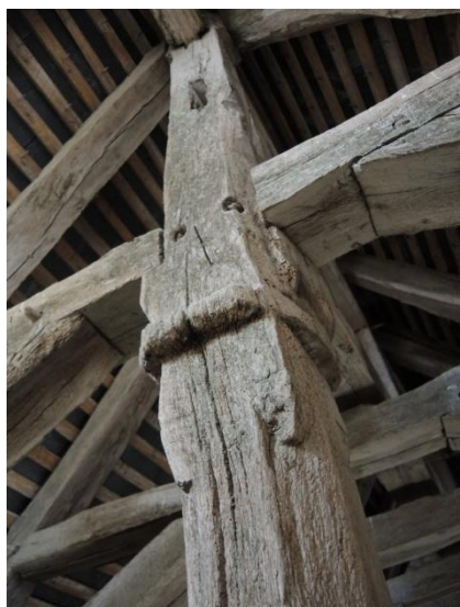
Chapelle nord, assemblage en tête d'un poinçon
