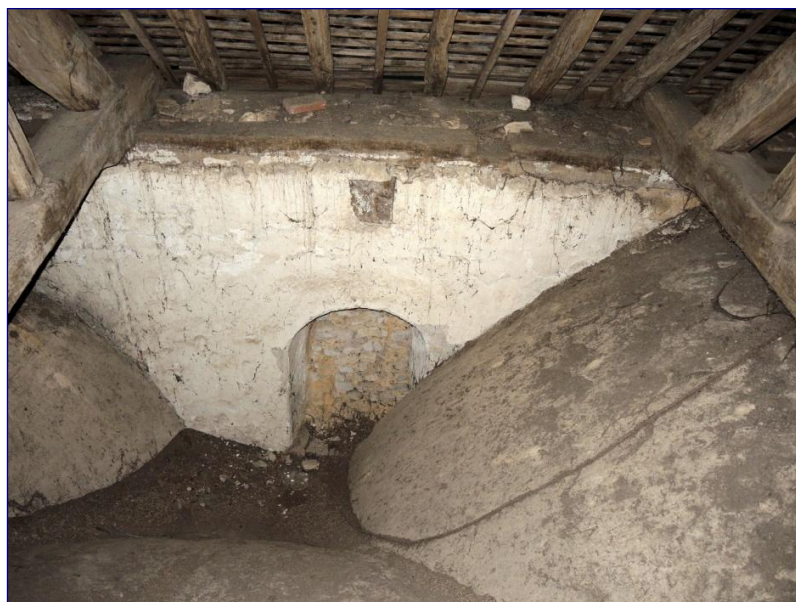
Fig. 15 : charpente de la nef, gouttereau sud avec ancienne baie murée
