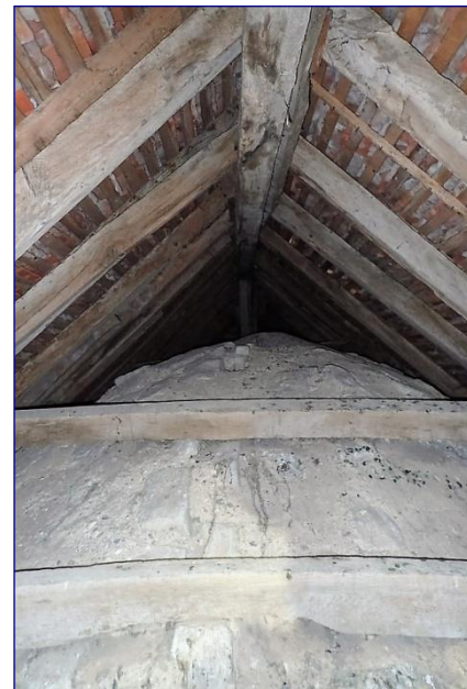
Charpente du chœur, vue vers l'est
