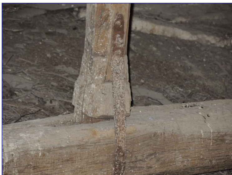
Fig. 10 : charpente du chœur, base buticulaire d'un poinçon
