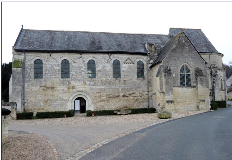
Fig. 1 : vue générale de l'église côté sud
