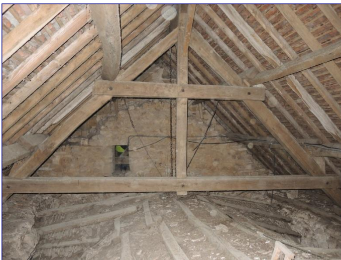
Charpente du chœur, travée ouest vers l'ouest
