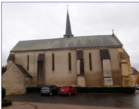
Charpente du vaisseau (nef et travée droite du chœur)
