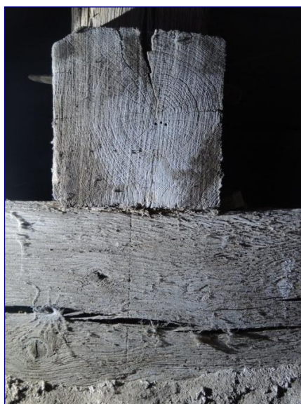
Fig. 13 : charpente de la nef, trait d'établissage sous un blochet
