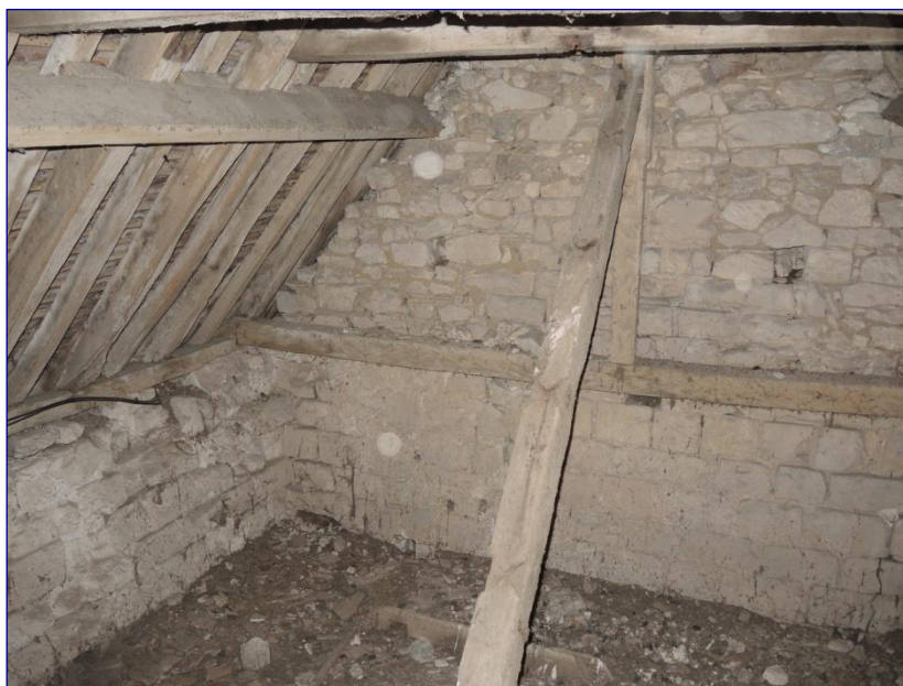
Fig. 16 : charpente de l'abside, ferme orientale et chevronnage au nord
