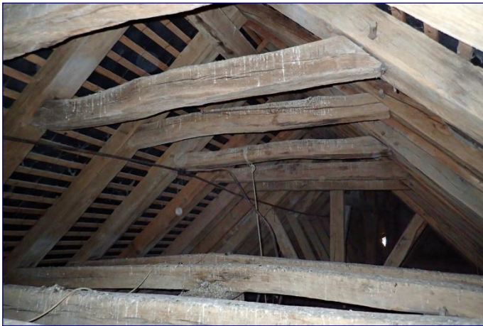
Structure intermédiaire vers l'est
