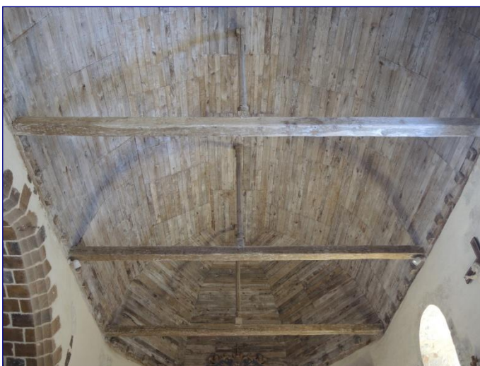
Charpente lambrissée du chœur entièrement refaite en 2007
