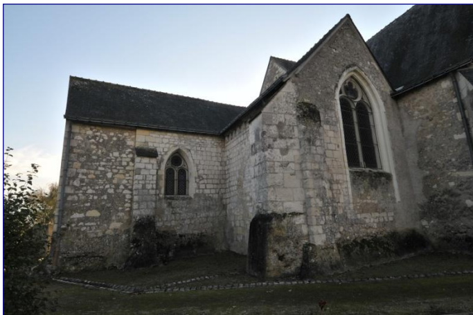
Partie orientale de l'église, vue vers le sud
