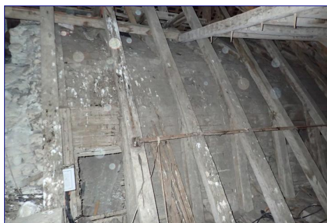
Charpente de la nef vue depuis le comble de la chapelle nord
