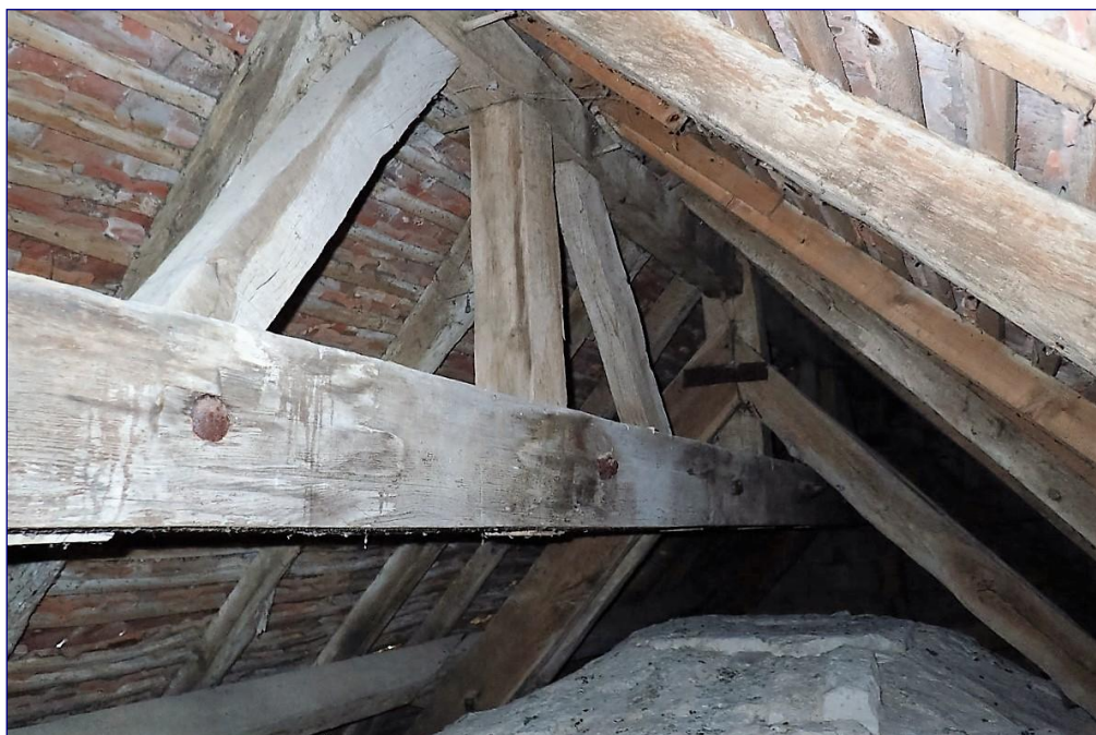
Charpente de la nef, contreventement
