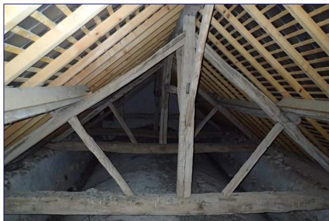
Charpente de la nef
