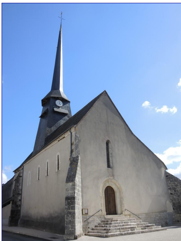
Fig. 1 : vue générale vers le sud-est
