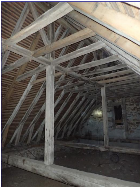
Charpente ouest, vue générale vers l'est
