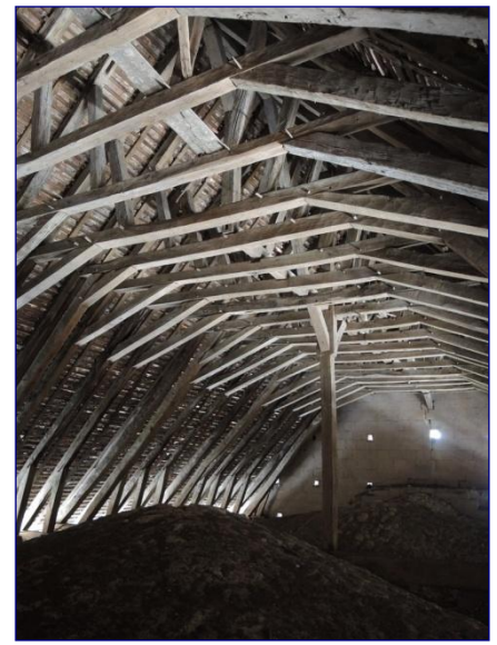
Charpente de la nef vers l'ouest
