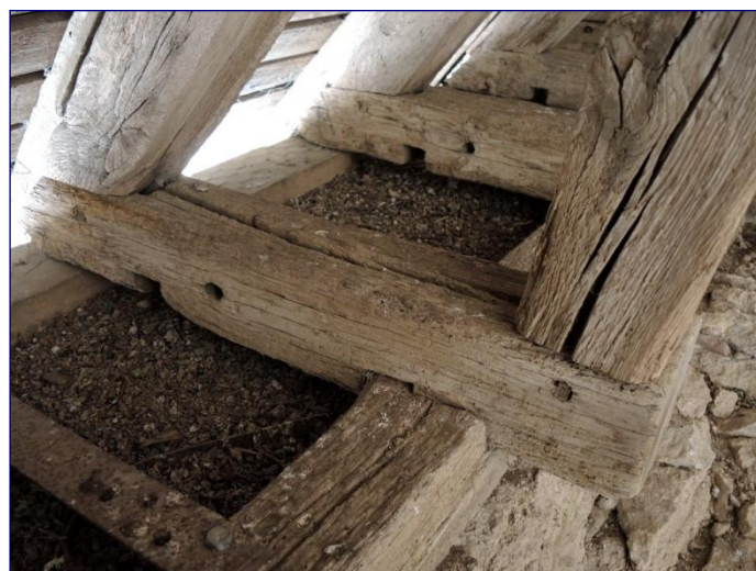
Fig. 9 : charpente du chœur, détail d'un blochet
