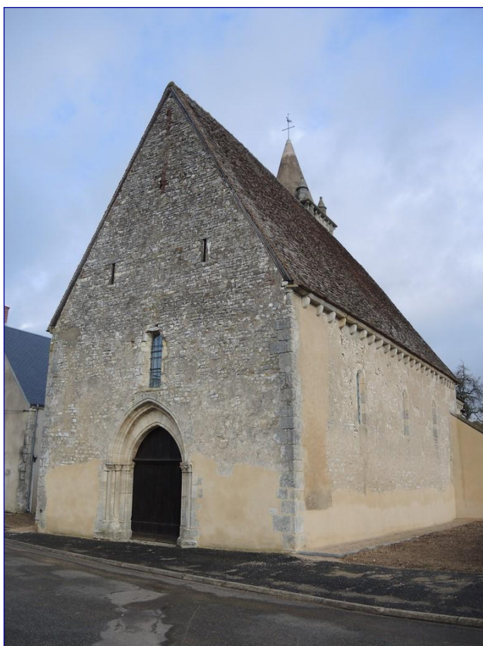
Fig. 1 : vue générale de la nef vers le nord-est
