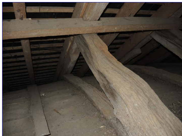
Fig. 11 : charpente du chœur, aisselier courbe
