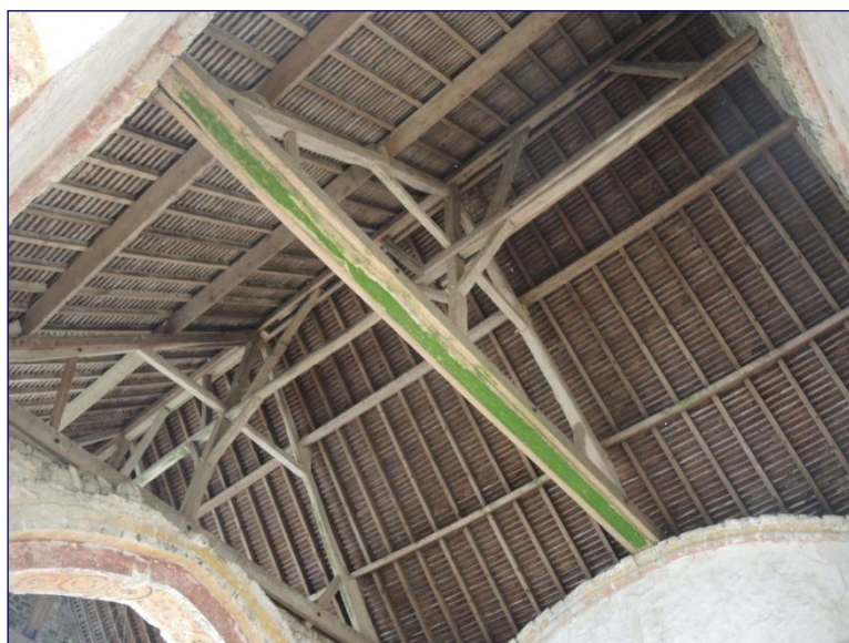
Charpente du vaisseau
