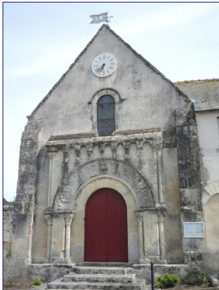
Fig. 2 : façade occidentale de l'église
