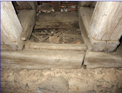
Structure est, assemblage des sablières
