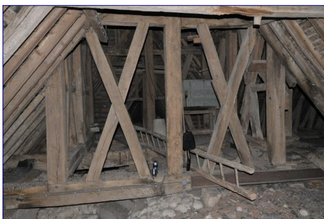
Fig. 17 : clocher, face ouest du beffroi
