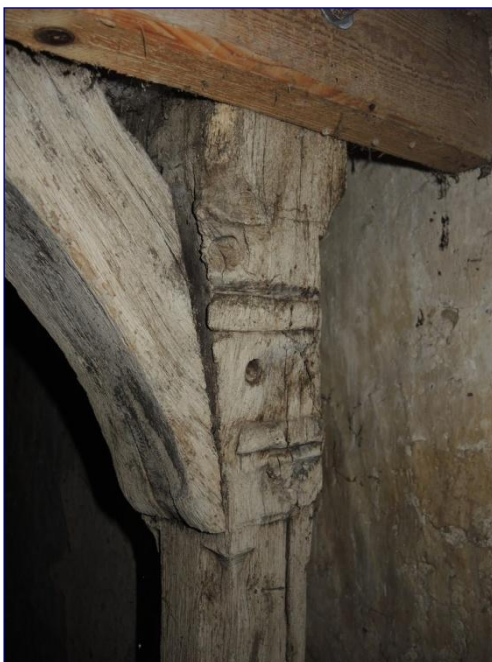
Charpente de la nef, poinçon sculpté de F1
