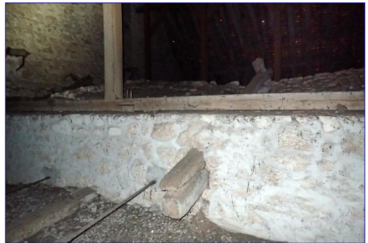
Fig. 10 : partie orientale de la charpente, écharpes croisées et entrant d'une ancienne ferme
