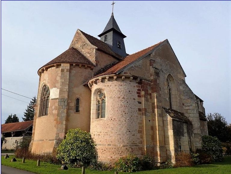
Charpente du chœur, ferme centrale à l'entrait arqué
