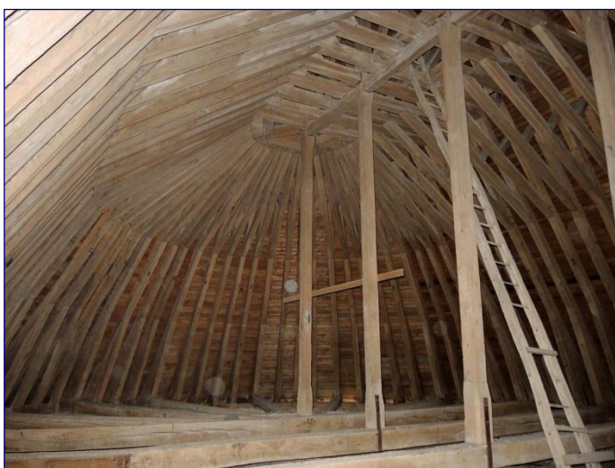
Charpente du chœur, vers la croupe à l'est
