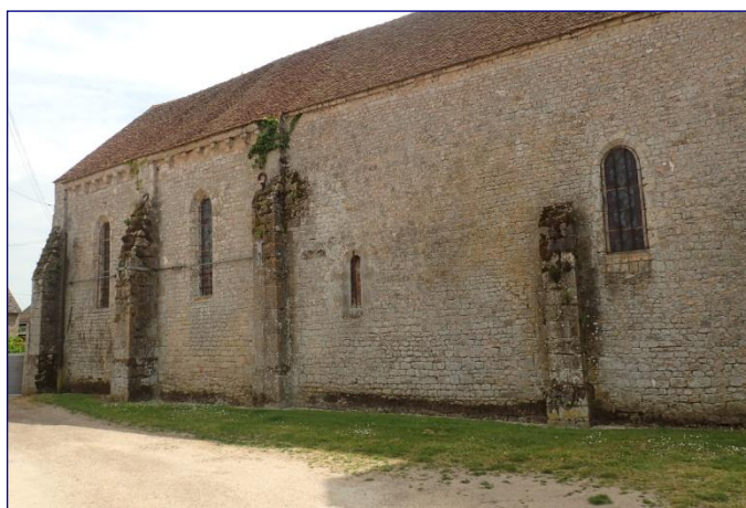
Mur gouttereau de la nef et du chœur
