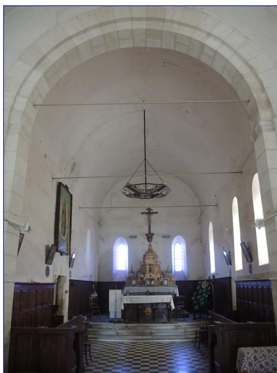
Fig. 4 : vue intérieure du chœur
