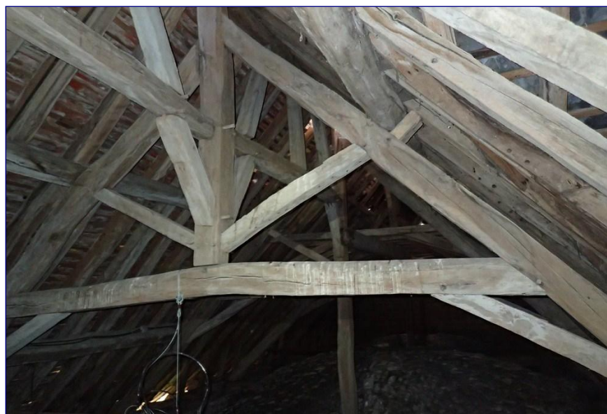
Charpente de la nef
