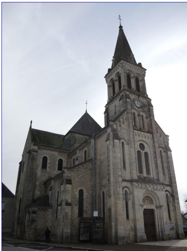
Fig. 1 : vue générale de l'édifice vers le sud-est
