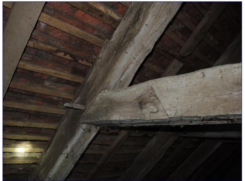
Charpente du chœur, travée est, entrait retroussé avec mi-bois (remploi)
