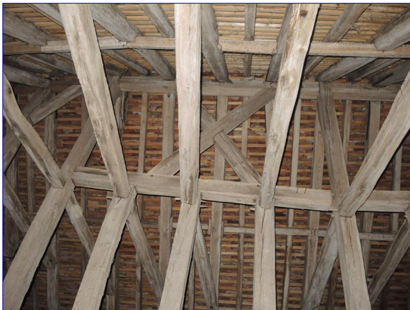
Fig. 15 : contreventement longitudinal
