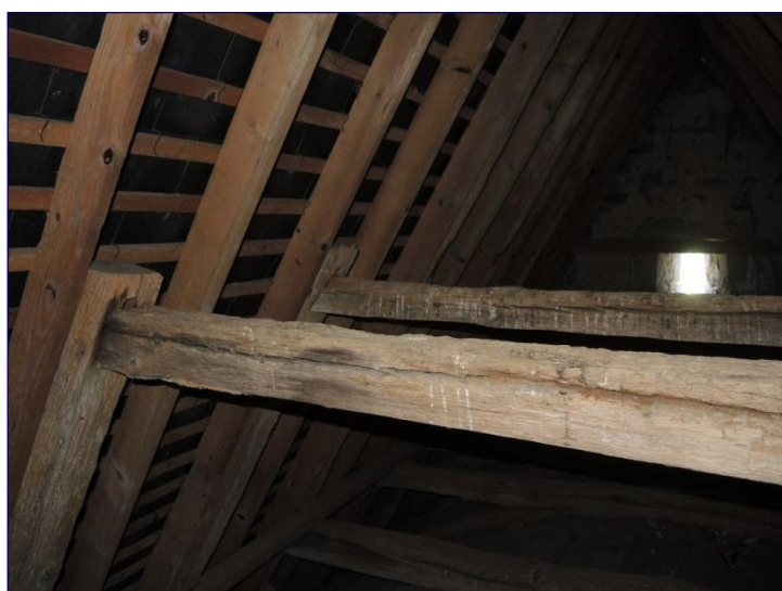
Fig. 9 : charpente du chœur, assemblage à tenon-mortaise
