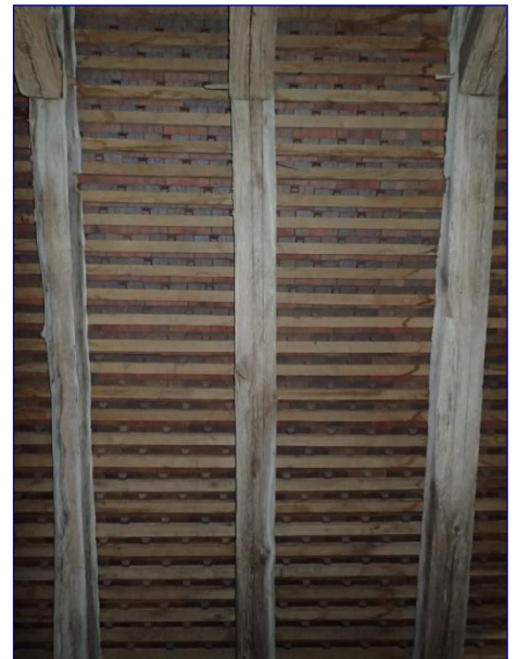
Charpente ouest, lignage au noir en sous-face
