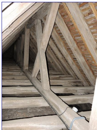
Contreventement de la charpente
