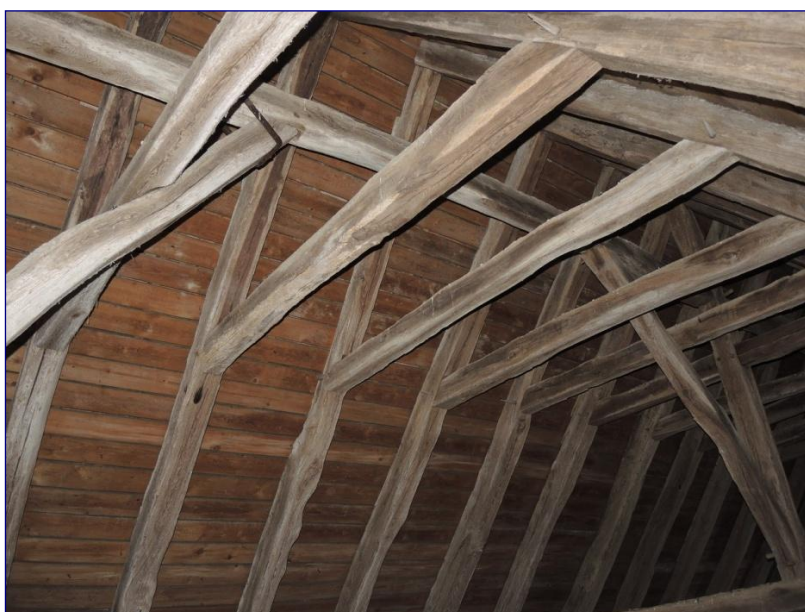
Fig. 10 : charpente de la nef, détail du contreventement
