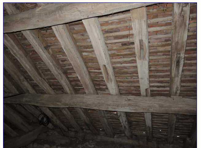
Fig. 8 : charpente du chœur, chevrons en remploi
