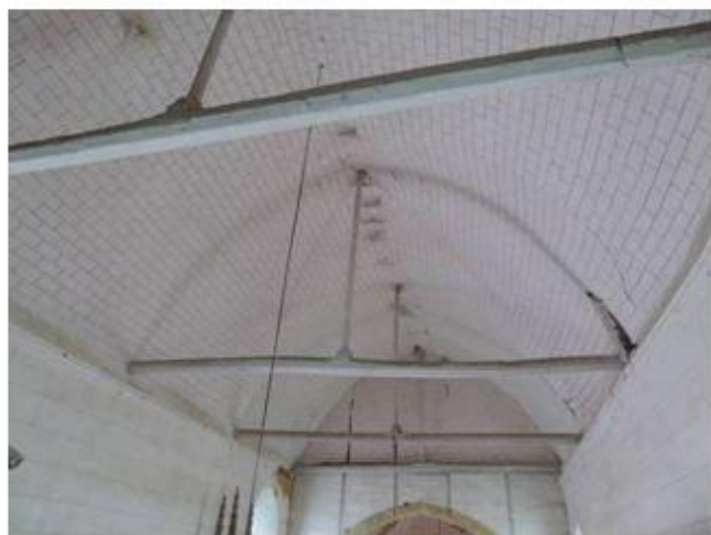
Fig. 3 Charpente voûtée de la nef
