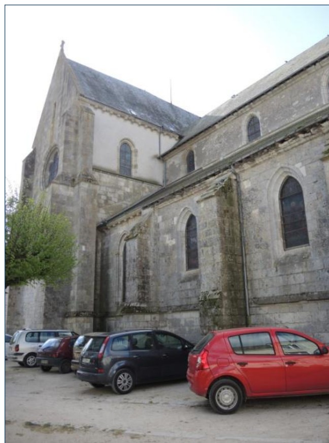
Fig. 2 : bras nord du transept et nef
