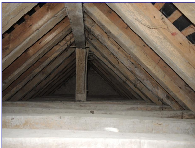
Fig. 15 : chapelle méridionale, partie haute de la charpente
