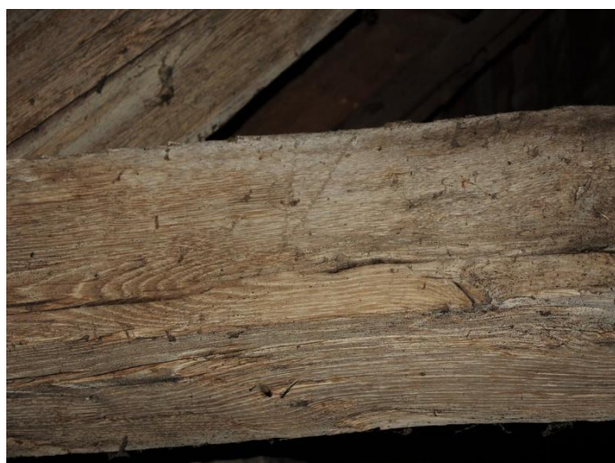
Charpente de la nef, marquage avec rouanne
