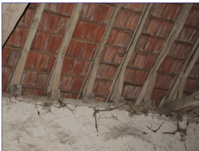
Charpente du chœur, pied des chevrons sur blochets
