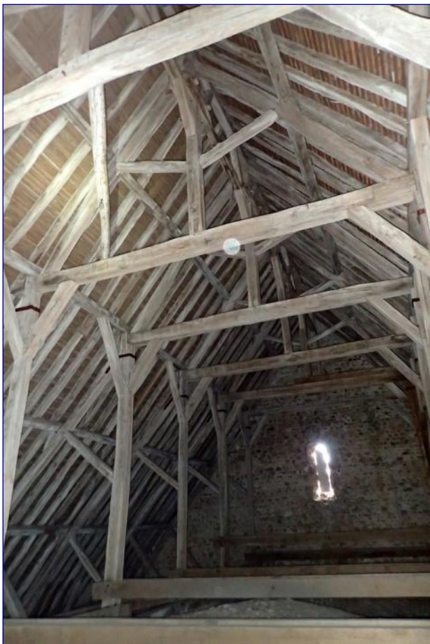
Fig. 13 : partie occidentale de la charpente vers l'ouest
