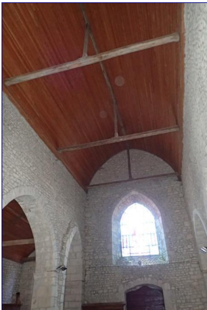
Charpente de la nef vers l'ouest
