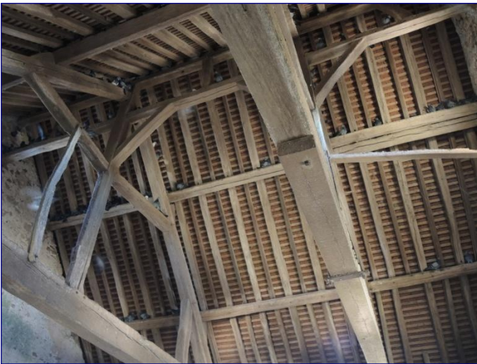
Charpente du clocher
