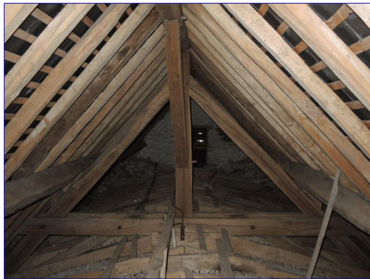
Fig. 13 : charpente du chœur, ferme principale
