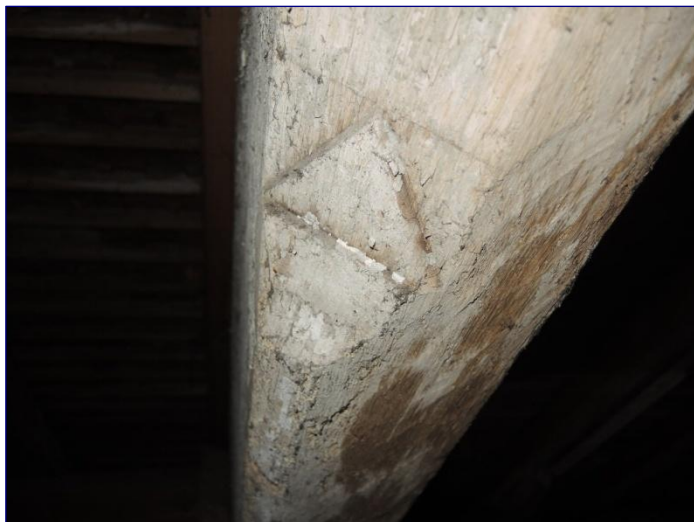
Fig. 8 : ancien entrain, détail d'un congé de chanfrein
