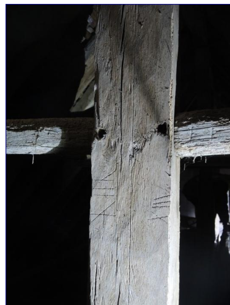
Poinçon avec lignage axial et marquage
