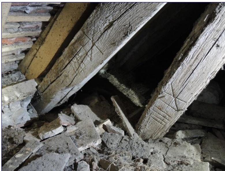
Fig. 12 : charpente de la nef, marques n° 19 (XVIII) en pied de chevron et jambette
