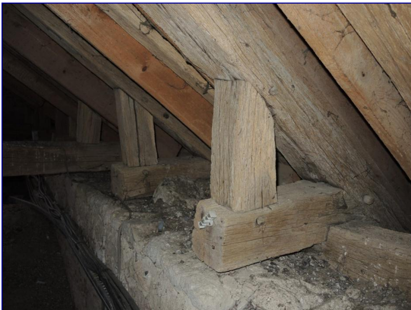
Fig. 10 : chœur, charpente du vaisseau central, blochets des fermes secondaires et sablière externe
