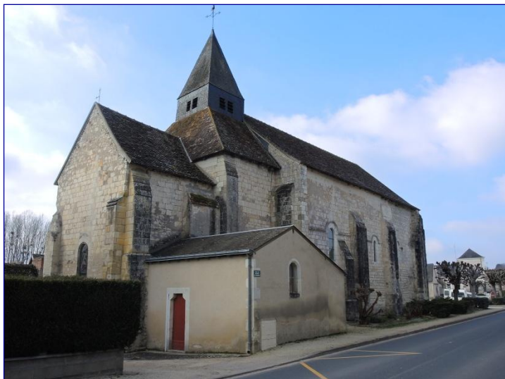
Fig. 1 : vue générale de l'église vers le sud-ouest
