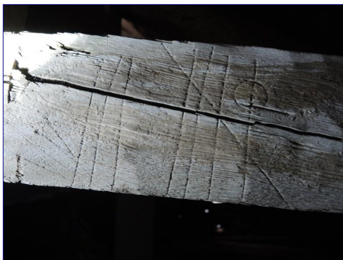
Charpente du vaisseau, marquage avec contremarque en rouanne
