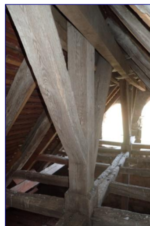
Charpente de la travée droite du chevet, détail
