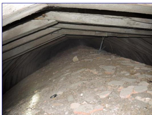
Charpente du vaisseau vers l'est
