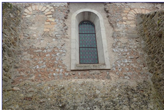
Mur nord de la nef
