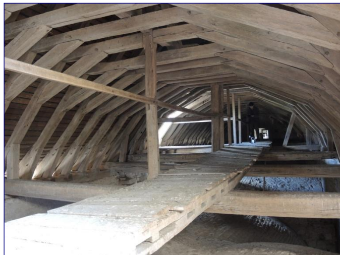
Fig. 19 : charpente de la travée ouest de la nef, vers l'est
