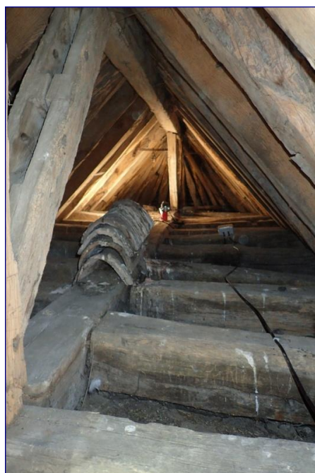
Fig. 11 : charpente du chœur vers l'est
