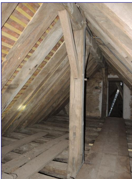
Charpente de la nef vers l'est
