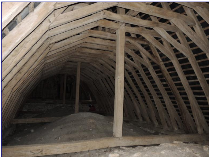
Charpente de la nef, vue générale vers l'ouest
