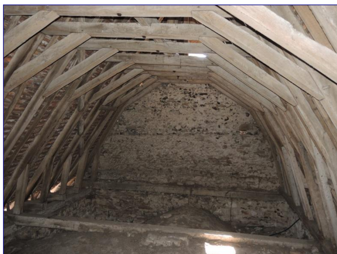
Fig. 14 : charpente de la chapelle sud, vue générale vers le sud
