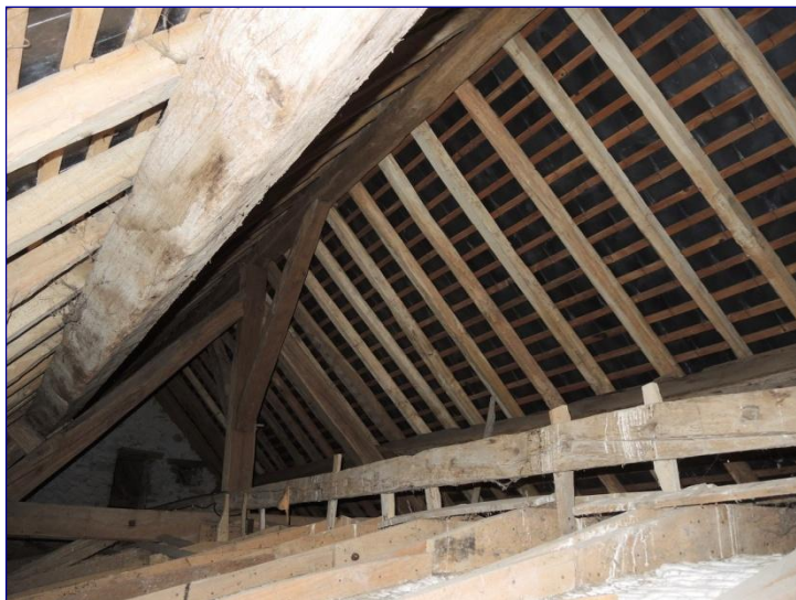
Fig. 12 : charpente de la nef, vue générale vers le sud-est
