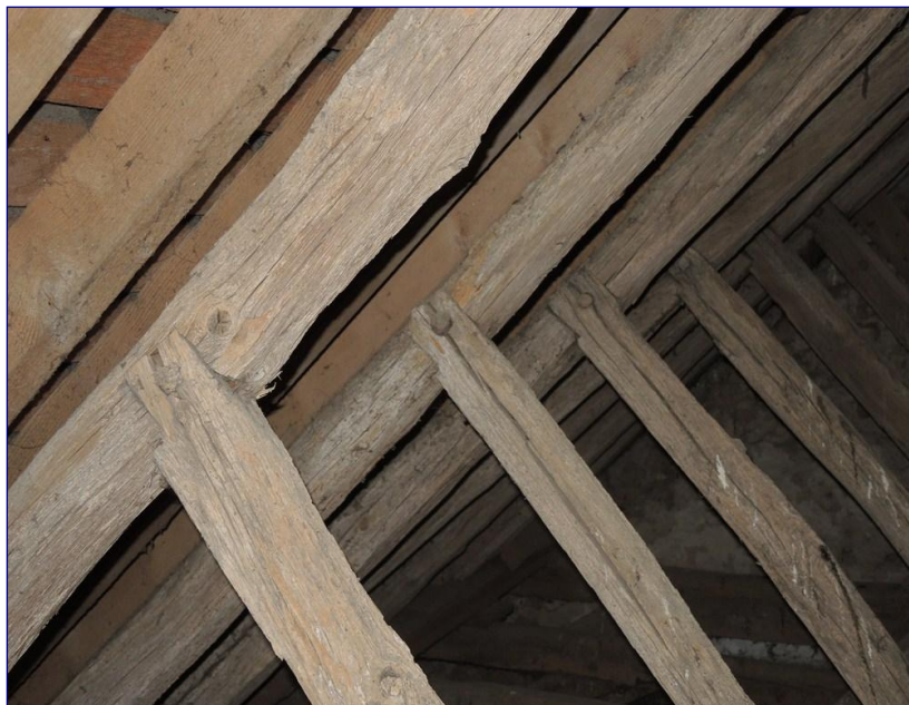
Fig. 6 : nef, structure 1, assemblage à mi-bois des écharpes
