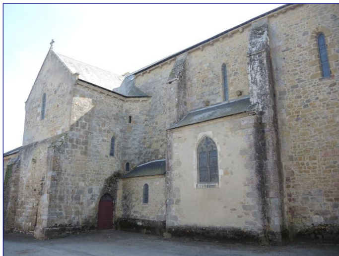
Mur nord de la nef et bras nord du transept
