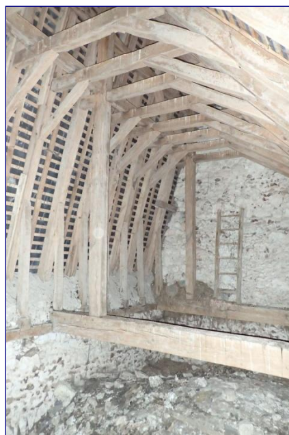
Charpente du chœur, vue vers l'est
