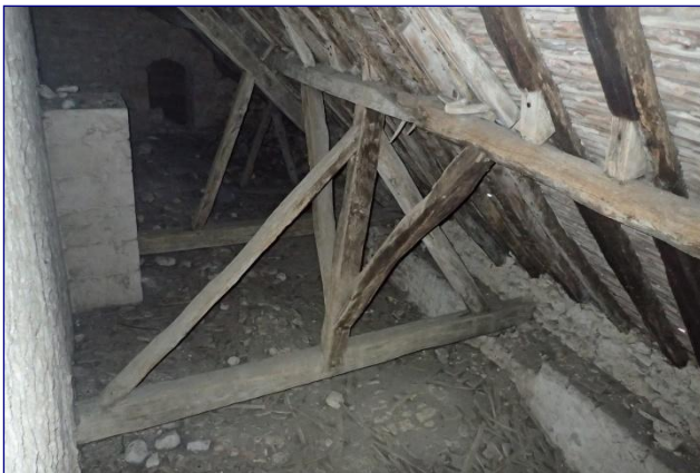
Charpente du collatéral sud, ferme médiane au 1 er plan
