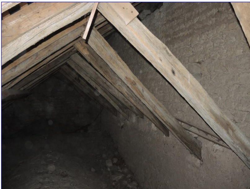
Fig. 13 : bas-côté nord du chœur, charpente en appentis, vue générale vers l'est
