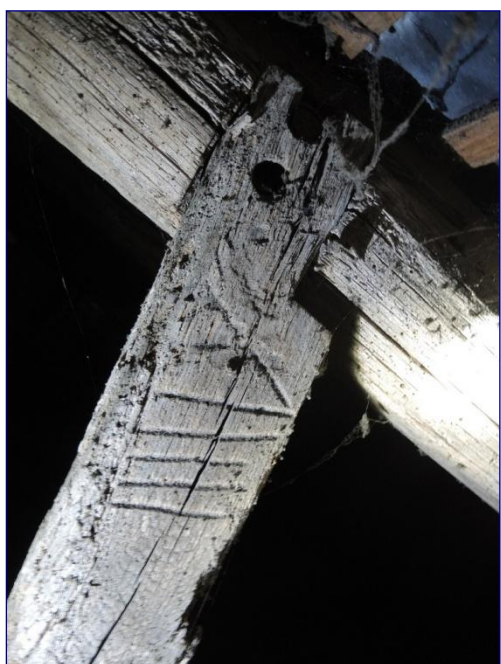
Fig. 9 : nef, structure 1, marque 9 sur une écharpe
