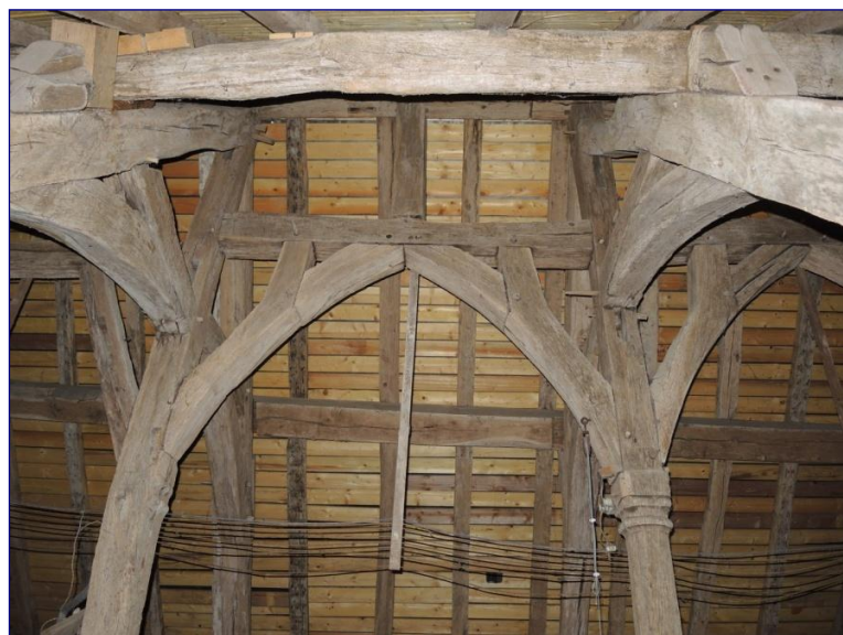
Fig. 8 : charpente de l'avant-chœur, travée médiane
