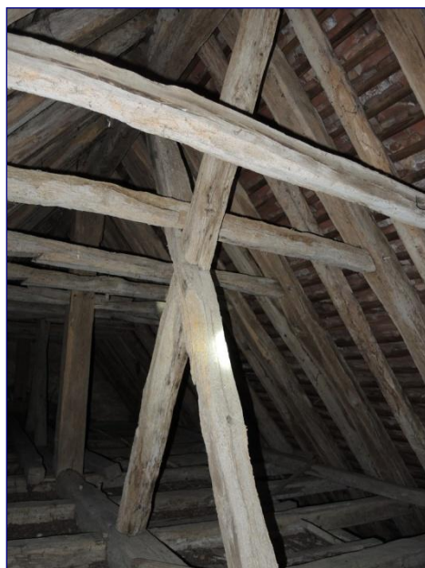
Charpente de la nef, contreventement
