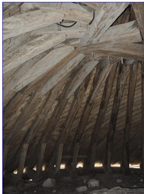
Charpente en croupe de l'abside
