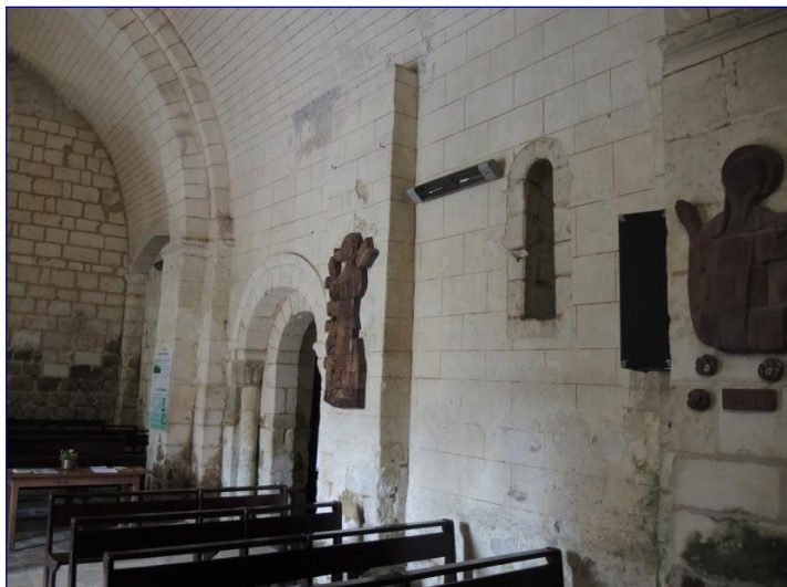
Fig. 5 : ancien gouttereau sud du vaisseau nord
