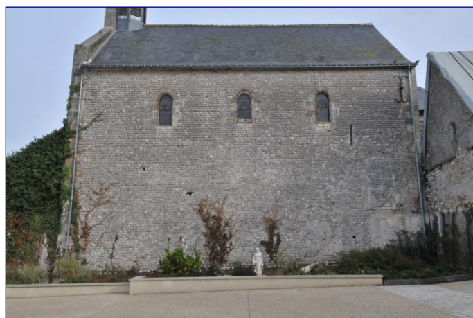
Mur sud de la nef
