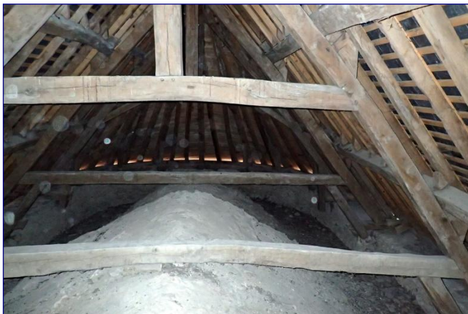
Charpente du chœur vers l'est
