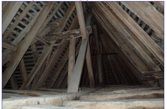
Charpente du chœur, vue générale au-dessus des entrants retroussés
