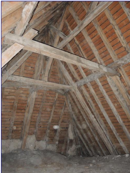
Charpente de la chapelle nord
