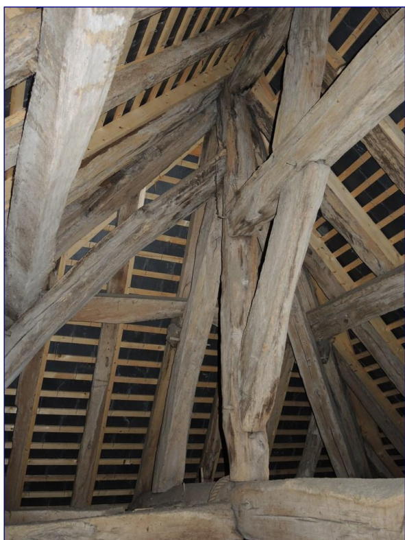
Charpente de la chapelle sud, croupe droite
