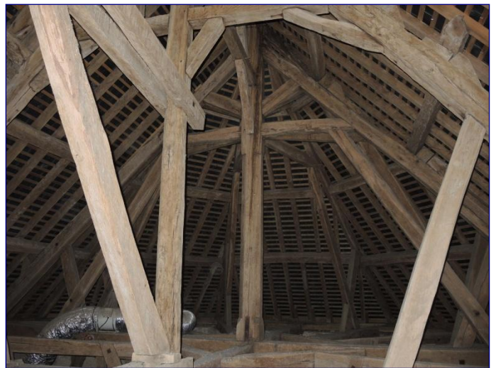
Charpente du chœur, vue générale vers l'est
