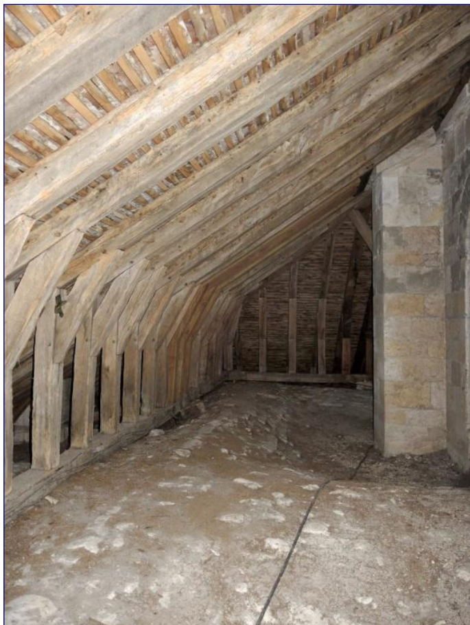
Fig. 15 : charpente du déambulatoire, côté est
