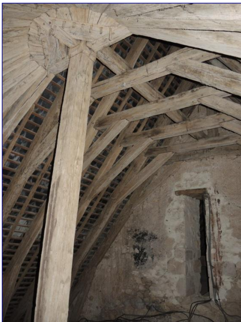
Fig. 5 : charpente de la travée droite vers l'ouest
