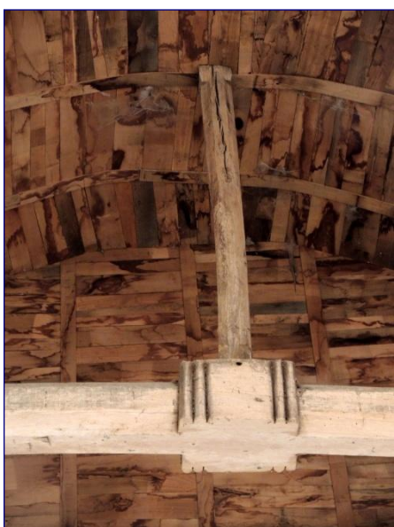
Charpente de la nef, détail d'un poinçon
