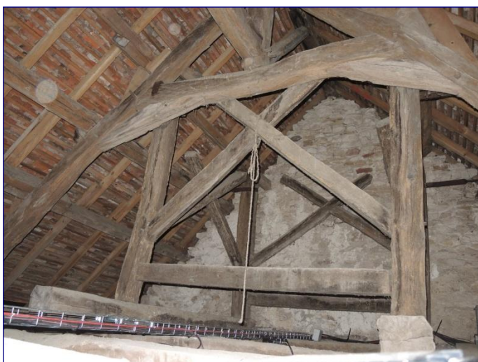
Charpente de la nef, base d'un clocher de charpente à l'est
