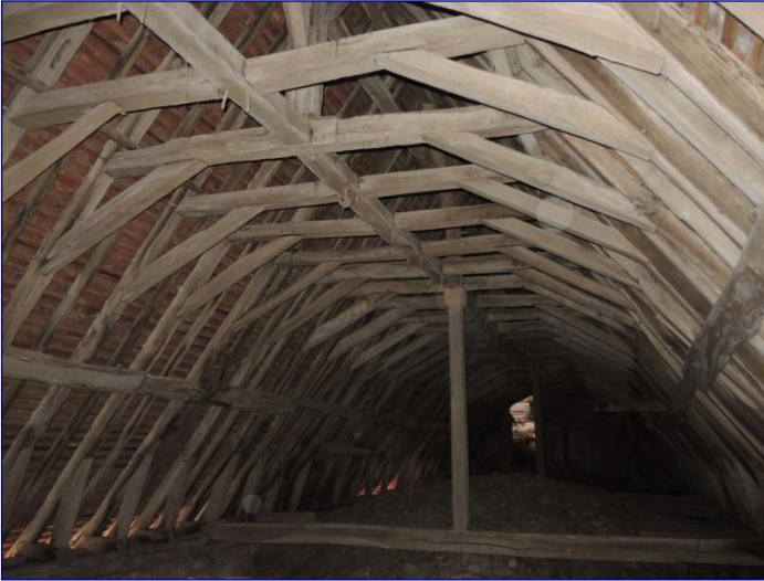
Charpente de la nef, vue générale vers l'ouest
