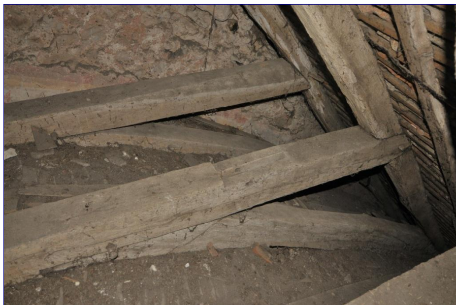
Fig. 9 : charpente de la nef, faux-entrait (ancien entrait retroussé en remploi)
