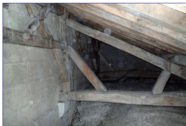
Charpente en appentis de la chapelle nord
