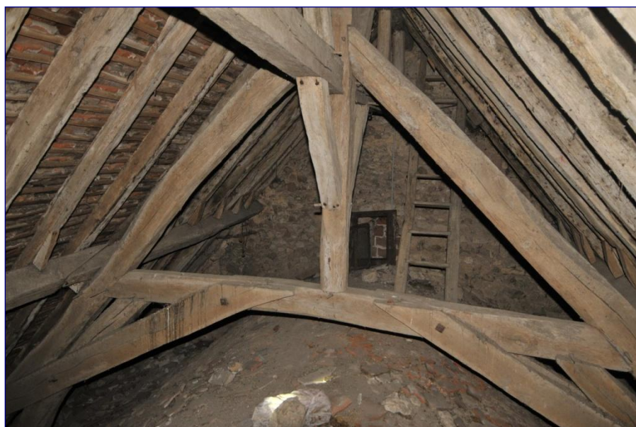
Fig. 10 : charpente de la travée droite, vue générale vers l'est
