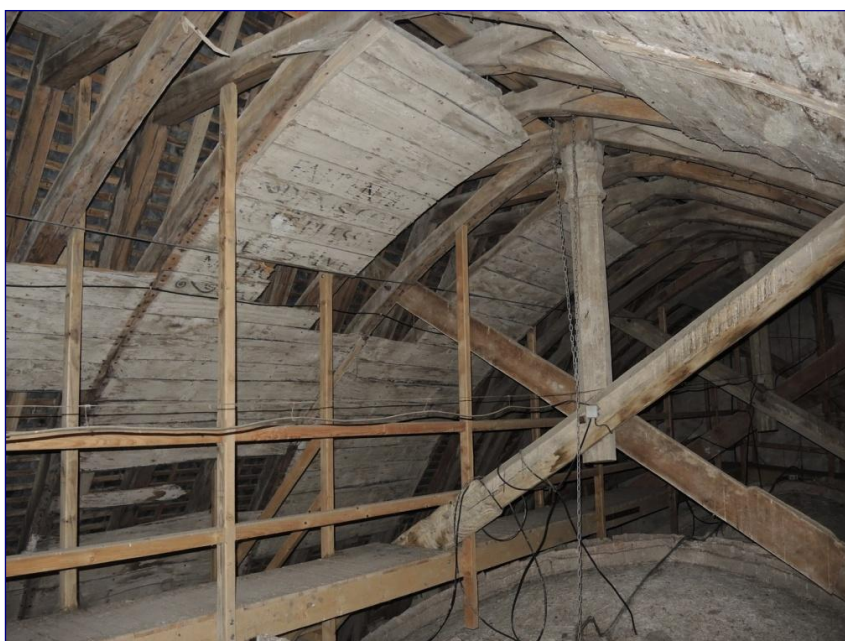
Fig. 6 : charpente de la nef et son lambris du XVIII e s.
