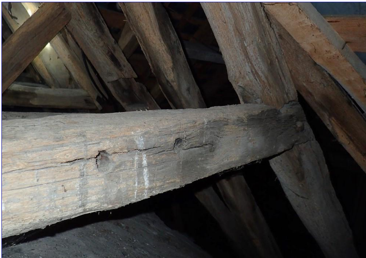
Fig. 11 : charpente du chœur, trous de levage sur le faux-entrait (F6)
