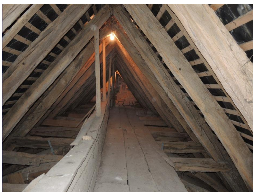
Fig. 6 : charpente de la nef vers l'est
