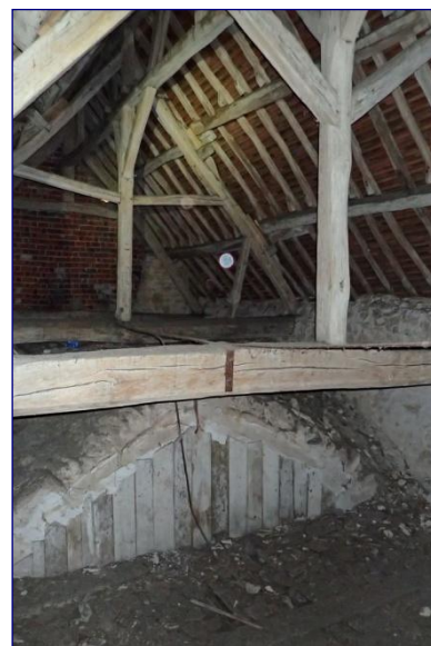
Charpente du vaisseau vers l'est
