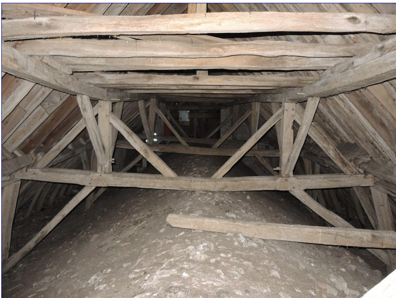
Fig. 7 : charpente de la nef, vue générale vers l'est
