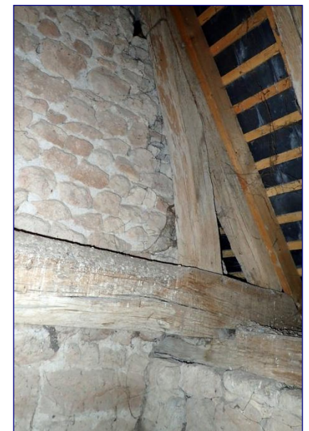
Charpente du chœur, détail d'un entrâit
