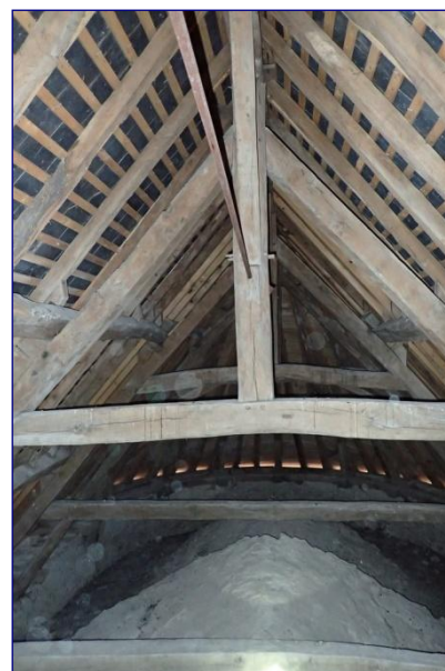
Charpente du chœur vers l'est
