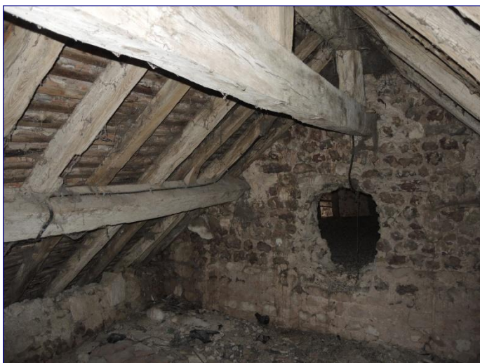
Charpente du chœur, travée est, vue vers l'ouest
