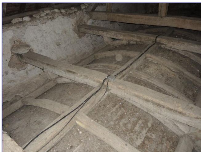
Voûte suspendue de la nef
