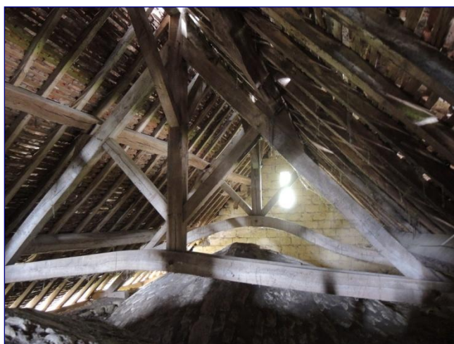
Vue générale de la charpente
