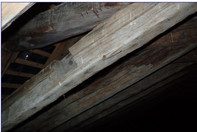
Charpente du vaisseau, aisselier, pièce de rempli avec mi-bois
