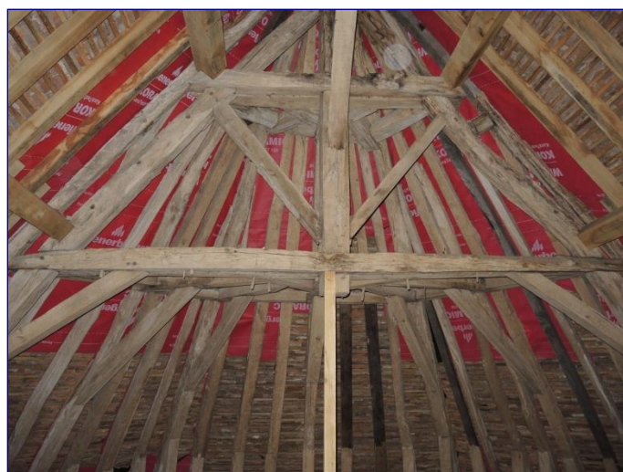
Charpente de l'abside
