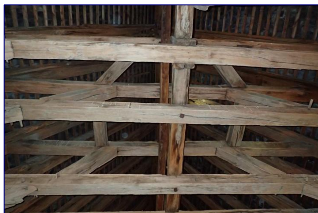
Charpente du chœur, élément de la plate-forme sur laquelle se dressait un clocher de charpente
