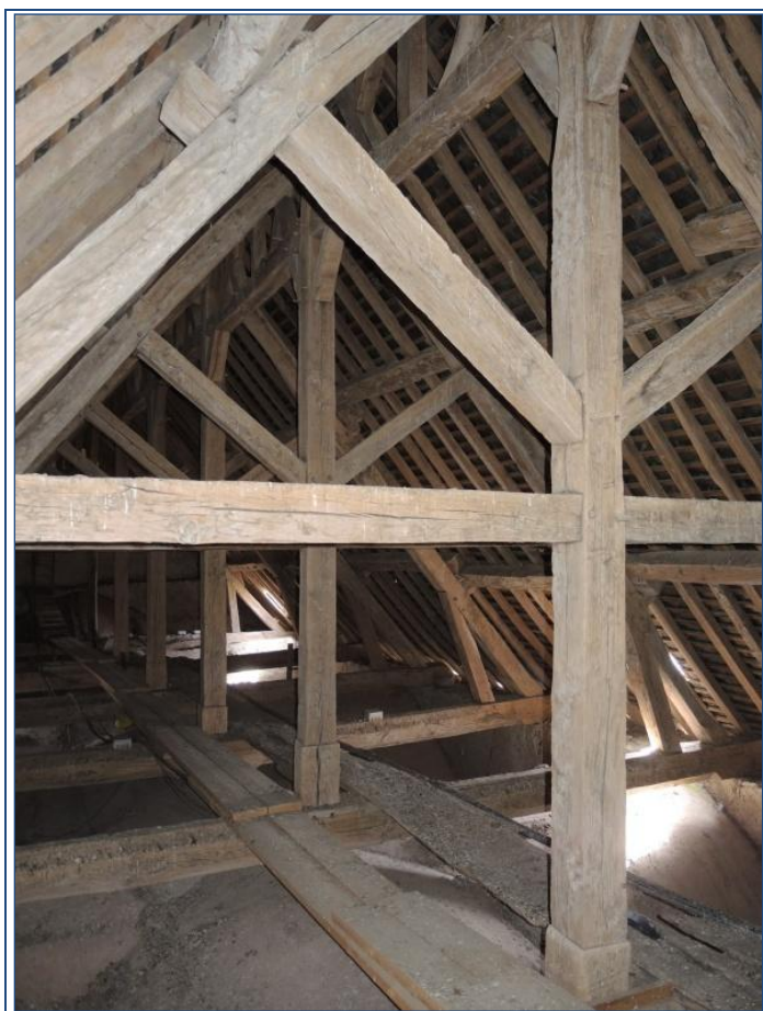
Fig. 10 : charpente de la nef vers l'est
