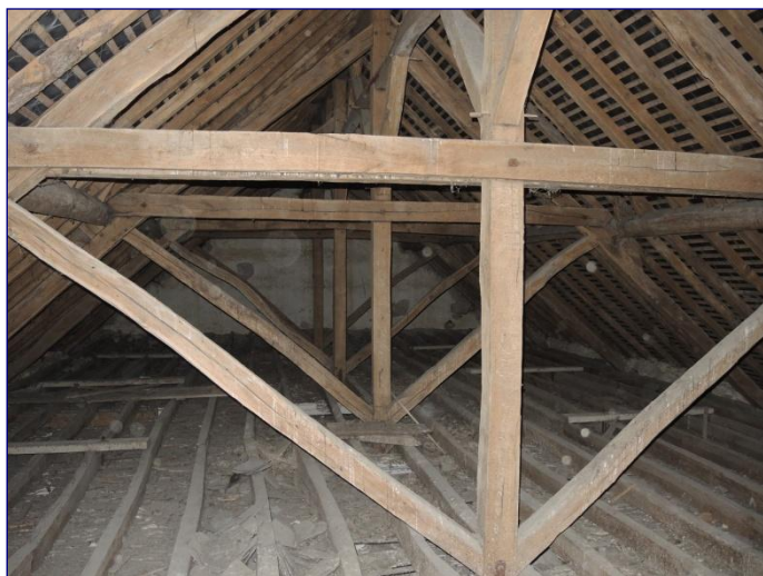
Charpente de la nef, vue vers l'ouest
