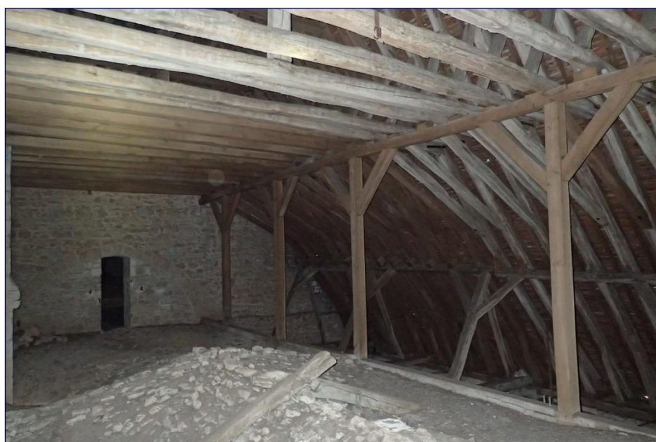
Fig. 7 : partie orientale de la charpente vers l'ouest
