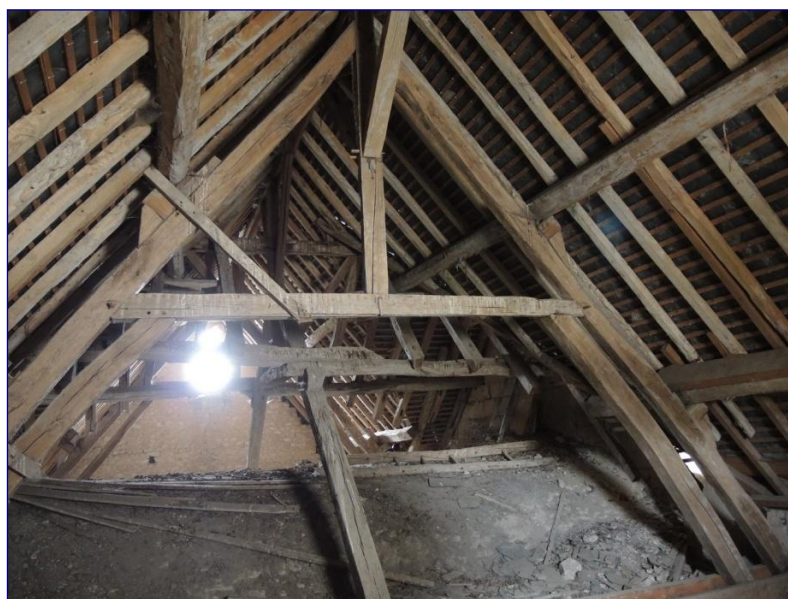
Fig. 11 : charpente de la chapelle sud vers le nord
