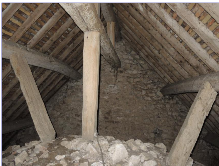
Structure ouest vers l'est
