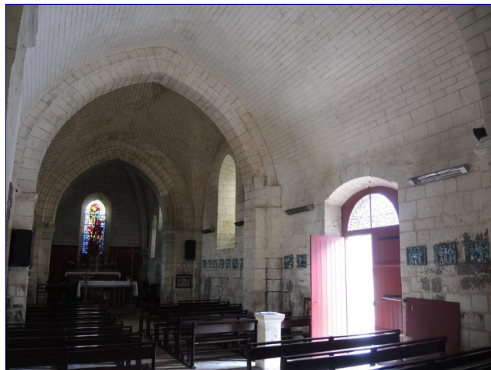
Fig. 6 : vaisseau sud, vue vers l'est
