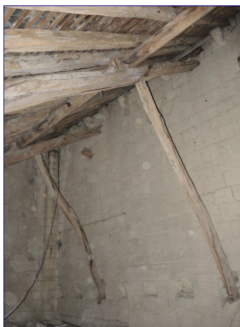
Fig. 16 : chapelle sud, contrefiches ancrées dans la maçonnerie
