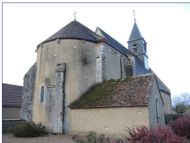
Chevet de puis le nord-est
