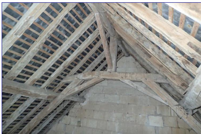
Charpente du chœur vers l'est
