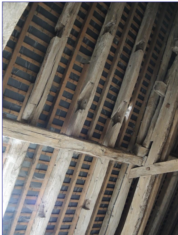
Fig. 9 : chevrons en remploi avec mi-bois
