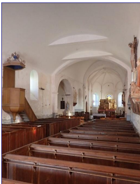
Vue générale de la nef vers le chœur
