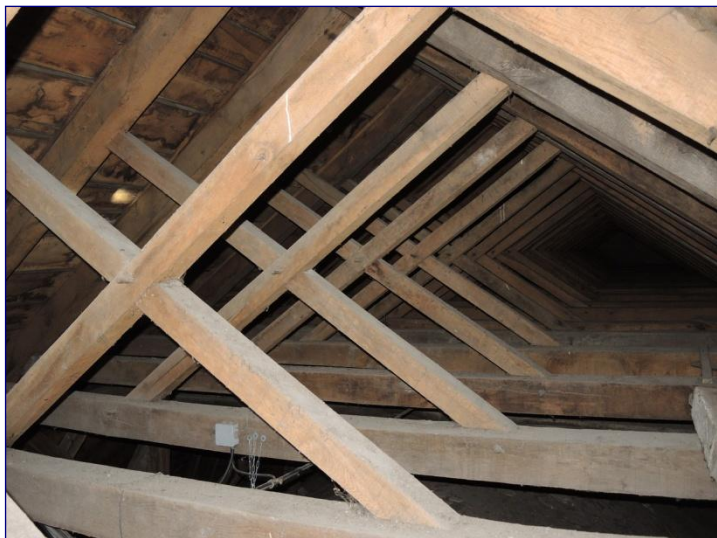
Fig. 5 : charpente de la nef, écharpes croisées et entrails retroussés
