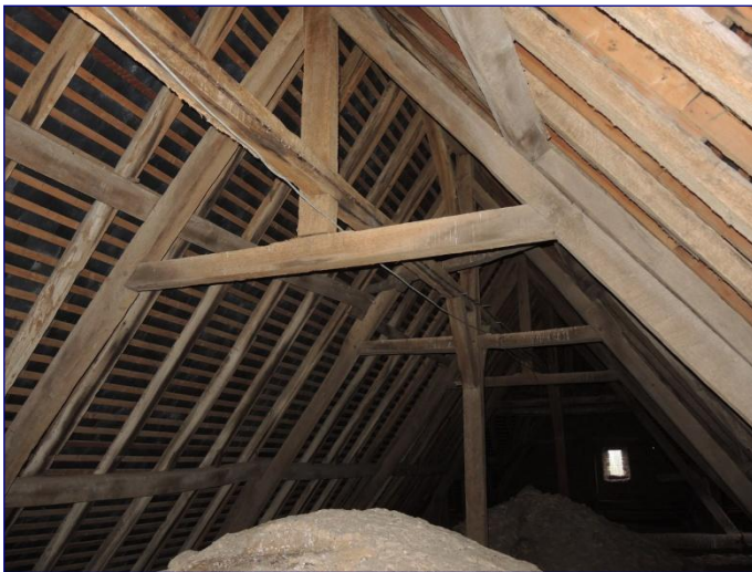
Charpente de la nef vers l'est
