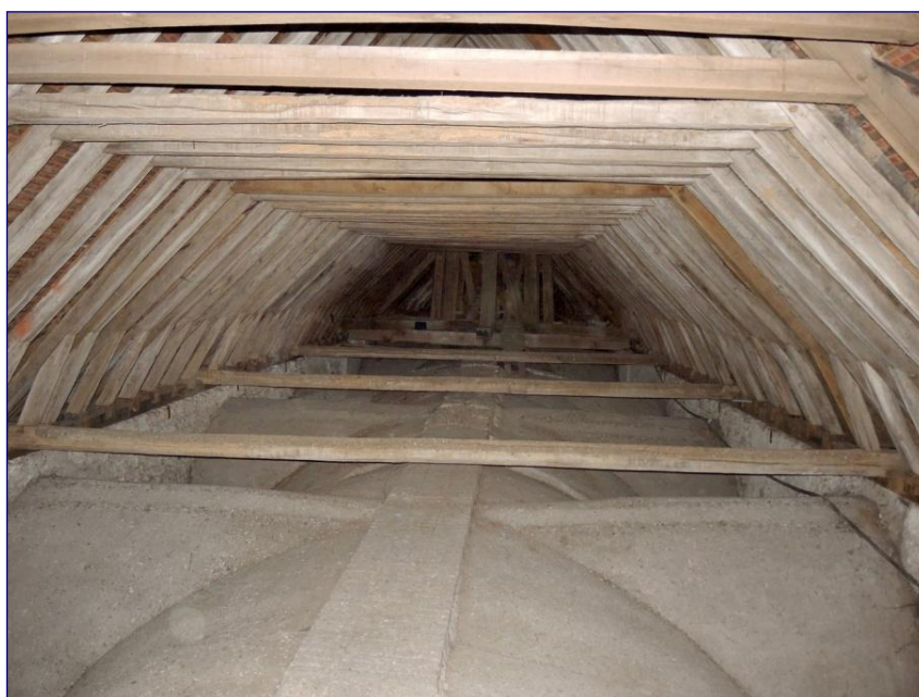
Fig. 14 : charpente de la nef vers l'est
