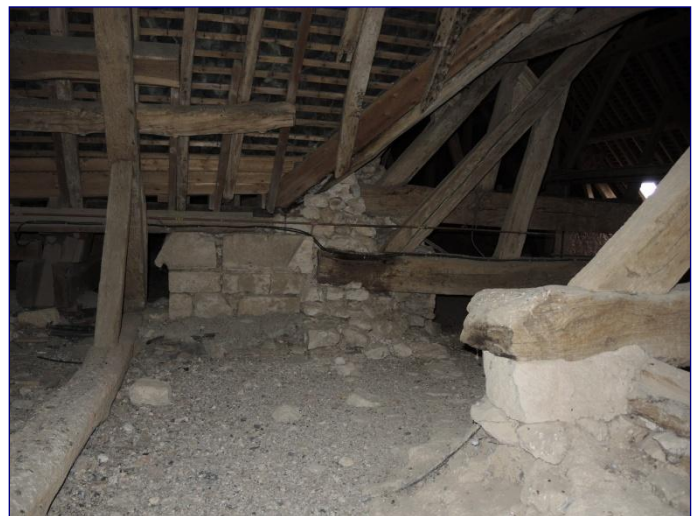
Arasement de la tourelle d'escalier au nord sur laquelle repose les fermes
