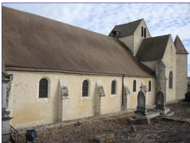
Fig. 3 : vue générale de la nef, côté sud
