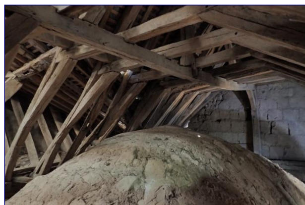
Charpente de chapelle sud vers le nord-est
