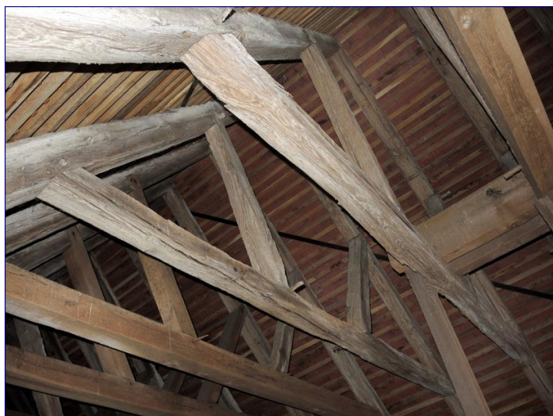
Fig. 9 : charpente est du chœur, partie supérieure des fermes
