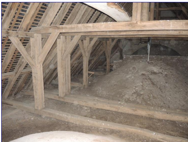
Charpente de la nef, poteaux entre les structures est et ouest
