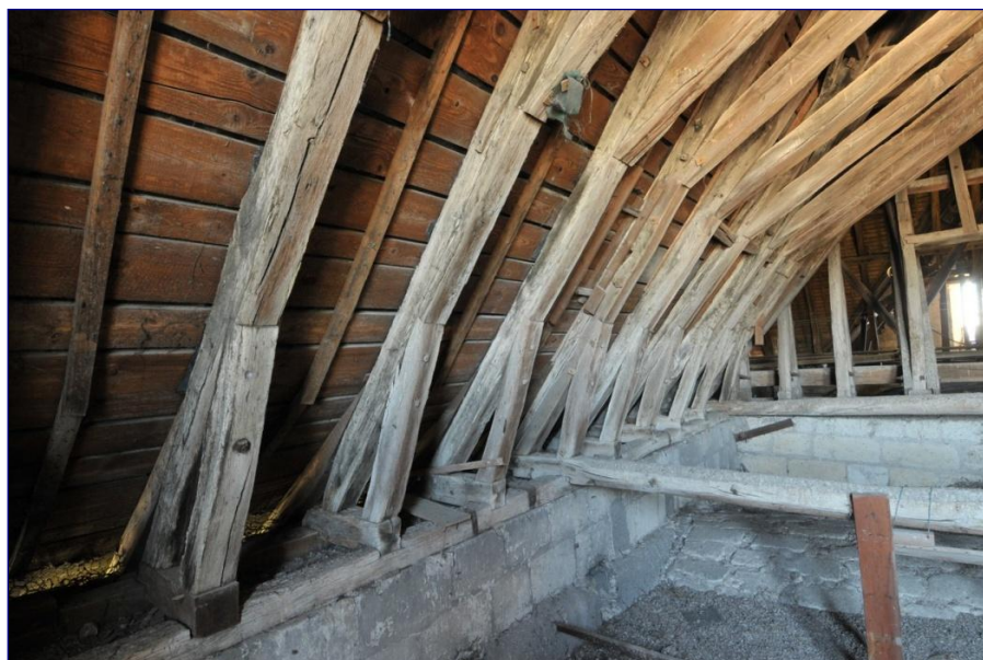
Fig. 11 : charpente du bras nord, jambettes avec double chevillage transversal
