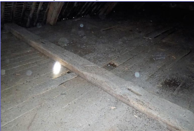
Nef, entrant d'une structure antérieure
