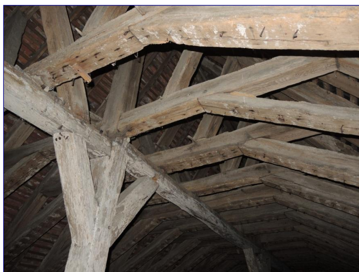
Fig. 6 : charpente de la nef, poinçon et faux-entrails
