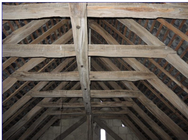
Fig. 8 : charpente du chœur, faux-entrails assemblés à mi-bois dans les chevrons et lierne
