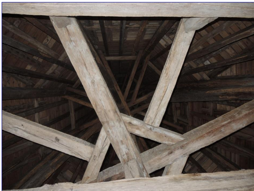
Enrayure basse de la flèche du clocher
