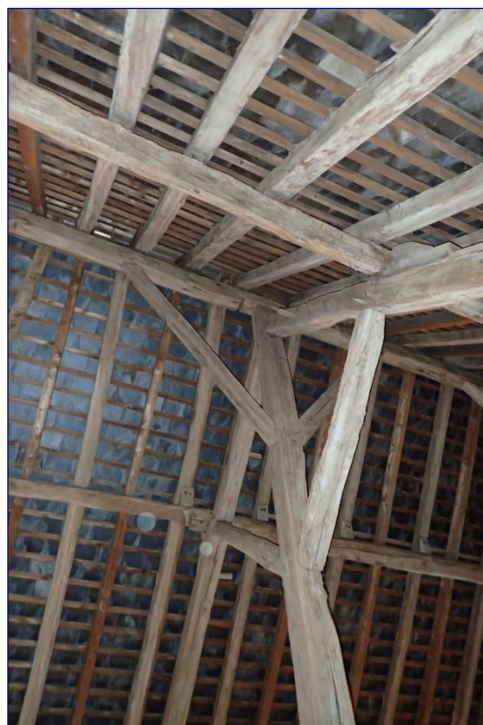
Contreventement longitudinal avec faitière et liens
