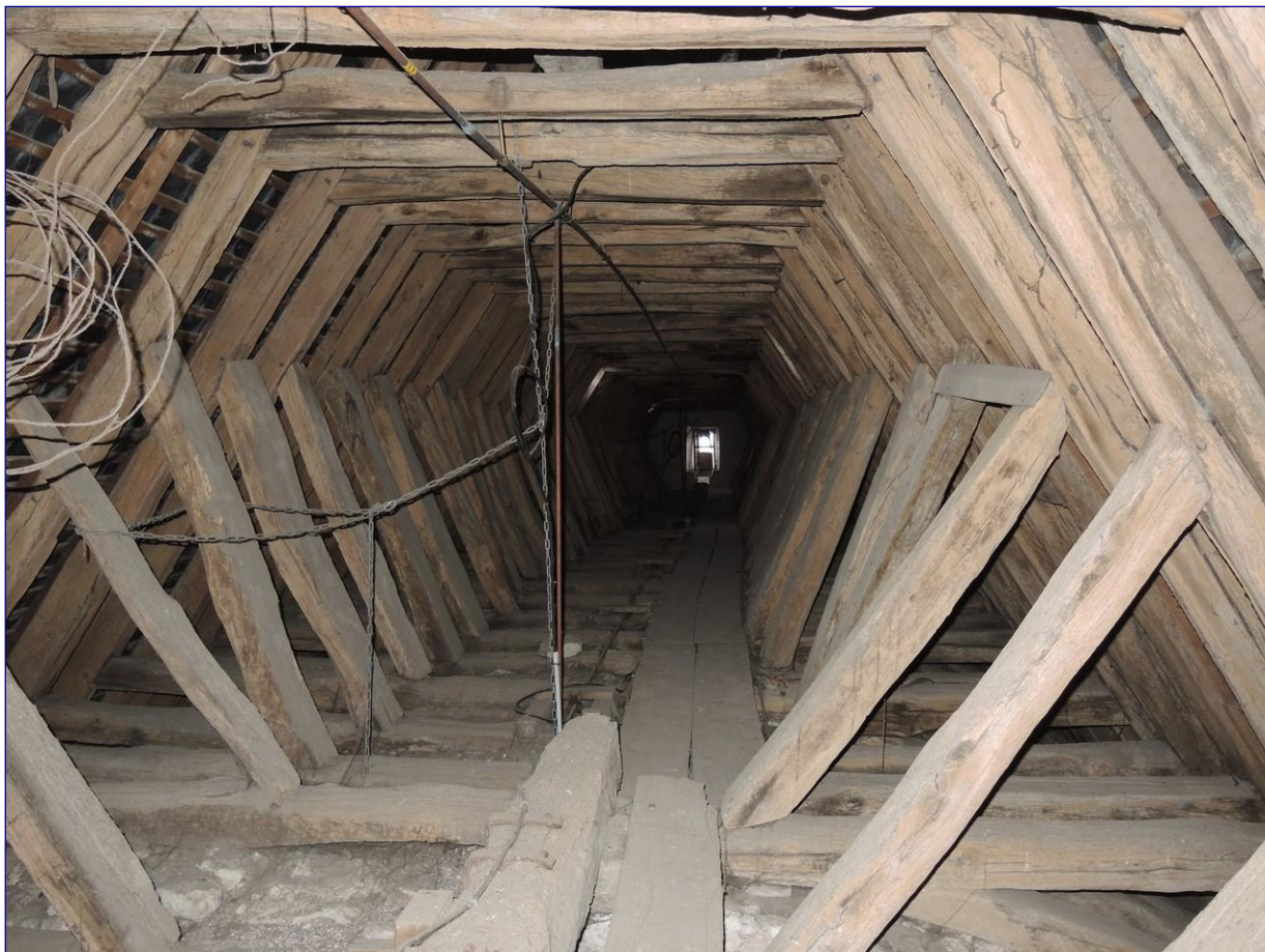
Fig. 8 : charpente du vaisseau principal, structure 1, vue générale vers l'est
