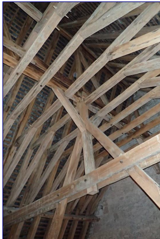
Charpente du chœur, ferme orientale, poinçon scié
