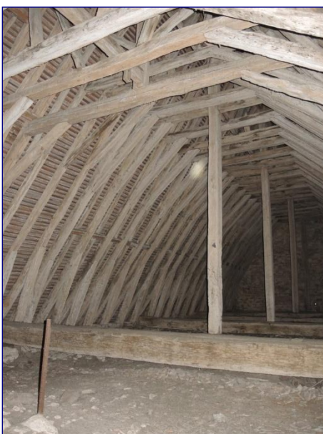
Charpente du chœur, vue générale
