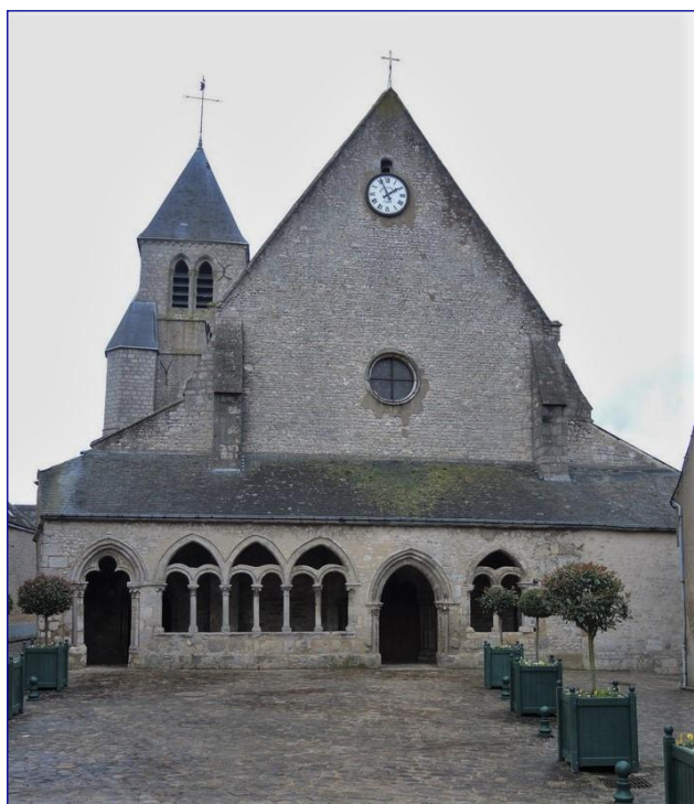
Fig. 1 : façade occidentale précédée d'une galerie
