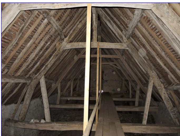
Charpente de la nef vers l'ouest
