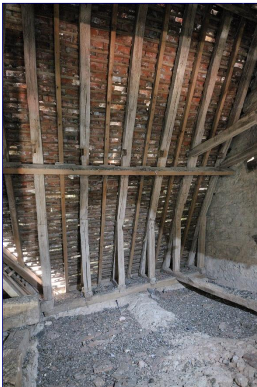
Fig. 13 : charpente du bras sud, rampant est
