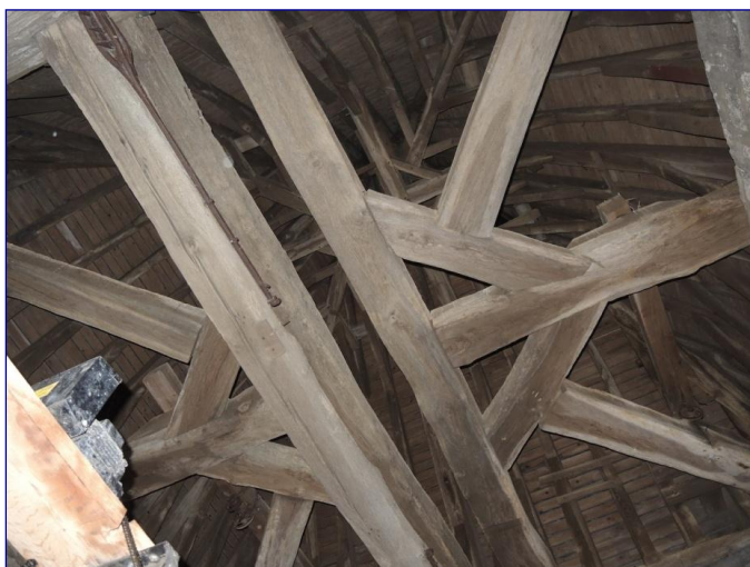
Fig. 16 : clocher, charpente de la flèche à double enrayure
