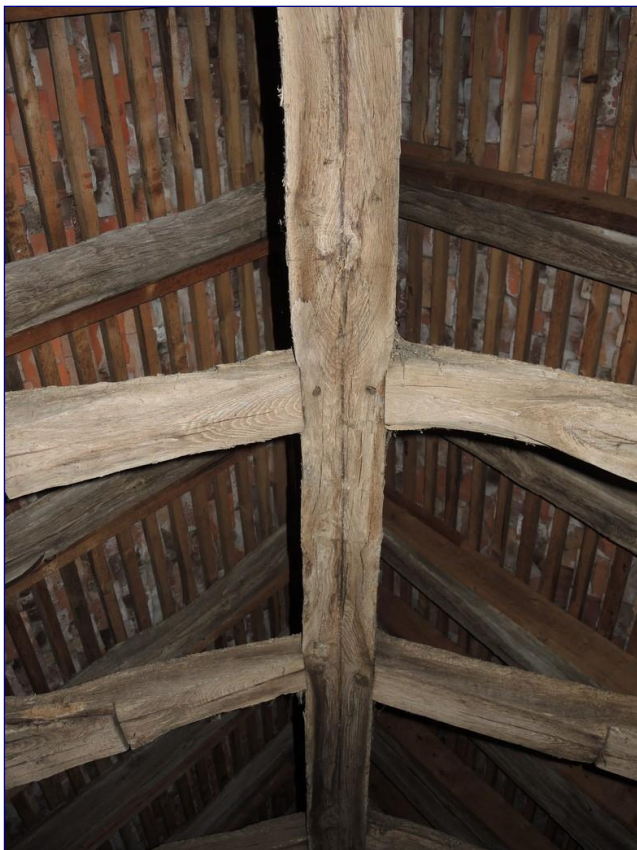
Fig. 10 : charpente occidentale, lignage au noir sur la sous-faîtière
