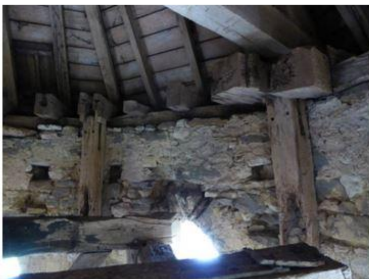
Fig. 18 Vestiges d'une enrayure basse avec ses poteaux d'angle de soutien
