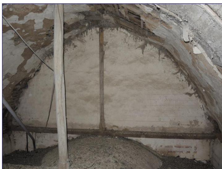
Fig. 13 : charpente du bras nord du transept, vue générale vers le nord
