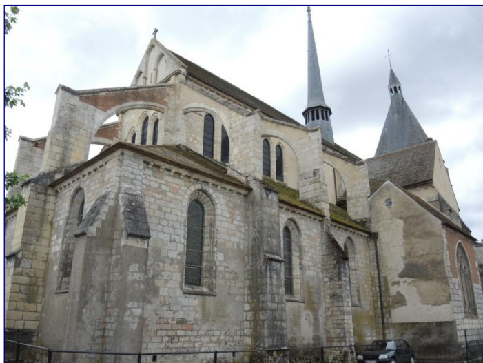
Fig. 1 : vue générale du chevet au nord-est
