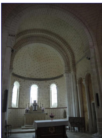
Fig. 6 : travée droite et abside
