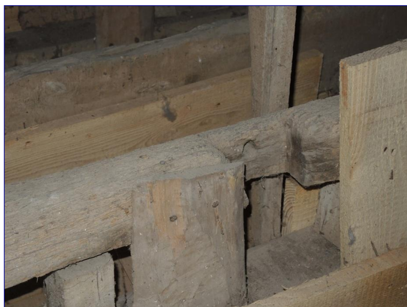
Fig. 8 : mortaise à mi-bois recevant une suspenste
