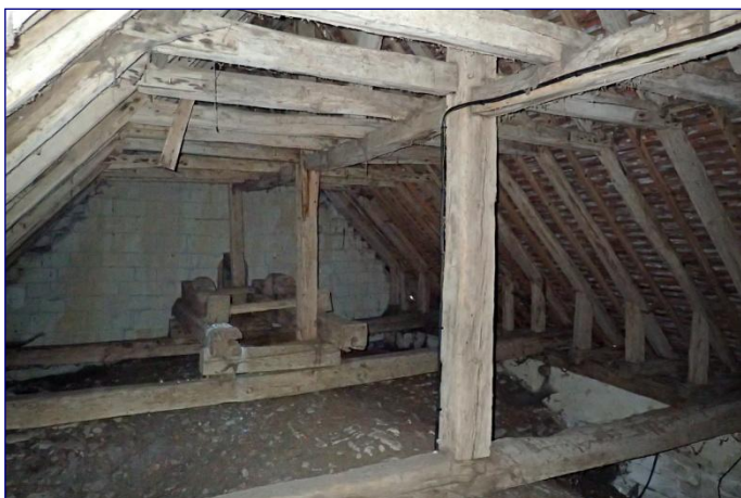
Charpente de la nef vers l'est
