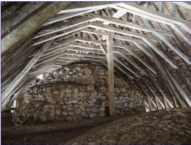
Charpente de la nef vers l'est
