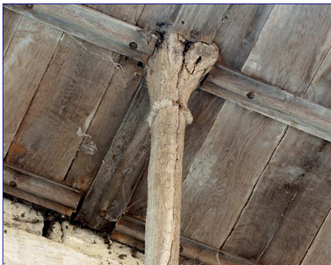
Fig. 8 : charpente de la nef, chapiteau de la 1 ère suspente à l'ouest
