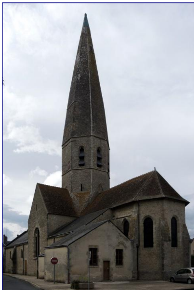
Fig. 1 : vue générale depuis le sud-est
