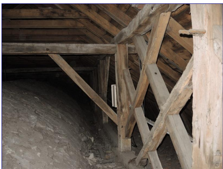
Fig. 7 : charpente de la nef, pan-de-bois longitudinal nord
