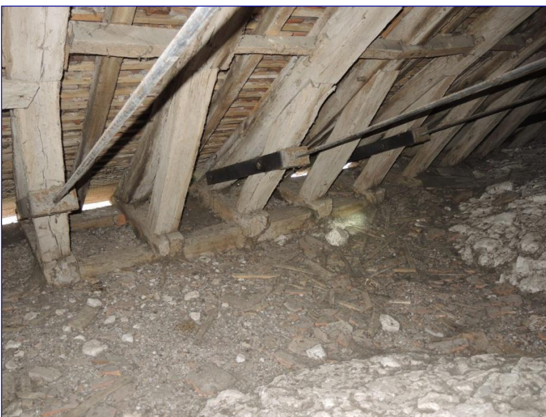
Fig. 14 : vaisseau nord, blochets reposant sur un double cours de sablières
