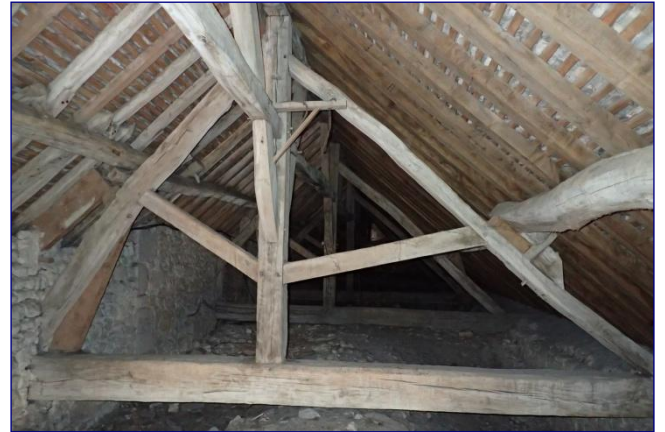
Charpente de la nef
