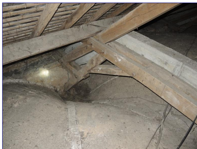
Charpente de la nef, pied de ferme
