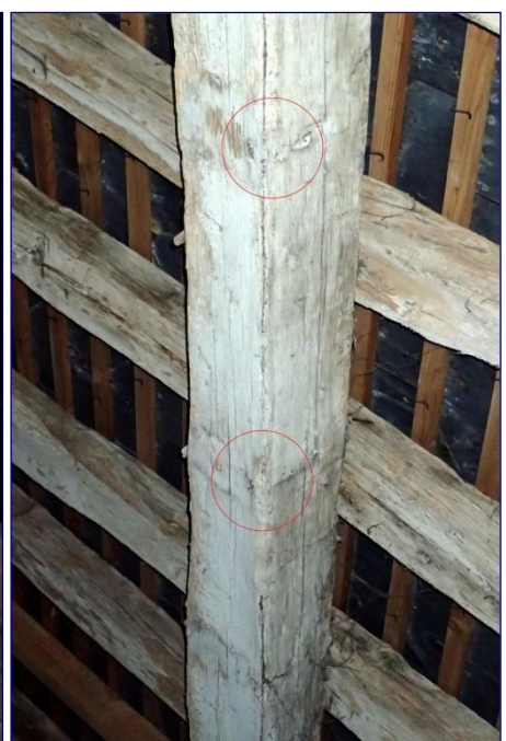
Charpente du vaisseau, panne avec trous obliques pour le transport
