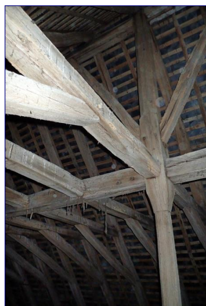
Charpente de la nef, détail
