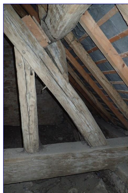
Charpente du chœur, pied de ferme
