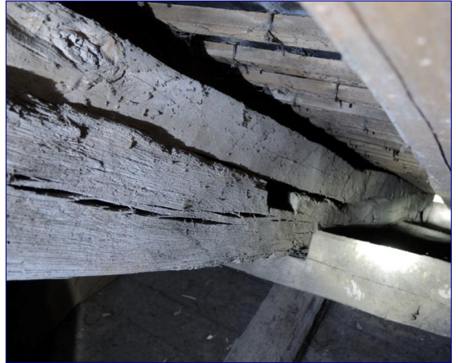
Fig. 12 : charpente de la nef, entaille sur chevron pour lisse de toiture
