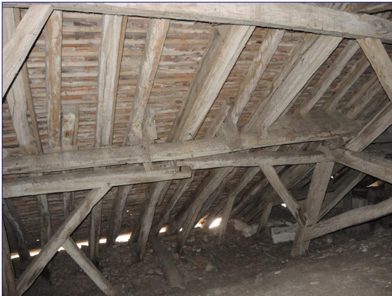
Fig. 8 : charpente de la nef, chevrons du versant sud et registre inférieur du portique
