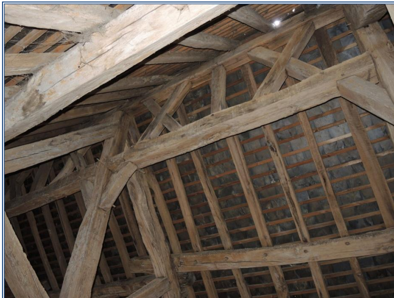
Fig. 12 : charpente de la nef, contreventement
