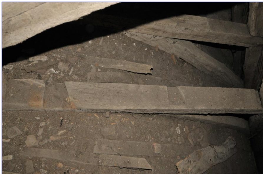
Fig. 8 : charpente de la nef, faux-entrait (ancienne sablière en remploi)
