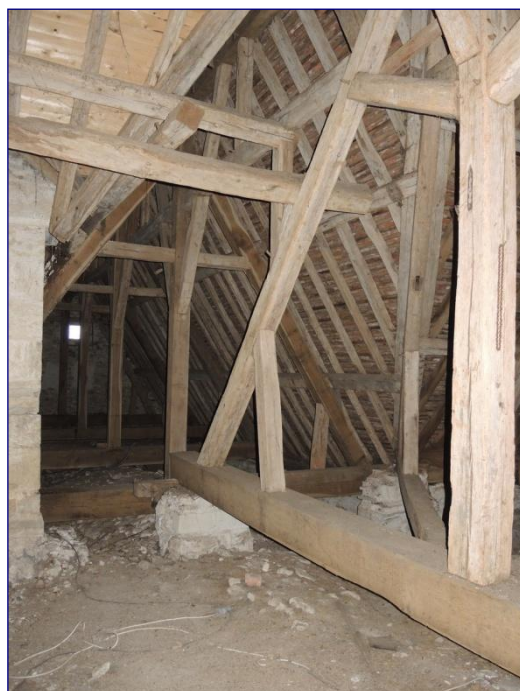
Jonction entre les charpentes du chœur et du bras nord
