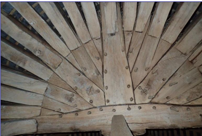
Charpente du chœur, enrayure haute
