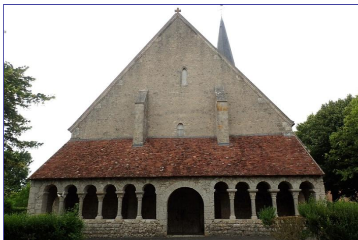
Fig. 1 : vue générale de la façade occidentale et de son porche
