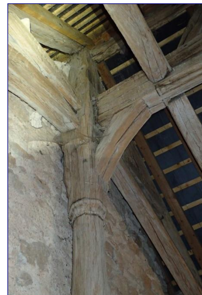
Charpente du chœur, poinçon ouest
