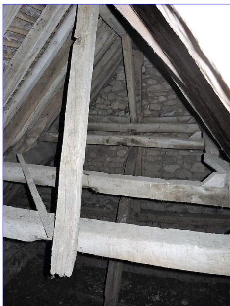
Fig. 15 : charpente de l'abside, vue vers l'est
