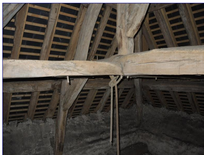
Charpente de la chapelle sud
