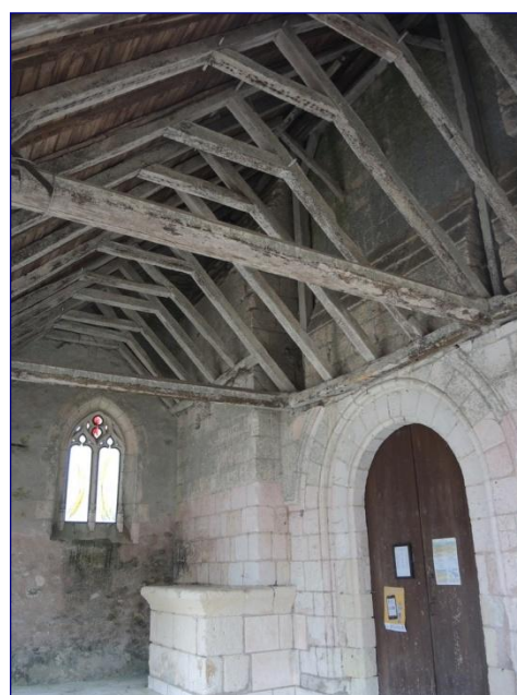
Charpente en appentis du porche occidental
