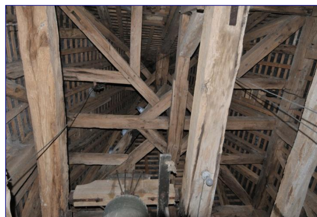
Fig. 18 : clocher, charpente de la flèche
