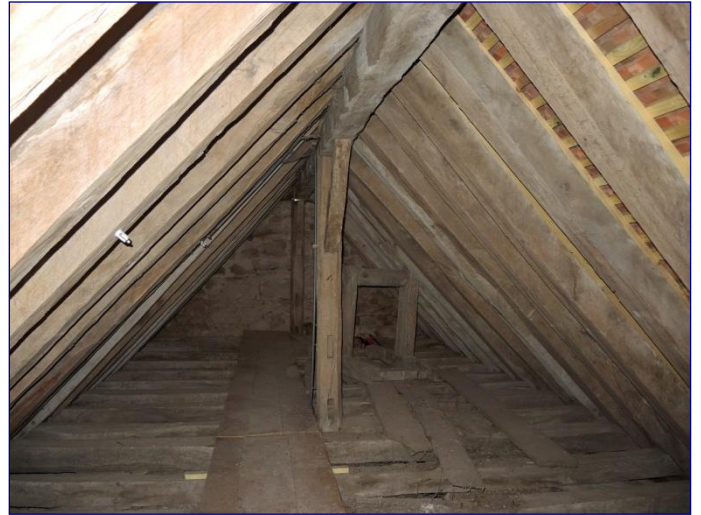
Charpente de la nef (vers l'ouest) au-dessus de l'ancien lambris
