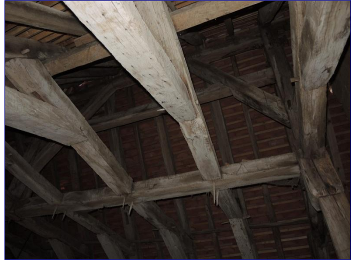
Sous-faitière avec numérotation (6) associée au poinçon
