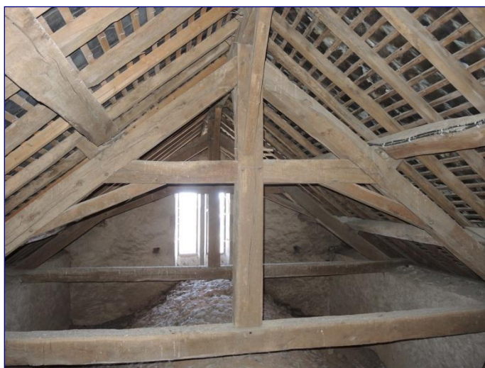
Charpente du chœur vers l'est
