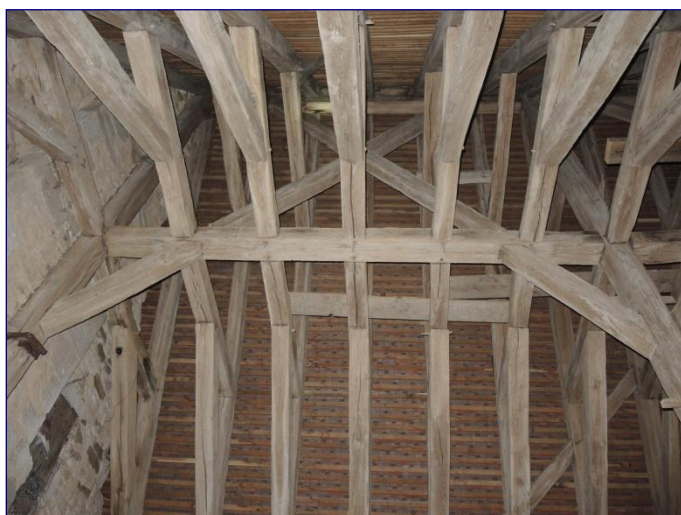
Charpente du vaisseau, contreventement dans la travée orientale
