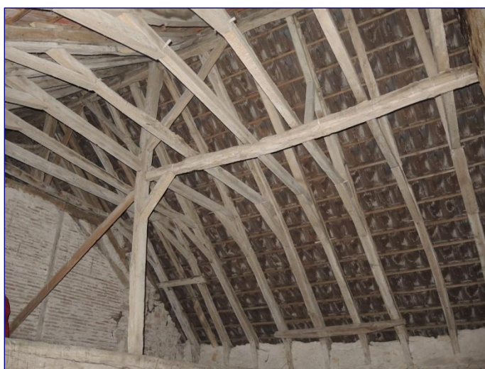
Charpente de la nef, ferme principale orientale
