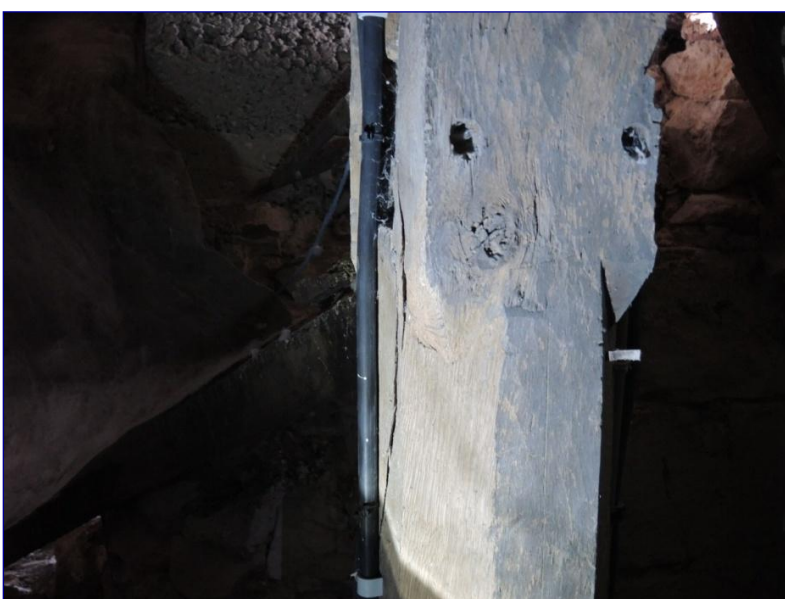
Fig. 20 : charpente de la flèche, bossage du poinçon de fond
