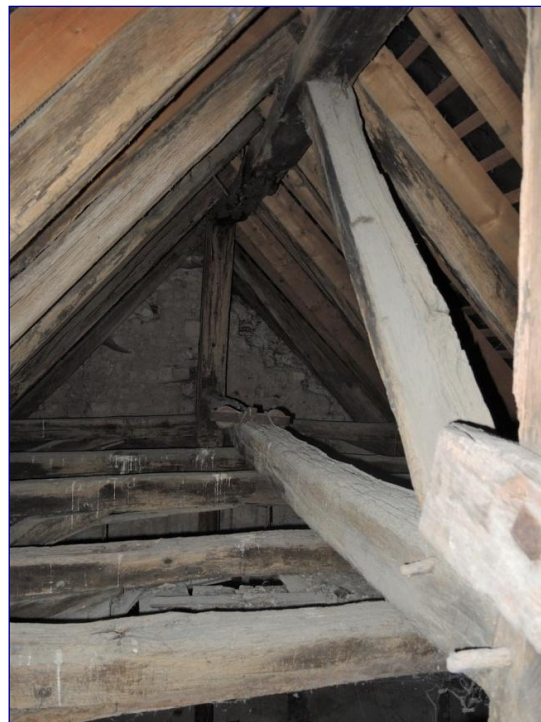
Fig. 12 : charpente du chœur, contreventement longitudinal
