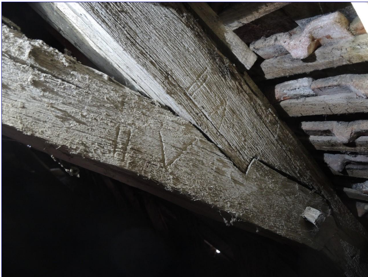
Fig. 7 : marque d'assemblage (7)
