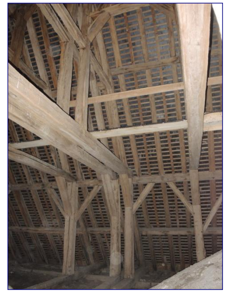
Charpente de la nef, structures est et ouest
