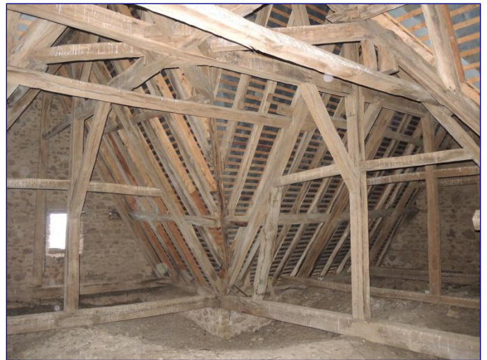
Charpentes de l'abside et du bras sud (à droite)
