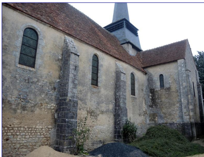
Vue de la nef et du bras sud du transept
