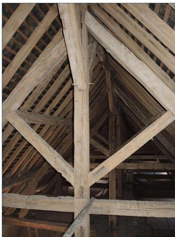
Fig. 11 : charpente de la nef, parties hautes
