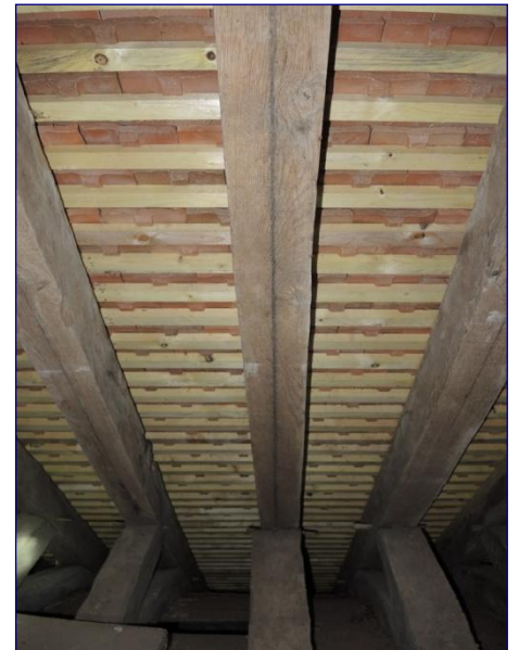
Charpente de la nef, chevron avec lignage
