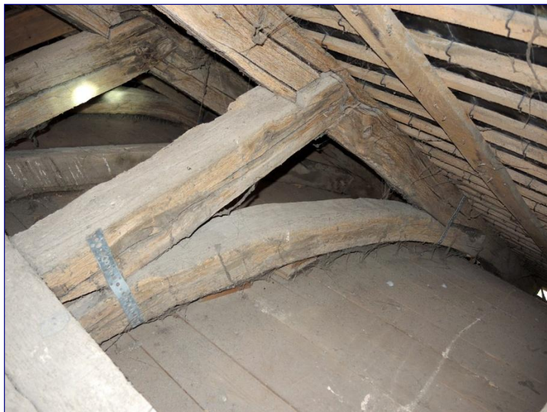
Fig. 8 : charpente de la nef, un faux-entrait et son aisselier
