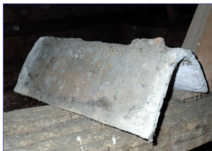
Fig. 13 : tuile faitière glaçurée avec son bouton en crête
