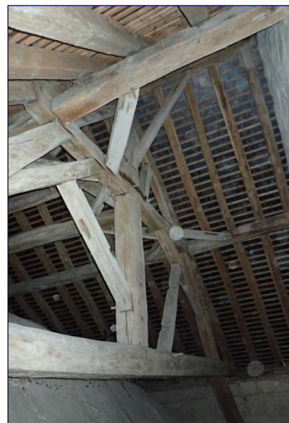
Charpente du chœur
