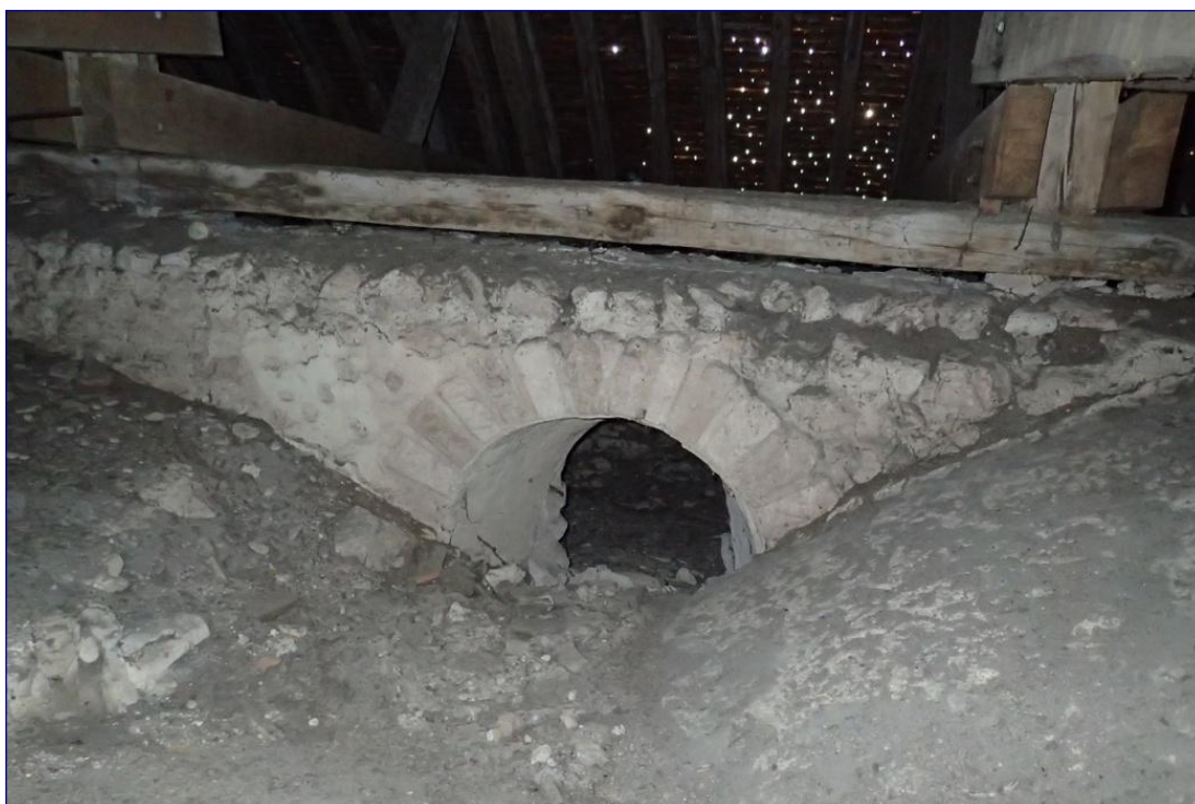
Fig. 15 : ancien mur gouttereau nord de la nef
