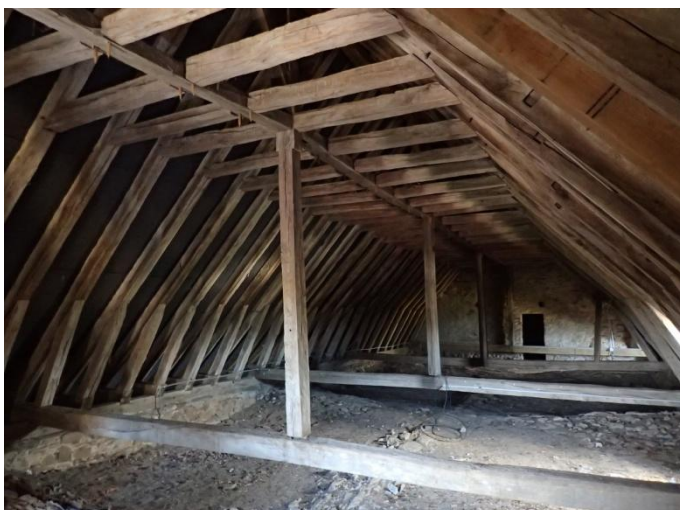
Charpente est, vue générale vers l'ouest
