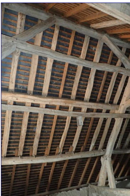
Charpente du vaisseau, chevronnage et contreventement
