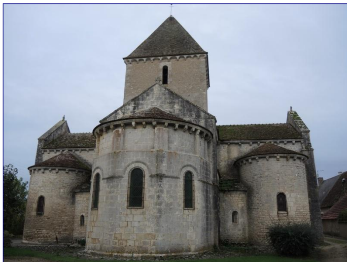
Fig. 2 : vue générale du chevet
