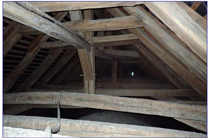
Structure occidentale vers l'est
