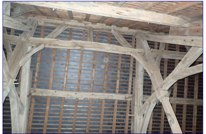
Charpente du vaisseau, contreventement
