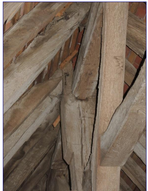
Assemblage en tête de poinçon
