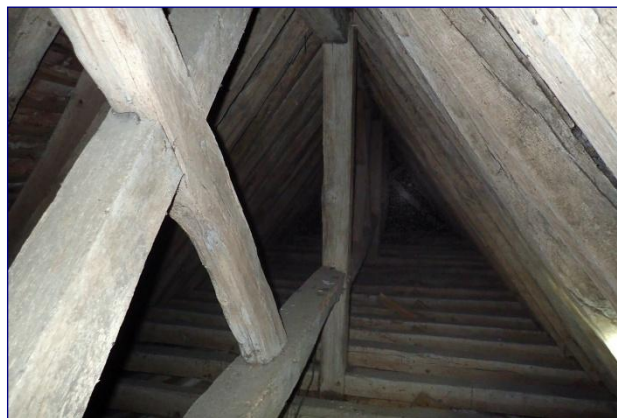
Charpente de la nef vers l'est
