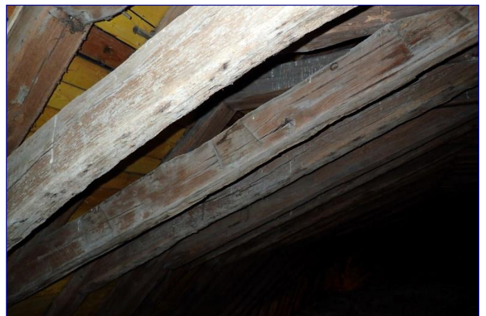
Charpente du vaisseau, aisselier, pièce de rempli avec mi-bois
