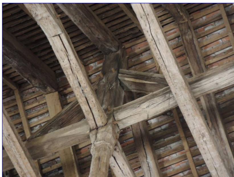
Fig. 10 : charpente de la nef, détail du contreventement
