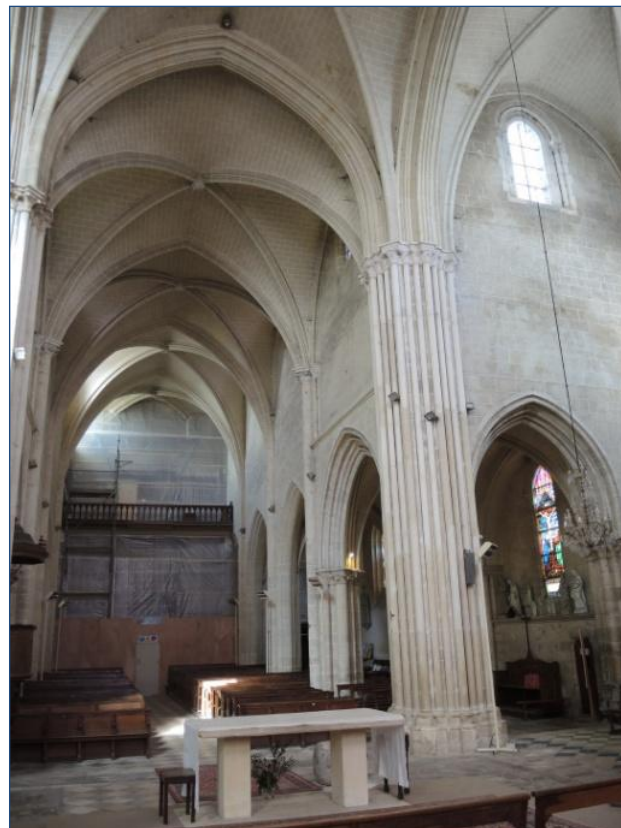
Fig. 4 : croisée et nef vers l'ouest
