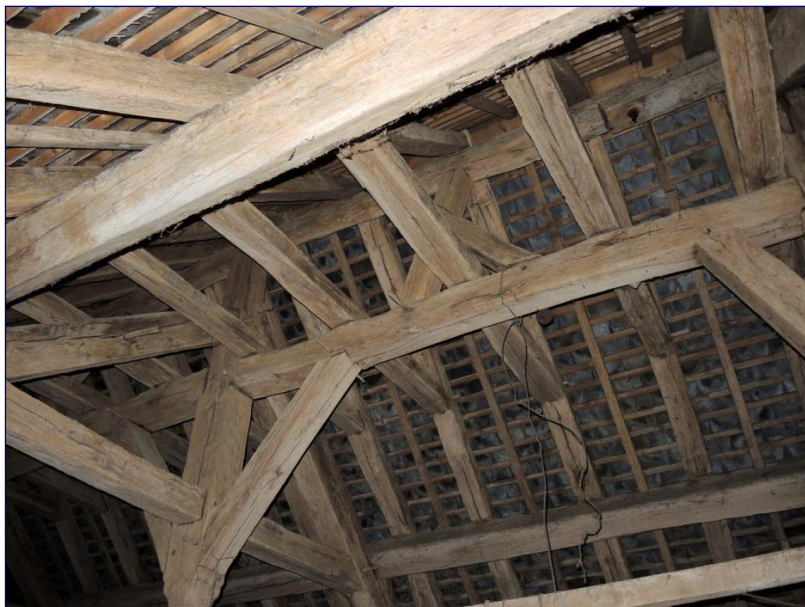
Fig. 14 : charpente de la nef, contreventement
