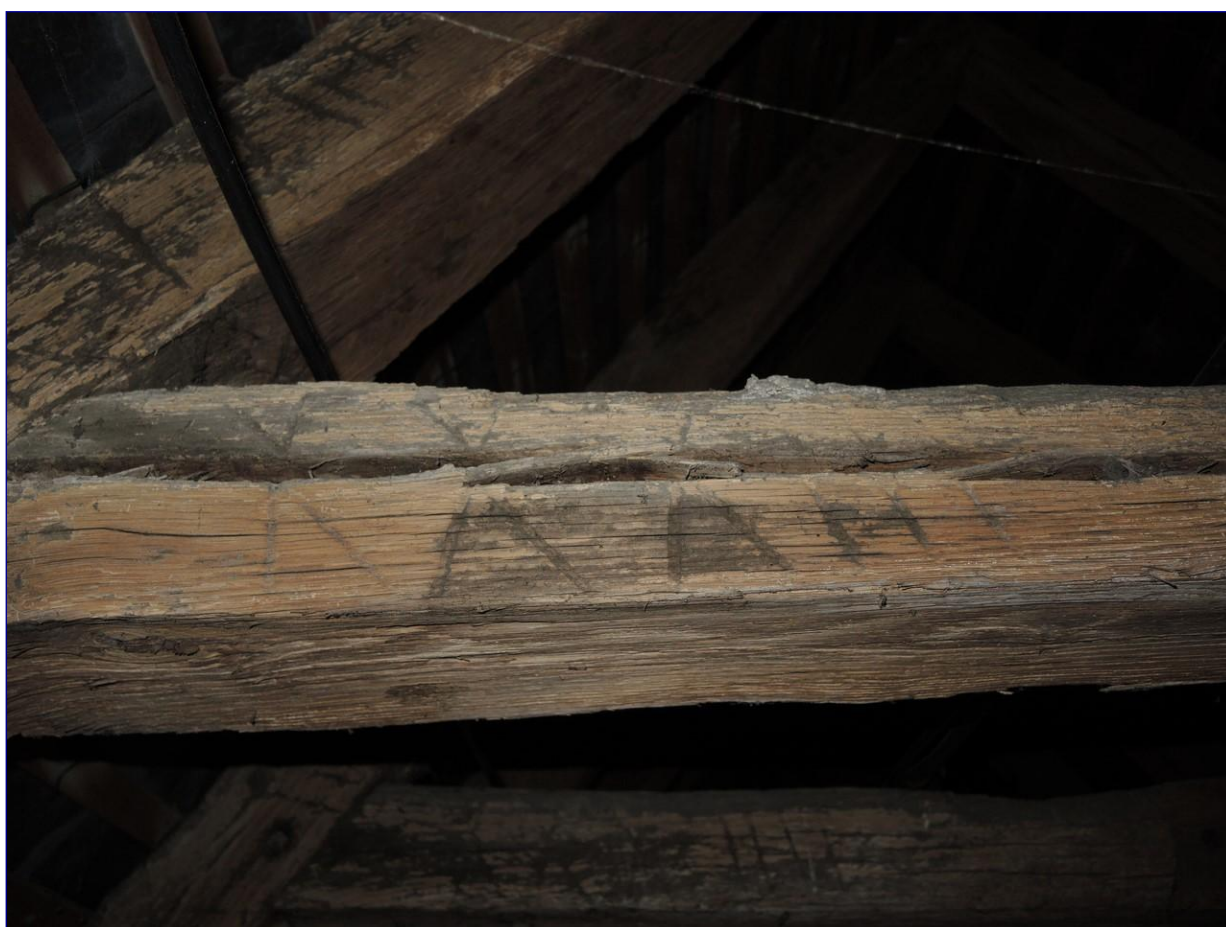
Fig. 9 : charpente du vaisseau principal, structure 1, marque d'assemblage XXXIII (33)
