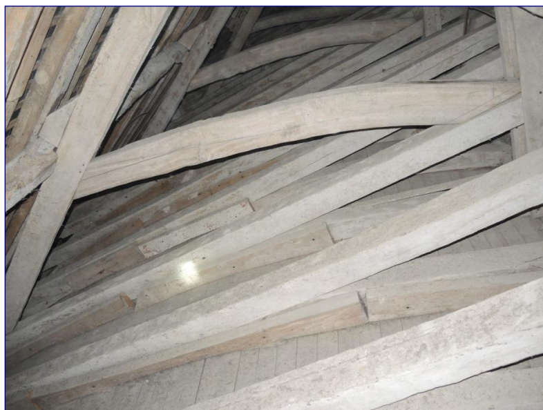
Fig. 17 : charpente lambrissée de la nef
