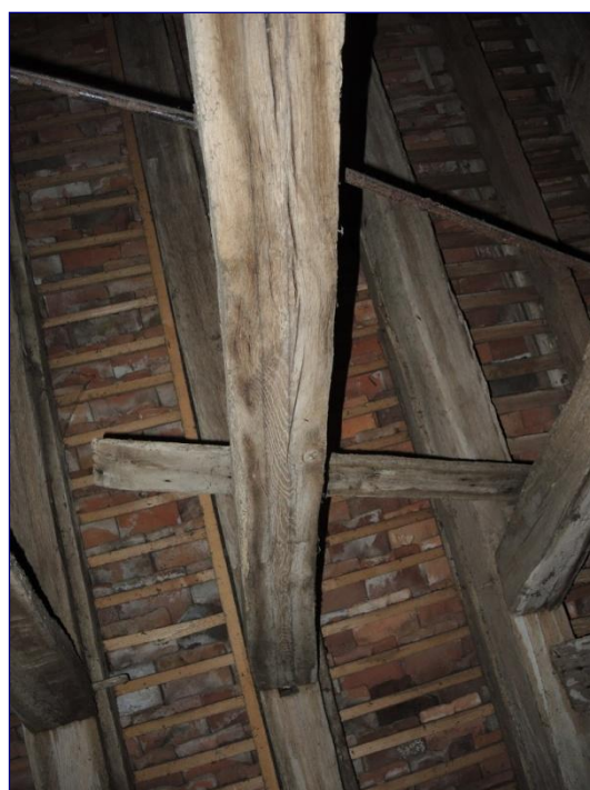
Charpente de la nef, lignages au noir sous les faux-entraits
