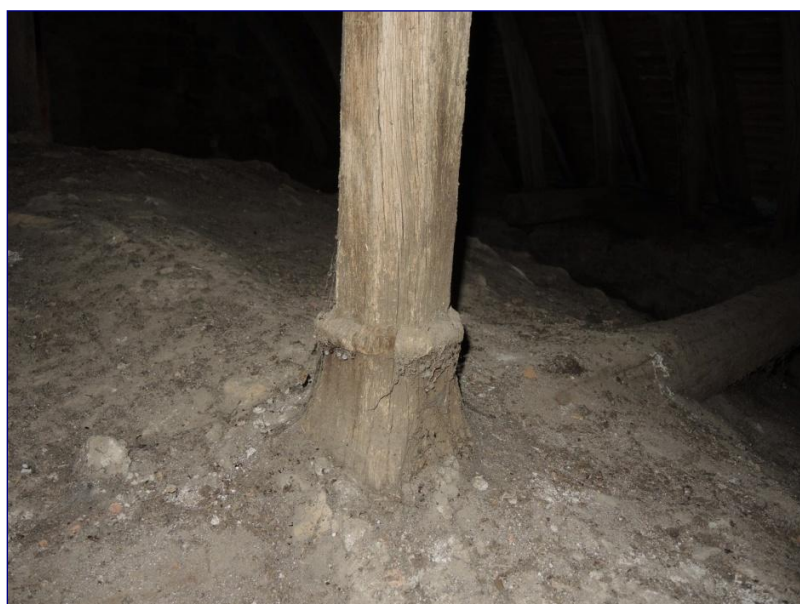
Fig. 9 : charpente occidentale, base de poinçon et entrail noyé dans les voûtes
