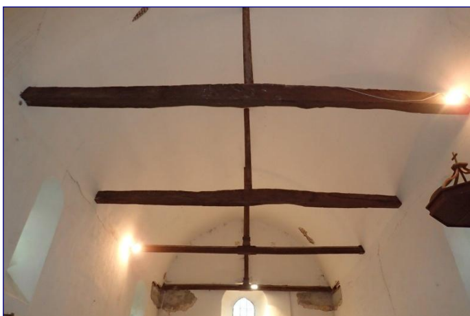
Nef, vue vers l'ouest, poinçons et entrails des fermes principales
