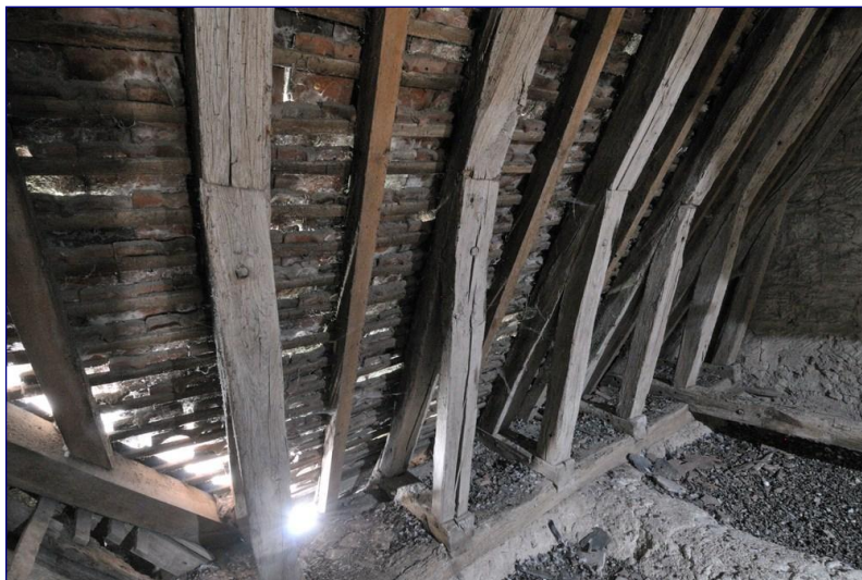
Fig. 14 : charpente du bras sud, rampant est, pieds de fermes
