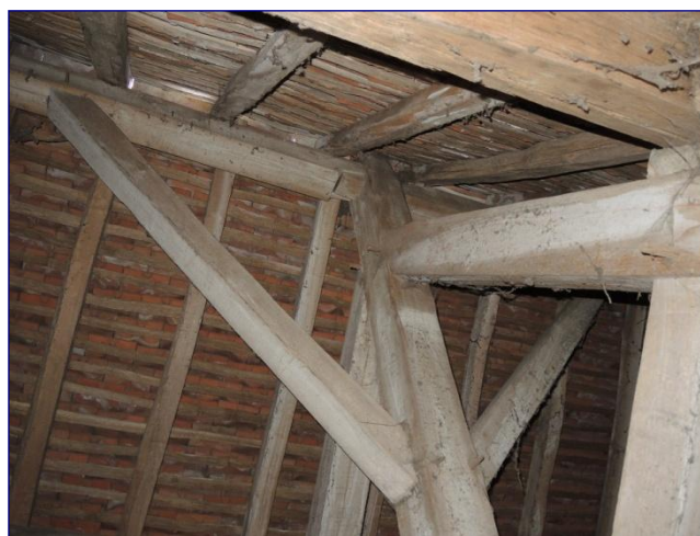
Charpente, détail du contreventement
