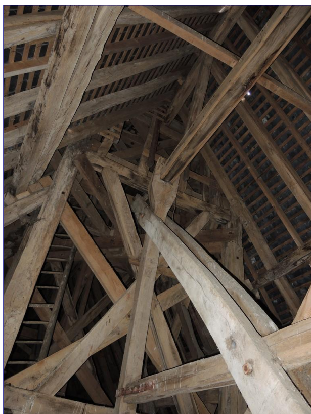
Fig. 11 : cage du beffroi et dispositif de contreventement
