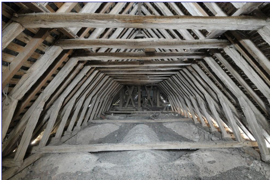
Fig. 7 : charpente de la nef, vue générale vers l'est
