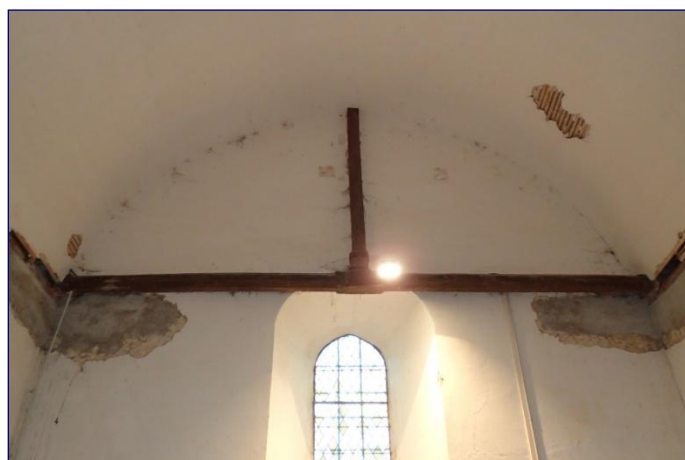
Nef, ferme occidentale
