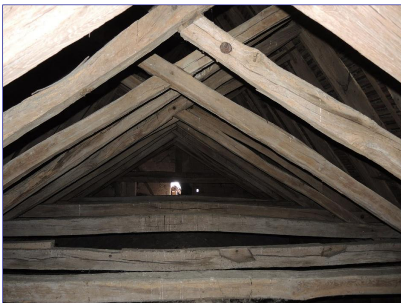
Fig. 6 : charpente de la nef, entraits retroussés et écharpes croisées (+ un remploi)
