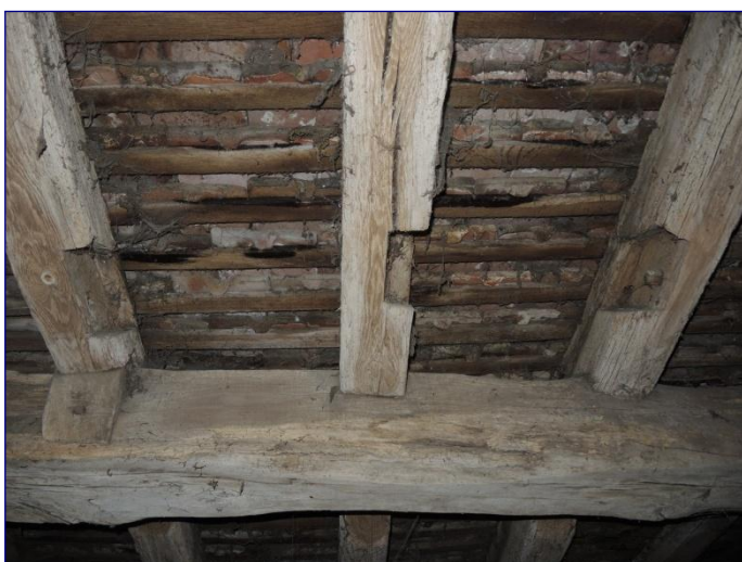
Charpente du chœur, travée est, chevrons en remploi
