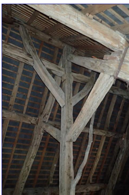
Charpente du chœur, détail d'une ferme
