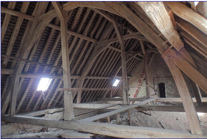
Charpente de la nef, vue d'ensemble vers l'est
