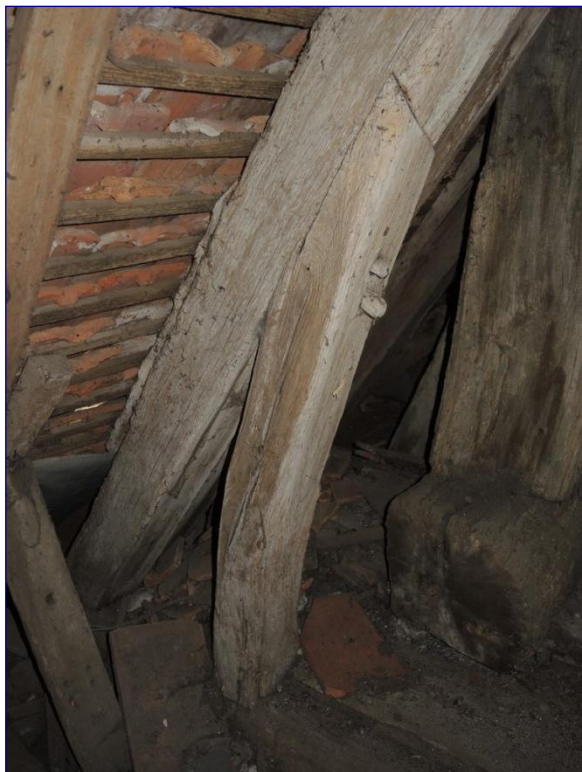
Fig. 10 : charpente de la travée droite, F 1, jambette
