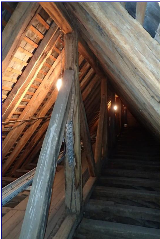
Charpente de la nef, contreventement longitudinal
