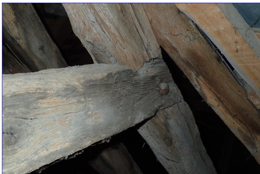
Fig. 10 : charpente du chœur, assemblage à mi-bois d'un entrait retroussé (F6)
