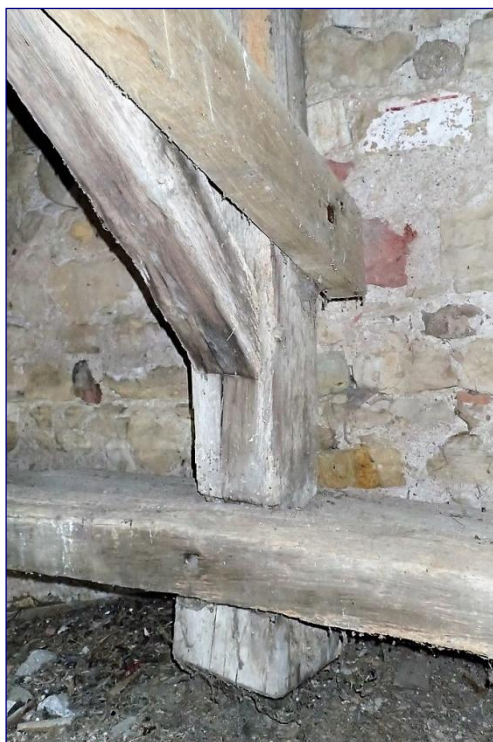
Charpente de la nef, détail d'un poinçon moisé en pied
