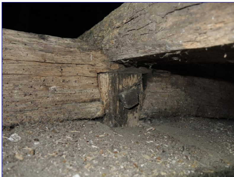
Fig. 13 : charpente de la nef, assemblage en tête de la suspente avec le 1 er faux-entrait
