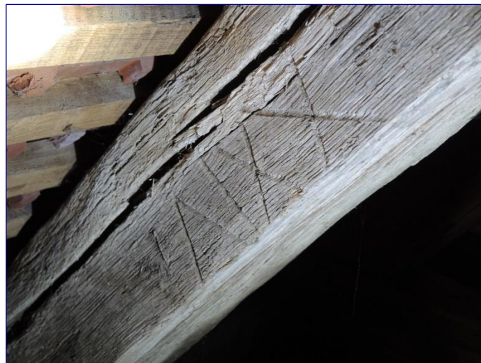
Fig. 12 : charpente est du chœur, marque XXIV sur F24
