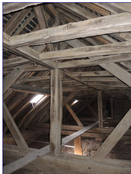
Charpente de la nef vers l'ouest
