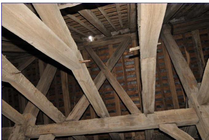
Charpente de la nef, contreventement
