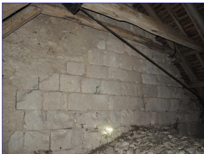
Fig. 9 : vaisseau nord, revers du pignon occidental, ancien solin de toiture
