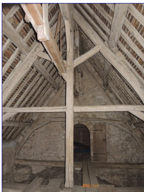
Fig. 15 : charpente du chœur vers l'ouest
