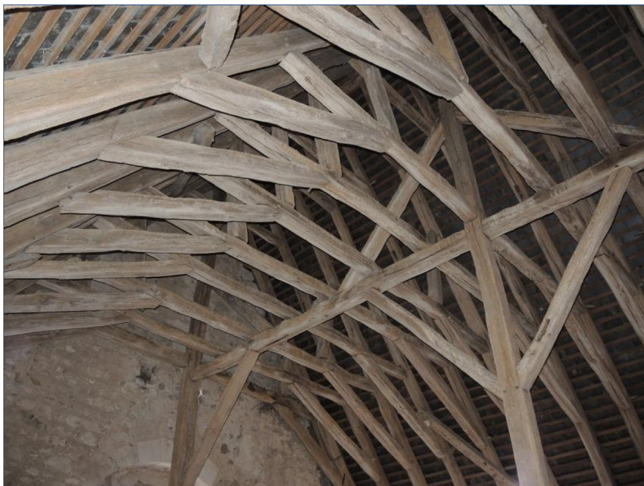
Fig. 8 : charpente du chœur, parties hautes
