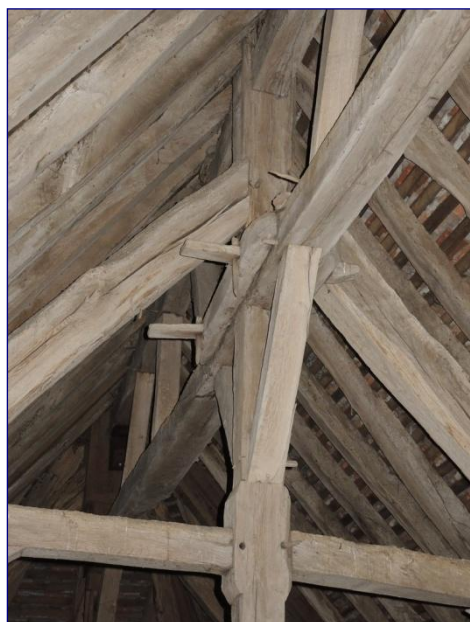
Fig. 17 : charpente du chœur, tête de poinçon et amoisés
