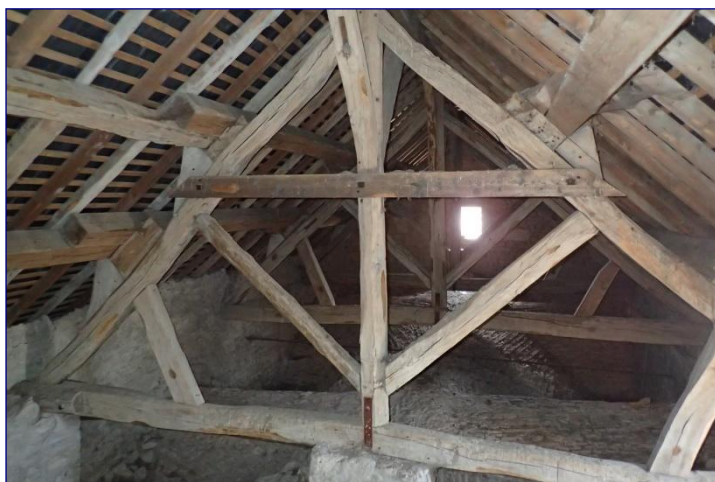
Charpente du vaisseau vers l'est
