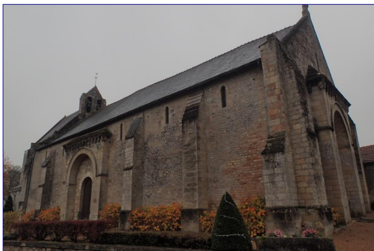
Vue générale de l'édifice vers le sud
