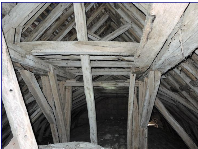
Fig. 11 : portique du beffroi central
