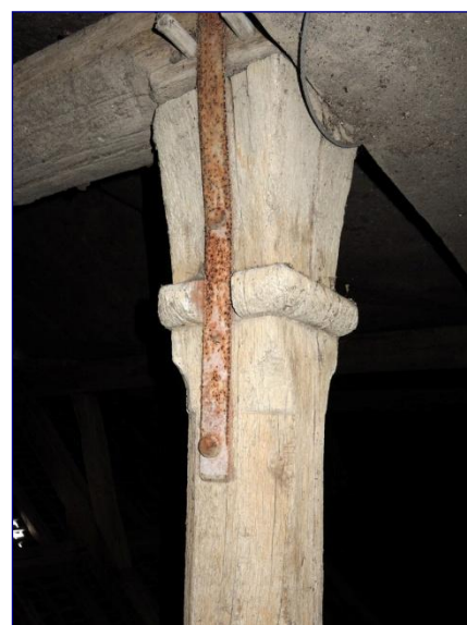
Fig. 17 : charpente de la nef, chapiteau de poinçon
