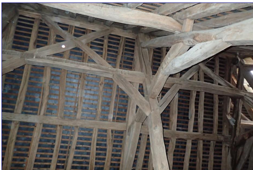
Charpente du chœur, vue générale du contreventement
