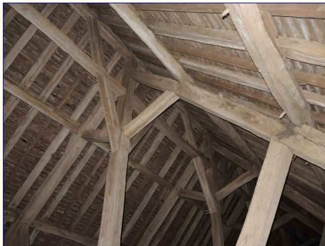
Charpente de la nef, contreventement
