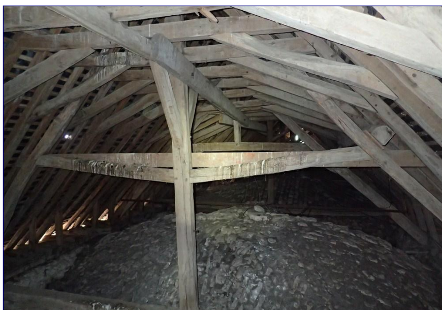
Charpente du chœur
