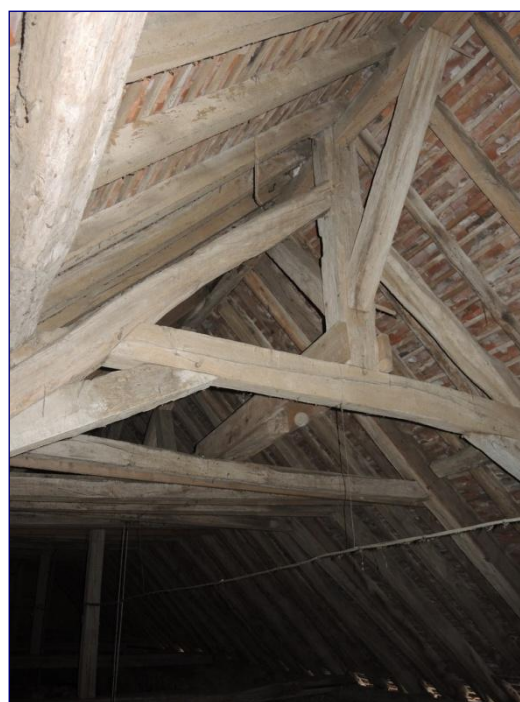
Charpente de la nef, ferme occidentale
