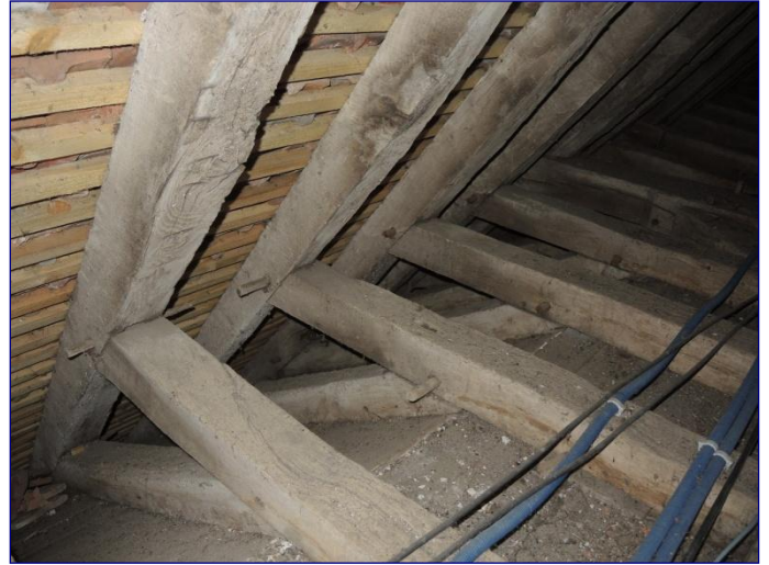
Charpente de la nef, asselier reliant chevron et entrain retroussé
