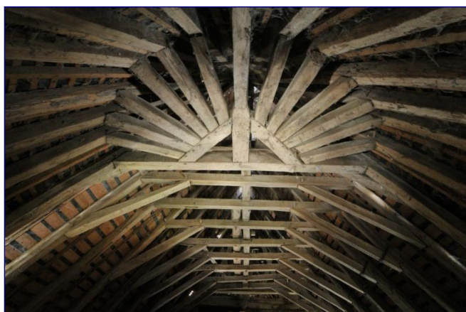
Fig. 15 : charpente du chœur, parties hautes
