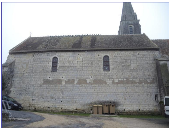
Nef, mur gouttereau sud
