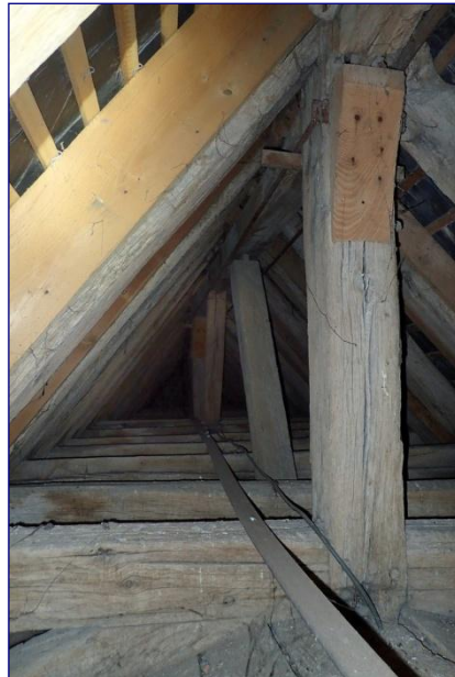
Charpente de la nef, contreventement
