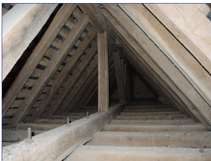
Charpente de la nef, contreventement
