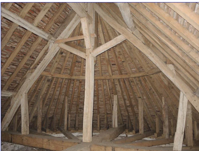
Charpente de l'abside
