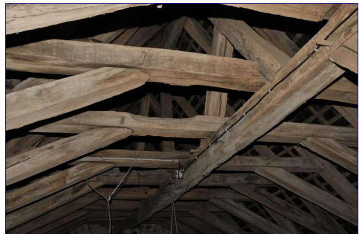
Charpente ouest de la nef, faux entrants au-dessus du sous-faîtage
