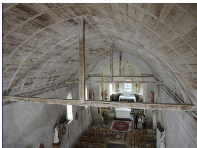
Fig. 4 : charpente de la nef, entrails et poinçons (XIX-XX e s.)
