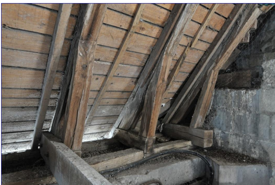
Fig. 15 : charpente du bras sud, pied des fermes méridionales
