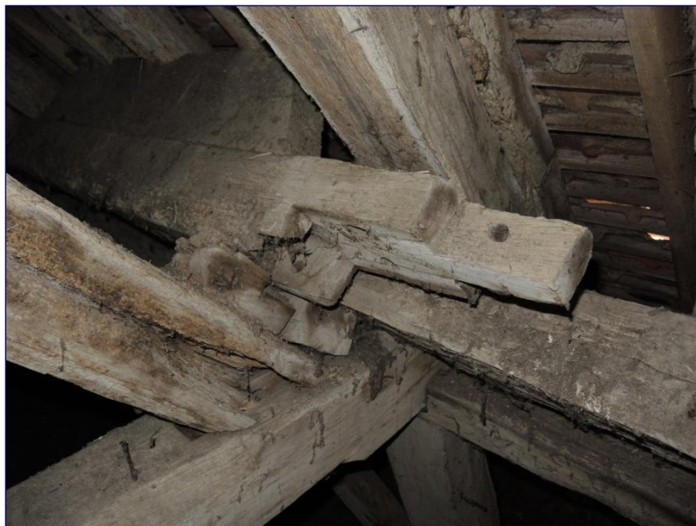
Fig. 14 : charpente de la nef, portique, panne en remploi à enture tenonnée
