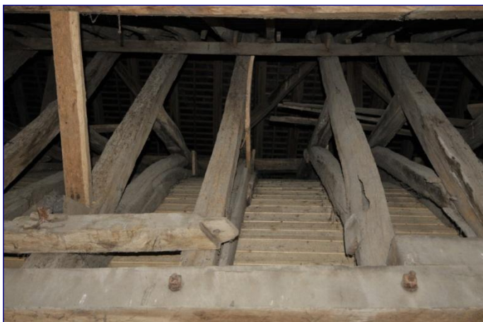
Charpente de la nef, face supérieure des chevrons
