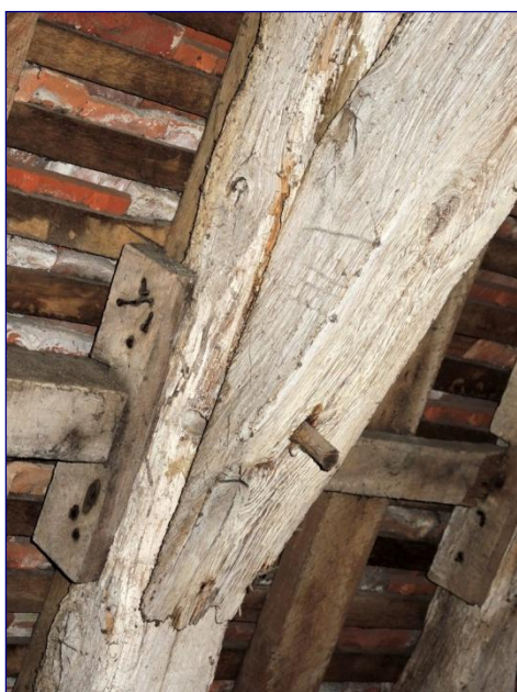
Fig. 11 : charpente de la nef, structure ouest, pied d'écharpe
