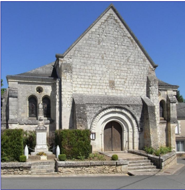
Fig. 1 : façade ouest de l'église
