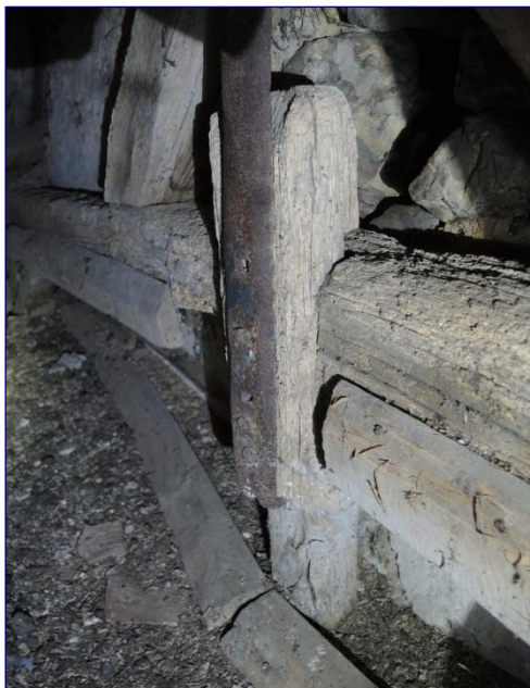
Fig. 5 : nef, structure 1, départ de suspente
