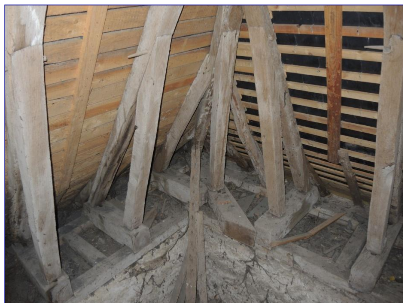
Fig. 11 : charpente du chœur, pieds des fermes de la croupe
