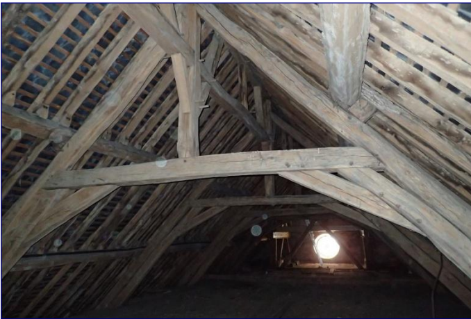
Charpente est, vue générale vers l'ouest
