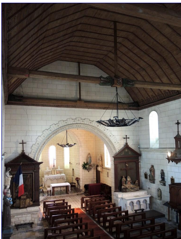
Fig. 3 : intérieur de la nef vers le sud-est
