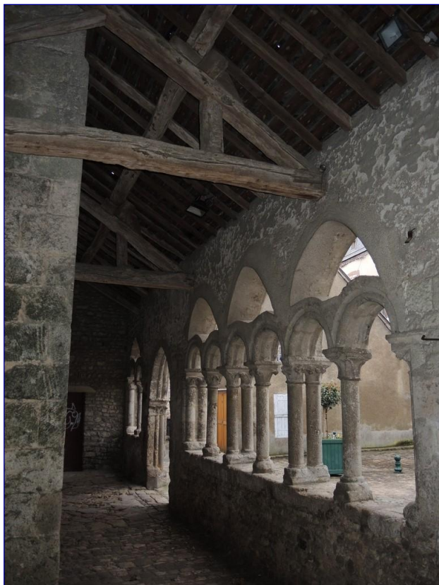
Fig. 3 : galerie occidentale, vue vers le sud
