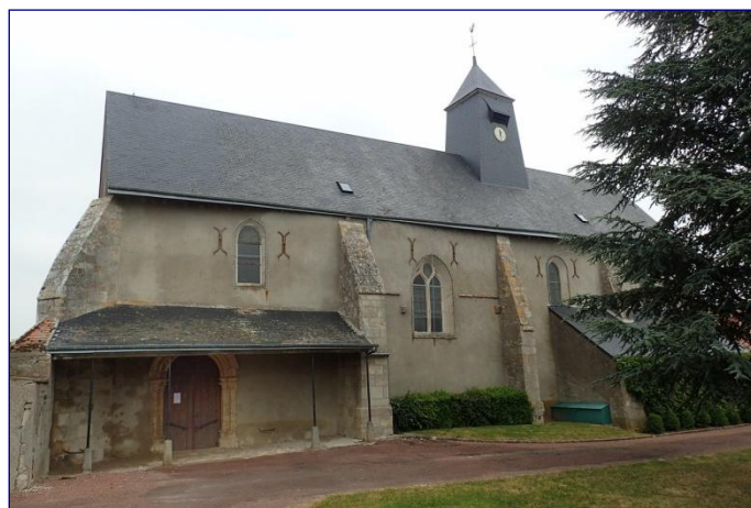
Vue générale de l'église au sud
