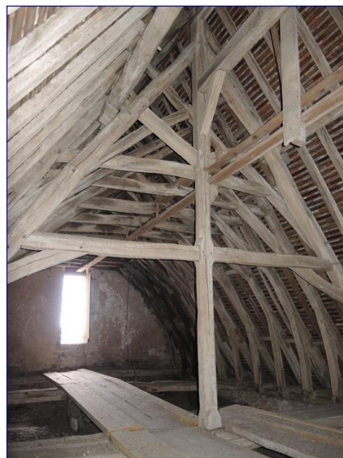
Fig. 8 : charpentes ouest et est de la nef, vers l'ouest
