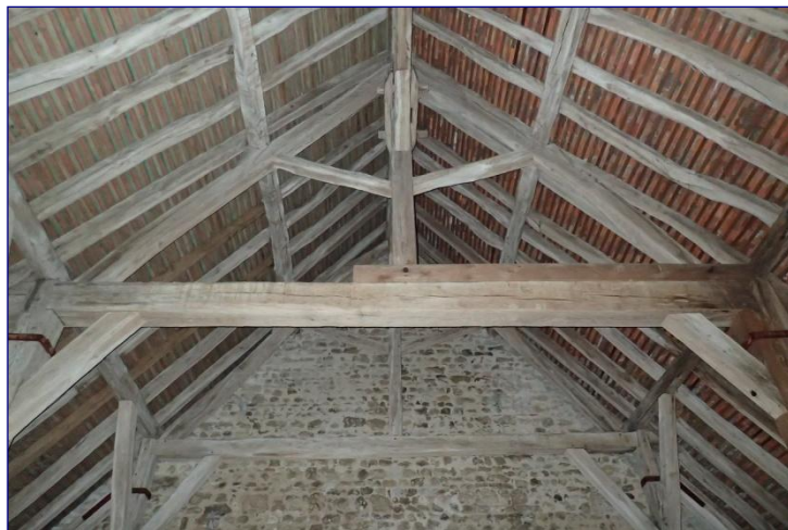
Fig. 14 : partie occidentale de la charpente vers l'ouest
