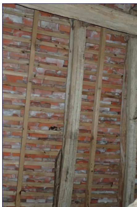
Charpente de la nef, chevron avec double lignage
