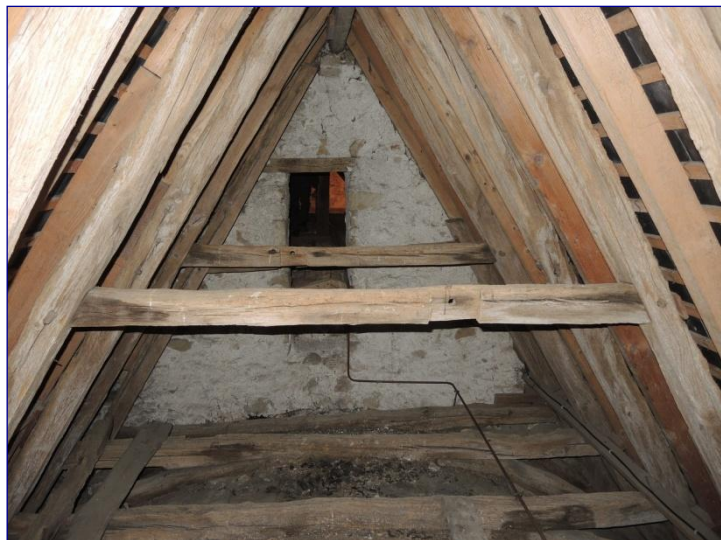
Fig. 7 : charpente du chœur, fermes occidentales
