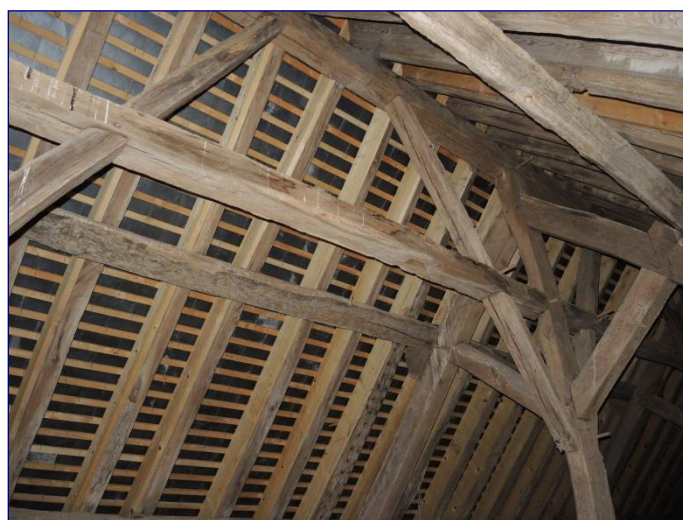
Charpente de la nef, contreventement
