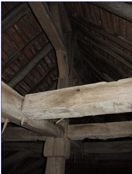
Poinçon avec bossage à hauteur du sous-faitage
