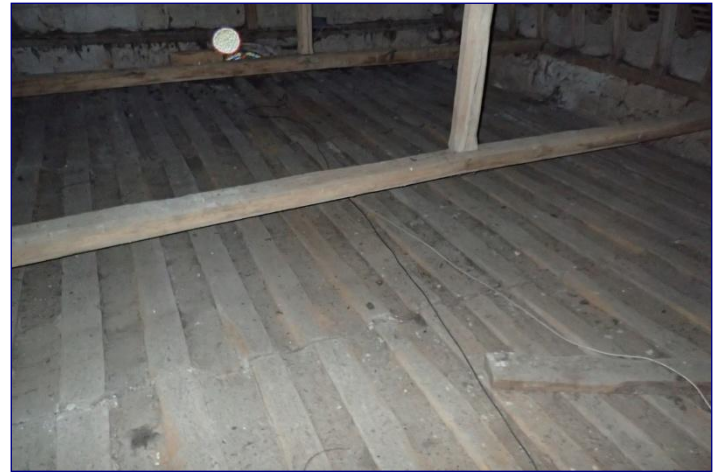
Charpente de la nef, entrails et plancher
