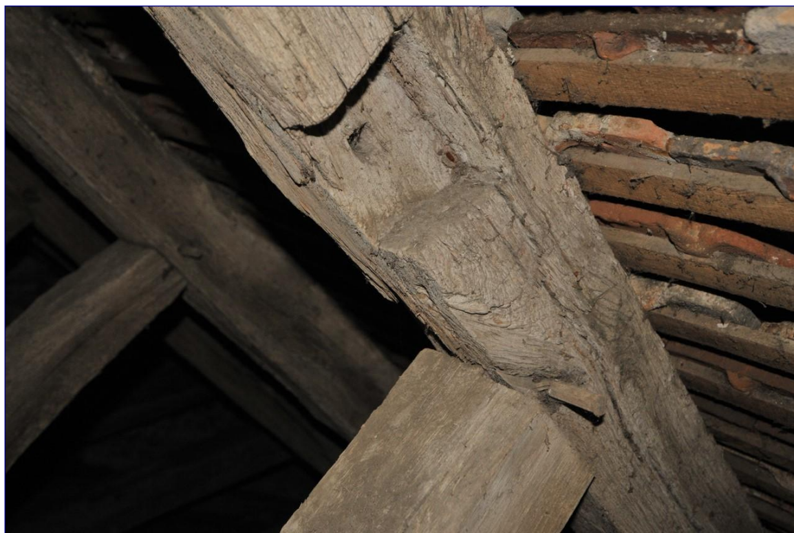
Fig. 7 : charpente de la nef, chevron en remploi avec assemblage orphelin à mi-bois
