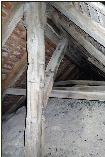
Charpente de la nef, poinçon haut à bossage
