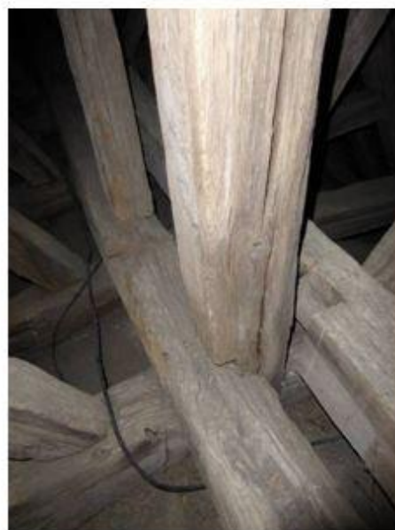
Fig. 7 Mi-bois passant de la herne au poinçon
