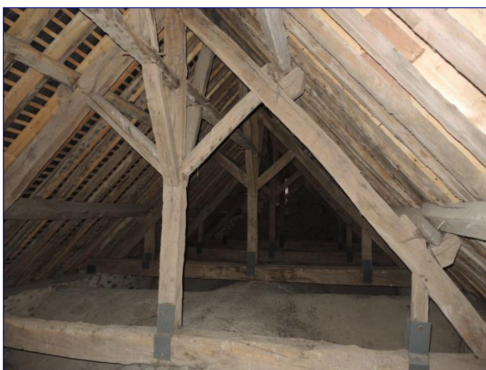
Charpente de la nef vers l'est
