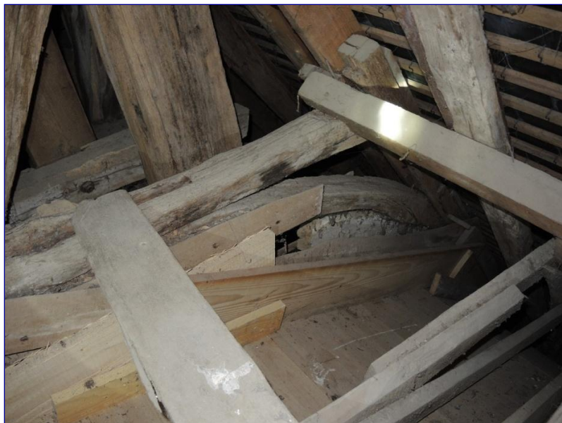
Fig. 6 : charpente de la nef, aisselier courbe
