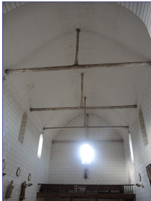
Vue générale de la nef vers l'ouest
