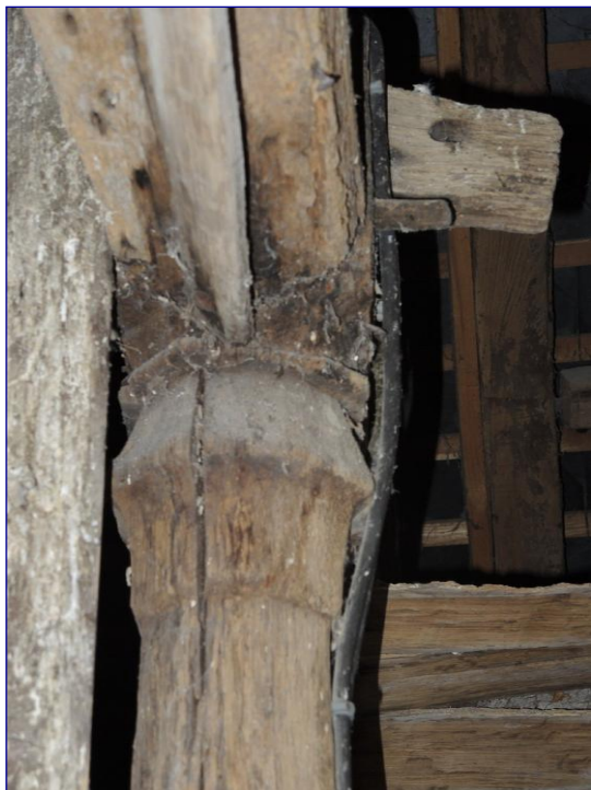
Fig. 11 : charpente du chœur, tête de poinçon
