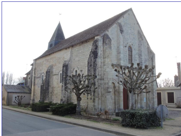
Fig. 2 : vue générale de l'église vers le sud-est
