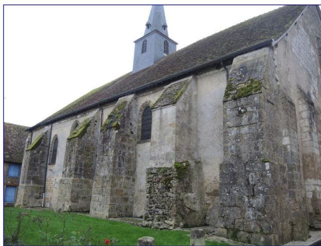
Fig. 2 : mur gouttereau méridional
