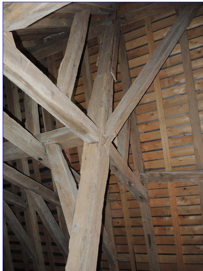
Fig. 13 : chapelle nord, poinçon sud ; mortaises en sous-face du faux-entrait est pour paroi en pan-de-bois
