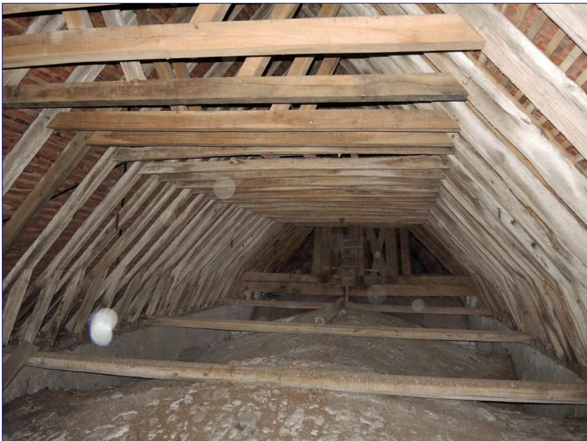
Fig. 6 : charpente est du chœur vers l'ouest
