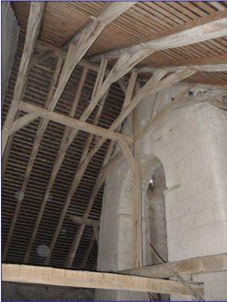
Charpente du chœur, fermes principales
