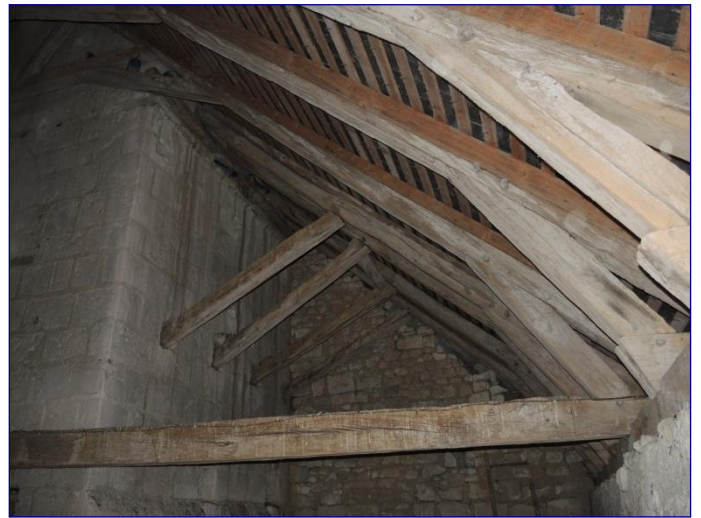
Charpente du chœur en appentis
