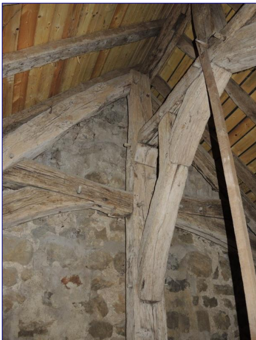
Fig. 9 : charpente de l'avant-chœur, ferme à l'est
