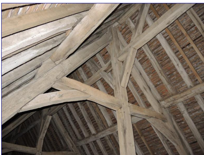
Charpente de la nef, détail
