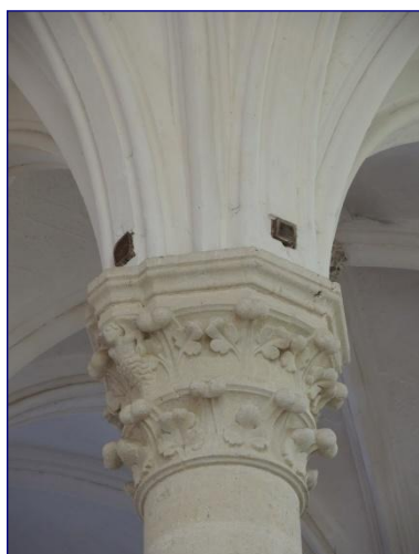
Fig. 6 : pile du chœur et pièces de bois sciées
