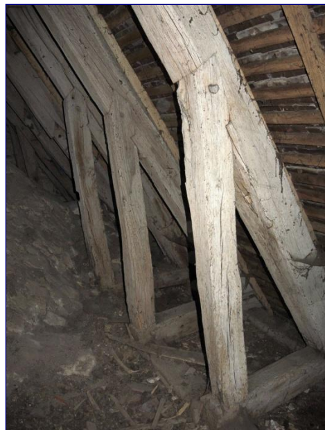
Fig. 9 : charpente de la nef, jambettes
