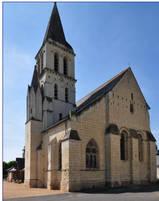
Fig. 2 : chevet, vue générale vers le nord-est
