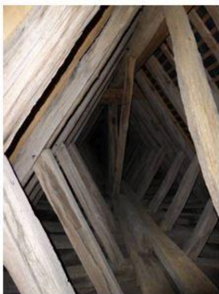
Fig. 6 Charpente de la nef
