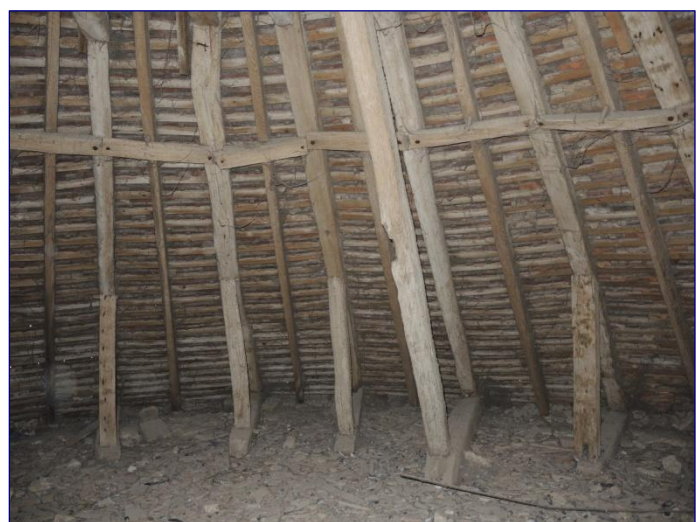
Fig. 11 : charpente de l'abside
