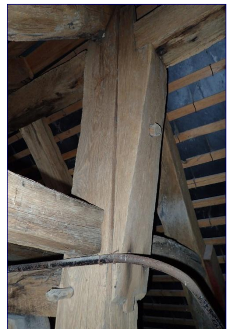
Structure occidentale, console chevillée au poinçon, ajoutée pour soutenir une faîtière
