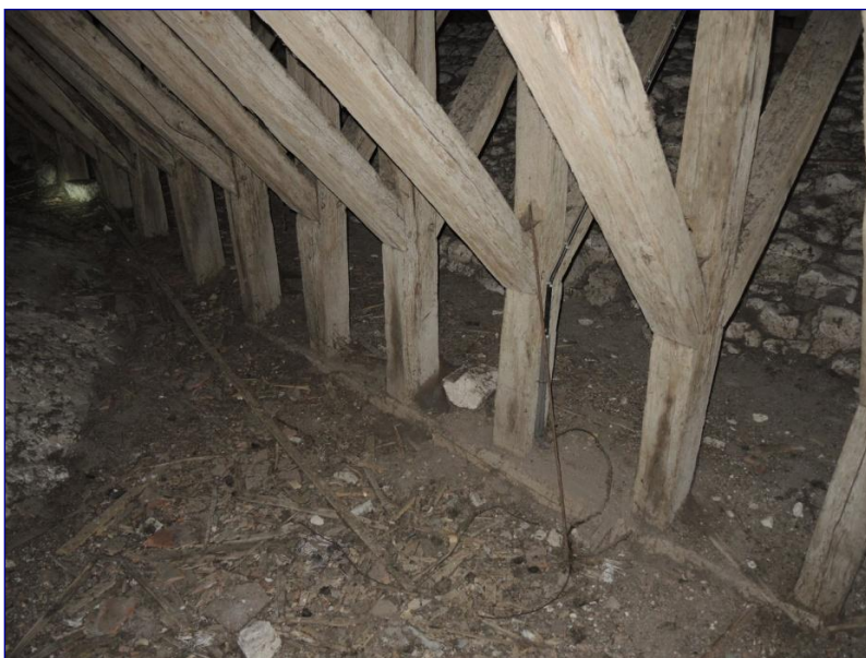
Fig. 13 : pieds de poinçon sur sablière reposant au droit du gouttereau sud du vaisseau nord
