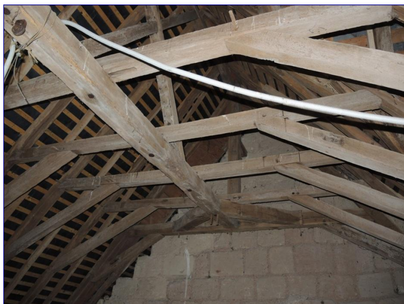
Fig. 10 : charpente du chœur, demi-enrayure à l'ouest
