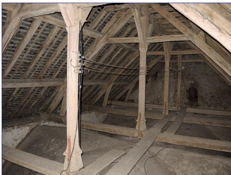
Fig. 13 : charpente de la nef
