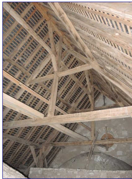
Charpente de la nef, structure ouest
