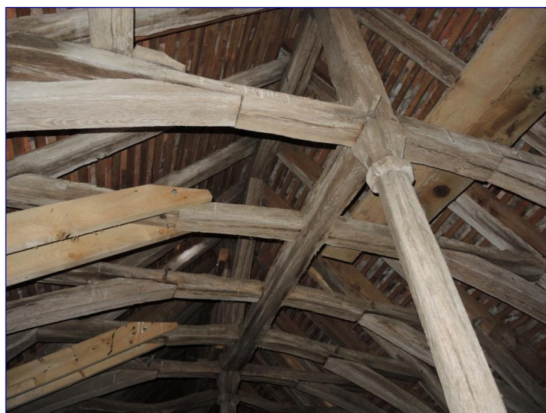
Fig. 5 : charpente occidentale, contreventement
