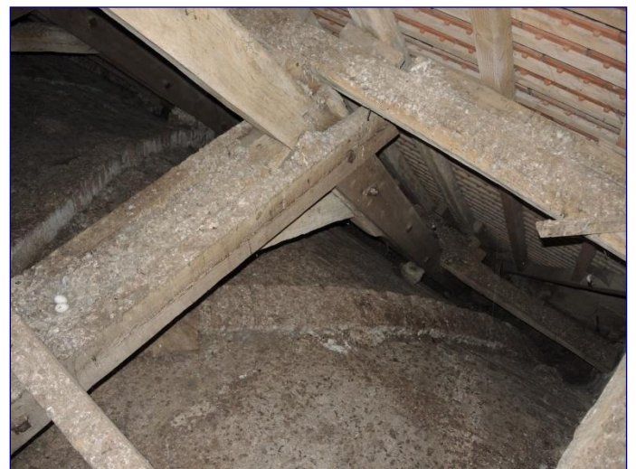
Charpente de la nef, entrait retroussé mis en place après sciage de l'entrait
