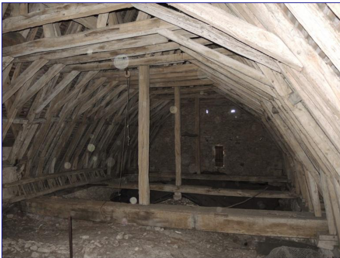
Charpente de la nef, vue générale
