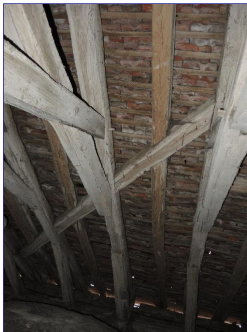
Fig. 10 : écharpes dans le plan des chevrons
