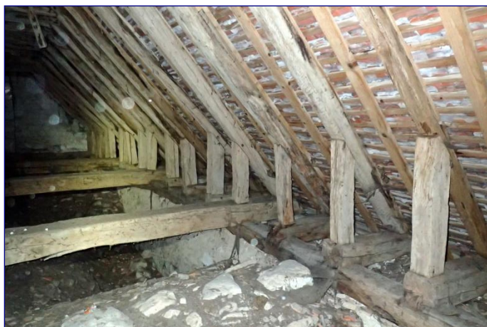
Charpente de la nef, pieds de ferme au nord
