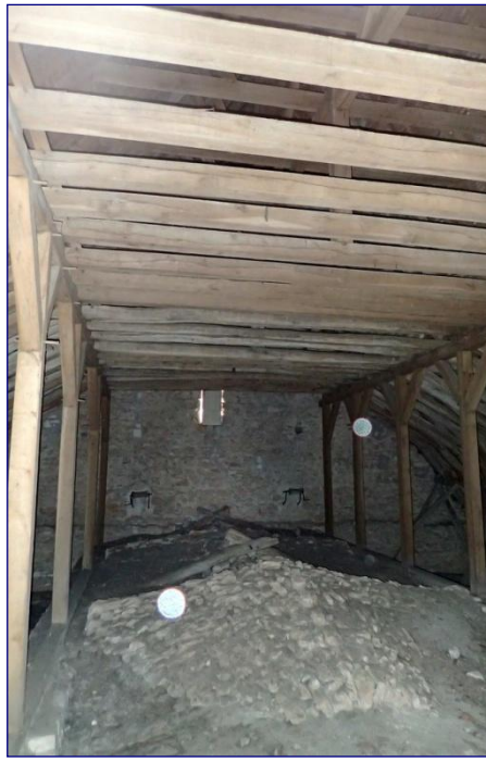
Fig. 4 : partie orientale de la charpente vers l'est
