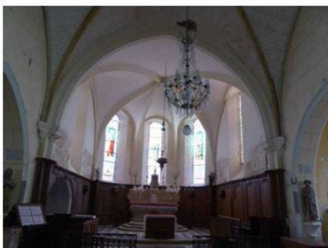
Fig. 4 Chœur avec, au premier plan, la fausse-voûte en bois
