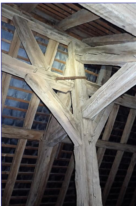
Charpente du vaisseau principal, contreventement
