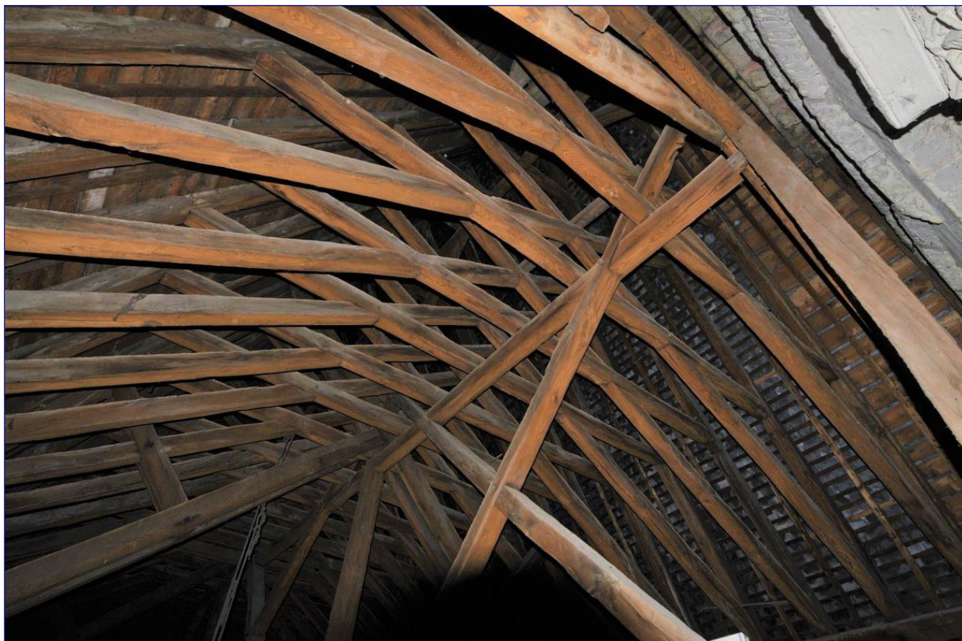
Fig. 6 : charpente de la nef, fermes secondaires entre 2 fermes principales
