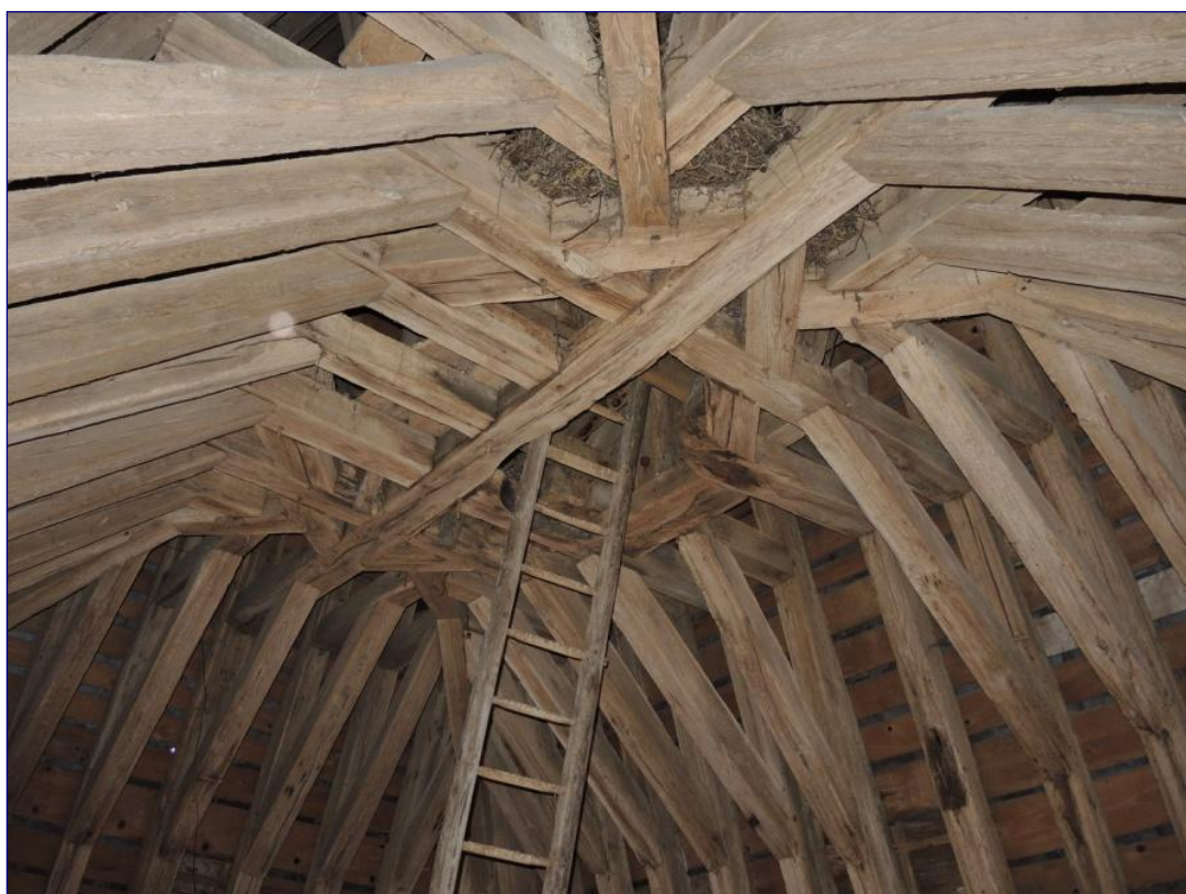
Fig. 17 : charpente de la toiture en pavillon du clocher
