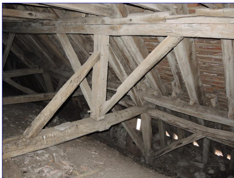
Fig. 13 : charpente de la nef, portique, contreventement longitudinal
