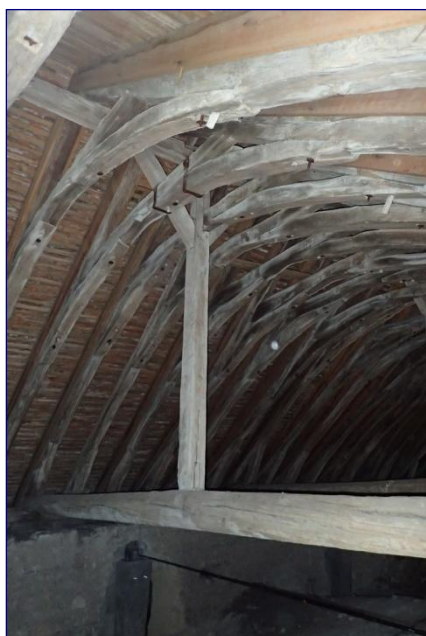
Fig. 9 : charpente des travées occidentales
