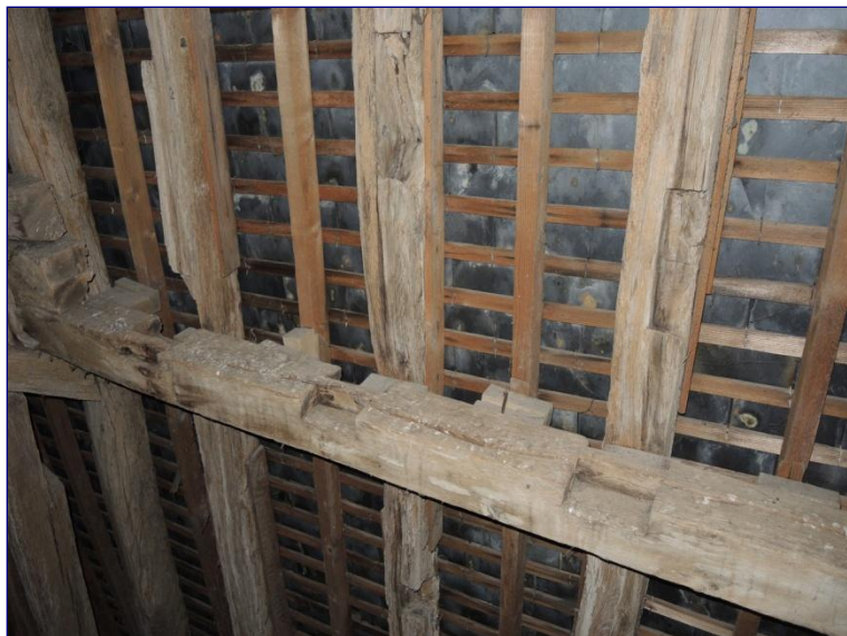
Fig. 8 : panne, remploi d'une ancienne sablière
