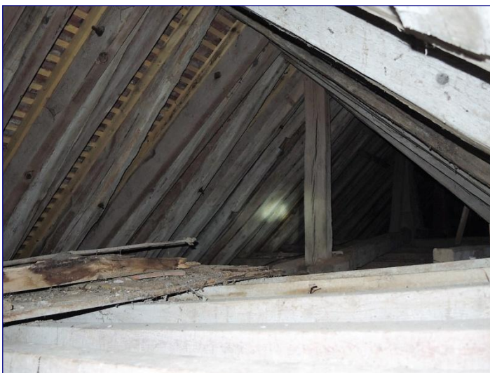
Charpente de la nef, vue générale au-dessus des faux-entraits
