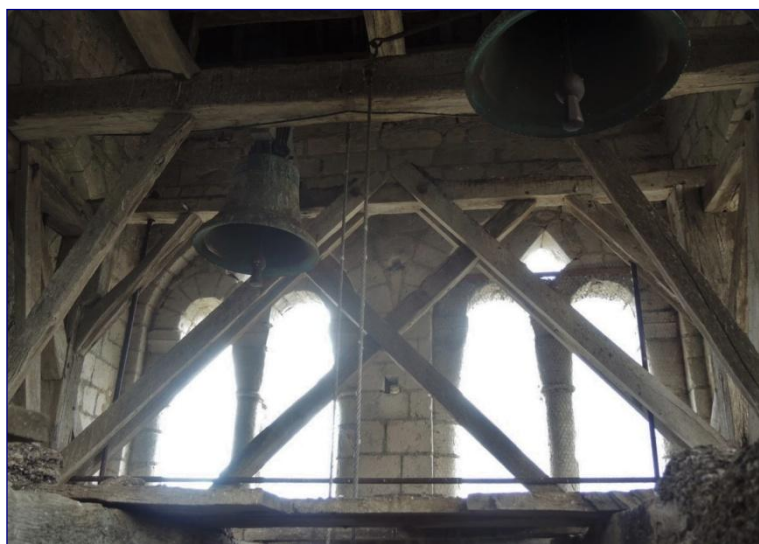
Enrayure basse de la flèche du clocher
