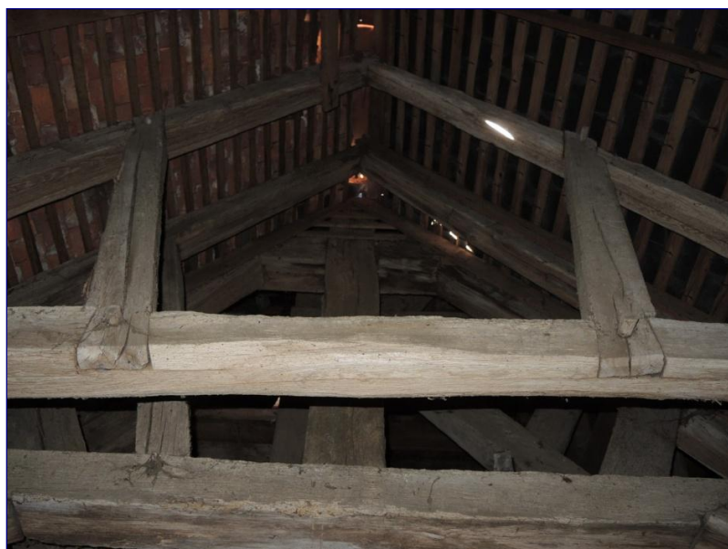
Fig. 8 : charpente de la travée droite, F 1, contrefiches reliant l'entraît retroussé aux chevrons
