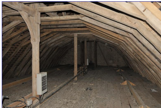
Charpente de la nef vers l'ouest
