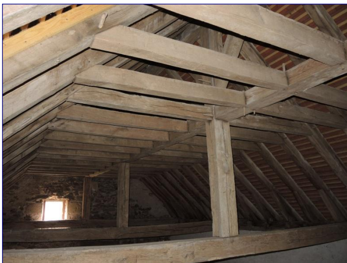
Charpente de la nef
