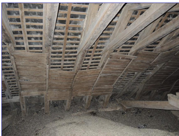
Fig. 6 : charpente de la nef, chevronnage sud conservant une partie du lambris
