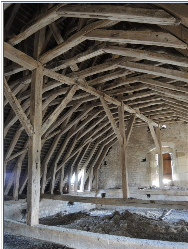
Fig. 6 : charpente du chœur vers l'est
