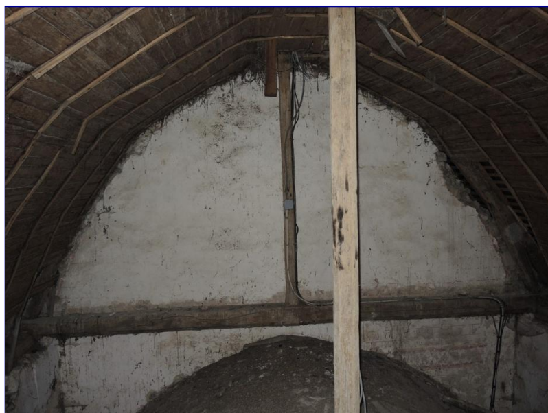
Fig. 16 : charpente du bras sud du transept, vue générale vers le sud
