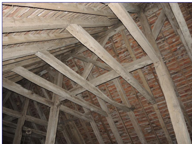
Charpente du chœur, contreventement à croix de Saint-André
