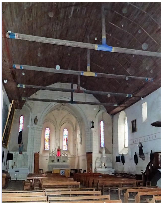
Nef, charpente apparente
