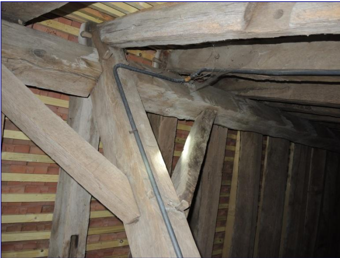
Charpente de la nef, tête de poinçon
