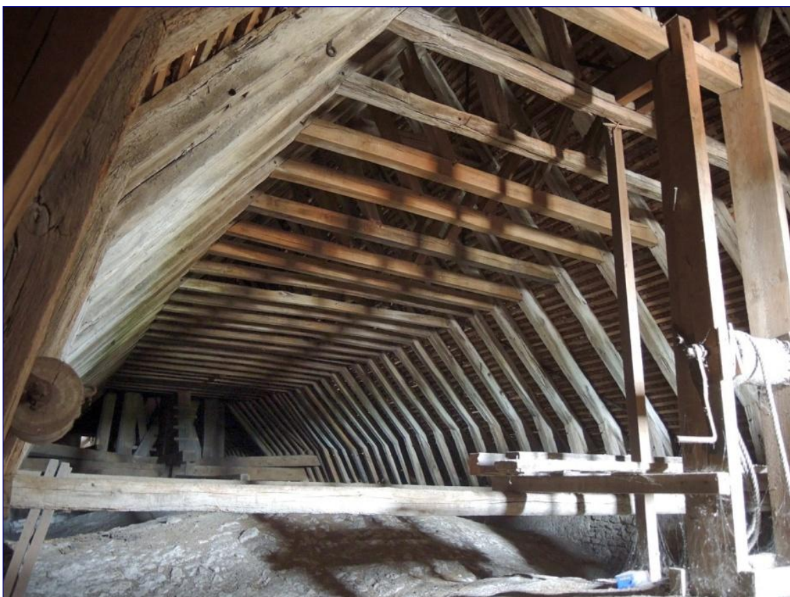
Fig. 7 : charpente est du chœur vers l'ouest
