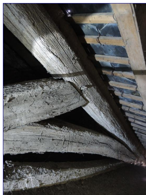
Fig. 10 : nef, structure 2, assemblage à tenon-mortaise
