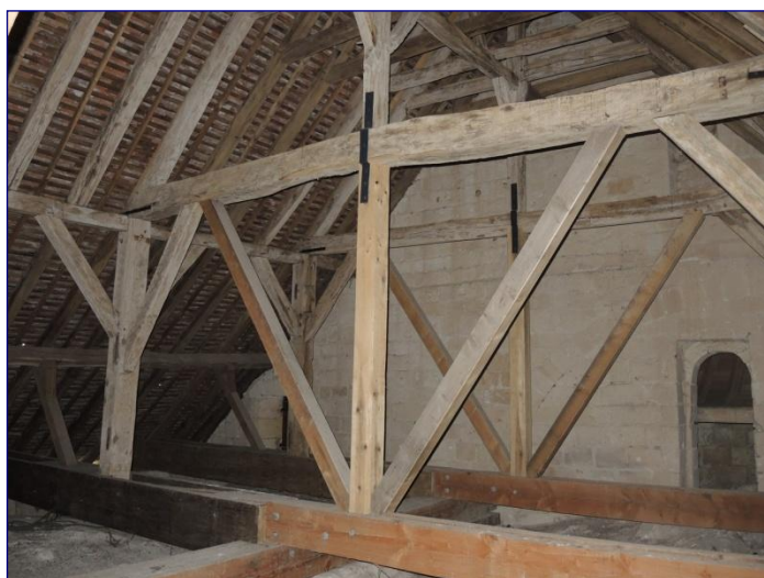
Fig. 12 : charpente du chœur vers l'ouest
