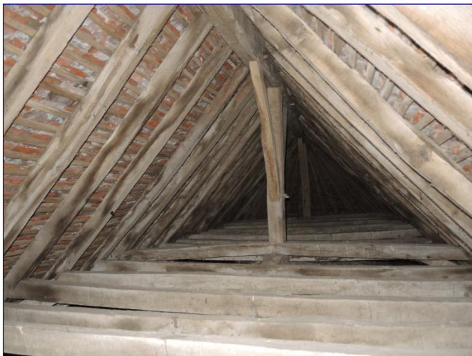
Charpente du chœur, vue vers l'est au niveau des entrails retroussés
