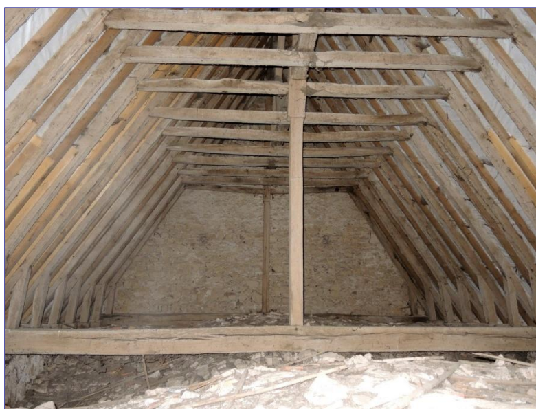
Charpente du chœur vers l'est
