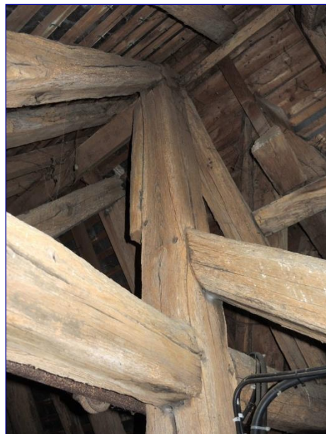
Fig. 14 : charpente du vaisseau principal, structure 2, tête de poinçon
