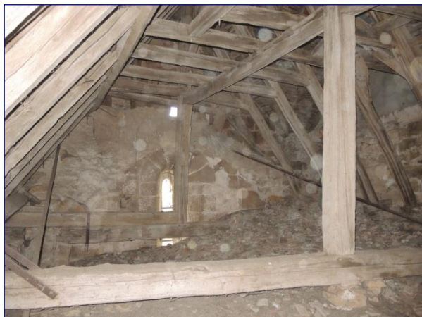
Structure ouest vers l'ouest
