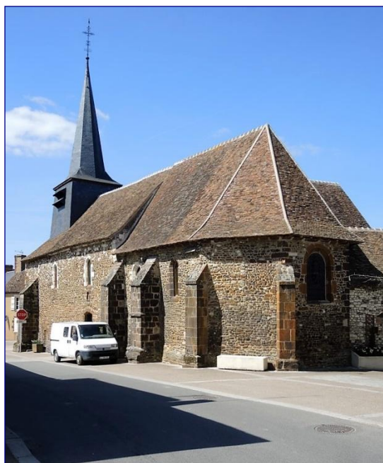
Vue générale de l'édifice vers le sud-ouest
