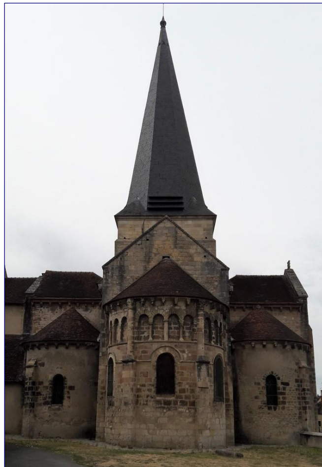
Fig. 2 : vue générale du chevet
