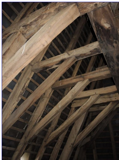
Charpente de la nef, détail
