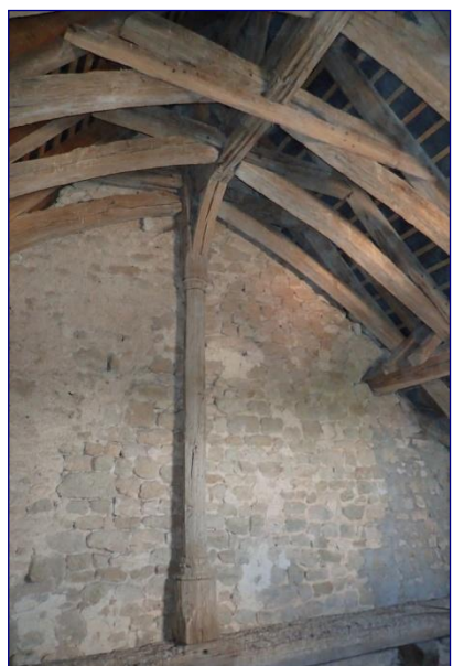
Charpente du chœur, ferme ouest
