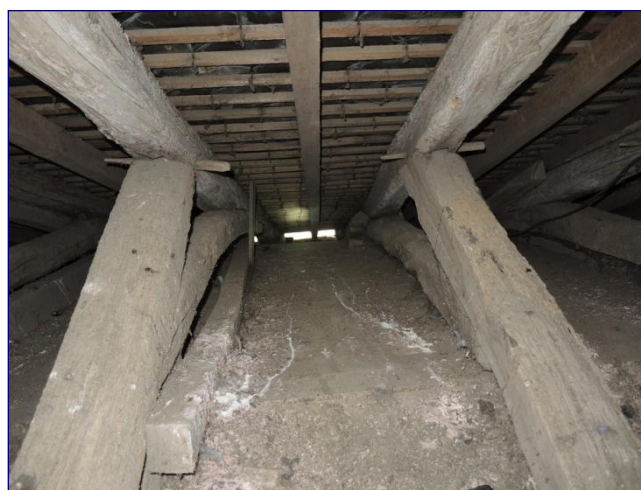
Fig. 8 : nef, structure 2, partie basse de 2 fermes
