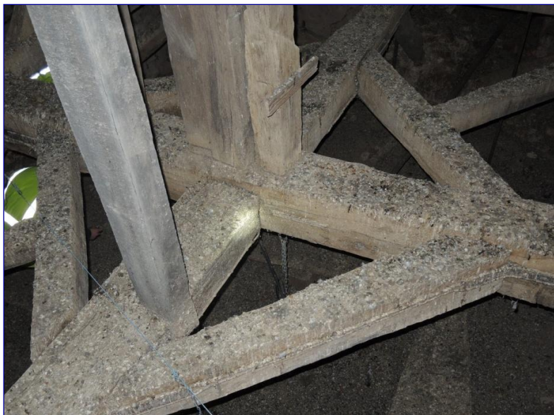
Fig. 18 : charpente de la flèche, enrayure basse
