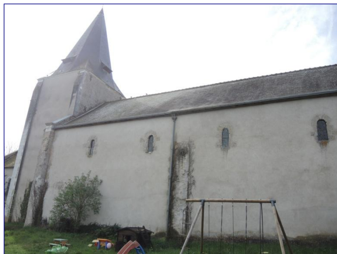
Vue générale du mur gouttereau sud de la nef
