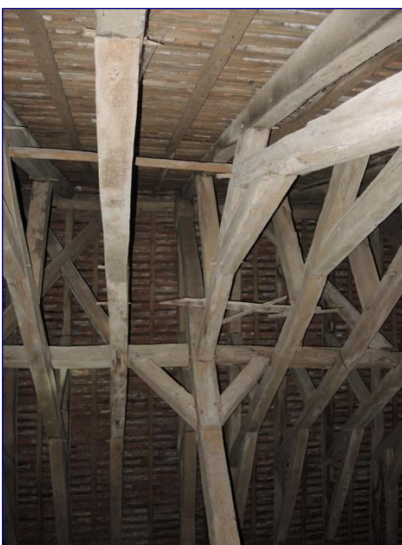
Charpente de la nef, contreventement
