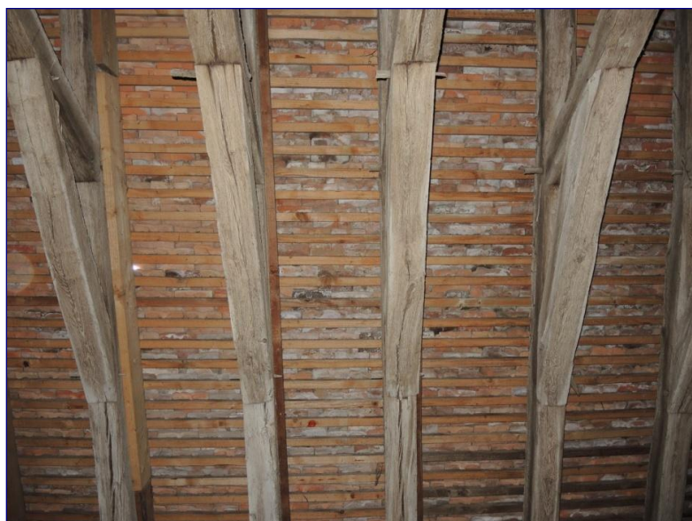
Fig. 14 : charpente orientale, aisseliers droits
