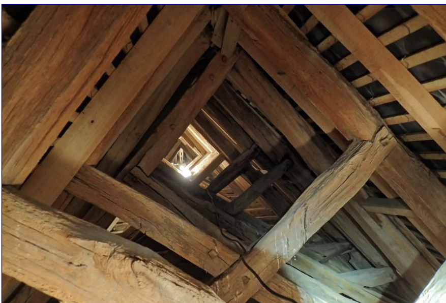
Fig. 6 : charpente de la nef vers l'est
