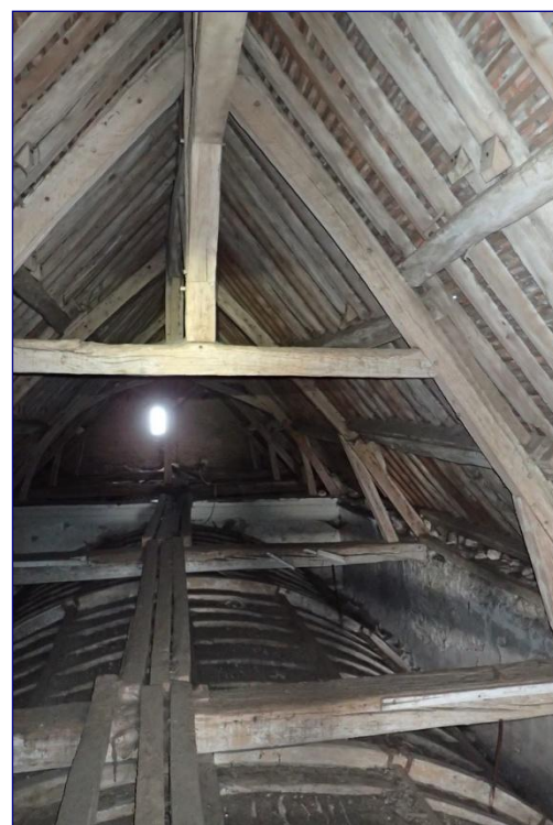
Vue générale du comble vers l'est
