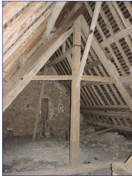
Charpente du collatéral, travée médiane
