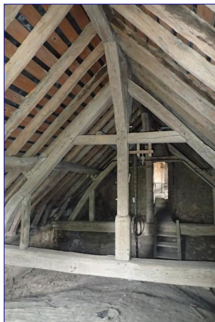
Charpente du chœur, 2 e ferme, face est
