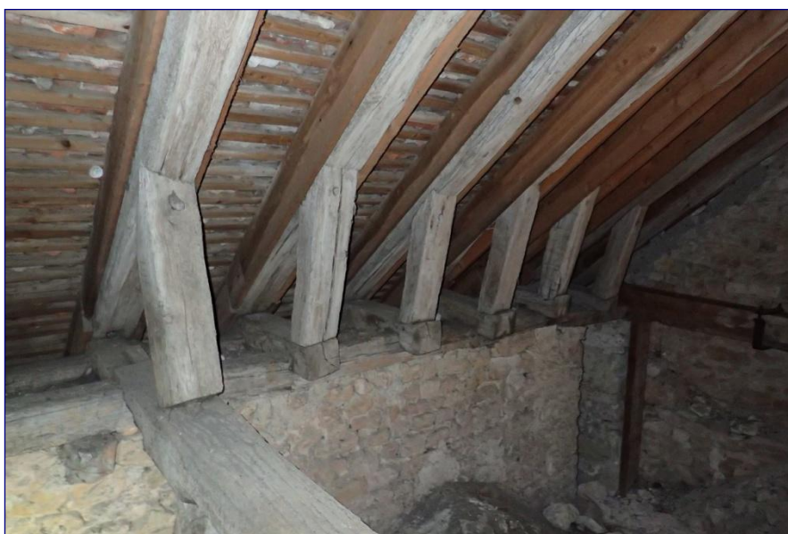
Fig. 6 : charpente des travées orientales, pieds de fermes au nord-est
