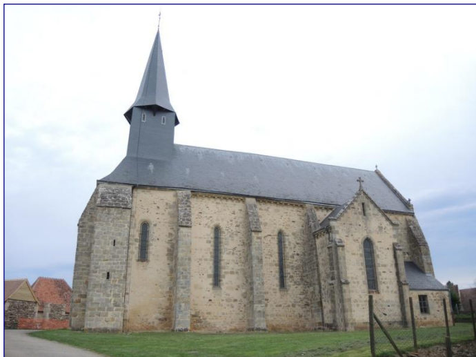
Vue générale de l'édifice vers le nord
