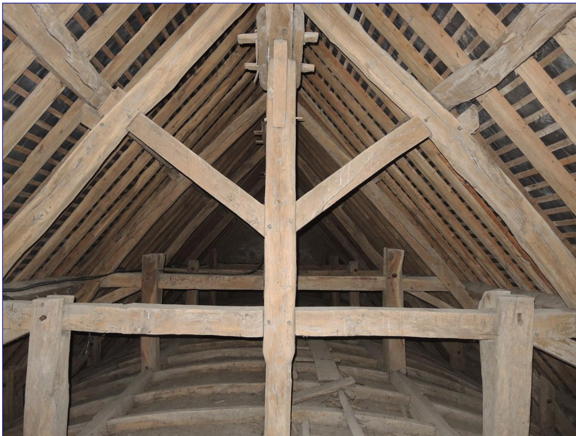
Fig. 16 : charpente de la nef, vue générale vers l'ouest
