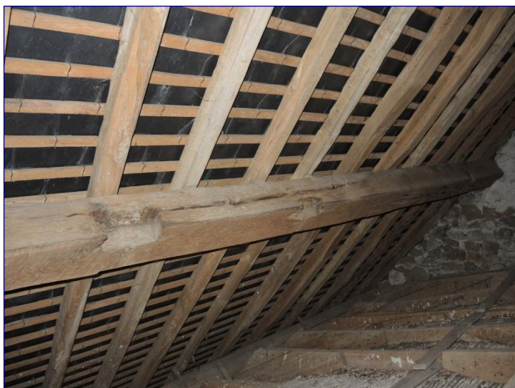
Fig. 14 : charpente de la nef, panne en rempli
