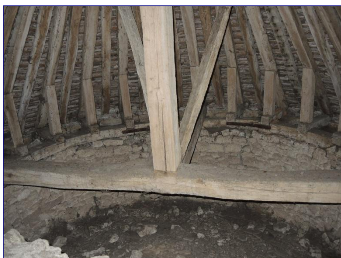
Charpente de l'abside, partie inférieure
