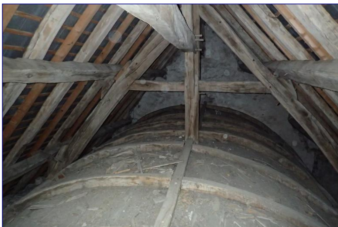
Charpente de la nef
