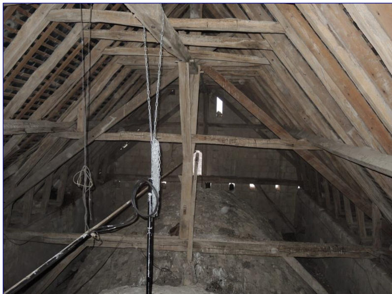
Fig. 7 : charpente du chœur, vue générale vers l'est
