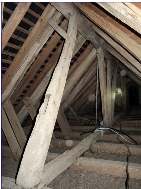
Fig. 13 : charpente de la nef, contreventement
