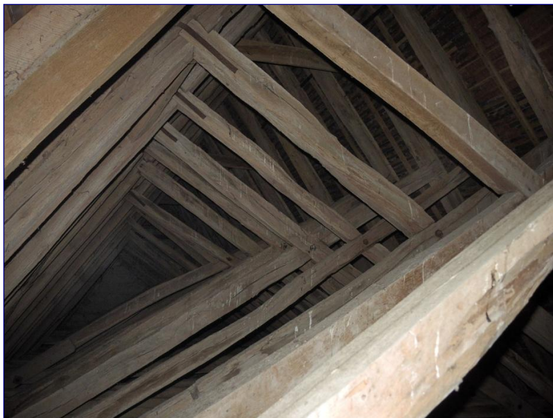
Fig. 5 : charpente de la nef, écharpes croisées
