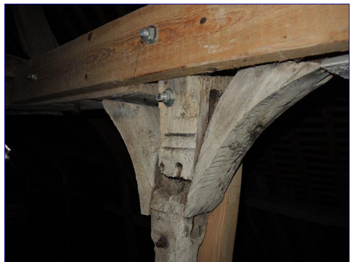
Charpente de la nef, poinçon sculpté de F7
