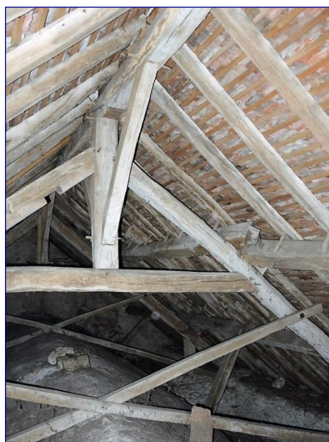
Charpente du chœur
