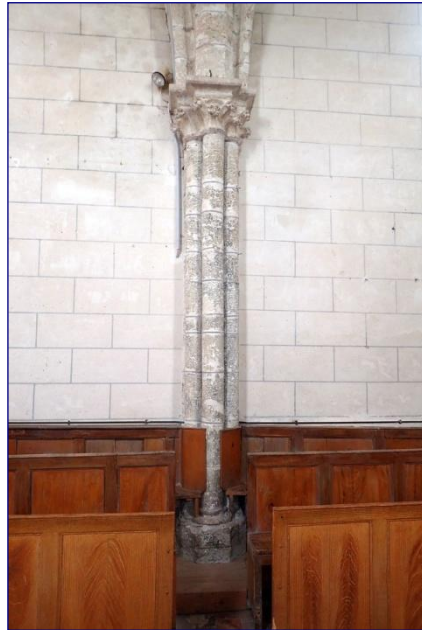
Support de voûtes entre les travées 3 et 4
