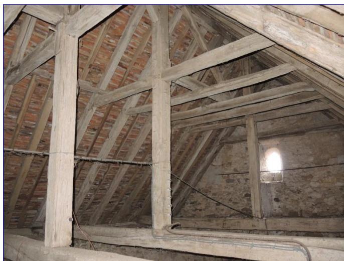
Charpente du chœur, vue générale vers l'est
