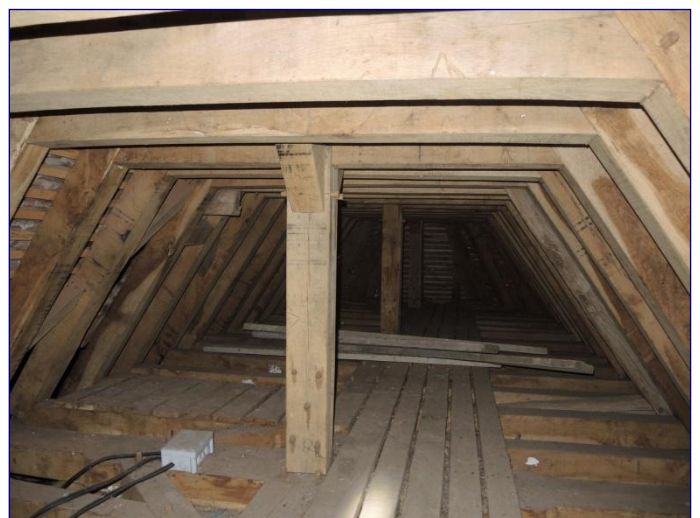
Charpente du chœur reconstruite en 2007
