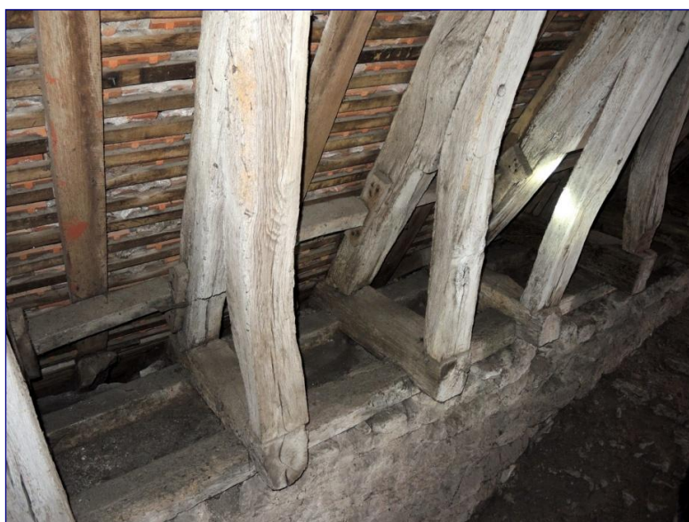
Fig. 13 : charpente de la nef, structure ouest, pieds de ferme
