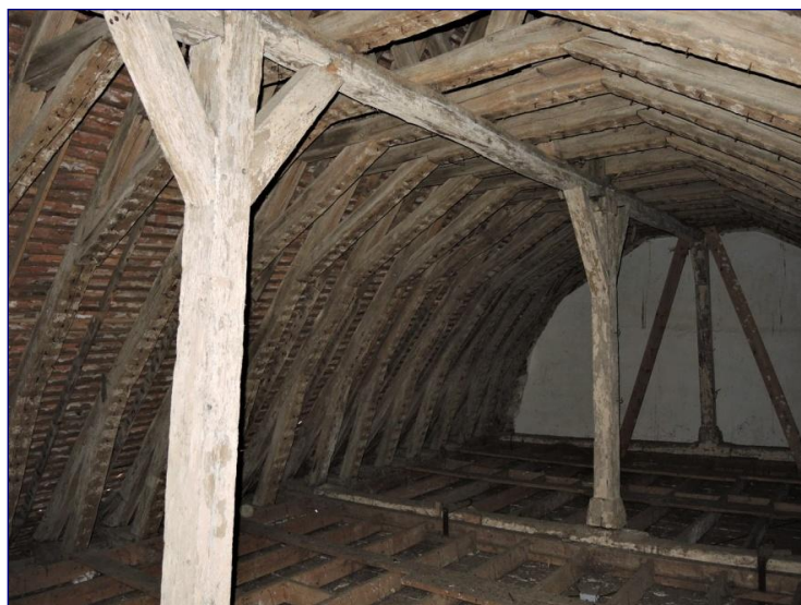
Fig. 5 : charpente de la nef, vue générale vers l'ouest
