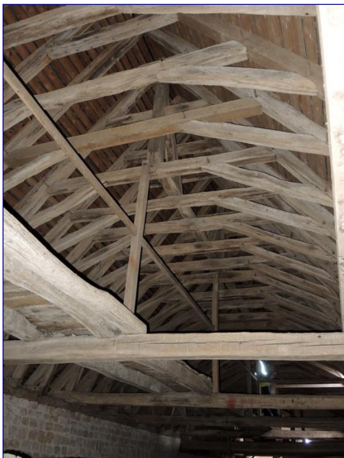
Fig. 12 : charpente de la nef (2 e et 3 e travées), vers l'ouest
