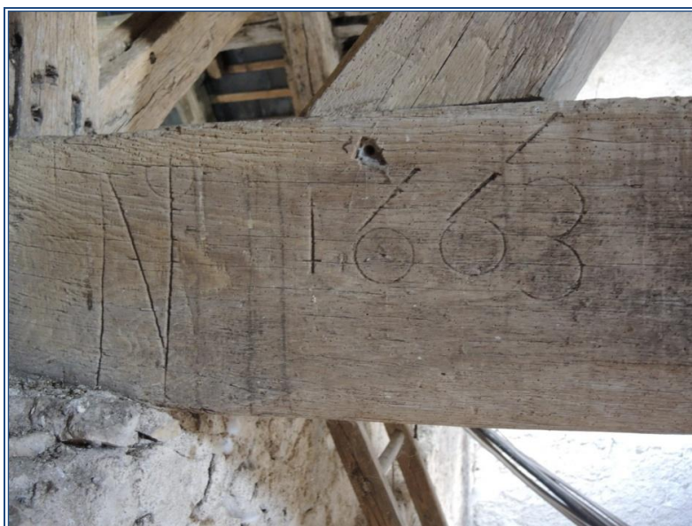
Fig. 14 : charpente de la croisée, marque de vente sur l'entrait d'axe au sud
