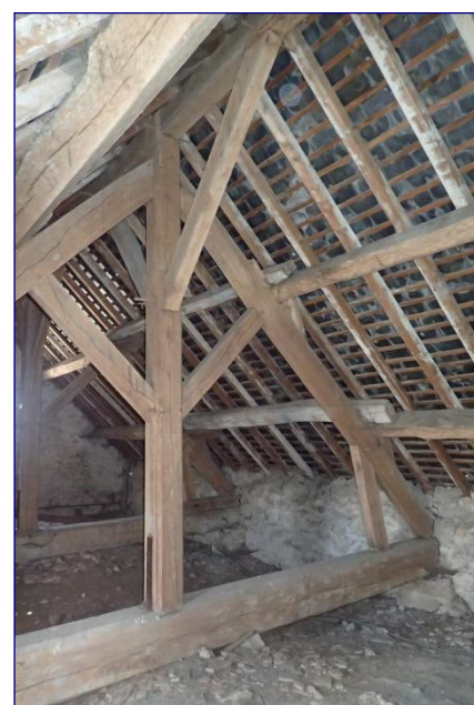
Charpente à fermes et pannes du chœur
