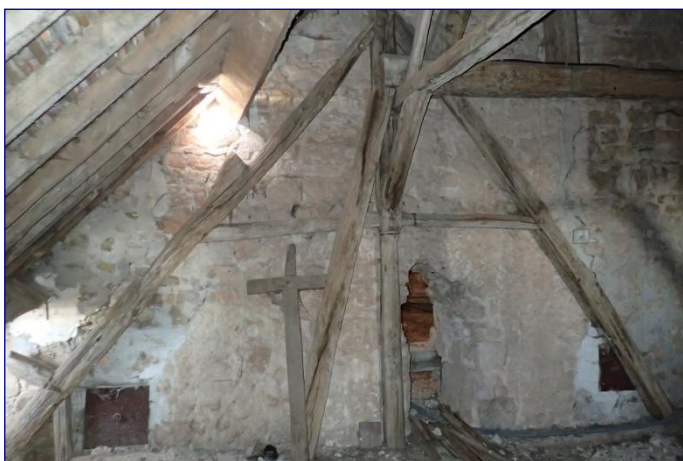
Charpente du chevet, structure 1
