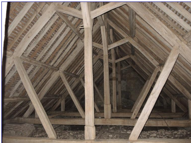
Charpente de la nef vers l'est
