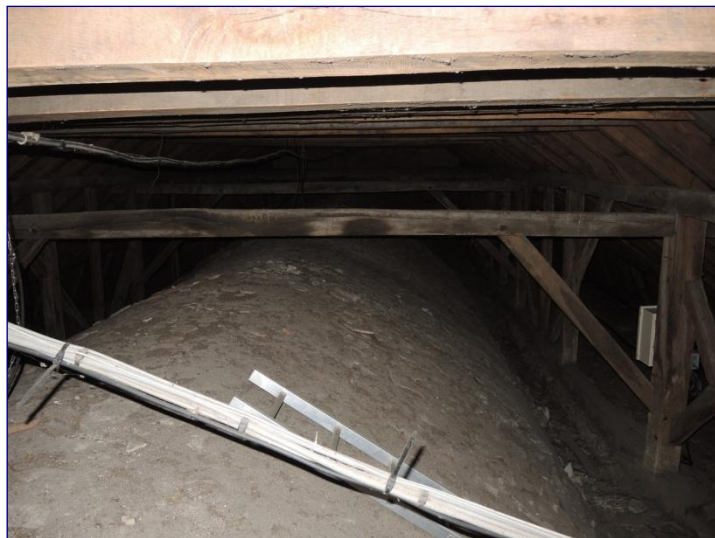
Fig. 6 : charpente de la nef, portique enjambant le berceau
