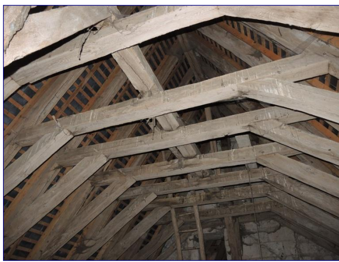
Charpente du chœur, parties hautes
