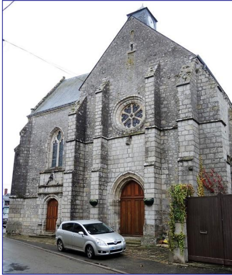
Façade occidentale de la nef et du collatéral
