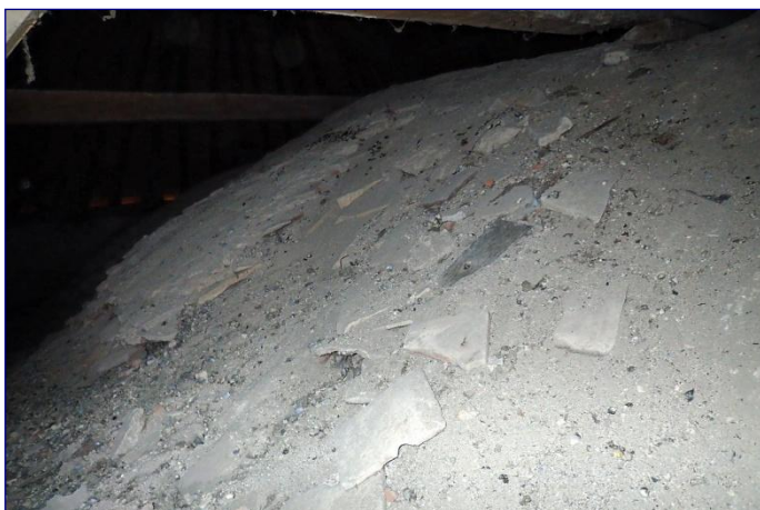
Voûte de la travée droite du chœur, ancien dispositif de couverture en tuile posé à même l'extrados
