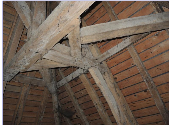
Charpente de la chapelle nord, enrayure haute de la croupe droite
