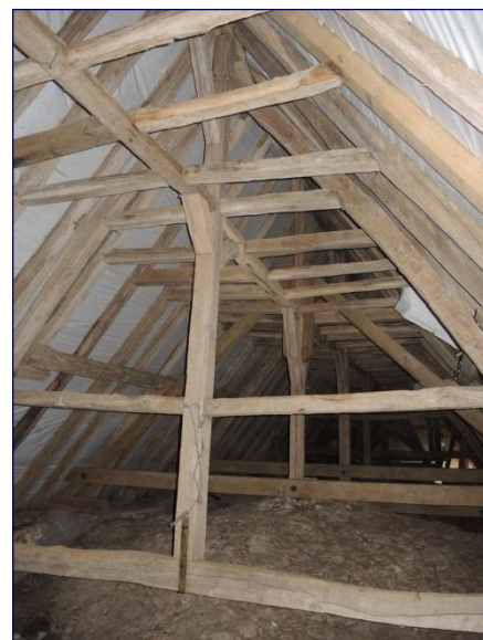
Charpente vers l'ouest
