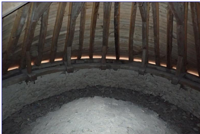
Charpente du chœur, croupe de l'abside
