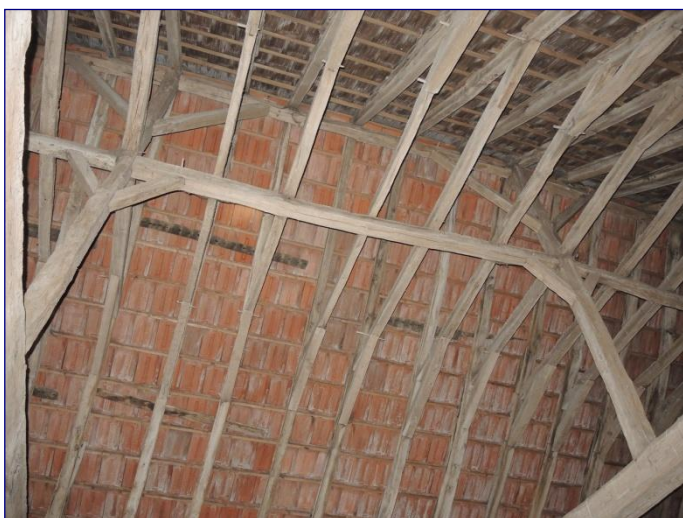
Charpente du chœur, contreventement
