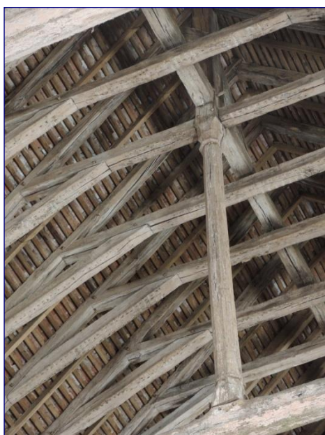
Fig. 9 : charpente de la nef, détail d'un poinçon
