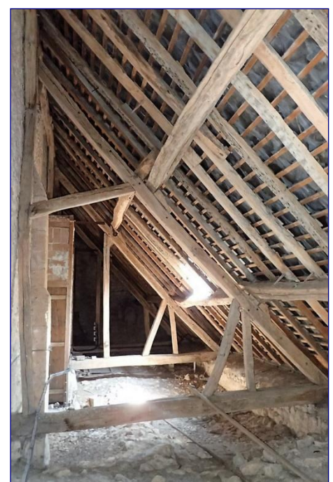
Charpente du collatéral sud
