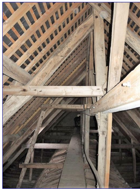
Charpente de la nef, vue vers l'est
