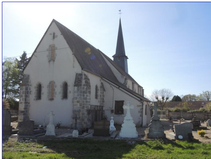
Fig. 2 : vue générale de l'église vers le sud-ouest
