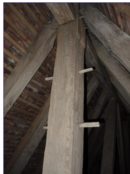
Charpente de la nef, détail d'un poinçon
