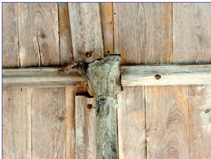
Fig. 9 : charpente de la nef, chapiteau de la 2 ème suspente
