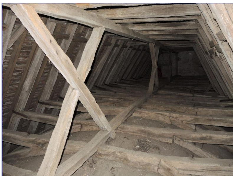
Fig. 10 : charpente de la nef, vue générale vers l'est
