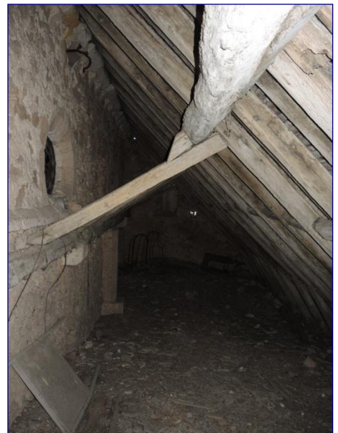
Collatéral, charpente en appentis
