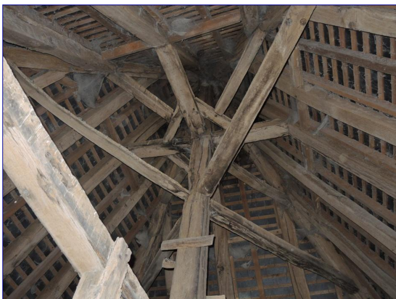
Fig. 19 : charpente de la flèche, enrayure haute
