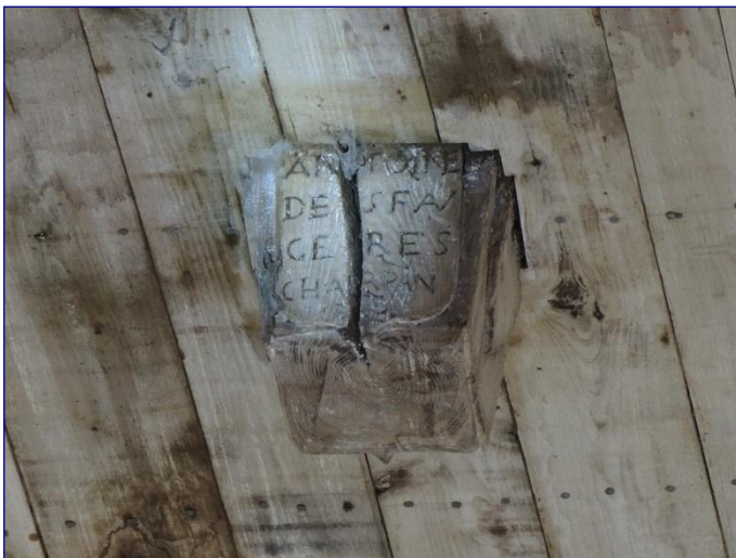
Charpente de la nef, clef pendante portant l'inscription « Antoine Desfaugeres charpentier »
