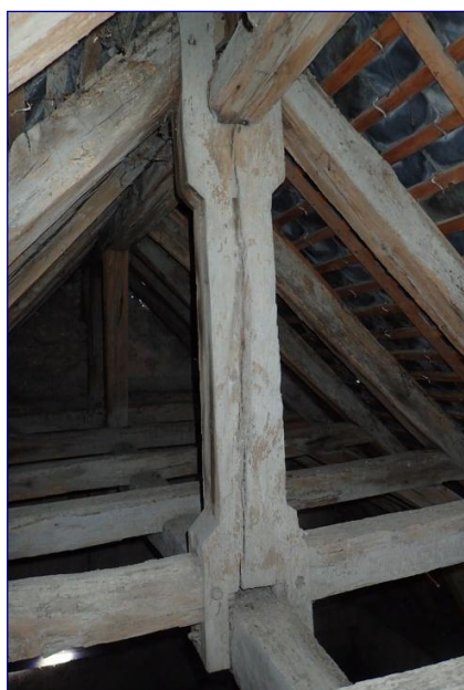
Charpente de la chapelle sud, détail du poinçon haut
