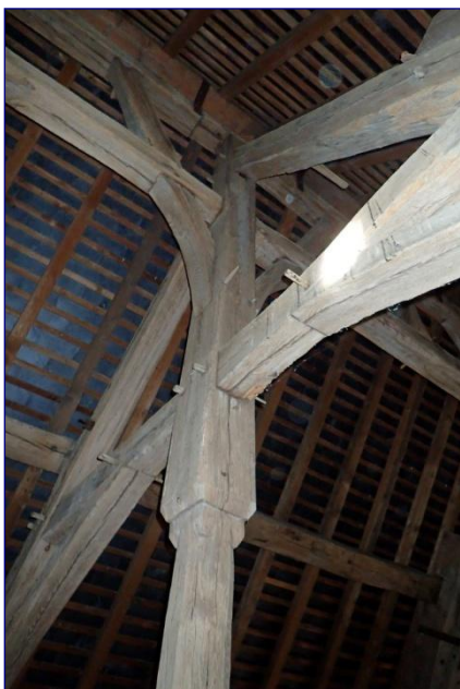
Charpente du vaisseau, détail d'un poinçon
