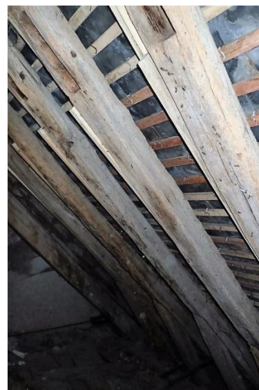
Chevrons avec mortaises orphelines
