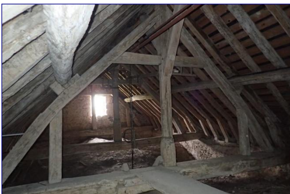
Charpente du chœur, vue générale vers l'est
