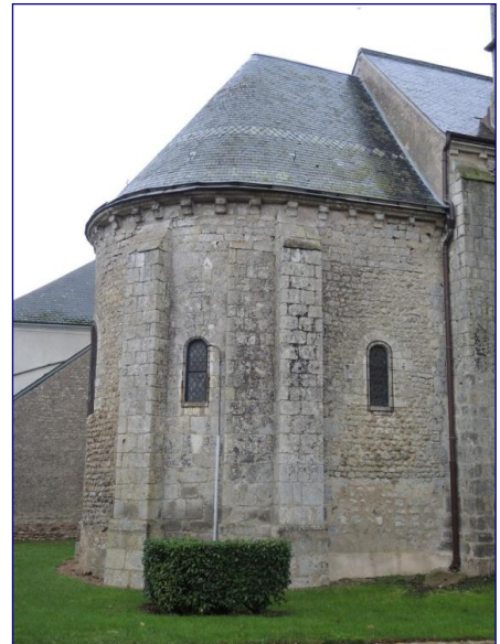
Fig. 2 : abside vue du nord
