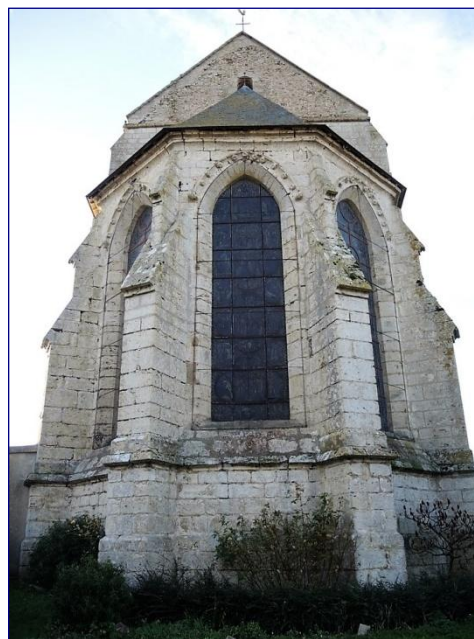
Arasement de la tourelle d'escalier au nord sur laquelle repose les fermes
