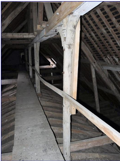
Charpente de la nef, vue vers l'ouest
