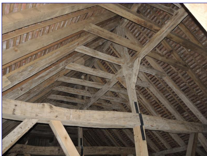
Fig. 11 : charpente du chœur
