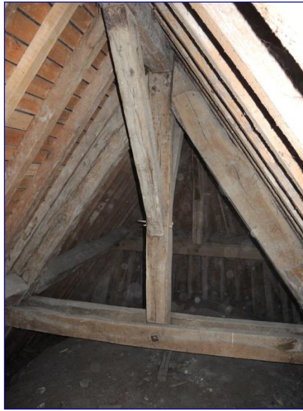
Charpente du chœur vers l'est
