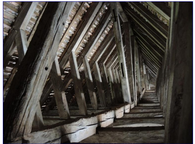
Charpente de la nef au-dessus des faux-entrées
