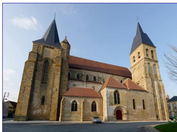
Vue générale de l'église au sud
