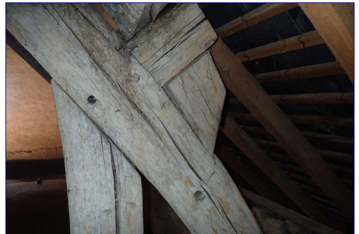
Charpente du vaisseau, assemblage arbalétrier et échantignole
