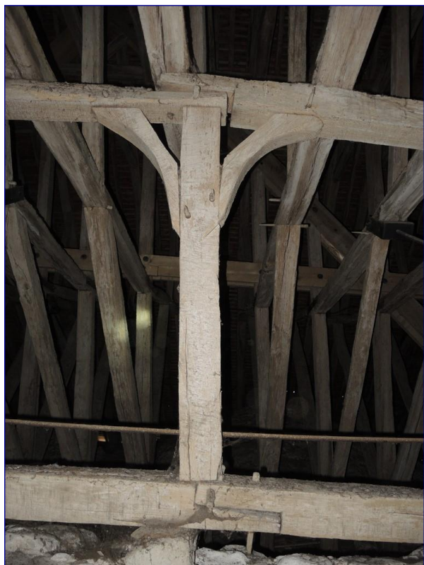
Fig. 19 : dispositif longitudinal, 3 e poteau avec aisseliers courbes pour renforcer l'assemblage de la sablière haute
