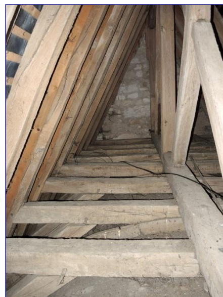
Charpente de la nef vers l'ouest
