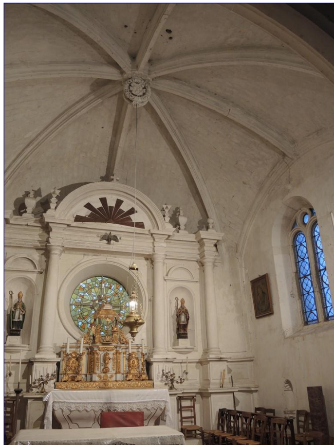
Fig. 3 : vue intérieure du chœur
