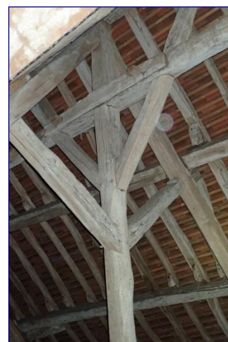
Charpente du vaisseau, détail
