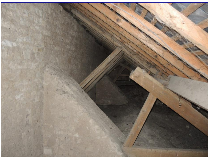
Fig. 11 : bas-côté sud du chœur, charpente en appentis, vue générale vers l'est
