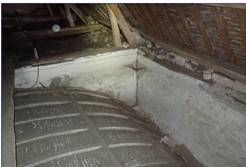
Extrados du berceau en bois et vestige d'une corniche en stuc
