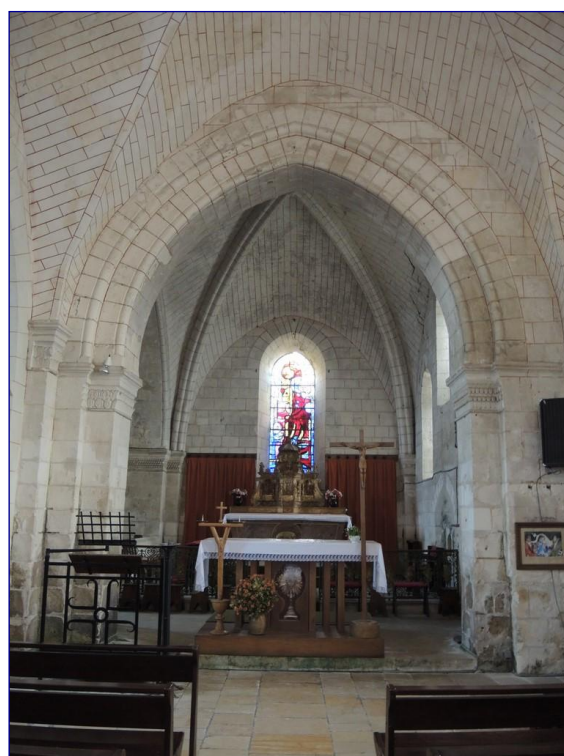
Fig. 8 : vaisseau sud, travée orientale
