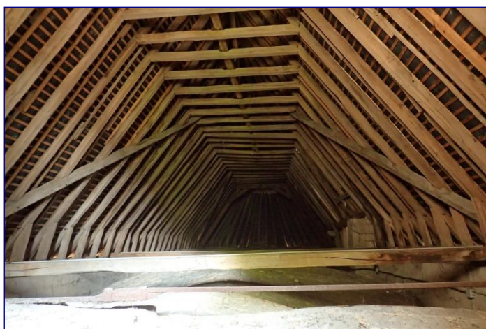
Charpente de la nef, vue générale vers l'est
