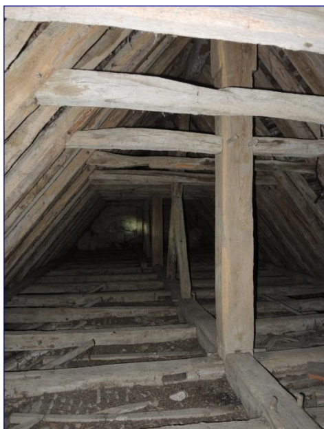
Charpente de la nef, vue générale vers l'ouest
