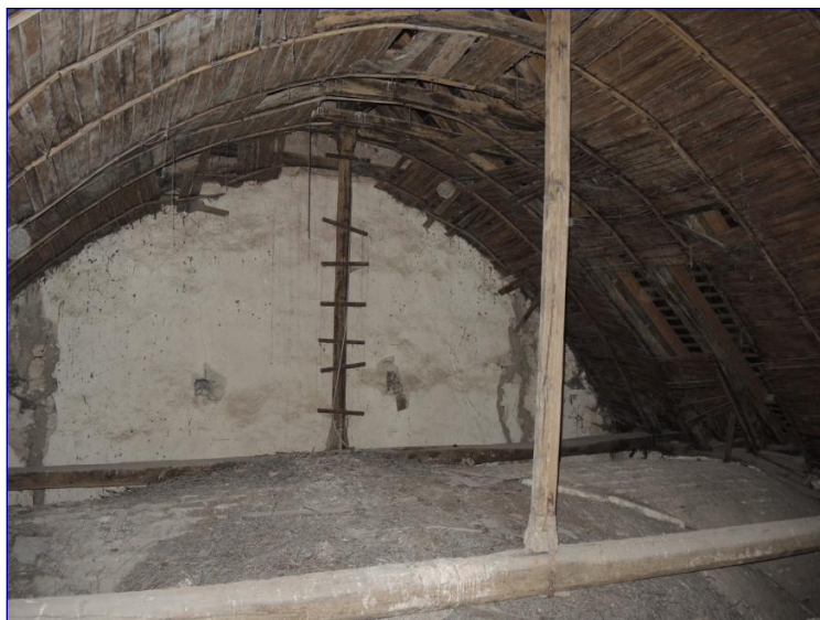
Fig. 9 : charpente du chœur, vue générale vers l'est
