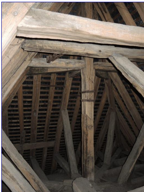
Fig. 13 : charpente du vaisseau principal, structure 2, vue vers l'ouest
