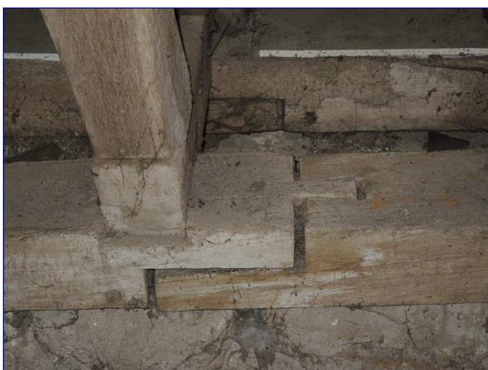
Charpente de la nef, assemblage des sablières par enture à tenon chevillé des sablières
