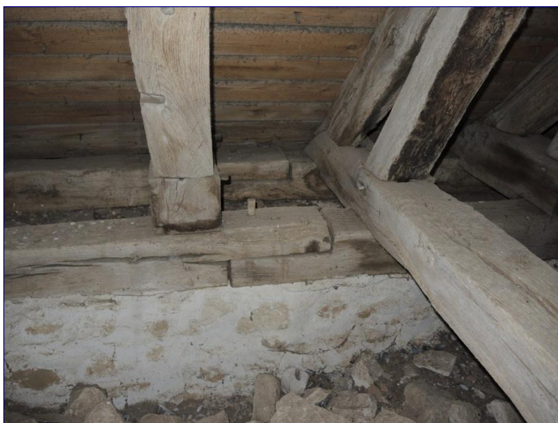
Fig. 12 : charpente de la nef, assemblage par enture des sablières
