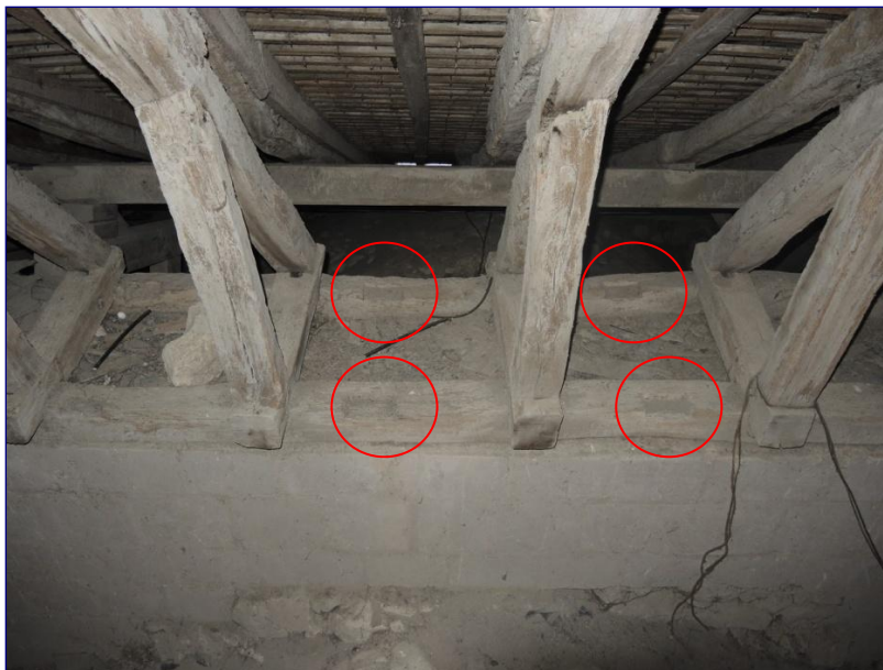
Fig. 10 : charpente du chœur, entailles simples sur les sablières témoignant d'un repentir
