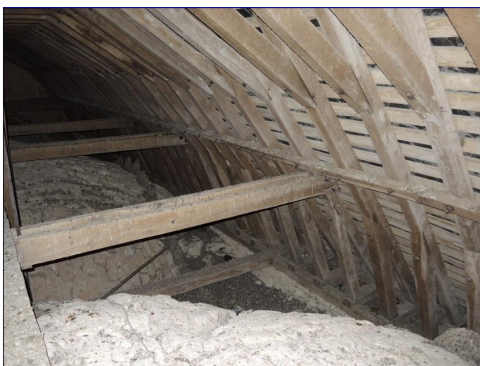
Charpente de la nef, fermes au nord
