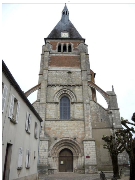
Fig. 3 : vue générale de l'église à l'ouest
