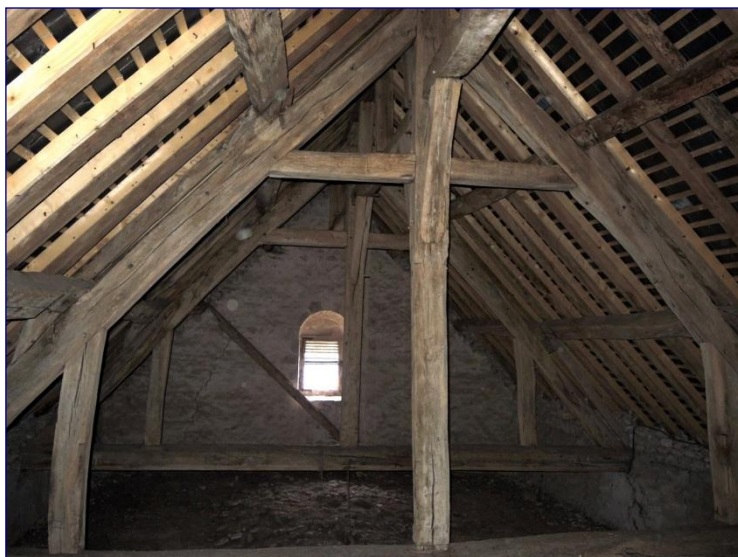
Charpente du chœur vers l'est
