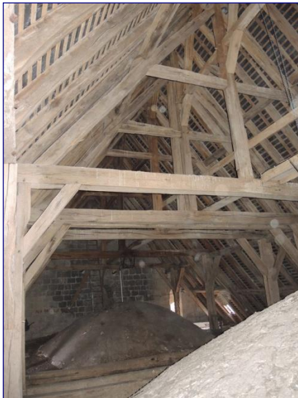
Charpente de la nef vers l'est
