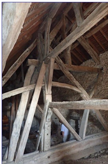
Charpente du chevet, structures 1 et 2
