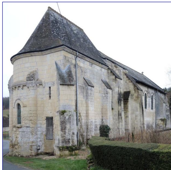
Fig. 2 : vue générale du chevet au nord-est
