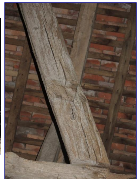
Charpente de la nef, remploi comme lien
