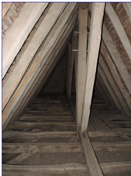
Charpente de la nef vers l'ouest
