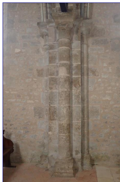
Mur gouttereau de la nef et du chœur
