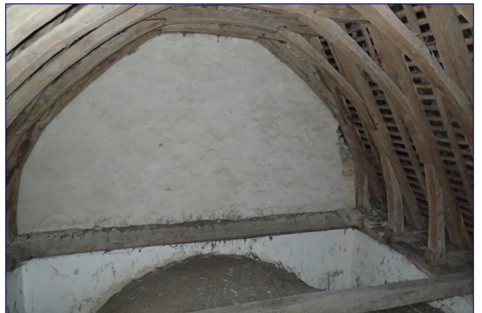
Charpente de la chapelle nord autrefois apparente
