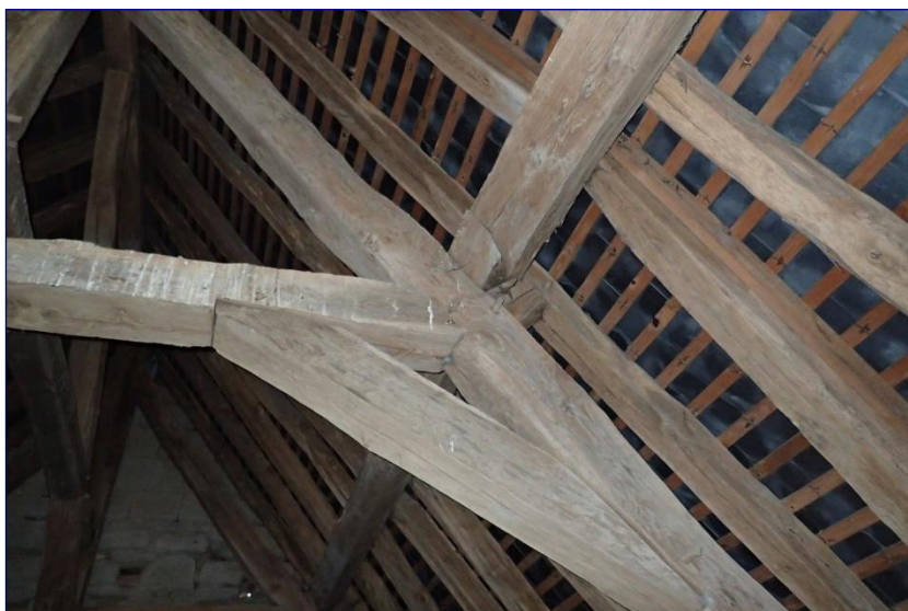
Charpente du chœur, assemblage des pannes en sifflot
