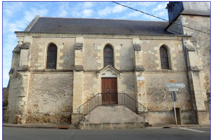
Fig. 2 : vue générale de la nef au sud
