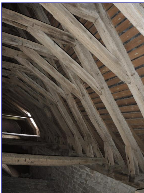
Fig. 16 : charpente de la nef (2 e et 3 e travées), fermes au nord
