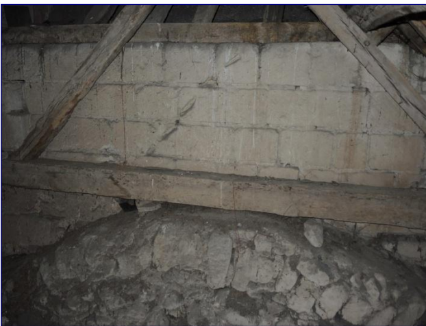
Charpente du bras nord du transept et encoches d'une ancienne toiture
