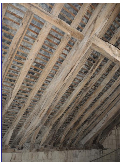
Fig. 15 : chapelle sud, charpente en appentis
