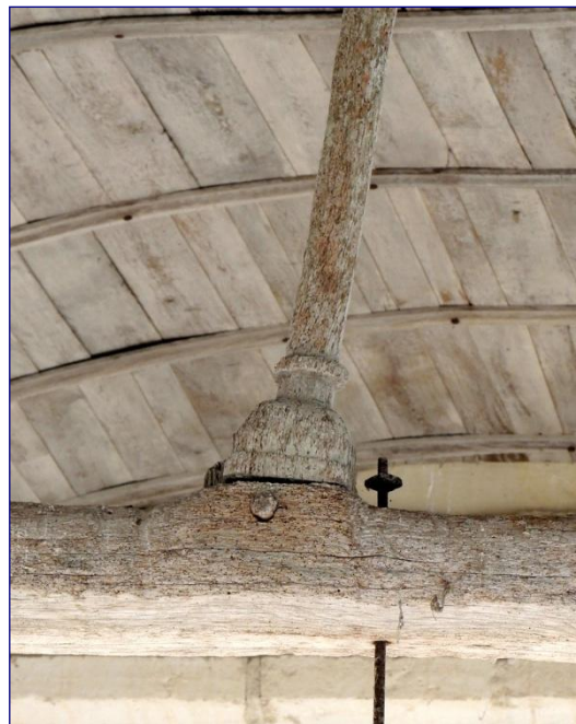
Fig. 7 : charpente de la nef, base de la 4 ème suspente
