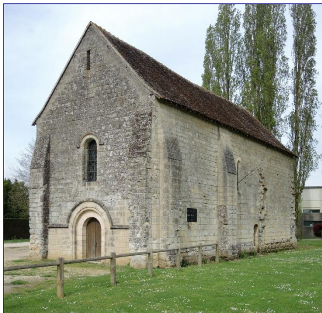
Vue générale de la chapelle au sud-ouest
