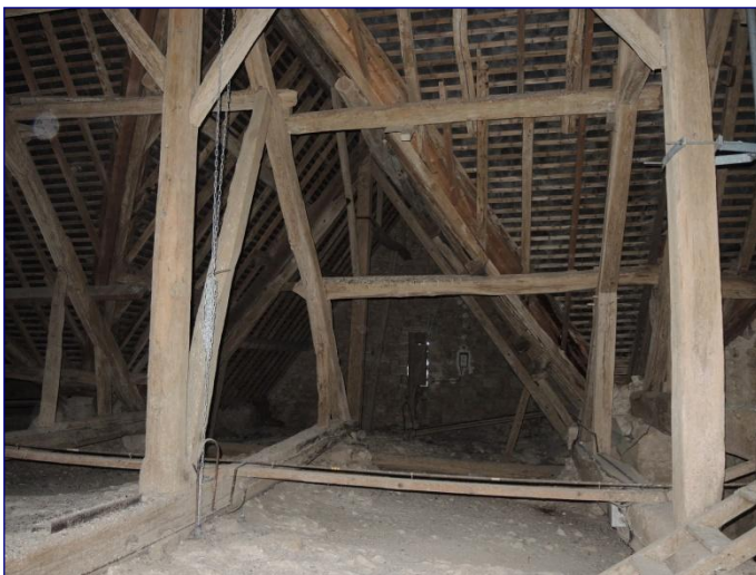
Charpente de la nef et en arrière plan, charpente de la travée médiane du collatéral
