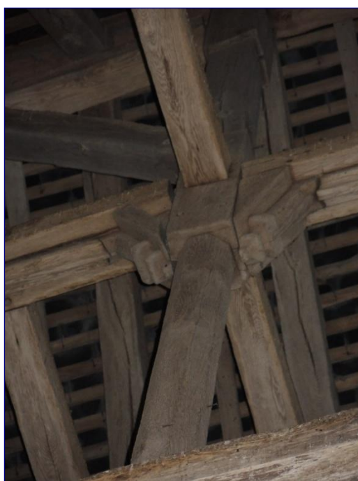
Charpente, détail de consolles décoratives
