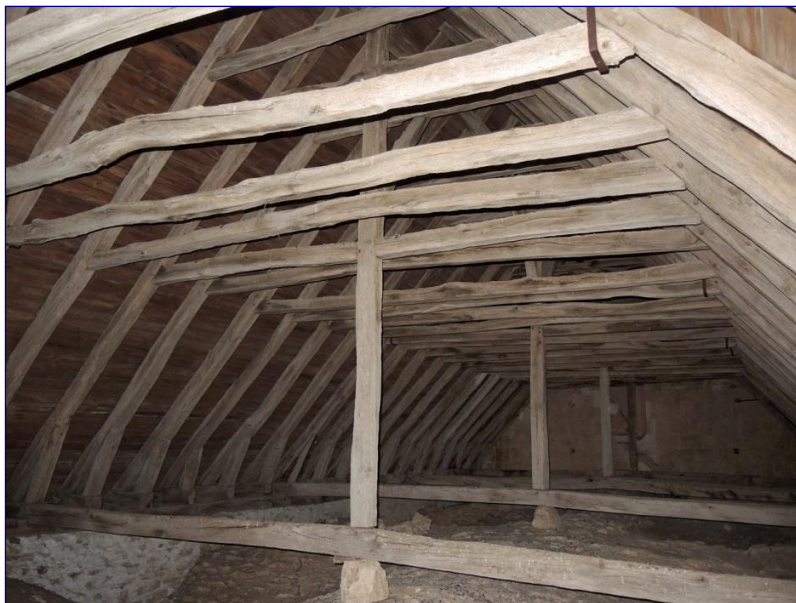
Fig. 8 : charpente de la nef
