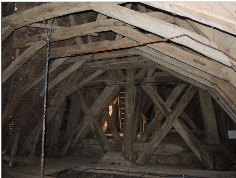
Fig. 7 : charpente de la travée droite, vue vers l'ouest ; en arrière-plan, le clocher de charpente
