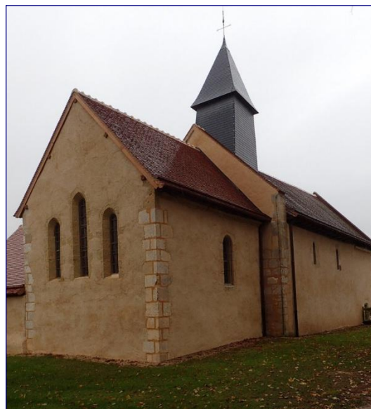
Vue générale de l'édifice vers le sud-ouest après ravalement
