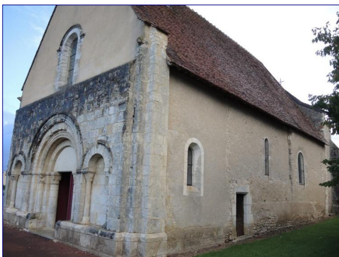
Nef vue du sud-ouest
