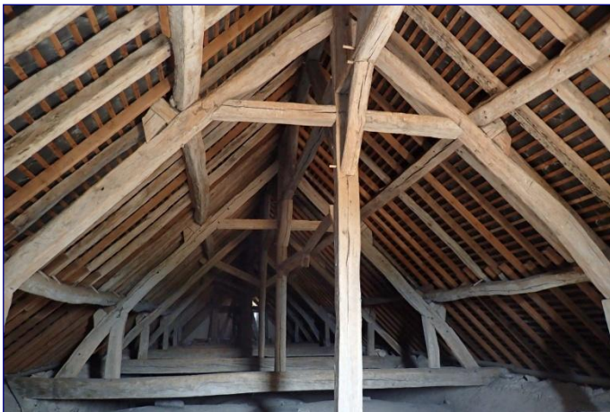
Charpente du vaisseau vers l'est
