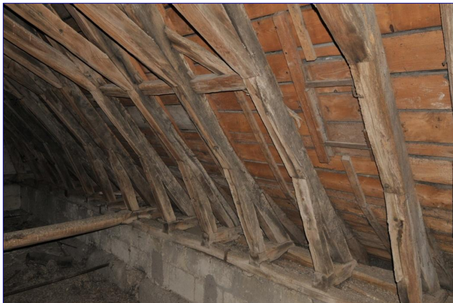
Fig. 10 : charpente du bras nord, pied des fermes (versant est)
