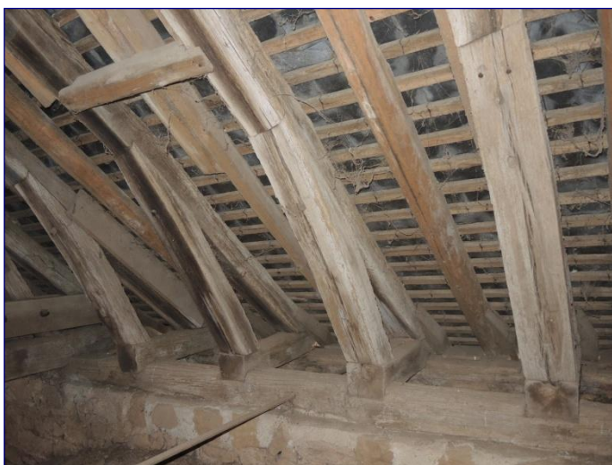
Charpente de la nef, pieds de ferme
