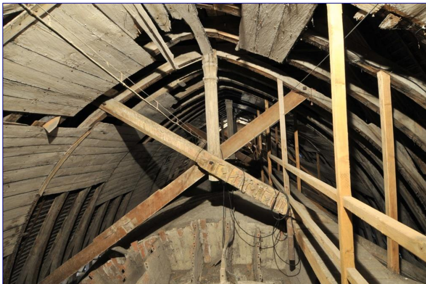
Fig. 5 : charpente de la nef vers l'ouest
