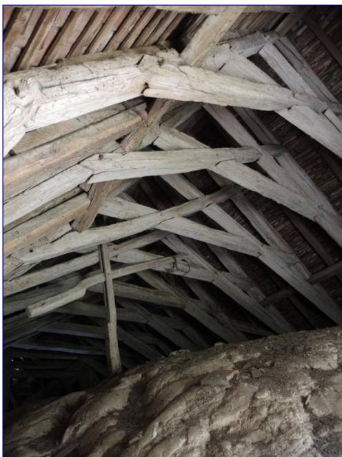
Fig. 9 : chevrons réunis par des écharpes croisées
