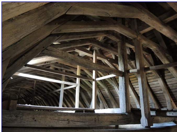
Fig. 18 : jonction des charpentes de la nef, entre 2 e -3 e travées et travée ouest
