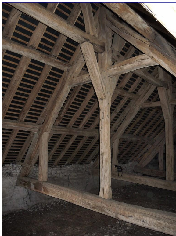
Charpente du chœur
