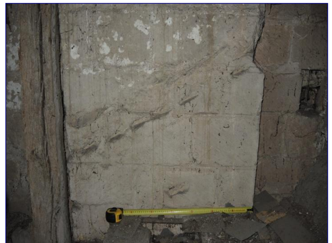
Charpente du bras nord du transept, encoches d'une ancienne toiture
