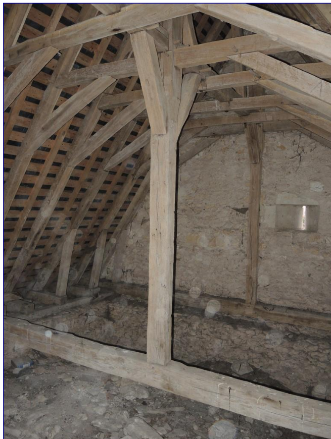
Fig. 12 : charpente de la chapelle nord, vue générale vers le nord
