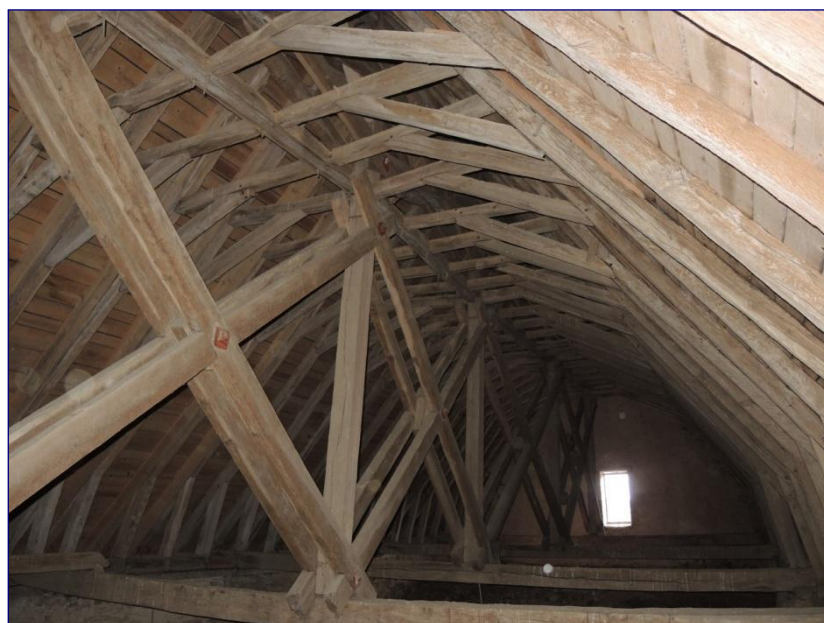
Charpente, vue générale vers l'est
