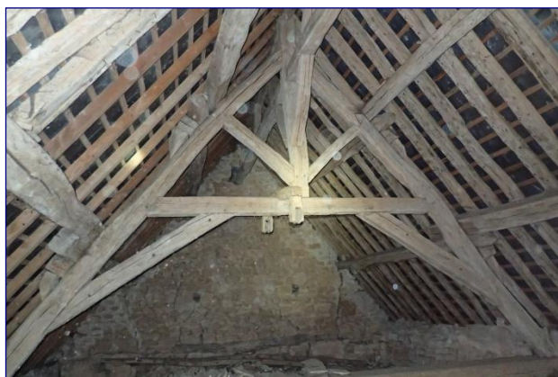
Charpente vers l'est
