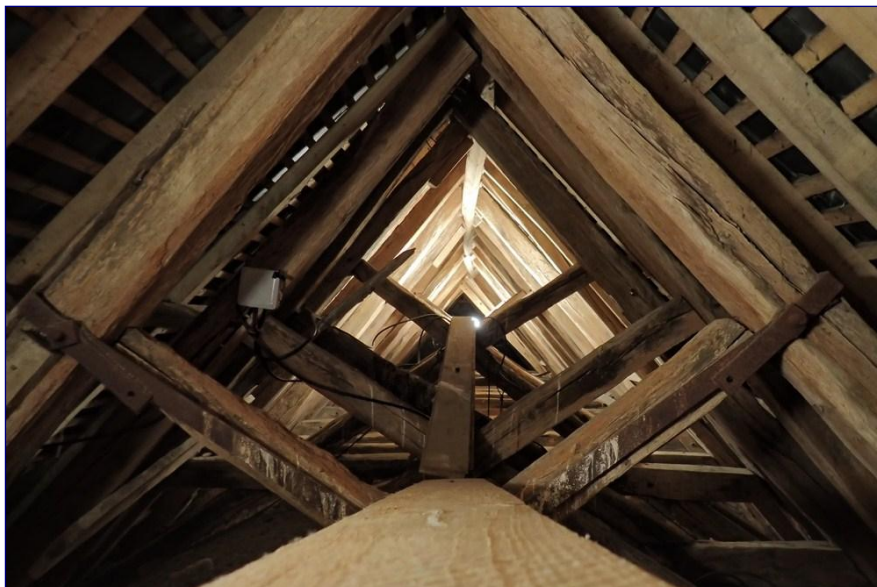
Fig. 5 : charpente de la nef vers l'ouest
