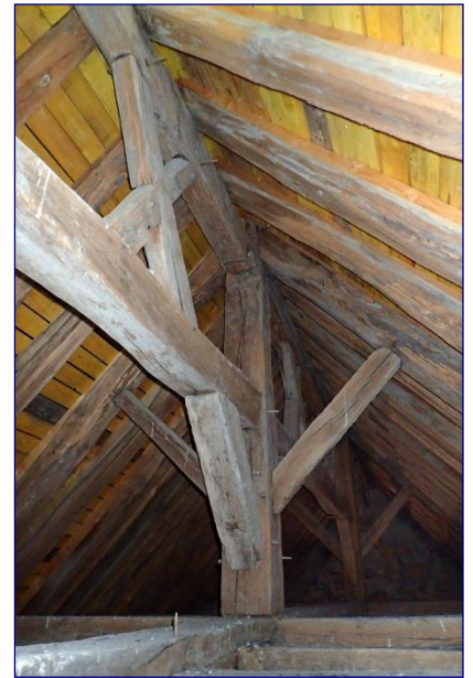
Charpente du vaisseau, contreventement
