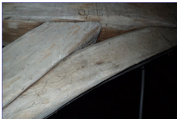
Charpente du chœur, marquage au crayon de bois
