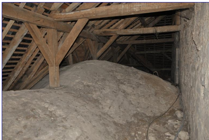
Charpente en appentis du transept
