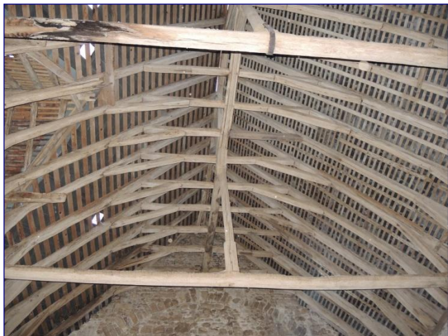
Charpente, vue générale vers l'ouest
