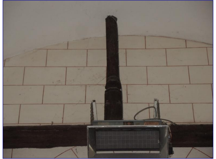
Base du poinçon de la ferme occidentale (F1)
