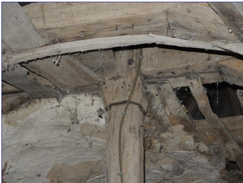
Fig. 15 : charpente du bras nord du transept, tête de pignon
