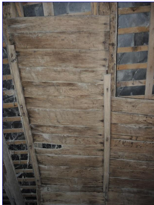
Fig. 8 : charpente de la nef, lambris cloués et couvre-joints
