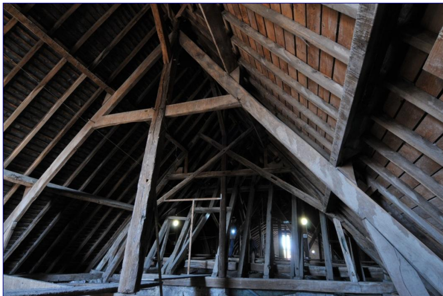
Fig. 13 : charpente du bras sud, vue générale vers le nord
