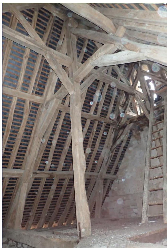
Charpente du chœur, ferme principale
