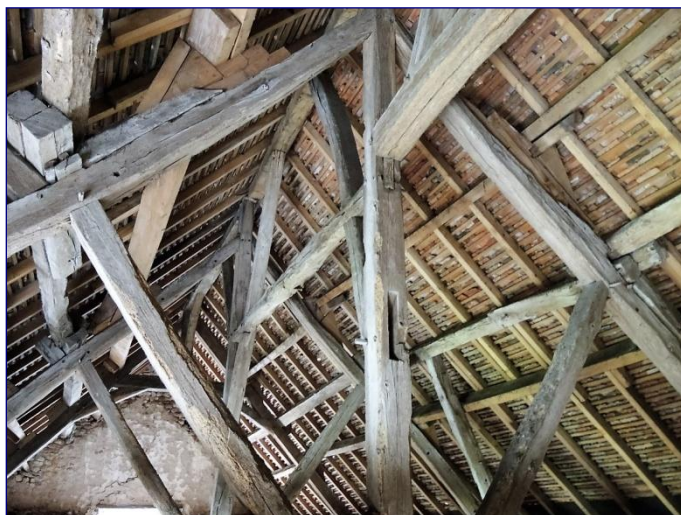
Charpente de la nef, vue vers l'ouest
