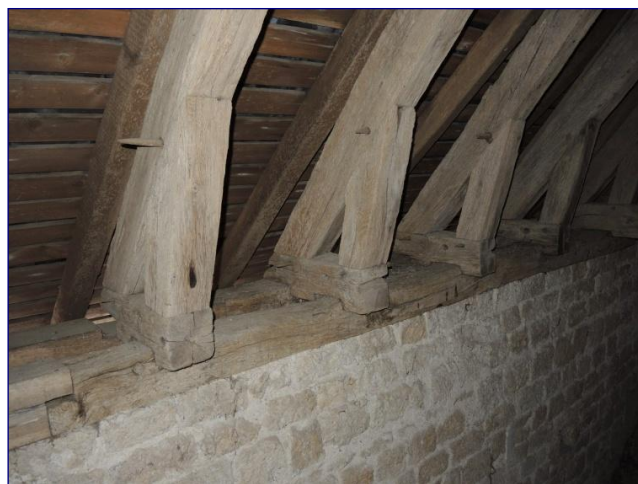
Fig. 15 : charpente de la nef (2 e et 3 e travées), pieds de ferme
