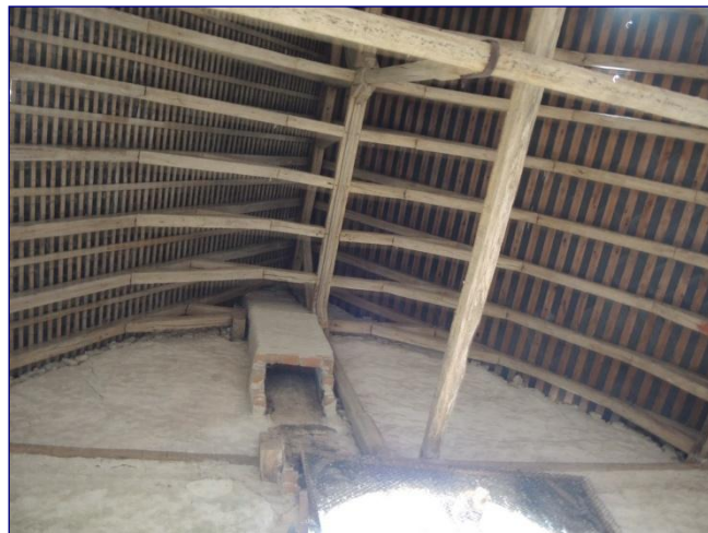
Charpente, partie orientale
