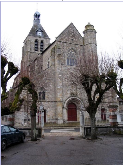
Fig. 3 : vue de l'église à l'ouest
