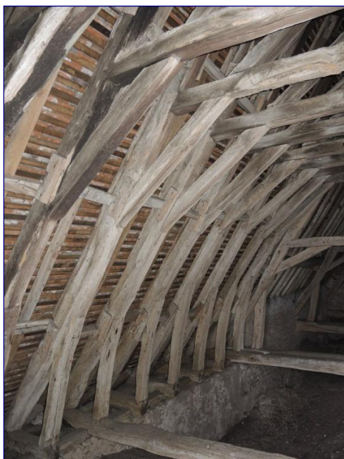
Fig. 7 : charpente ouest de la nef, côté nord
