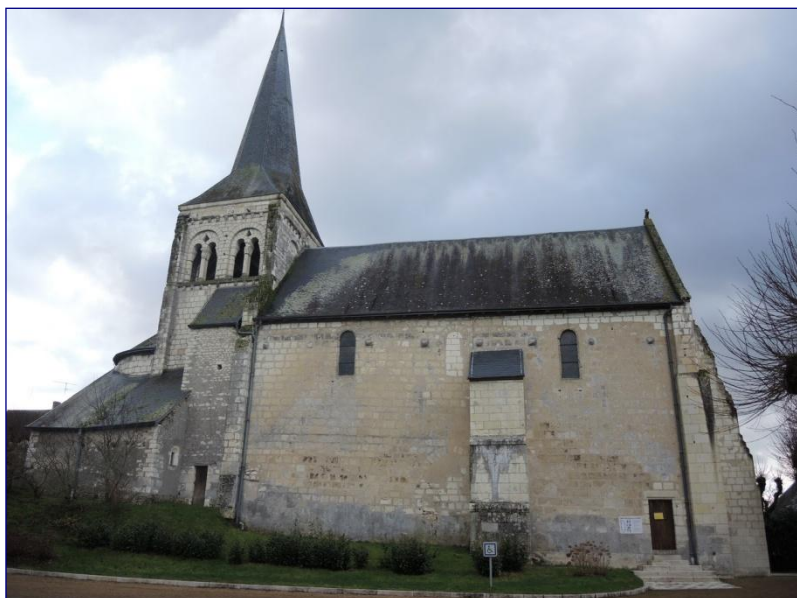
Vue générale de l'édifice vers le sud
