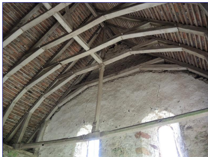
Charpente du vaisseau, extrémité est
