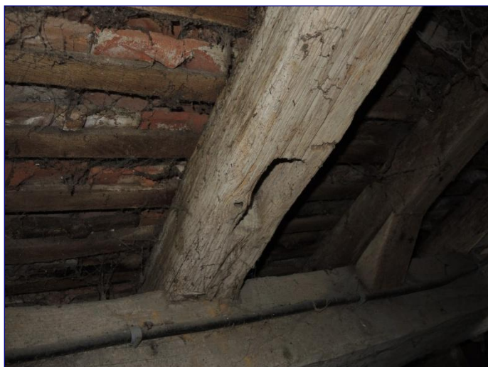
Charpente du chœur, travée est, chevron en remploi
