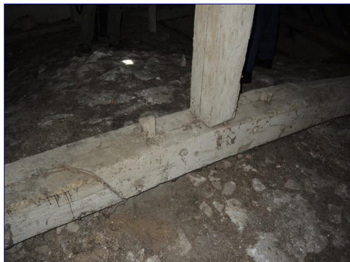
Charpente du chœur, entrait dont les 2 pièces sont assemblées par enture droite crantée verticale et bloquée par des clavettes
