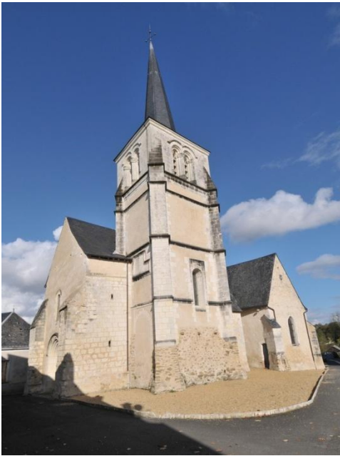
Vue générale de l'édifice vers le nord-est
