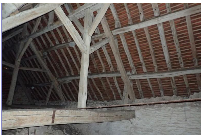
Charpente du vaisseau, côté sud
