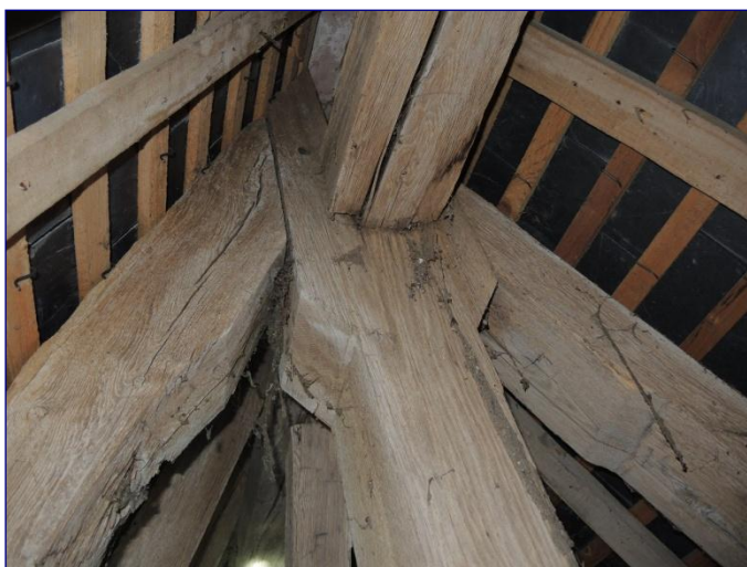
Charpente de la nef, détail des têtes de chevrons et de poinçon
