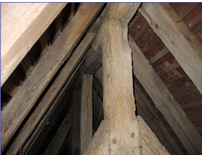
Charpente de la nef, tête de poinçon
