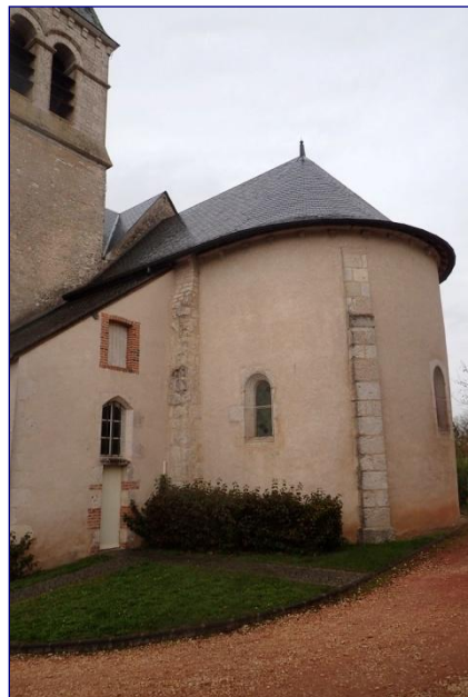
Vue du chevet depuis le sud-est
