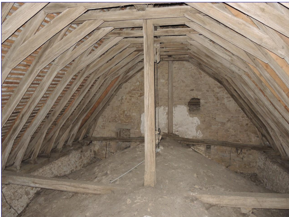
Fig. 12 : charpente orientale, vue générale vers l'est
