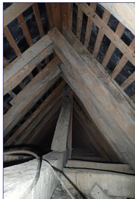
Charpente de la nef vers l'ouest
