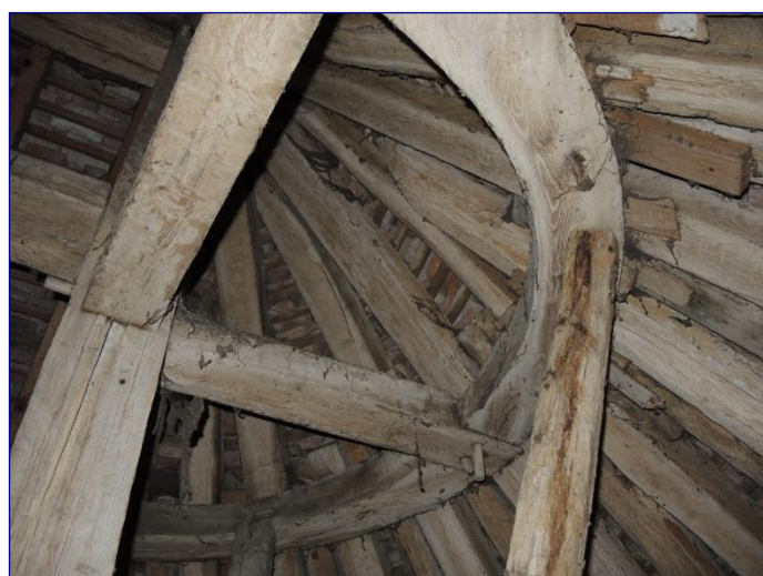
Charpente de l'abside, partie supérieure de la croupe
