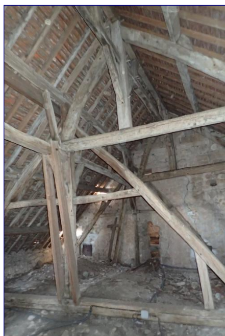
Charpente du chevet, structures 1 et 2
