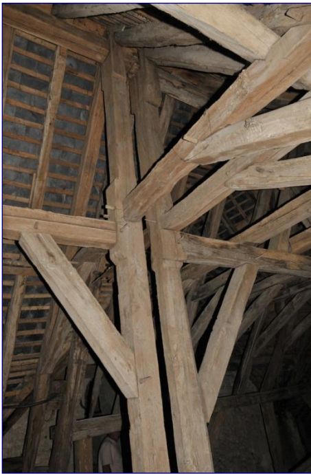
Jonction entre les deux charpentes de la nef
