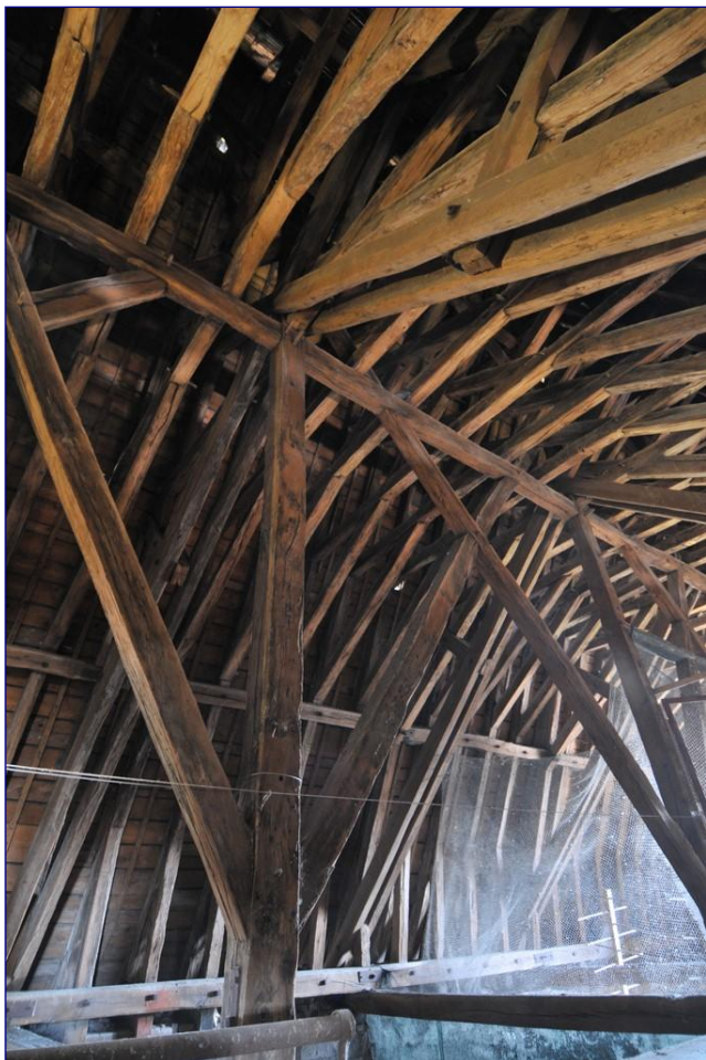
Fig. 4 : charpente de la nef, poinçon et écharpes croisées
