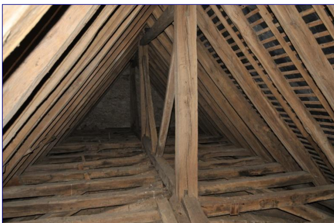
Charpente du chœur, vue générale vers l'est
