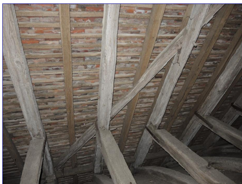
Fig. 14 : charpente de la nef, versant nord, lisse oblique réunissant les chevrons
