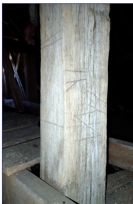
Charpente du vaisseau, trait de rameneret sur un poinçon
