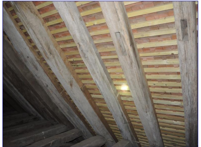
Charpente de la nef, chevrons en remploi avec mortaises vides
