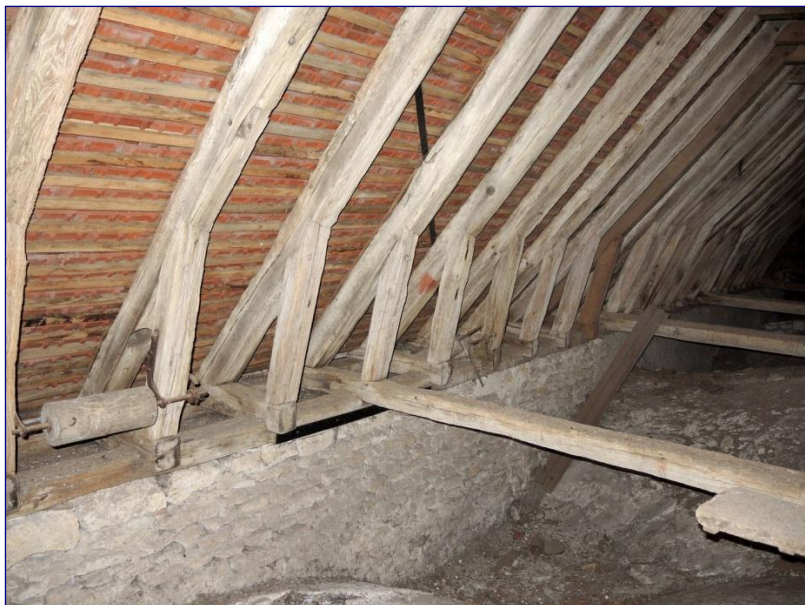
Fig. 8 : charpente est du chœur, pieds de fermes au sud
