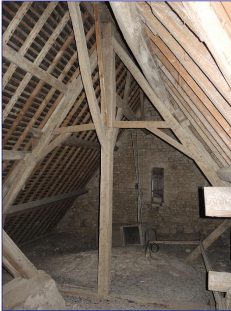
Charpente du collatéral, travée ouest
