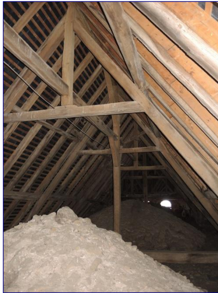
Intérieur de la nef vers l'ouest
