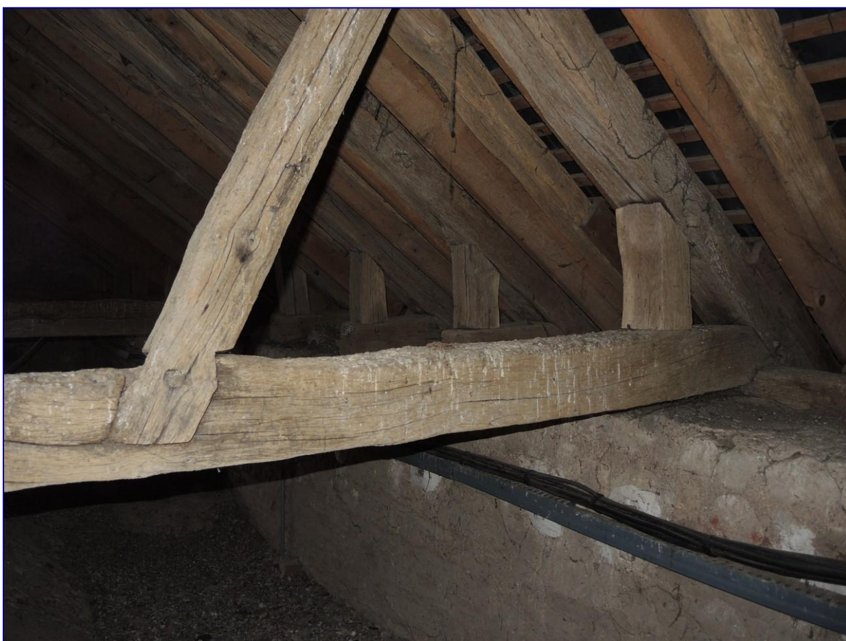
Fig. 9 : chœur, charpente du vaisseau central, ferme principale : contre-fiche assemblée à mi-bois avec l'entrait
