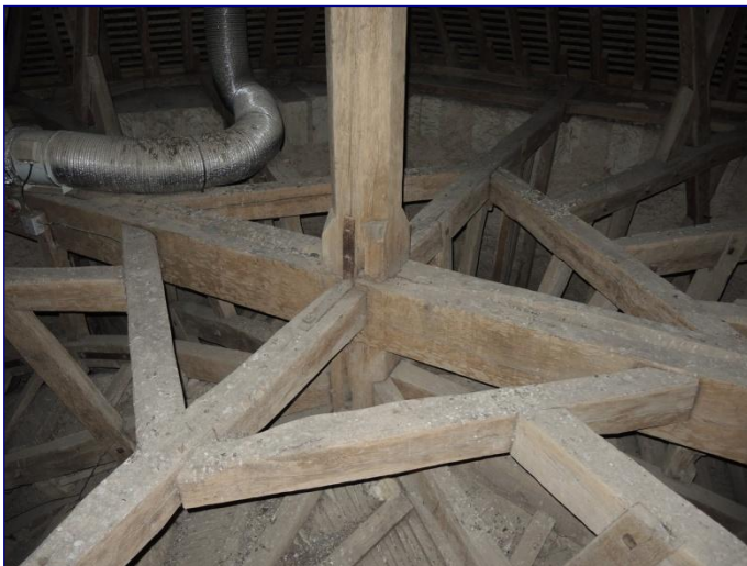
Charpente du chœur, détail de l'enrayure basse
