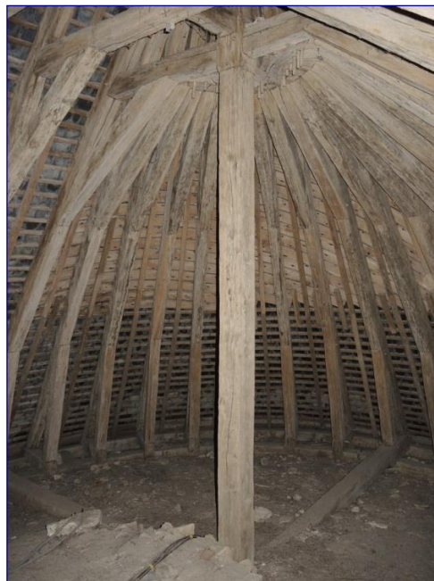
Fig. 6 : charpente de l'abside vers la croupe
