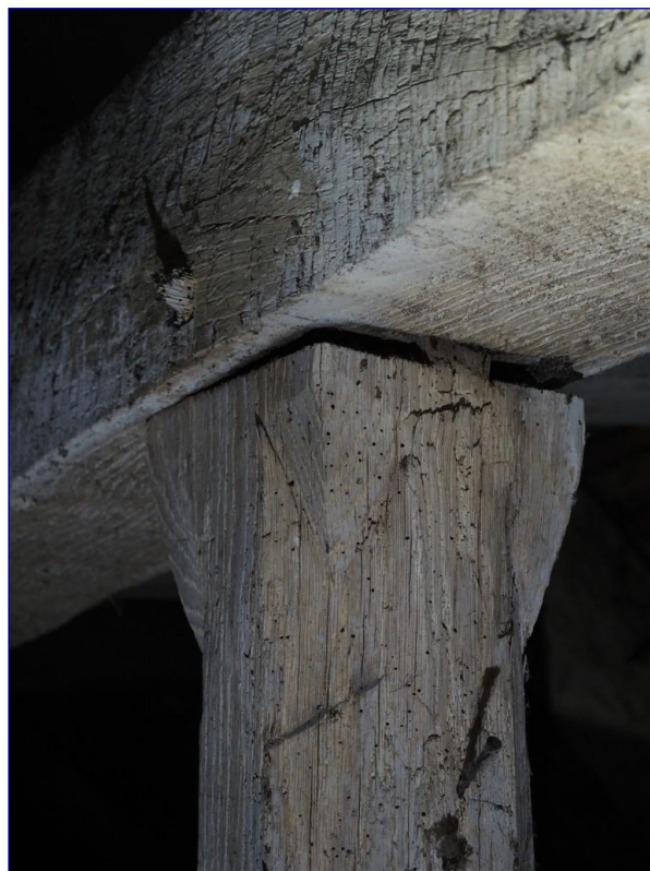
Fig. 20 : dispositif longitudinal, tête de poteau chanfreinée
