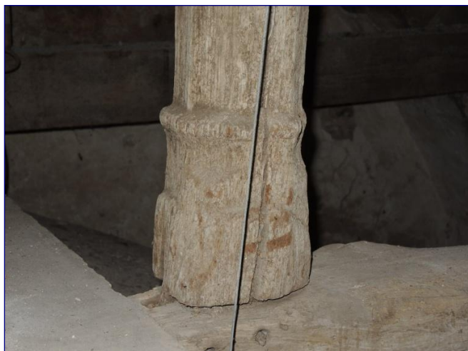
Fig. 11 : charpente de l'avant-chœur, base de poinçon
