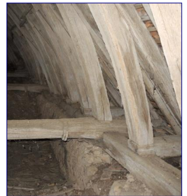
Structure est, pieds de ferme au nord
