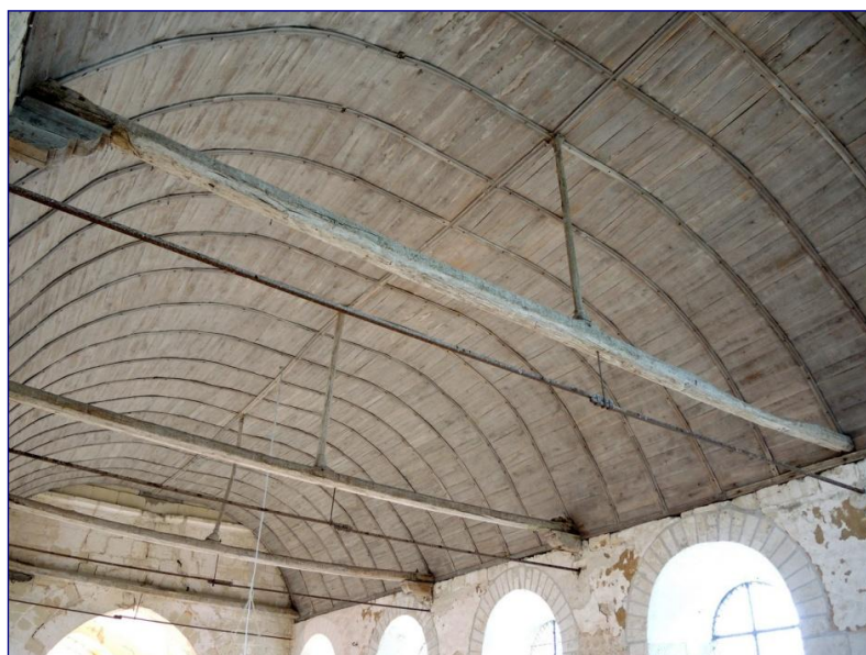
Fig. 5 : charpente apparente de la nef
