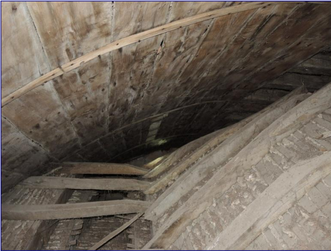
Charpente de la nef, ancien lambris et voûte en bois
