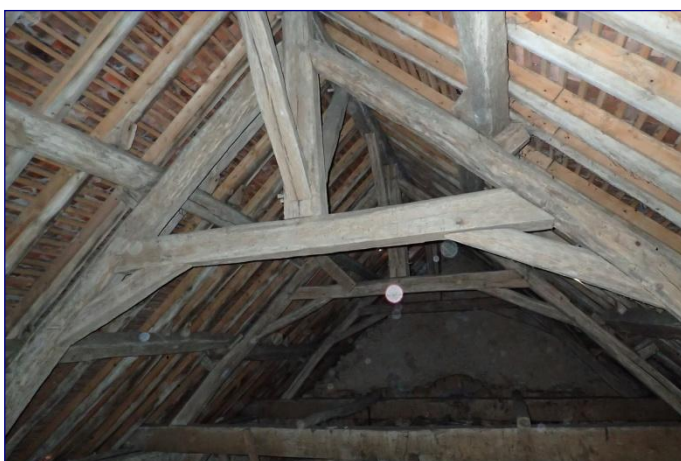
Charpente, vue générale vers l'ouest
