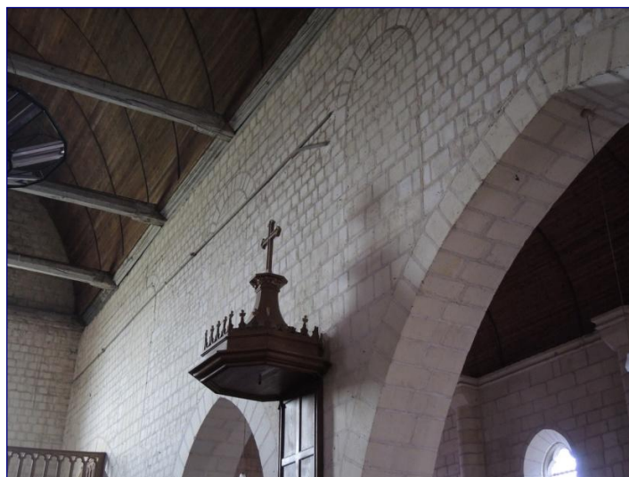
Fig. 4 : ancien mur gouttereau nord
