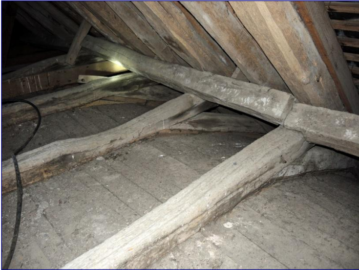
Fig. 11 : charpente de la nef, dessus des entrails retroussés
