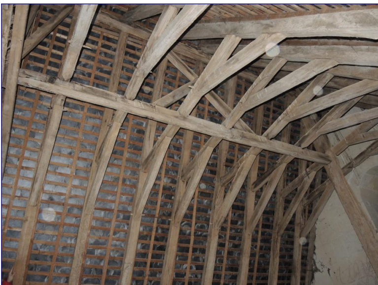
Fig. 15 : charpente du chœur, contreventement
