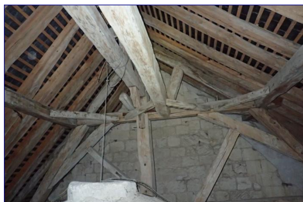
Charpente du chœur vers l'est
