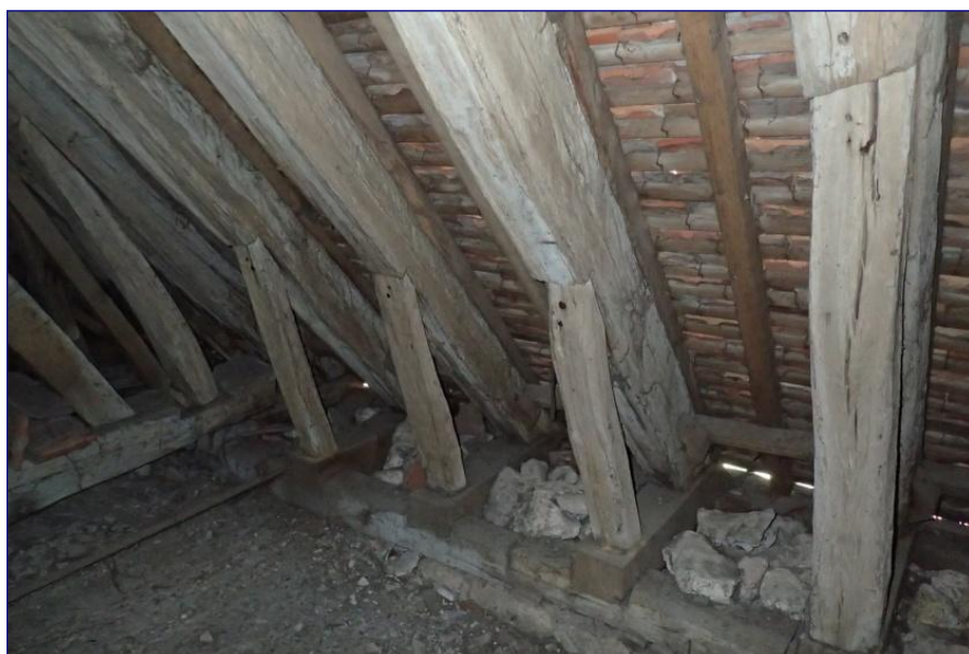
Fig. 10 : partie orientale de la charpente, pieds de fermes
