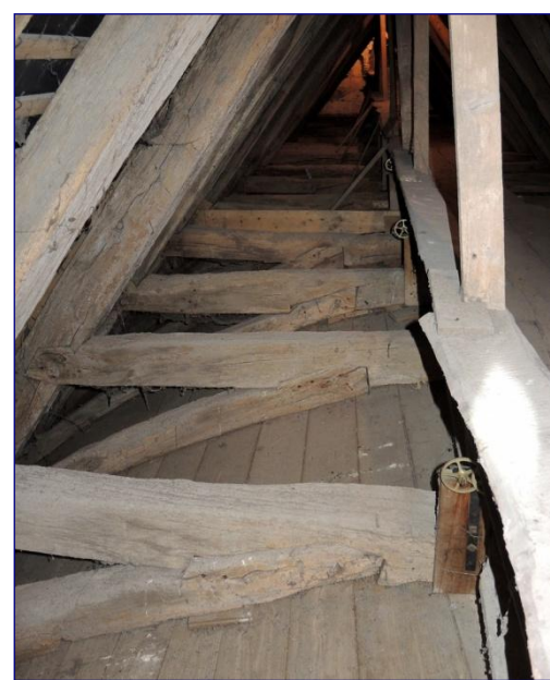
Fig. 7 : charpente de la nef, faux-entrails et aisseliers
