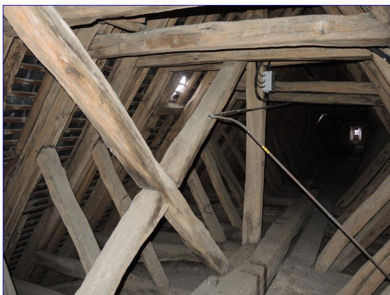
Fig. 12 : charpente du vaisseau principal, structure 2, vue générale vers l'ouest
