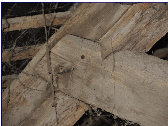
Fig. 10 : charpente de la nef, assemblage à mi-bois faux-entrait/chevron
