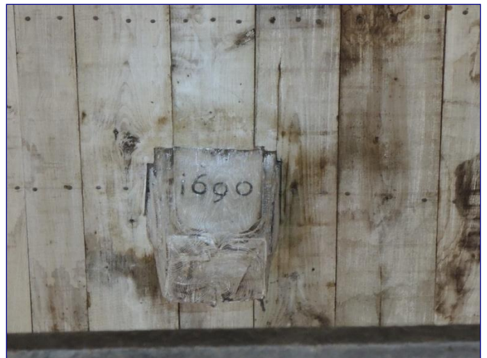
Charpente de la nef, clef pendante portant la date 1690
