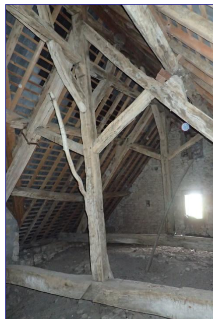
Charpente du chœur
