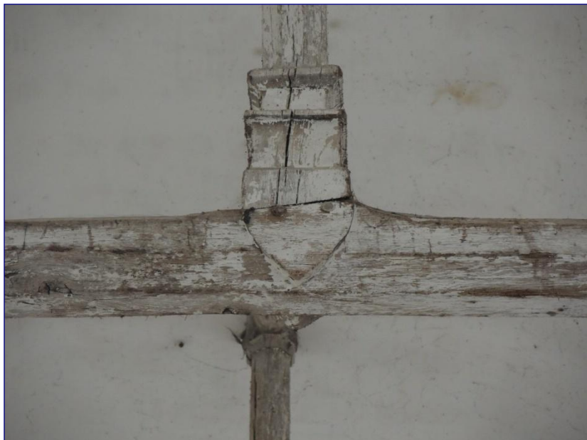
Base d'un poinçon tractant l'entrait décoré d'un écu
