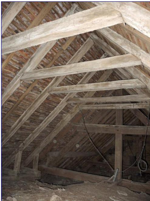
Charpente du chœur, travée est vers l'ouest
