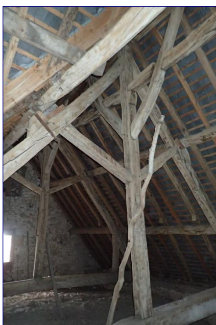
Charpente du chœur
