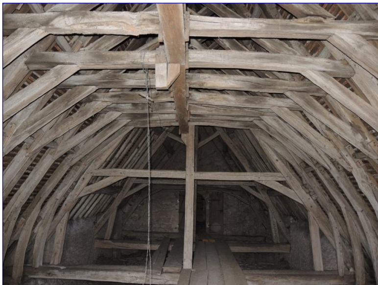
Fig. 6 : charpentes de la nef vers l'est
