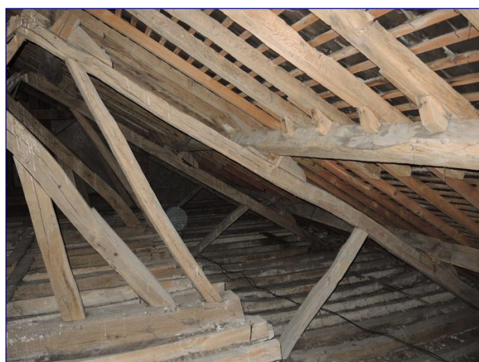
Charpente du collatéral
