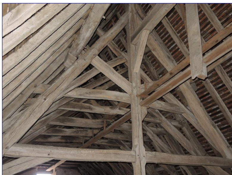
Fig. 9 : charpente de la nef, ferme de la structure est au premier plan
