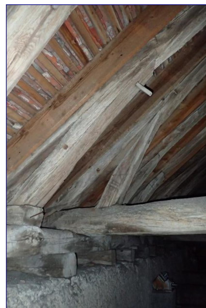
Fig. 11 : charpente des travées occidentales, détail de pieds de fermes
