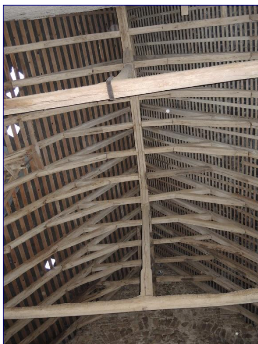
Charpente, vue générale
