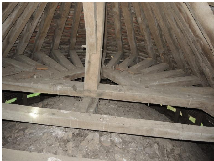
Charpente du chœur, enrayure de la croupe
