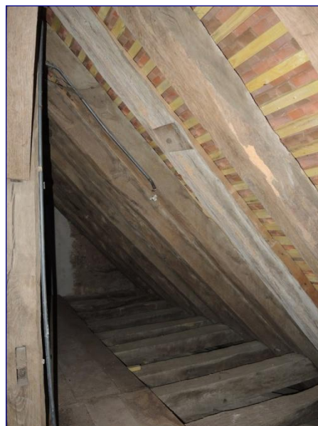
Charpente de la nef, chevron avec mi-bois
