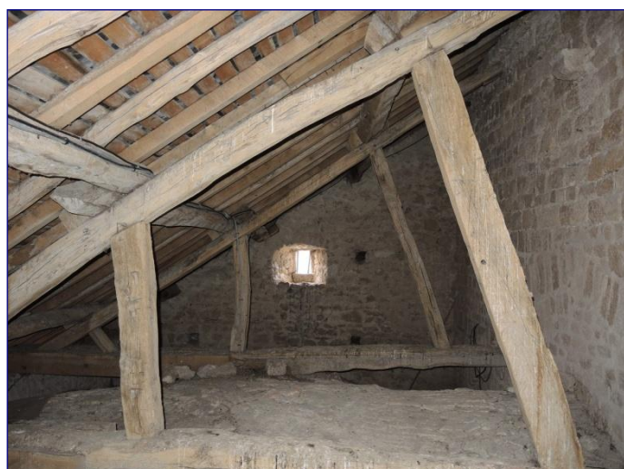
Fig. 22 : charpente en appentis du bas-côté sud
