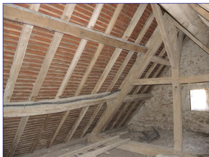
Fig. 12 : charpente du bras nord
