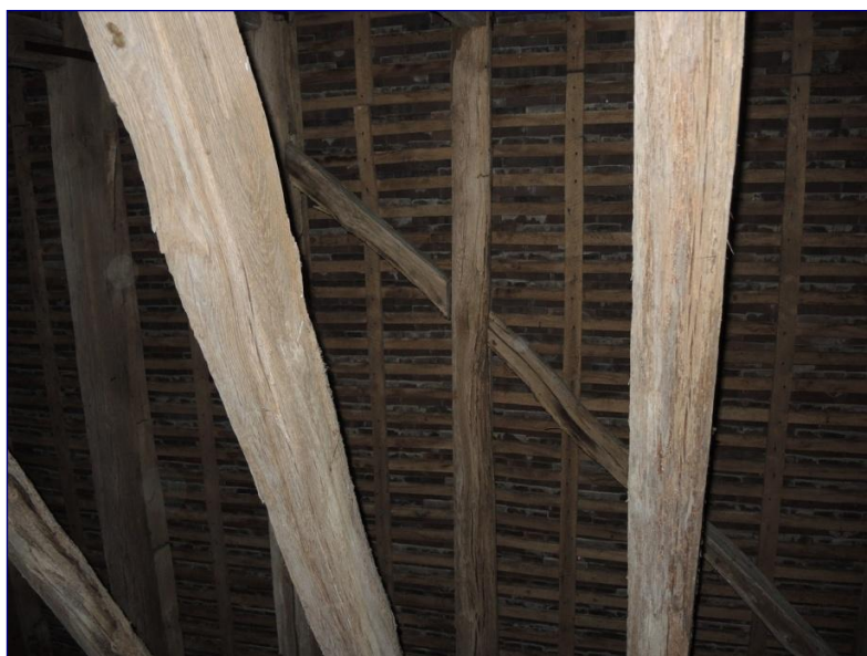
Fig. 10 : charpente de la nef, lisse de toiture entre les chevrons
