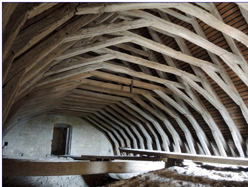
Fig. 6 : charpente des deux travées est du chœur, vue générale vers l'ouest
