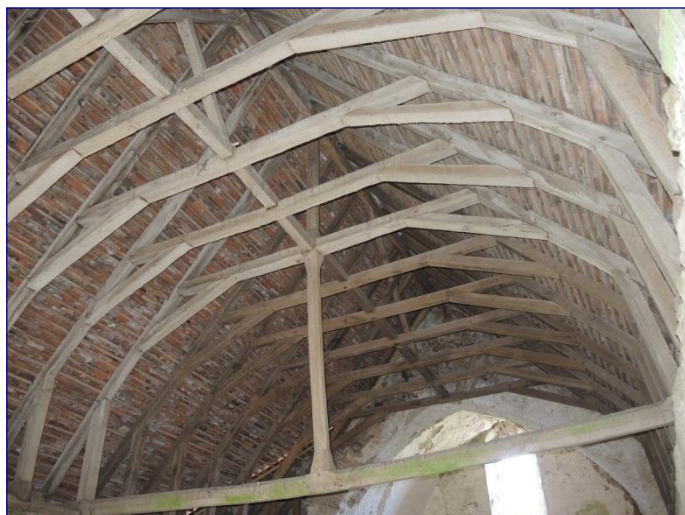
Charpente du vaisseau, partie ouest
