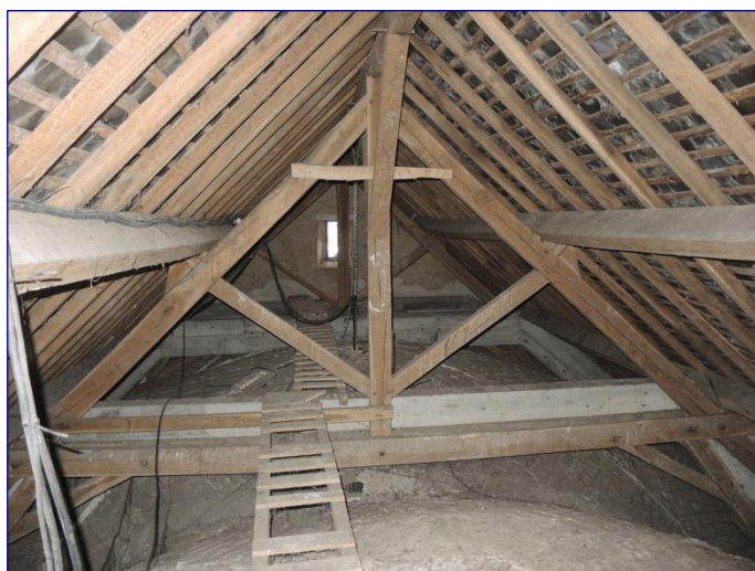
Charpente de la nef, vue vers l'est
