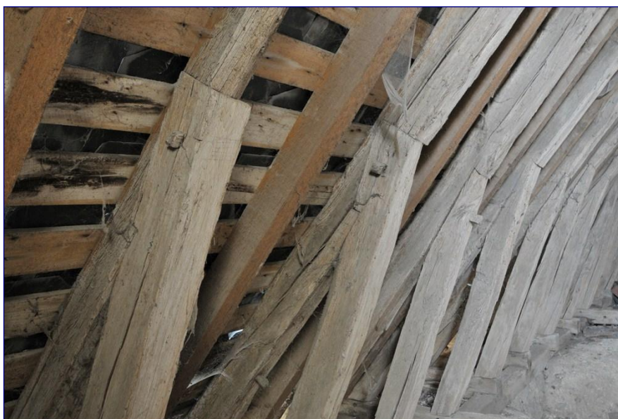
Fig. 8 : charpente de la nef, pieds de fermes au nord
