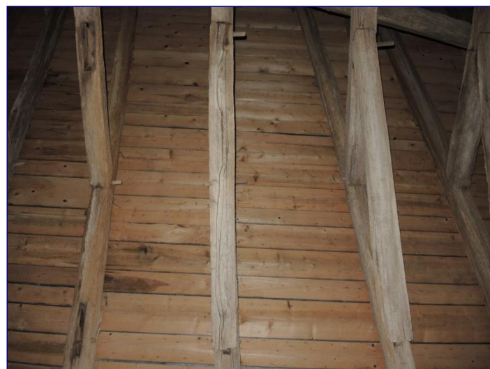
Lignages au noir en sous-face des aisseliers
