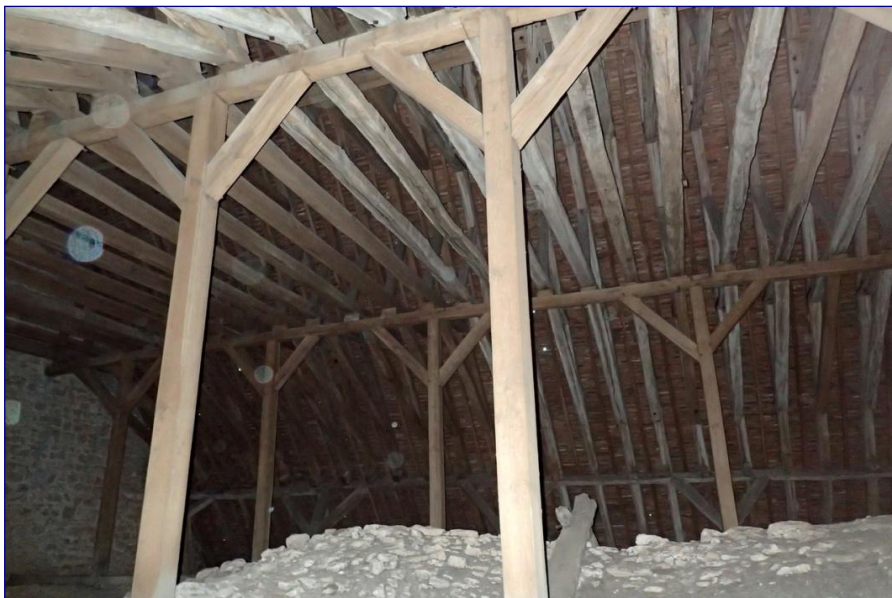
Fig. 8 : partie orientale de la charpente vers le nord
