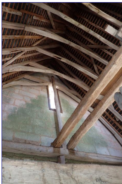
Charpente du clocher
