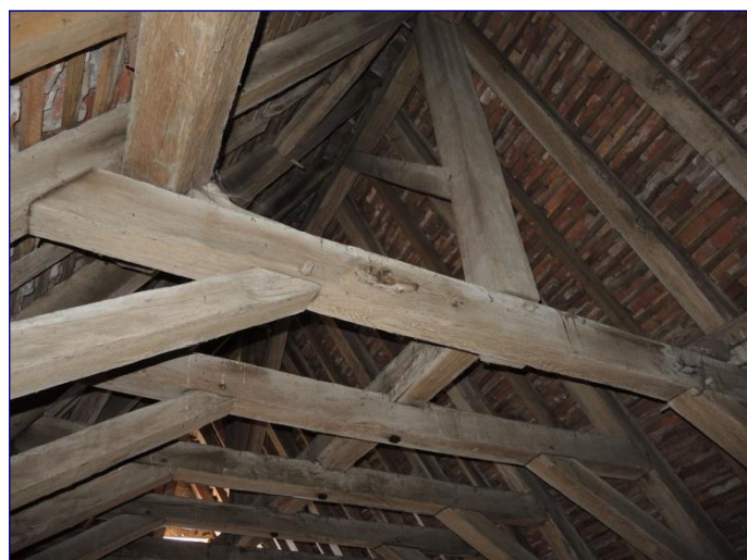
Fig. 15 : charpente de la chapelle sud, contreventement
