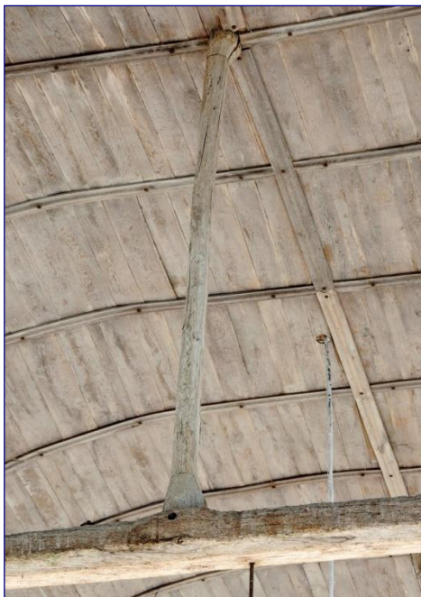
Fig. 6 : charpente de la nef, 3 ème suspente
