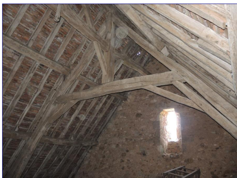
Charpente du chevet vers l'est
