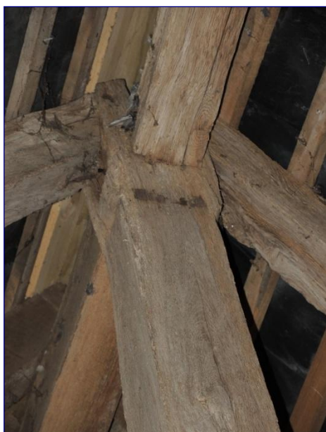
Charpente de la nef, tête de poinçon
