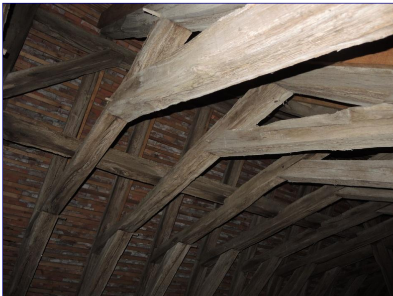
Fig. 13 : charpente orientale, contreventement
