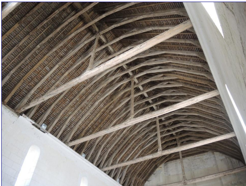
Fig. 8 : charpente de la nef, vue générale
