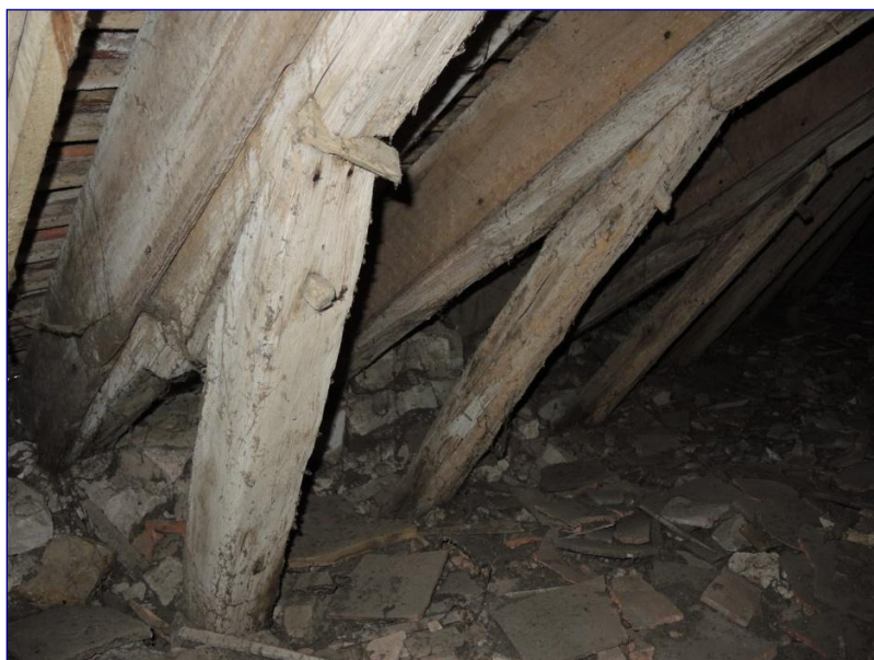
Fig. 10 : charpente de la nef, assemblage à embrèvement et à cheville transversale d'une jambette
