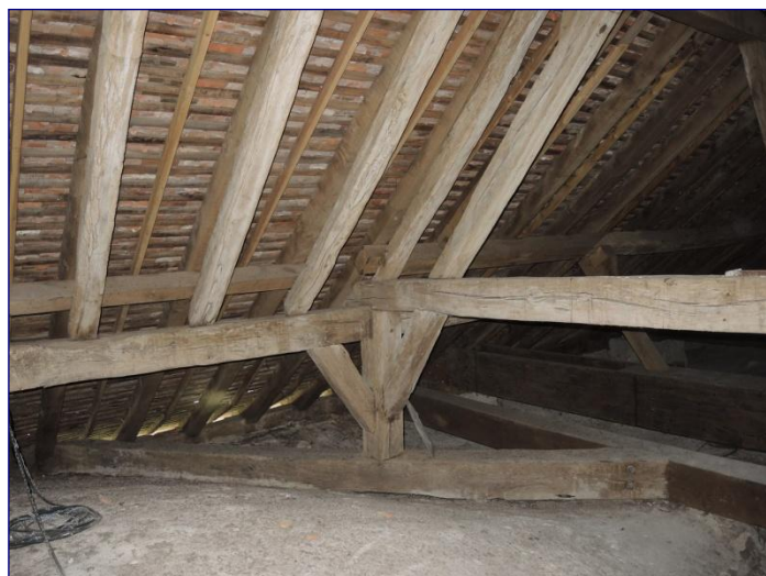
Fig. 15 : charpente du chœur, parties inférieures
