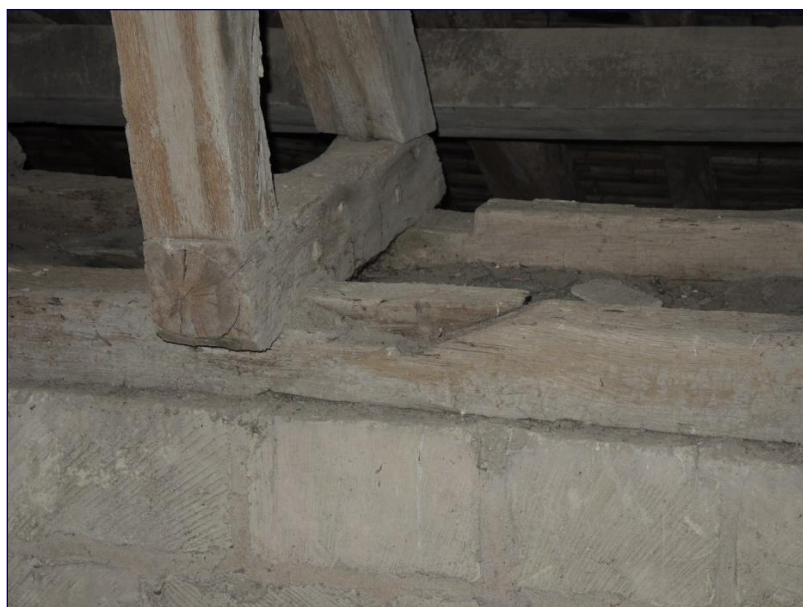
Fig. 11 : charpente du chœur, assemblage par enture oblique de la sablière interne
