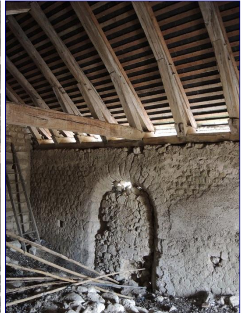
Arase du gouttereau nord
