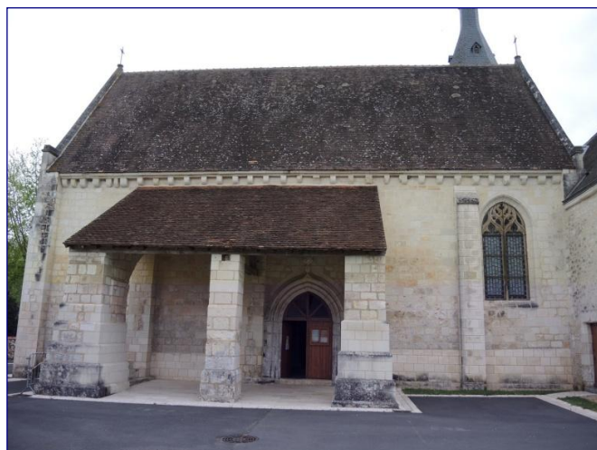
Fig. 2 : vue générale de la nef côté sud
