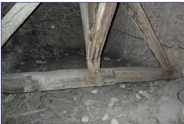
Collatéral sud, ferme ouest avec entrait en remploi (entailles)
