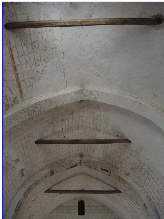
Fig. 6 : tirants insérés dans le berceau brisé de la nef
