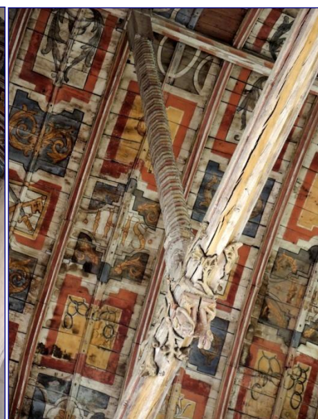
Charpente de la nef, détail d'un poinçon et d'un entrait sculptés
