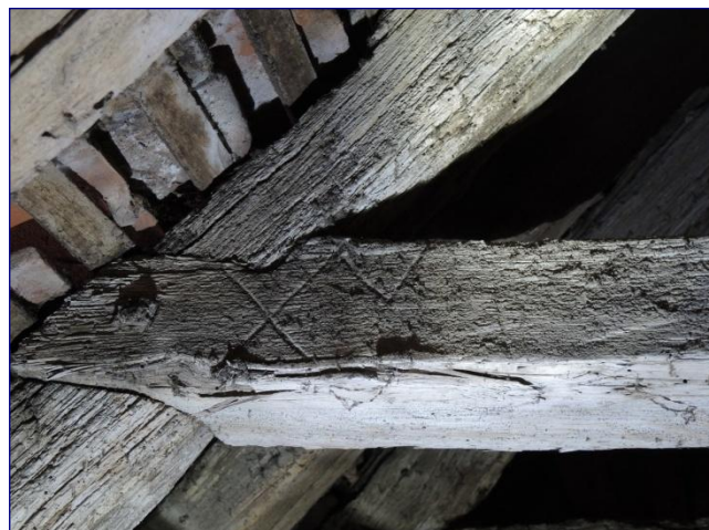
Fig. 12 : marque d'assemblage (15) et signe de latéralisation (I)
