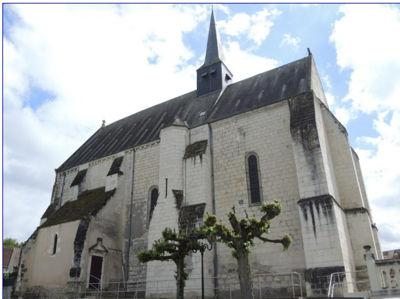
Fig. 1 : vue générale du mur gouttereau nord
