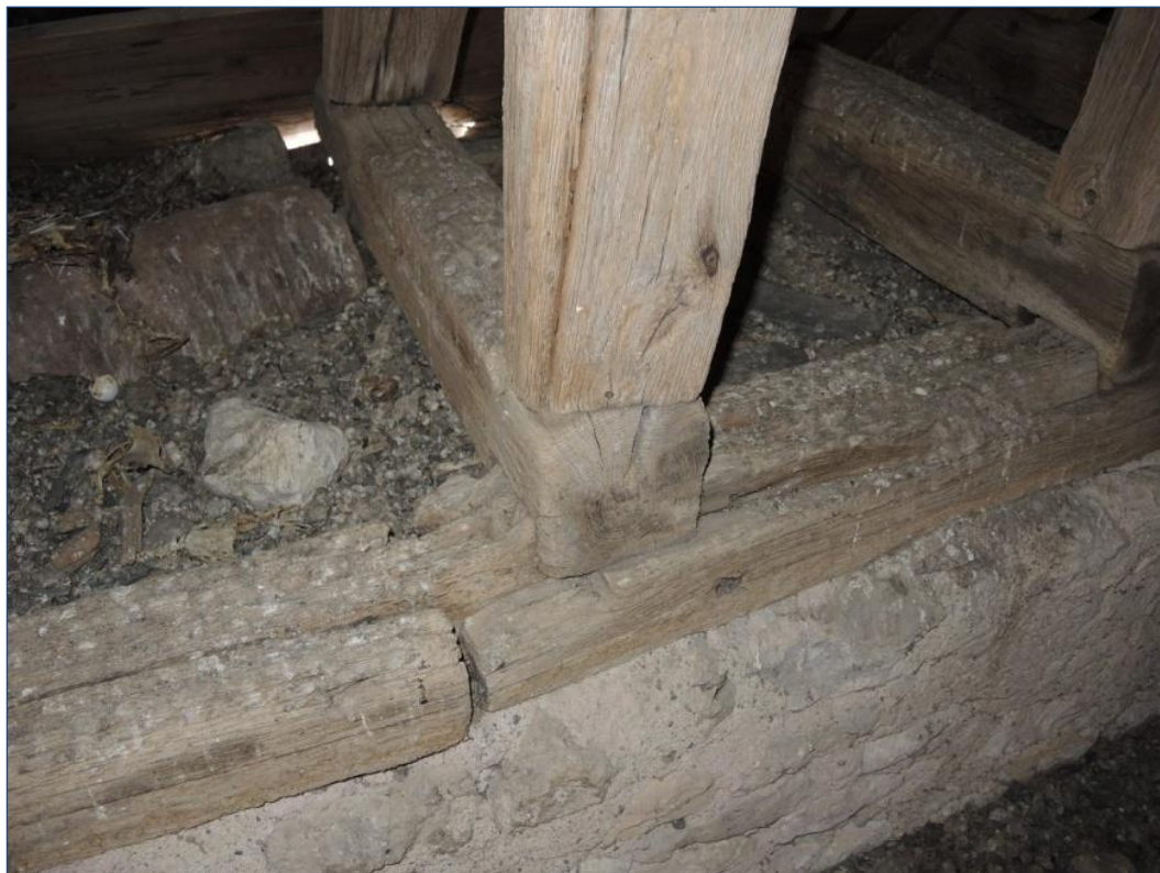
Fig. 9 : charpente du chœur, assemblage par enfourchement des sablières
