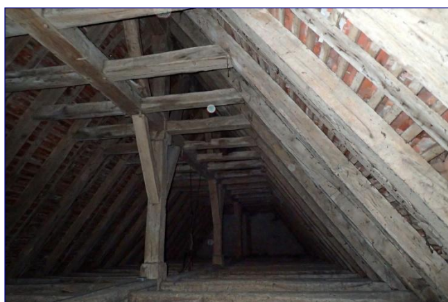
Charpente de la nef vers l'ouest
