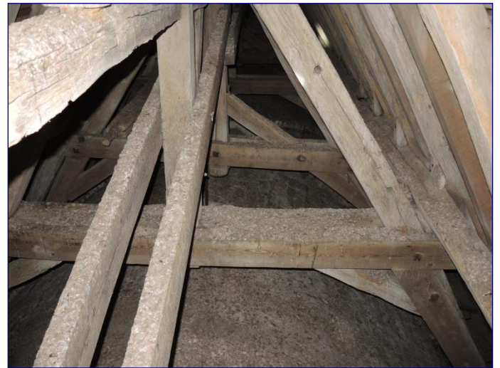
Charpente de la nef, au-dessous voûtes en brique
