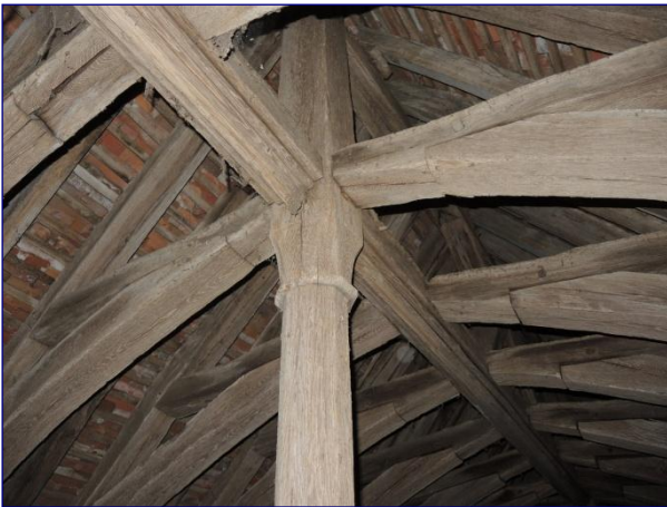
Structure est, détail d'un poinçon
