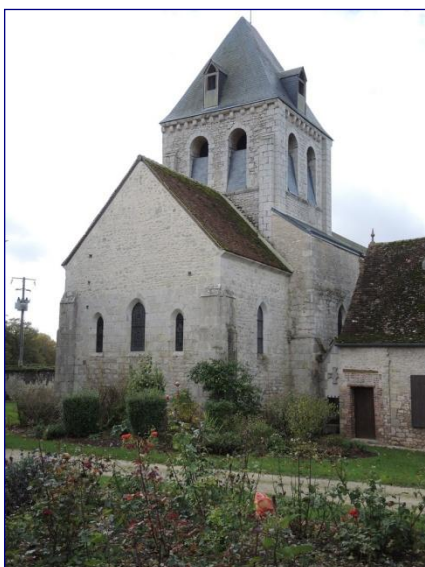
Structure ouest vers l'ouest
