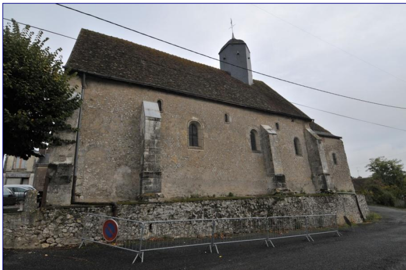
Fig. 1 : vue générale du mur gouttereau sud
