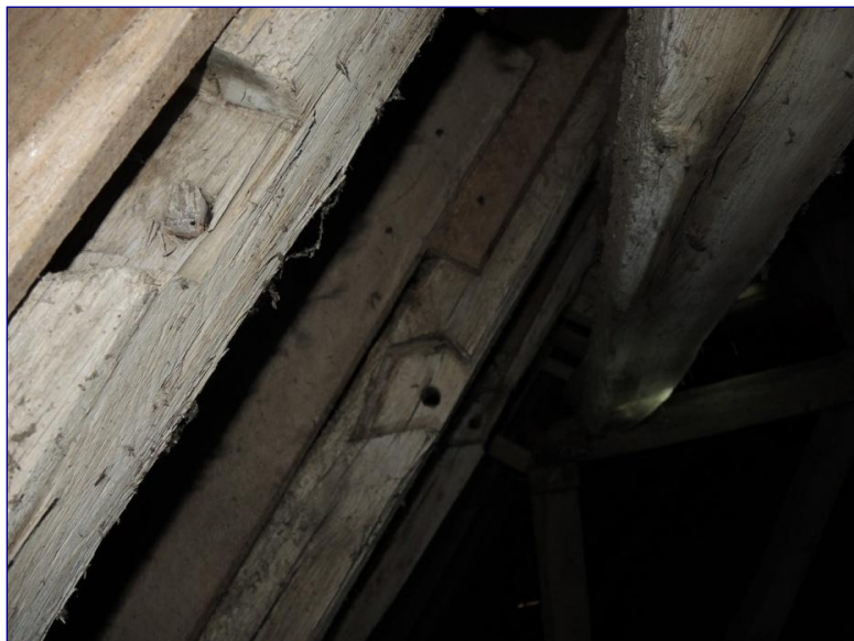
Fig. 11 : charpente de la nef, chevrons, encoches à mi-bois orphelines du 1 er niveau de faux-entrait
