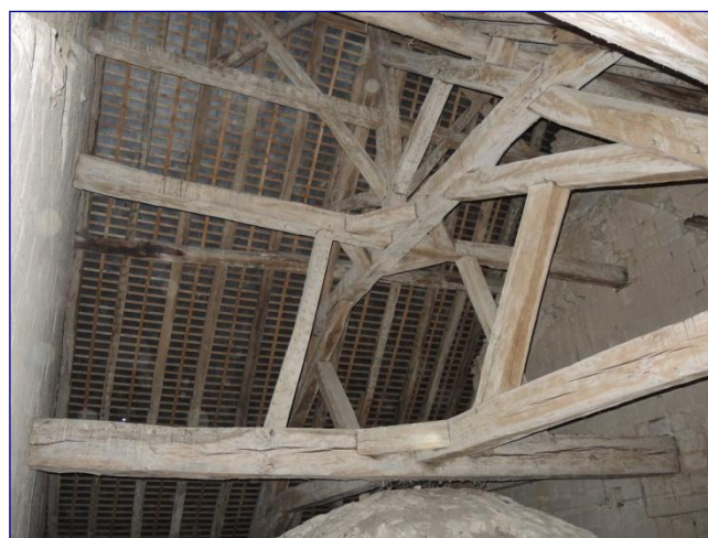
Charpente du chœur
