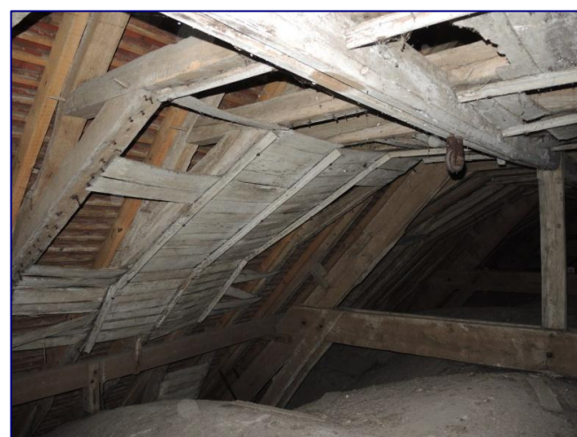
Fig. 6 : charpente de la nef, vestige de lambris
