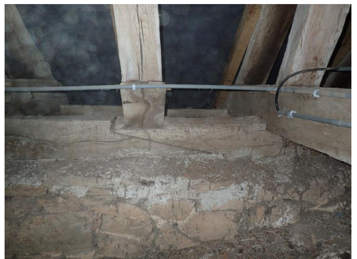
Charpente est, assemblage par enture des sablières
