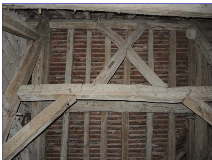
Charpente du chœur, contreventement
