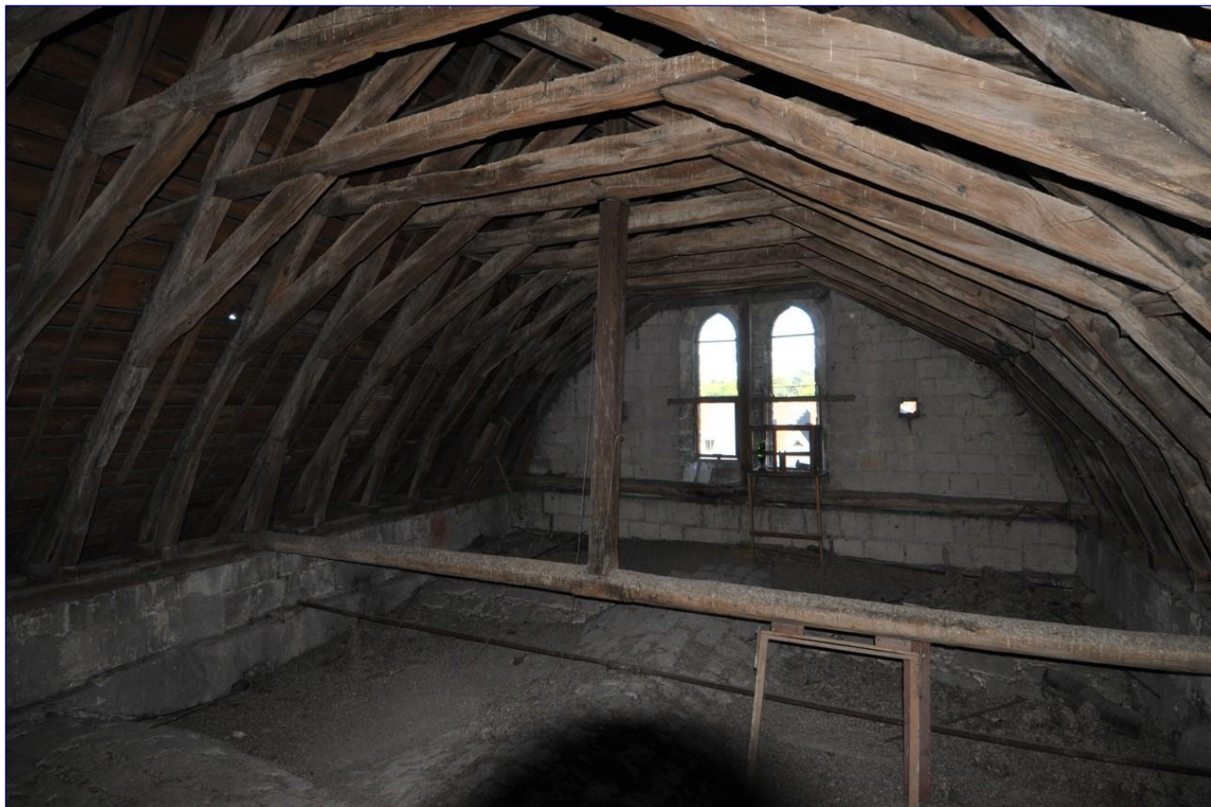
Fig. 7 : charpente du bras nord, vue générale vers le nord
