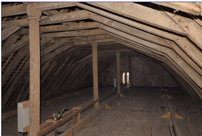
Charpente de la nef vers l'est
