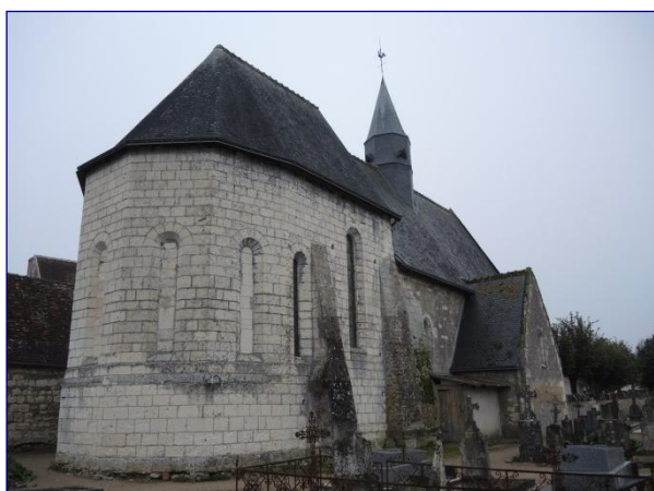
Charpente du chœur, croupe à l'est
