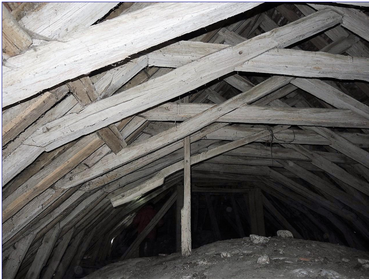
Fig. 5 : charpente, vue générale vers l'ouest
