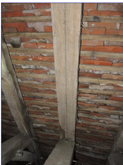
Charpente du chœur, lignage axial au noir sur chevron
