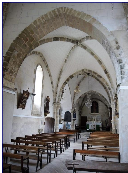
Vue intérieure du vaisseau unique vers l'est
