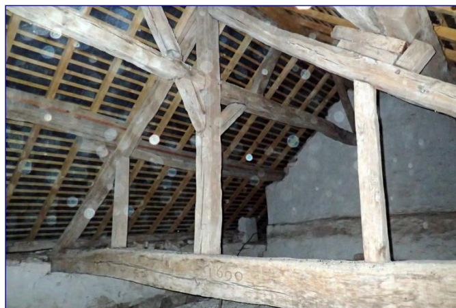
Charpente de la nef, entrain portant le millésime 1690
