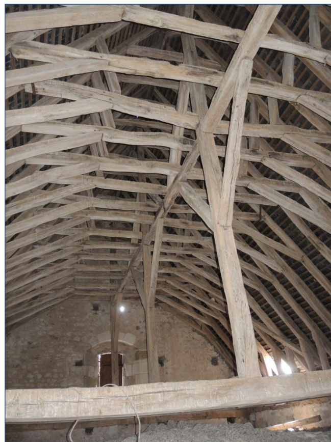
Fig. 7 : charpente du chœur vers l'est
