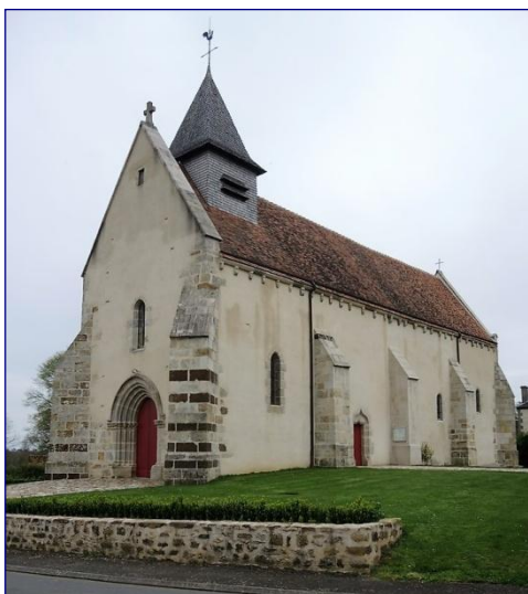
Vue générale vers le nord-est
