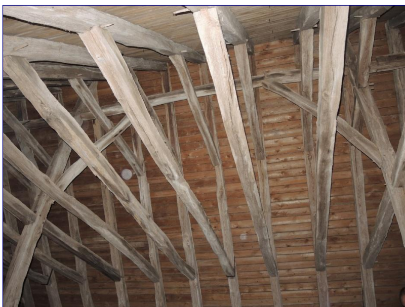
Fig. 9 : charpente de la nef, parties hautes
