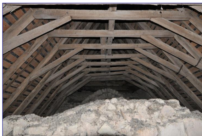
Fig. 16 : charpente du chœur, vue vers l'ouest
