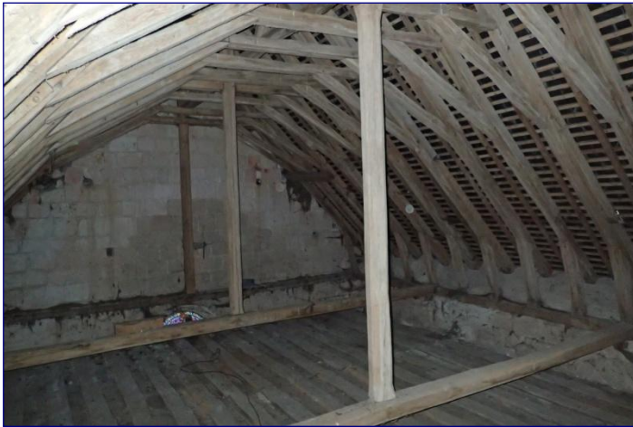
Charpente de la nef, vue générale vers l'ouest
