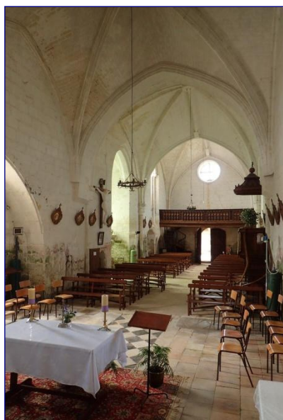
Intérieur de la nef vers l'ouest
