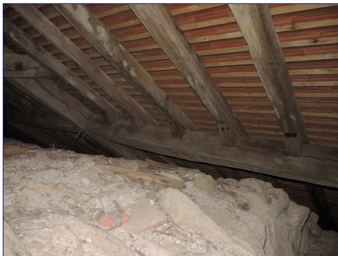
Charpente du collatéral nord, détail des entretoises entre les arbalétriers servant de pannes
