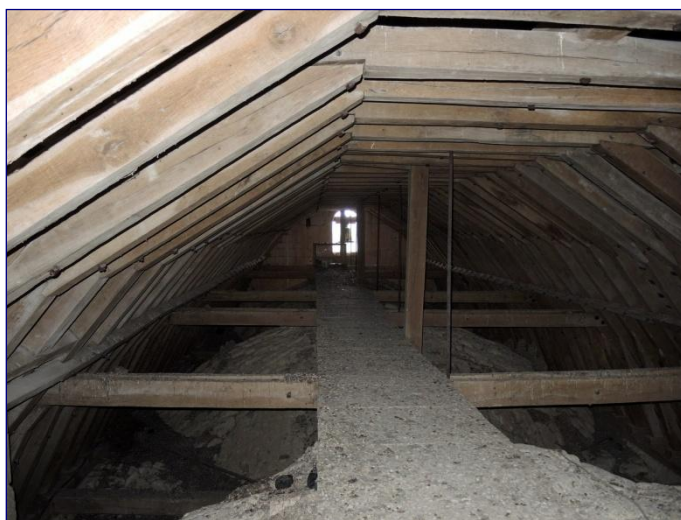
Charpente de la nef vers l'est
