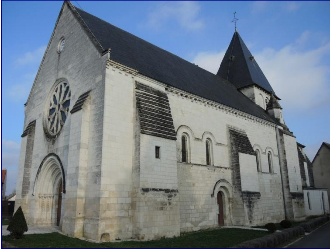
Vue générale de la nef depuis le sud-ouest
