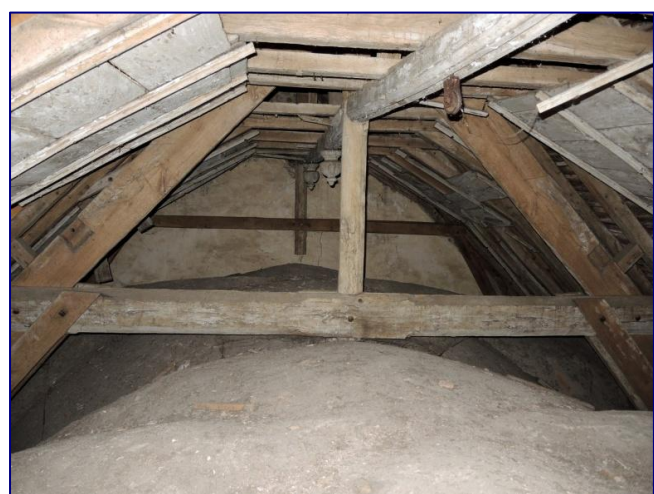
Fig. 5 : charpente de la nef vers l'ouest
