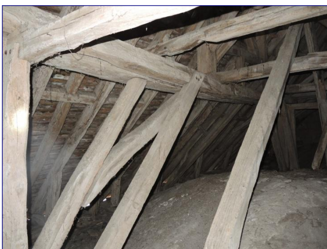
Fig. 13 : portique du beffroi enjambant la travée centrale
