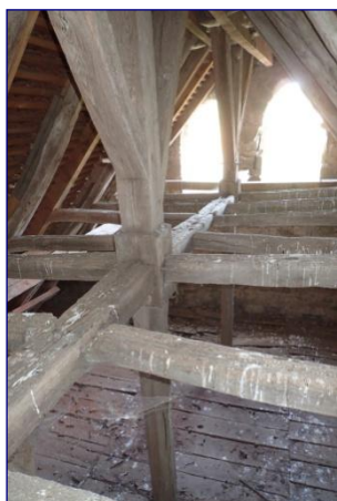
Charpente de la travée droite du chevet
