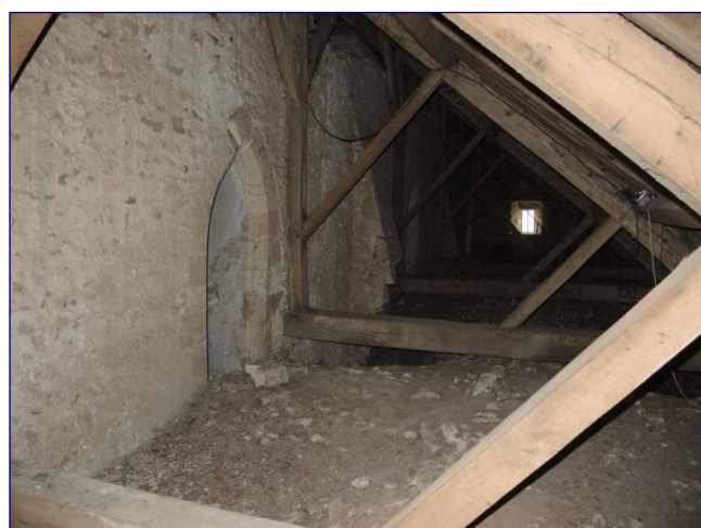
Charpente en appentis du collatéral nord
