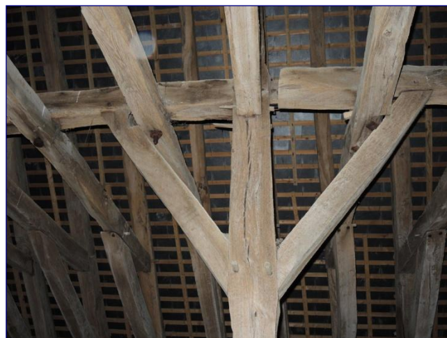
Charpente de la nef, détail d'un poinçon
