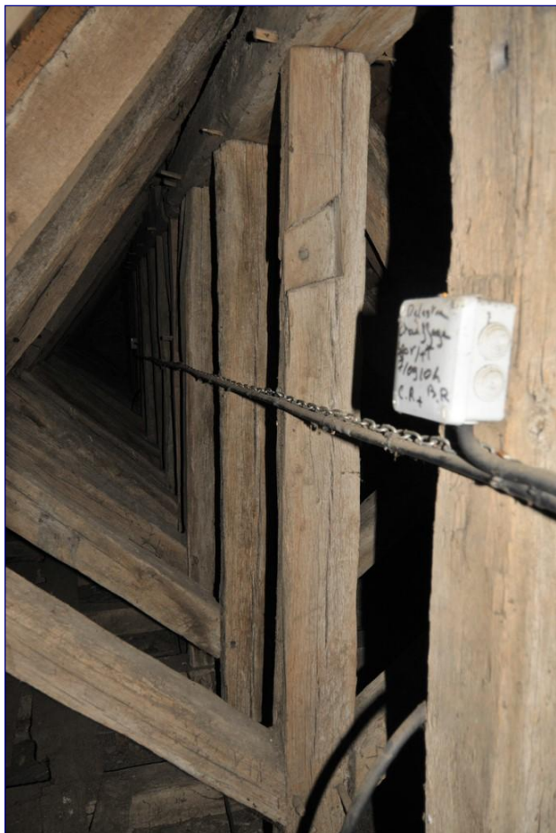
Fig. 5 : charpente de la nef, vue générale vers l'ouest
