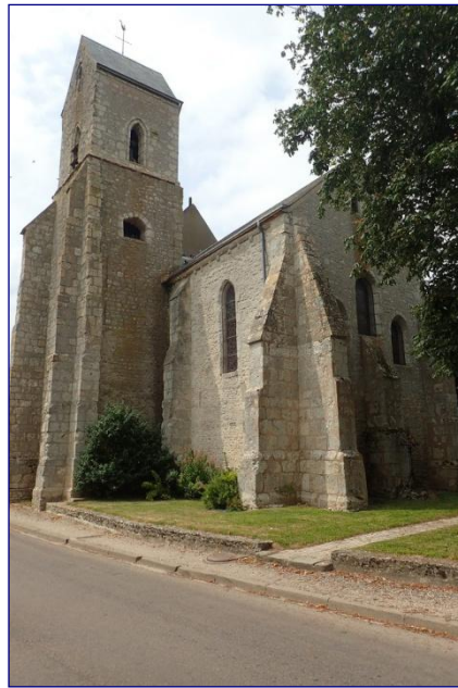
Vue du chevet depuis le sud-est
