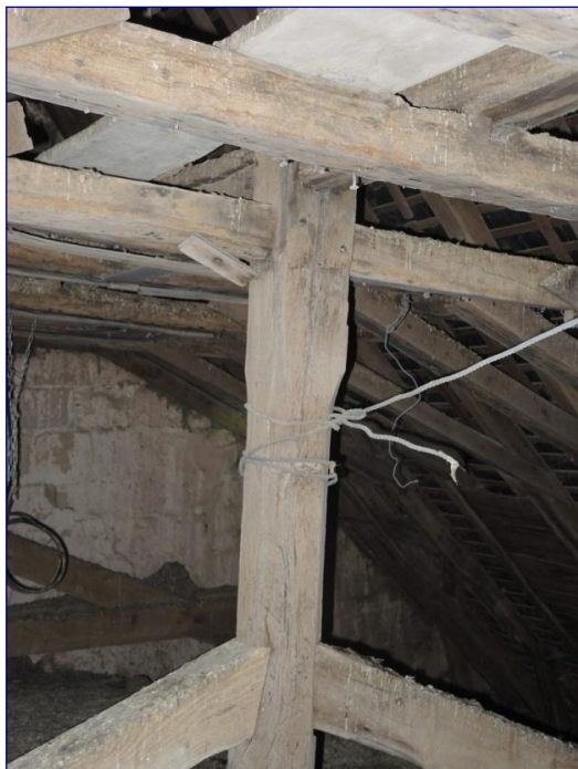
Fig. 7 : charpente de la nef, tête de poinçon d'une ferme principale
