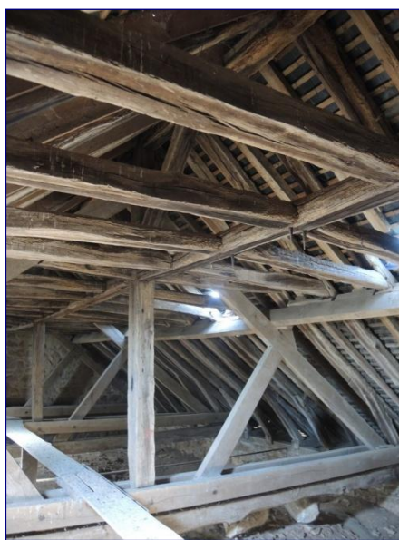
Charpente de la nef vers l'est
