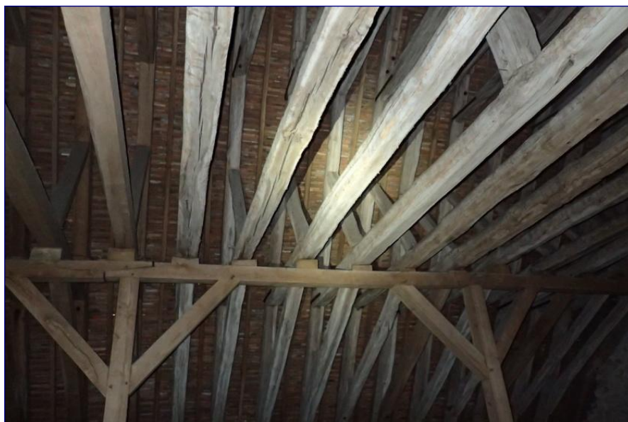
Fig. 9 : partie orientale de la charpente
