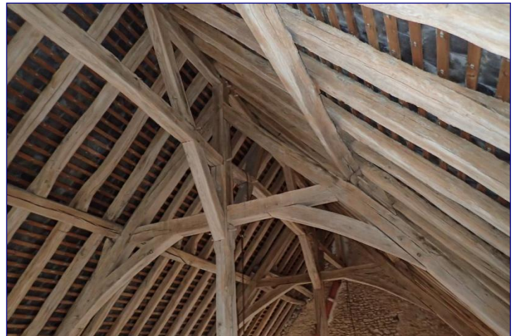
Charpente de la nef, ferme n° 2 et contreventement
