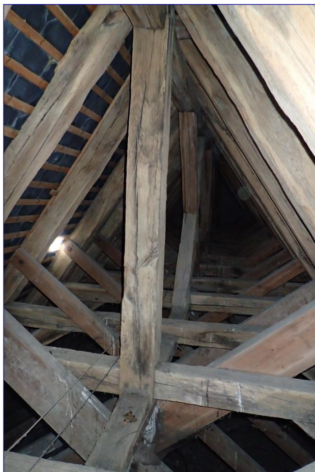
Fig. 6 : charpente de la nef, contreventement
