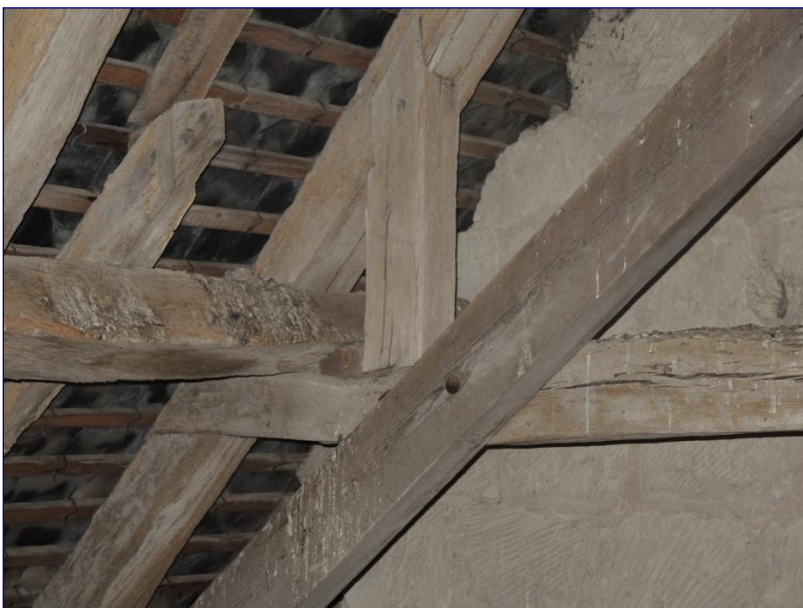
Fig. 12 : charpente du chœur, panne bloquée par un potelet assemblé à mi-bois au faux-entrait et aux chevrons
