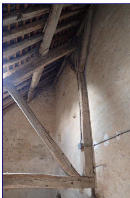
Charpente du collatéral nord
