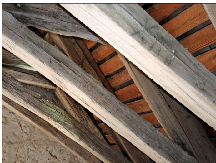
Fig. 10 : charpente du chœur, marquage des aisseliers 17 à 19
