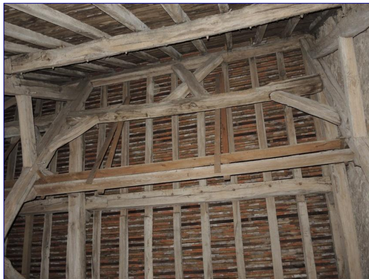
Fig. 14 : charpente de la nef, structure est, contreventement
