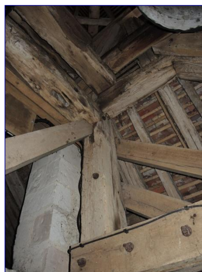
Fig. 18 : beffroi, cage des cloches, tête de poteau
