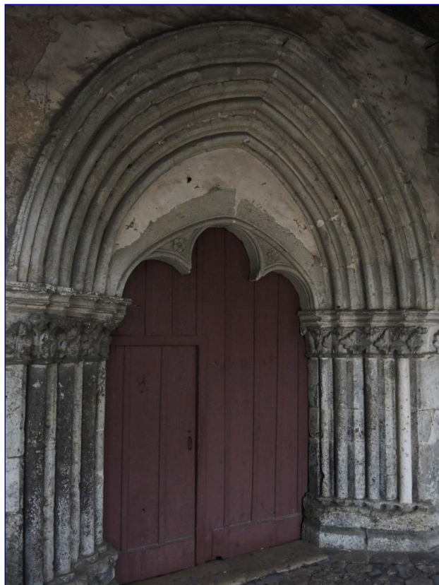
Fig. 4 : façade occidentale, portail central
