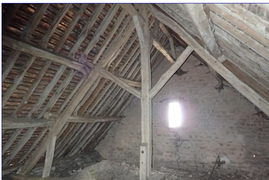
Ferme orientale de la charpente
