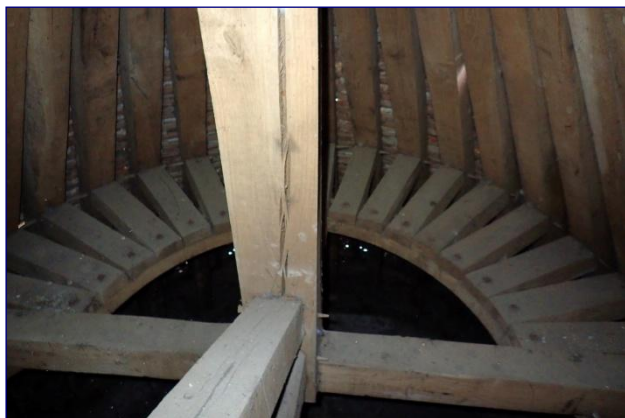
Charpente du chœur, enrayure haute de la croupe
