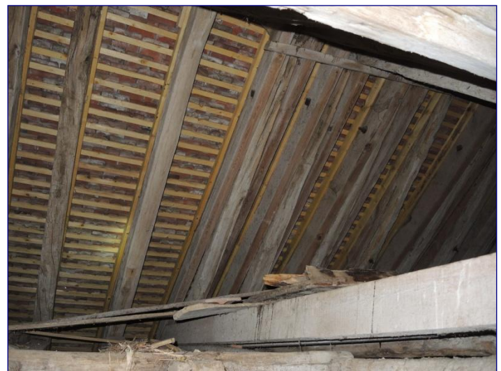
Charpente de la nef, chevronnage
