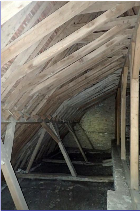
Fig. 3 : partie orientale de la charpente, travée sud vers l'ouest
