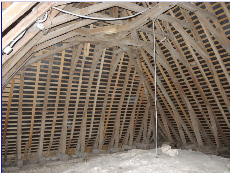
Fig. 9 : charpente du chœur, croupe à l'est
