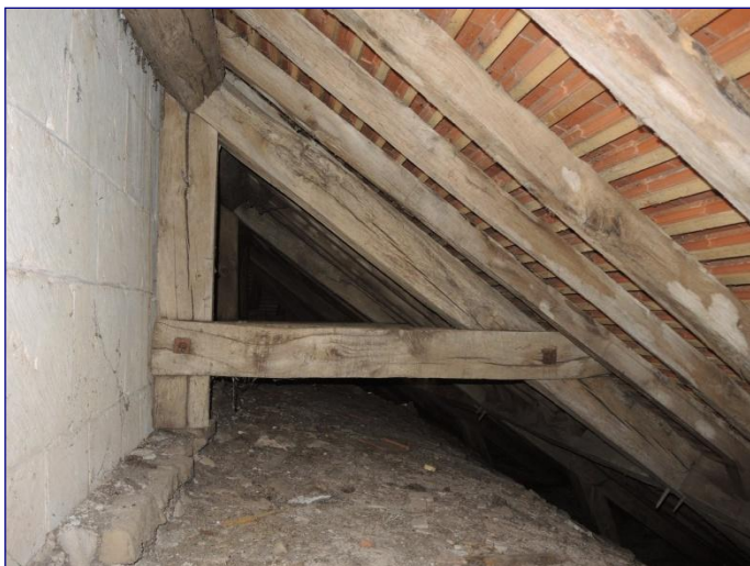
Charpente du collatéral nord
