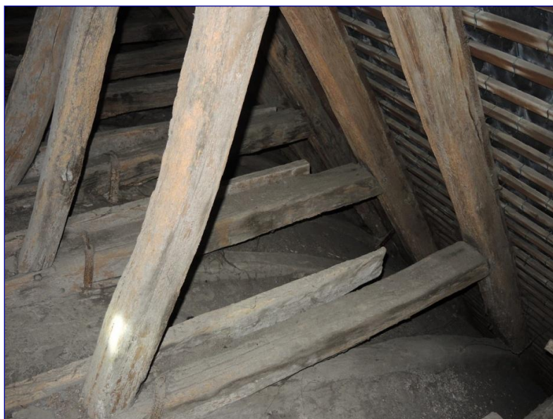
Fig. 11 : charpente du vaisseau principal, structure 1, aisseliers courbes reliant faux-entrâits et chevrons
