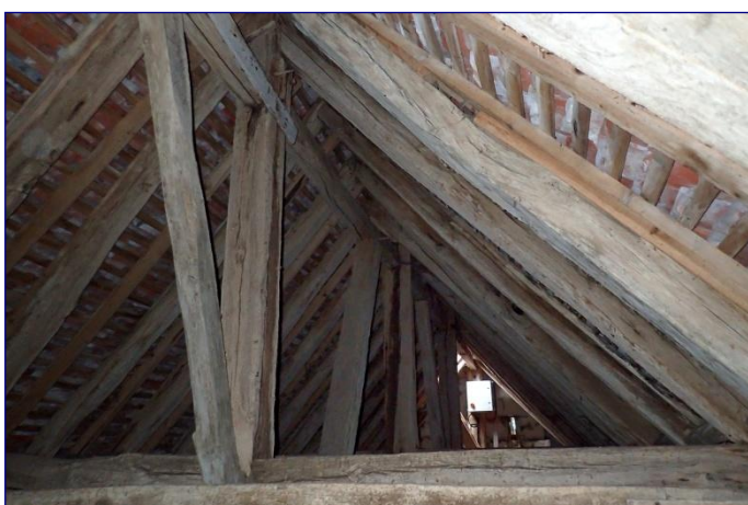
Charpente de la nef, contreventement
