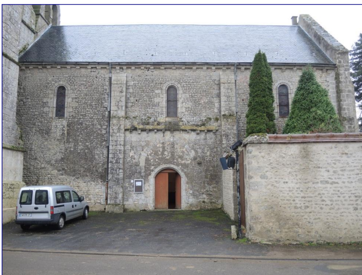
Fig. 3 : vue de la nef côté nord
