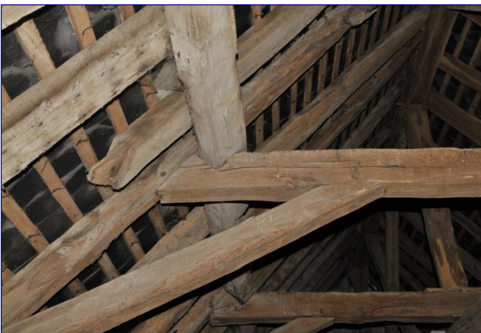
Charpente est de la nef, insertion de la panne dans le faux-entrait
