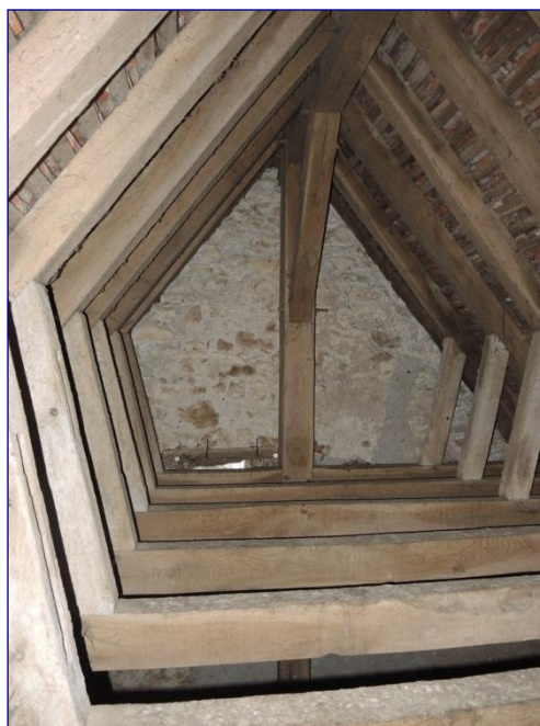
Charpente de la chapelle sud
