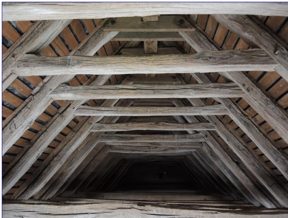
Fig. 7 : charpente du chœur, entre les deux niveaux de faux-entrails
