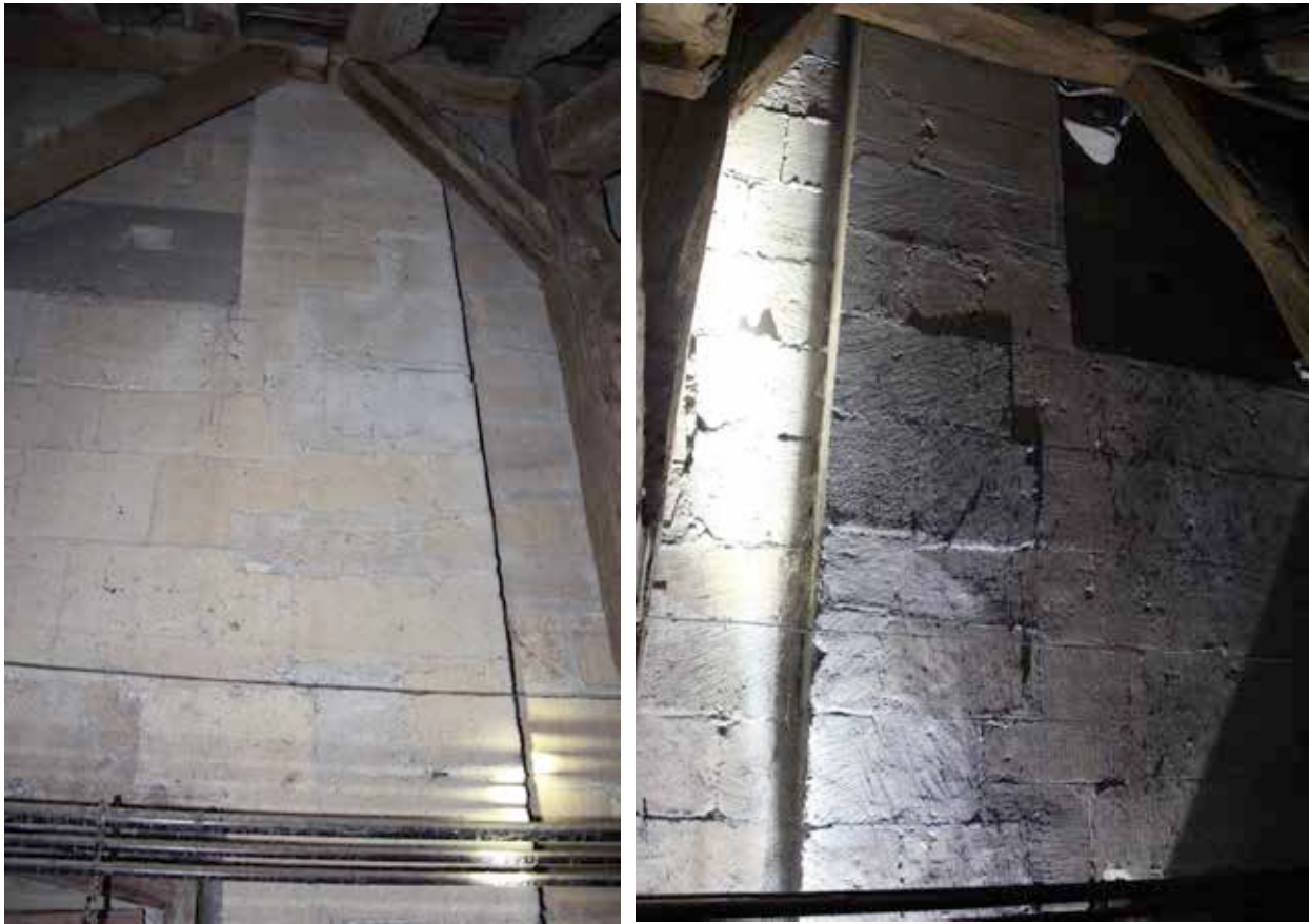
III. 5 — Déambulatoire : césure entre les maçonneries des deux campagnes du chevet. À g., mur sud, à dr., mur nord (cl. F. Épaud, CNRS ; S. Aumard, CEM).
