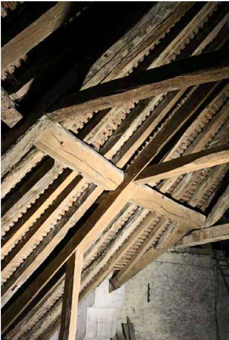
Ill. 15 — Déambulatoire, travée 16 : panne courbe de section trapézoïdale (cl. F. Épaud, CNRS).
