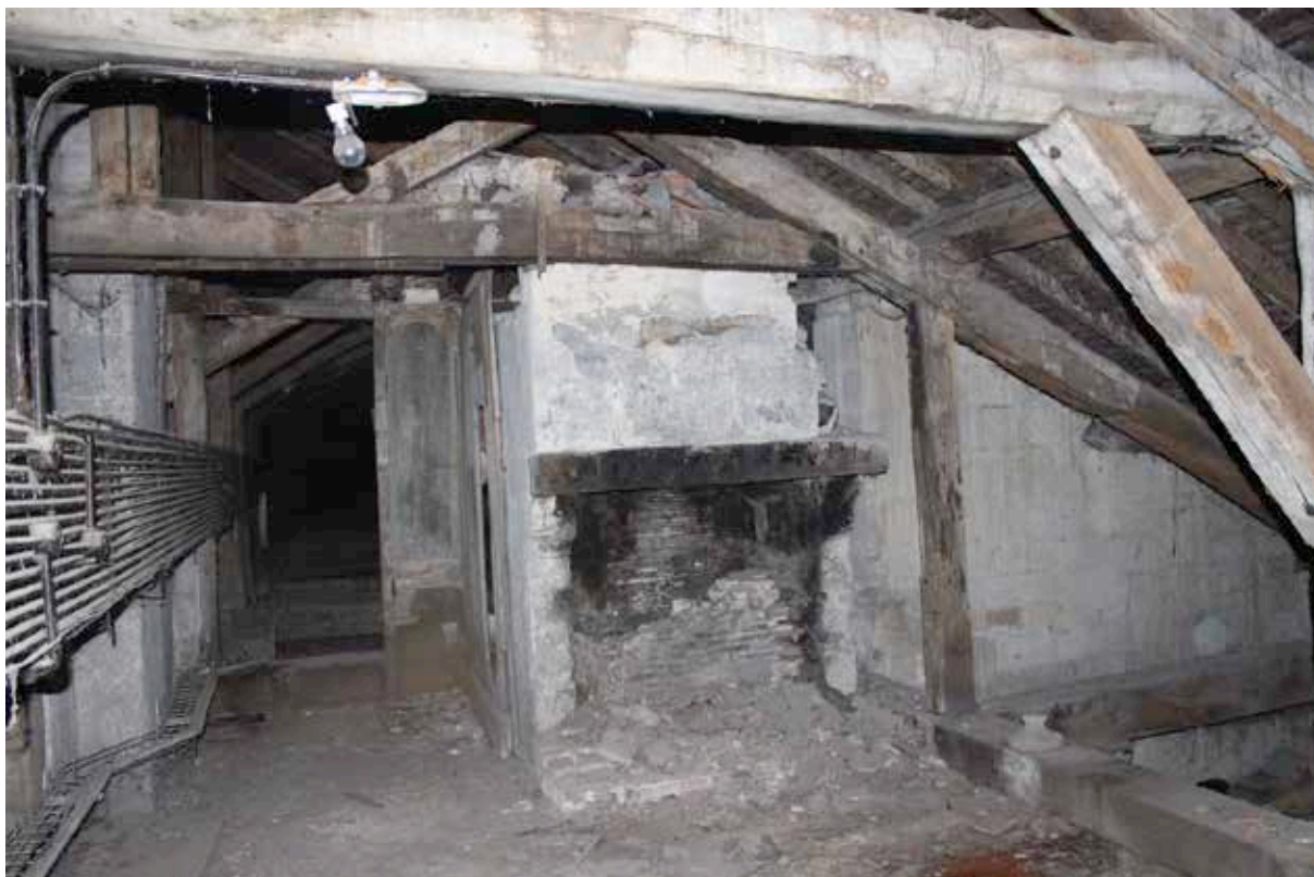
III. 74 — Nef, collatéral sud : vestiges d'un logement d'habitation (sonneur de cloche ?), cheminée et boiseries (cl. S. Aumard, CEM).
