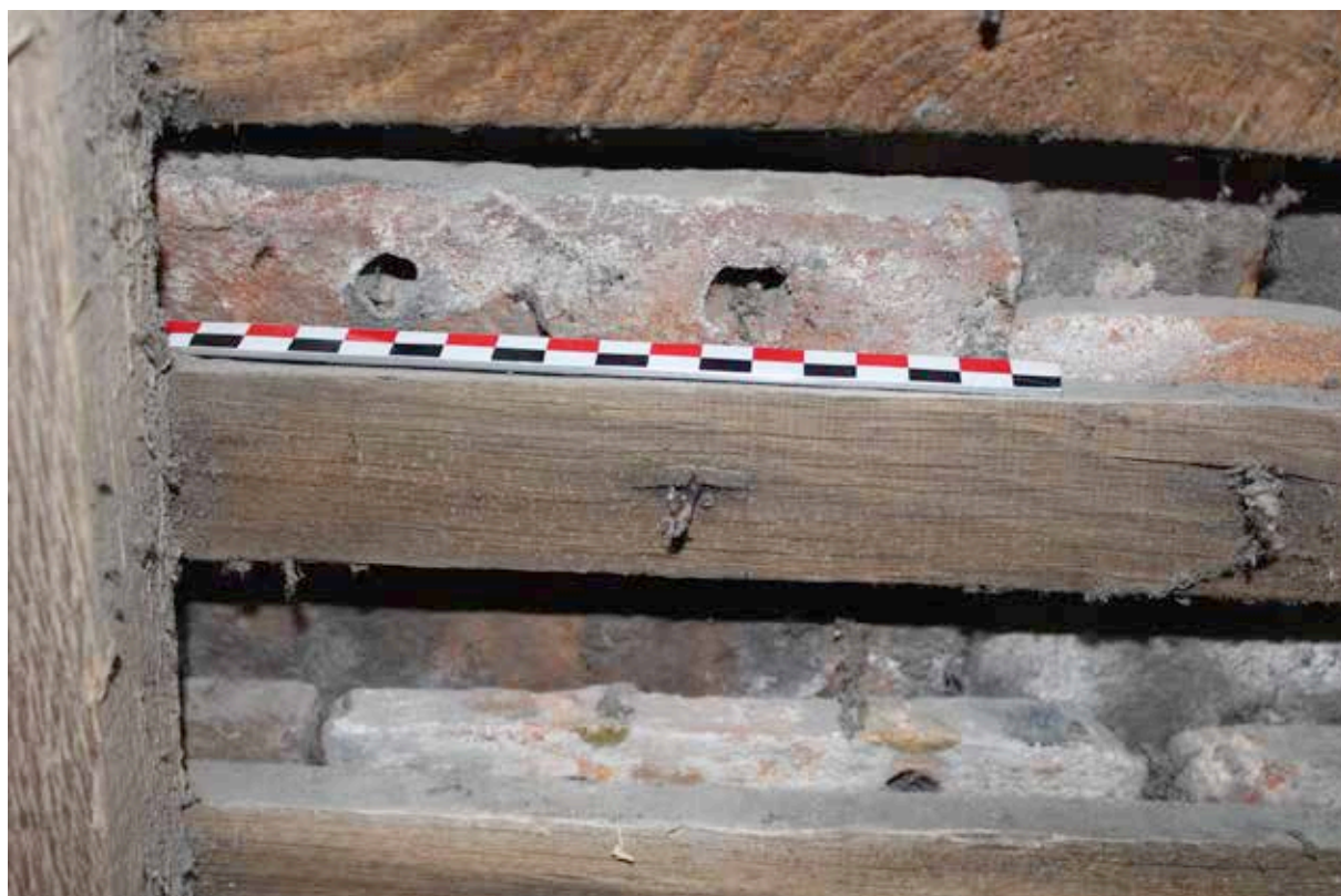
III. 70 — Nef, versant nord : tuiles médiévales sans crochet à deux perforations (cl. S. Aumard, CEM).
