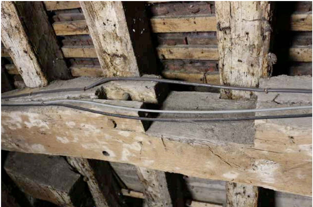
III. 35 — Déambulatoire, travée 6 : bois 6, détail d'assemblage (cl. F. Épaud, CNRS).
