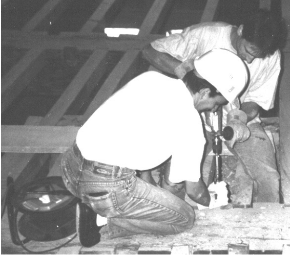
Photo 1 (Lavier) : Prélèvement à la tarière électrique
