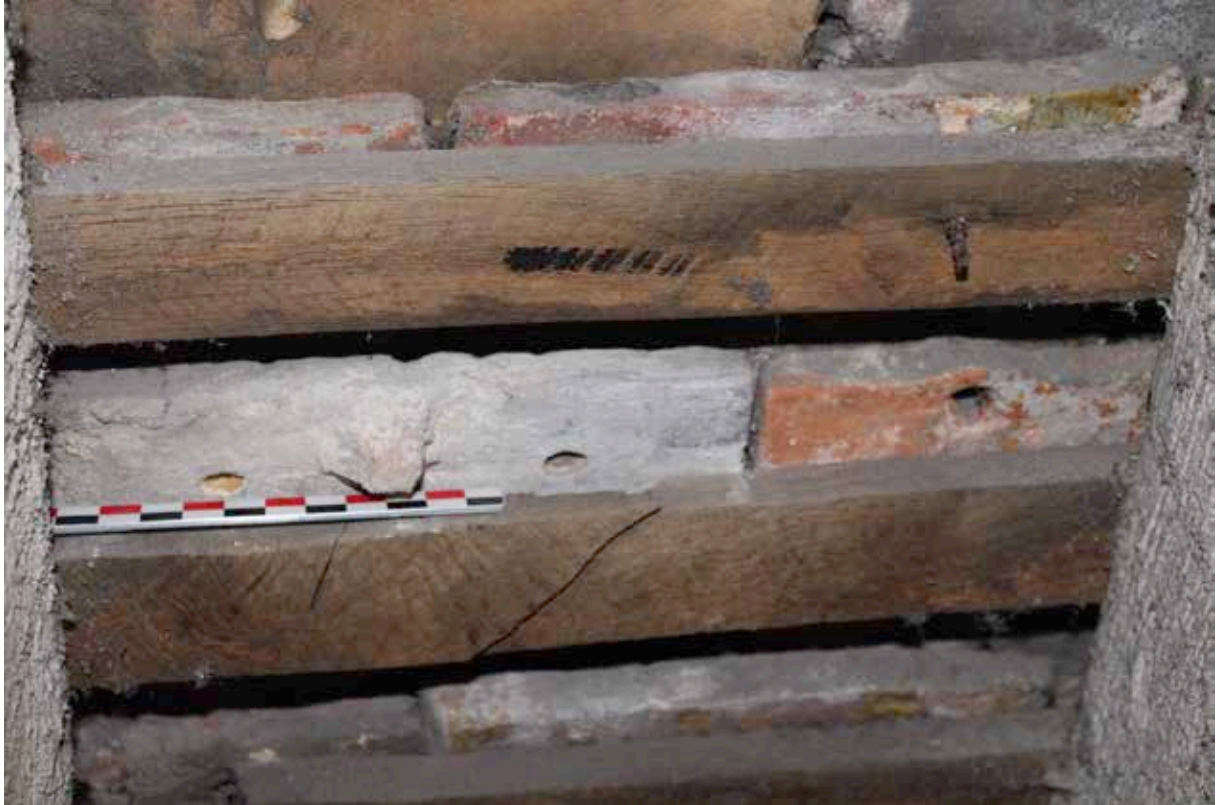
III. 72 — Nef, versant nord : tuile médiévale (?) à crochet avec perforations à chevilles (cl. S. Aumard, CEM).
