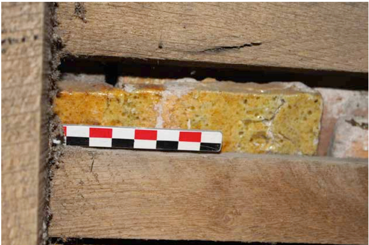
Ill. 66 — Transept nord, versant ouest : tuiles médiévales sans crochet avec glaçure jaune (cl. S. Aumard, CEM).
