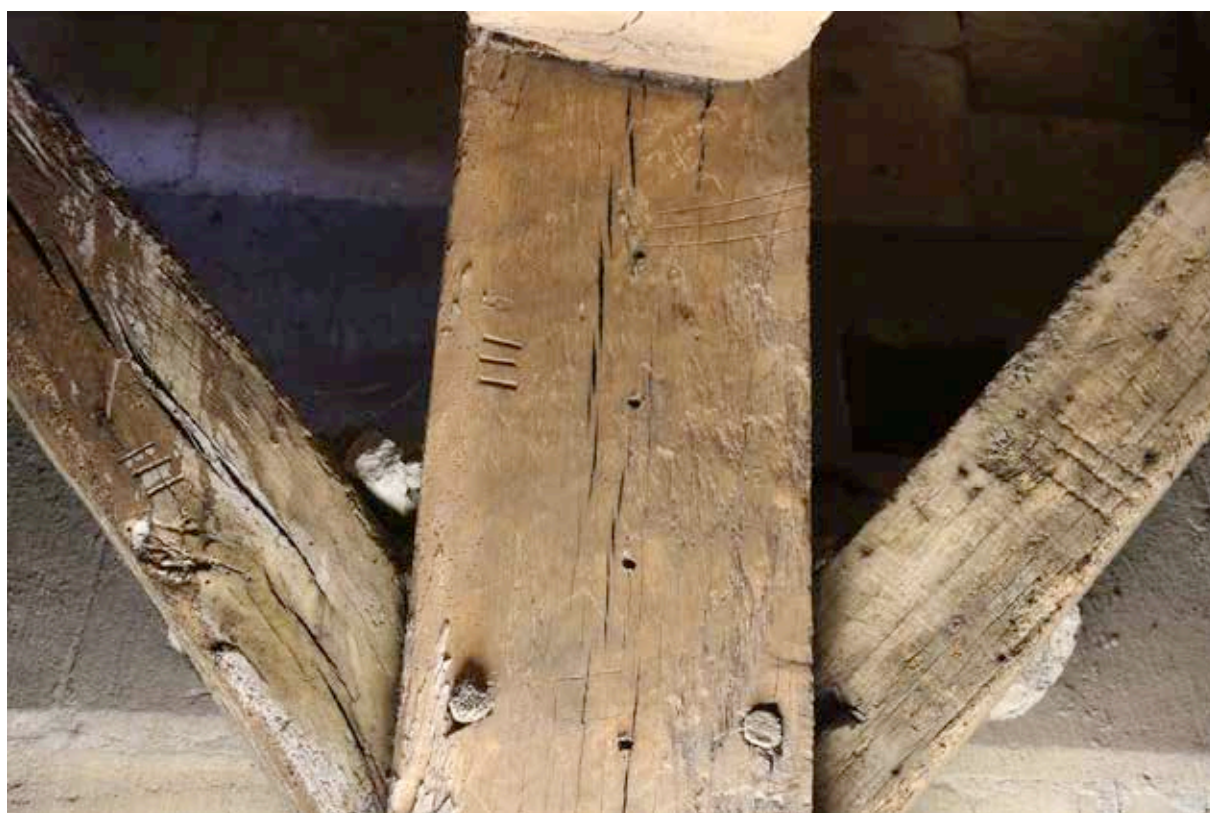
III. 21 — Déambulatoire : marques au ciseau et à la rainette (cl. F. Épaud, CNRS).
