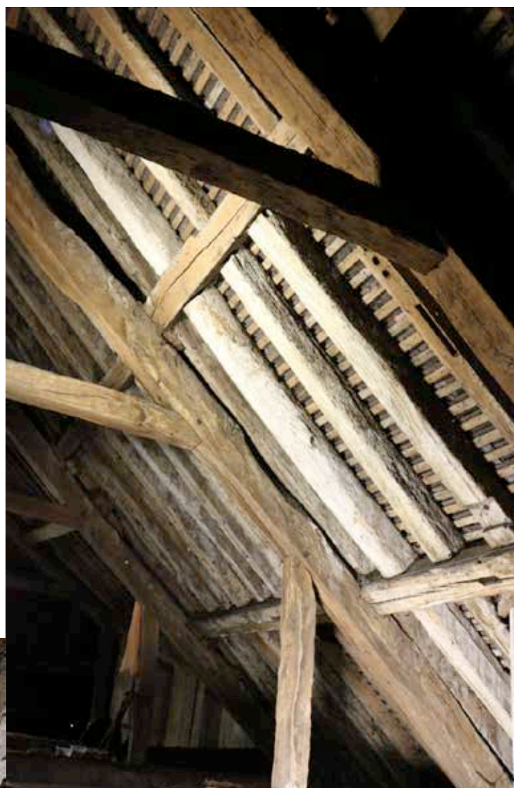
Ill. 31 — Déambulatoire, travée 9 : bois 9, chevron à côté de la ferme (cl. F. Épaul, CNRS).
