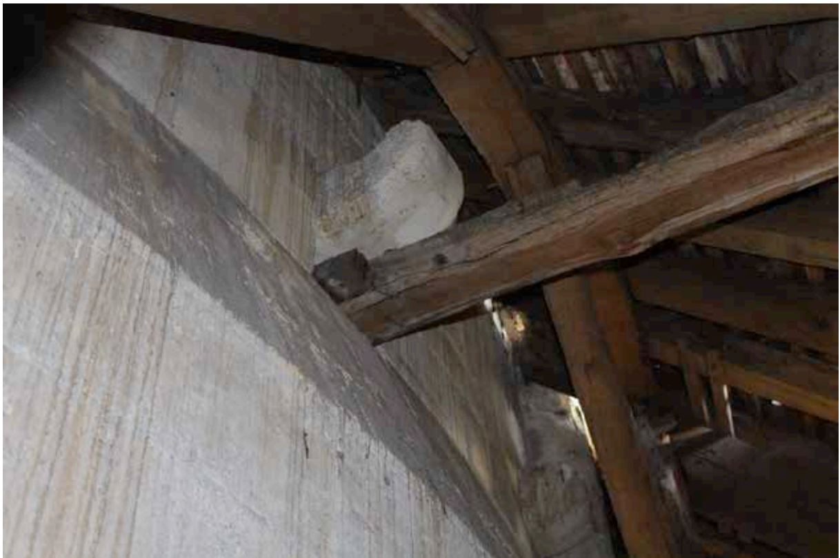
III. 53 — Déambulatoire : corbeau en partie haute du rond-point (cl. F. Épaud, CNRS).
