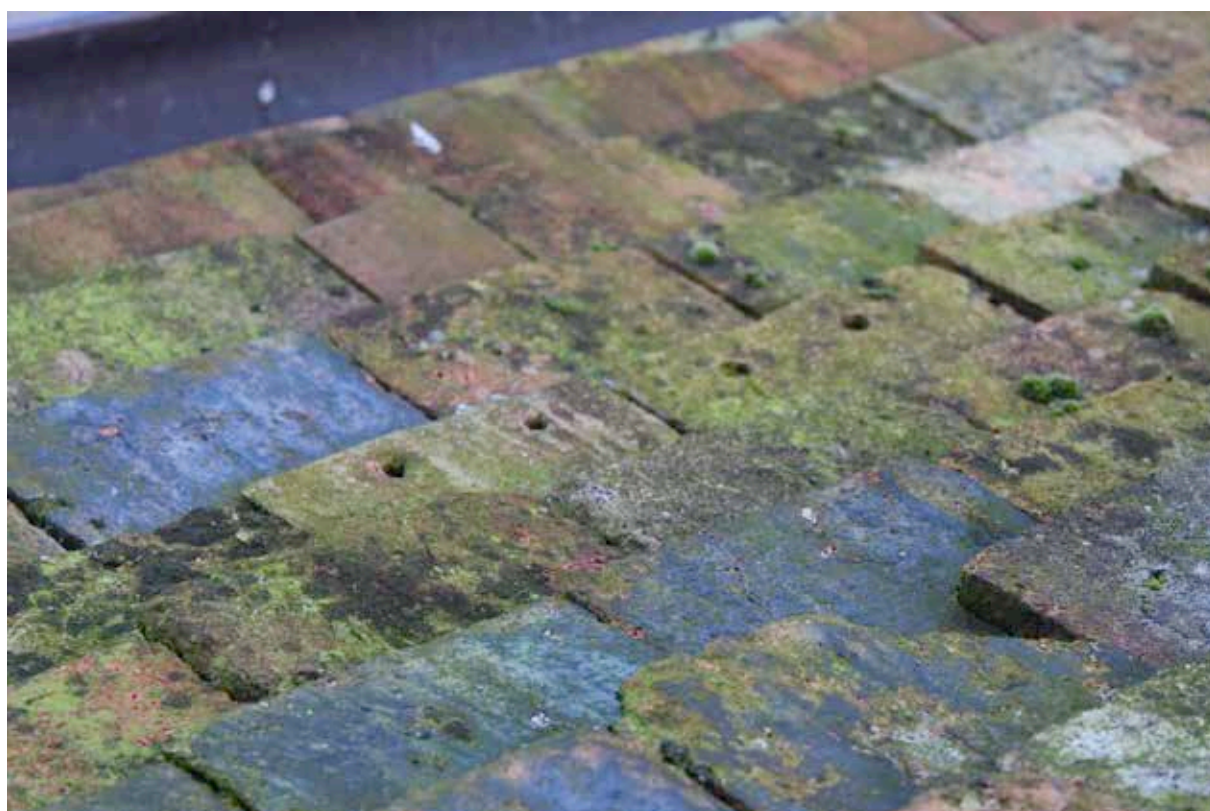
III. 69 — Nef, versant nord : tuiles médiévales sans crochet à deux perforations et pureaux glaçurés (cl. S. Aumard, CEM).
