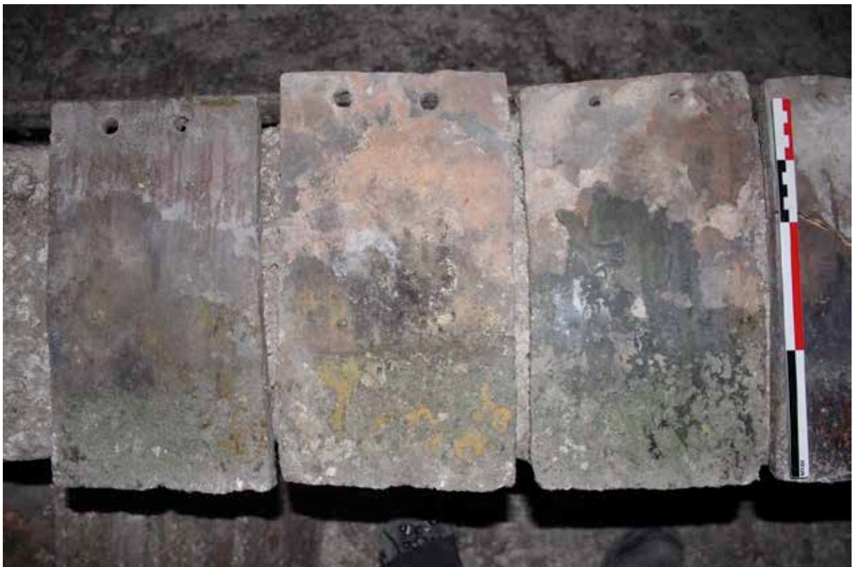
III. 73 — Nef, versant nord : tuiles médiévales retrouvées sur les reins de voûtes, type sans crochet à pureau glaçuré (cl. S. Aumard, CEM).
