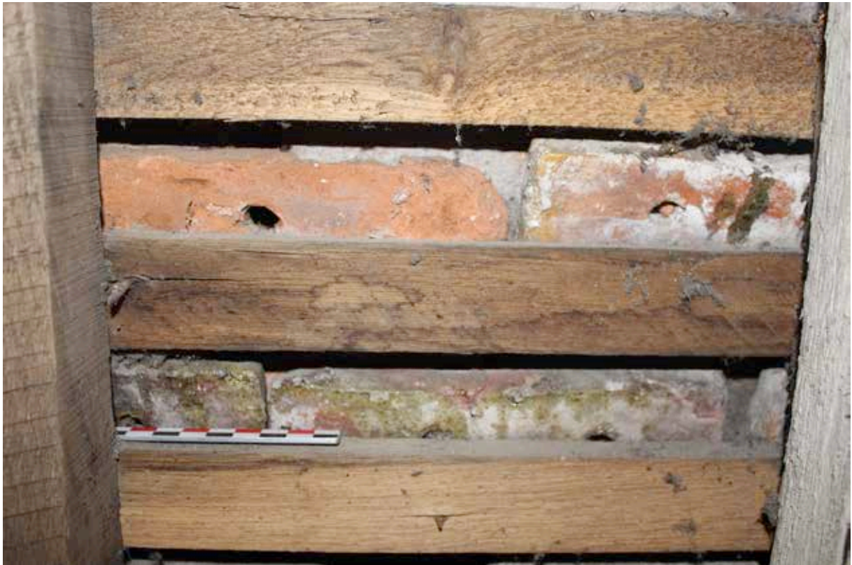
Ill. 65 — Transept nord, versant ouest : tuiles médiévales sans crochet à une ou deux perforations ; coulures de glaçure de couleur verte (cl. S. Aumard, CEM).
