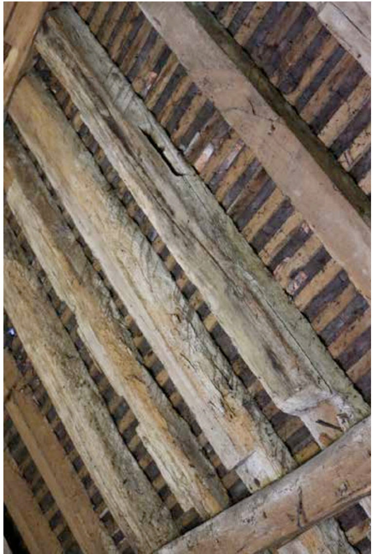
Ill. 37 — Déambulatoire, travée 6 : bois 7 (cl. F. Épaul, CNRS).
