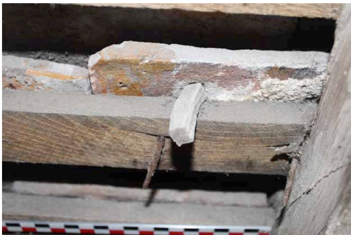
III. 71 — Nef, versant nord : tuile médiévale sans crochet avec cheville en place (cl. S. Aumard, CEM).
