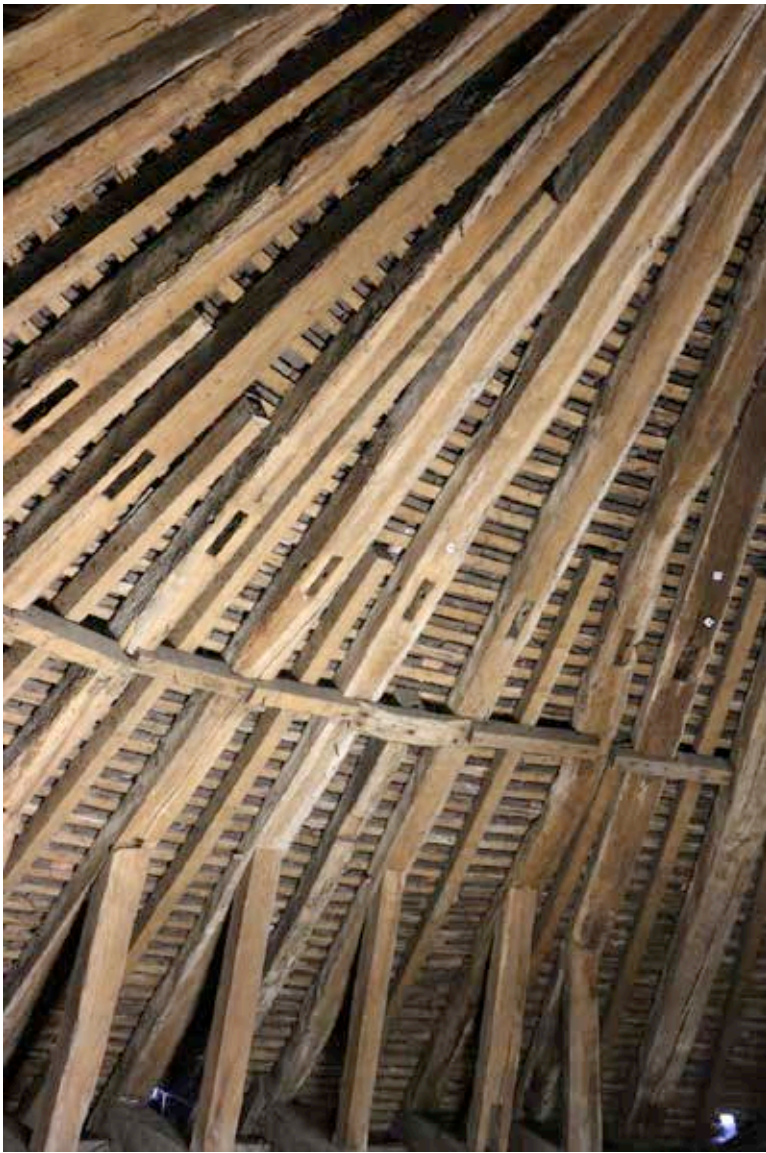
III. 25 — Déambulatoire, absidiole sud : bois 12 (cl. F. Épaud, CNRS).
