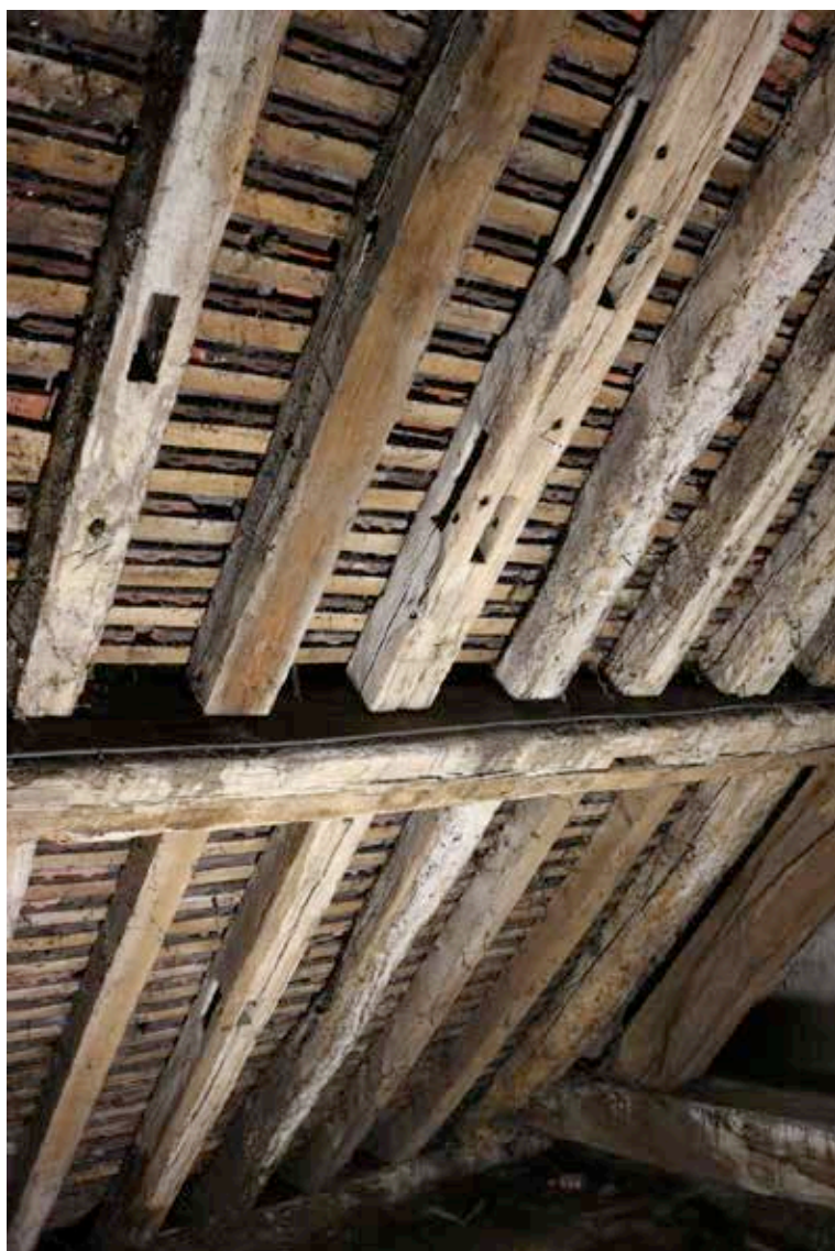
Ill. 32 — Déambulatoire, travée 10 : bois 10 (cl. F. Épaul, CNRS).
