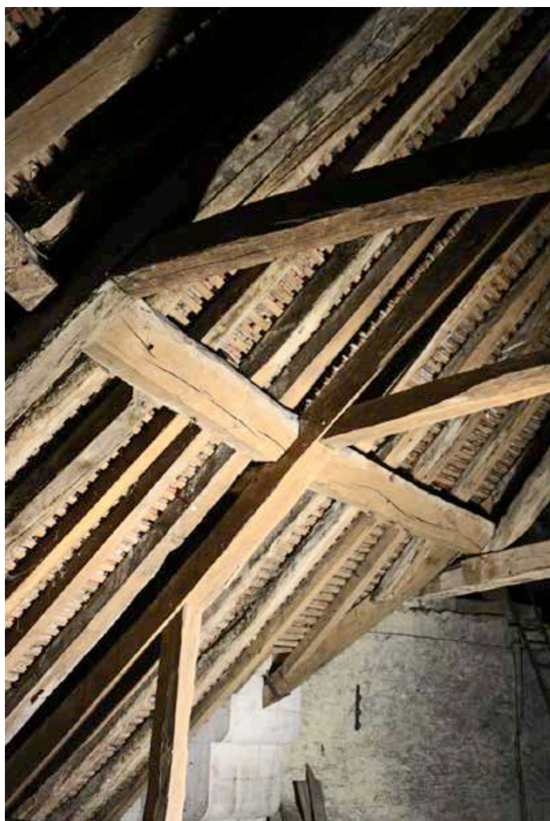
Ill. 14 — Déambulatoire, travée 15 : ferme d'axe nord (cl. F. Épaud, CNRS).
