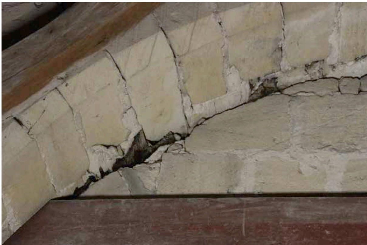
III. 8 — Déambulatoire, travée 30 : arc de décharge au revers d'une baie du triforium, couchis en place (cl. F. Épaud, CNRS).
