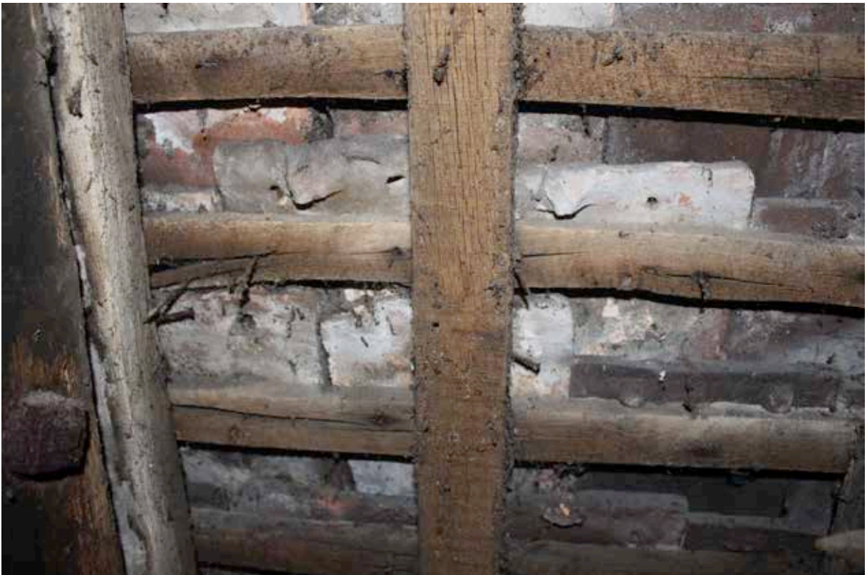
III. 59 — Chœur, versant sud : tuiles médiévales (?), type à gros crochet (cl. S. Aumard, CEM).
