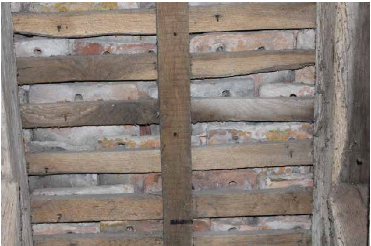
Ill. 64 — Transept nord, versant ouest : tuiles médiévales sans crochet parfaitement identifiables en sous-face de la couverture (cl. S. Aumard, CEM).
