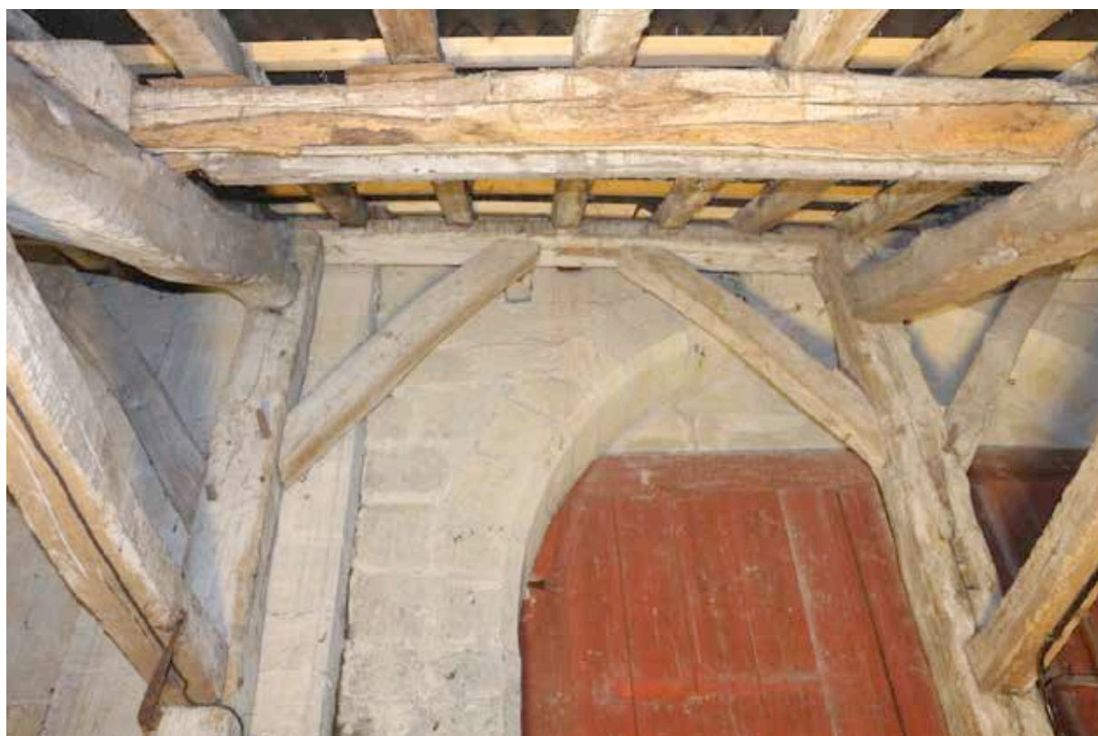
III. 12 — Déambulatoire : faîtage de la charpente (cl. F. Épaul, CNRS).
