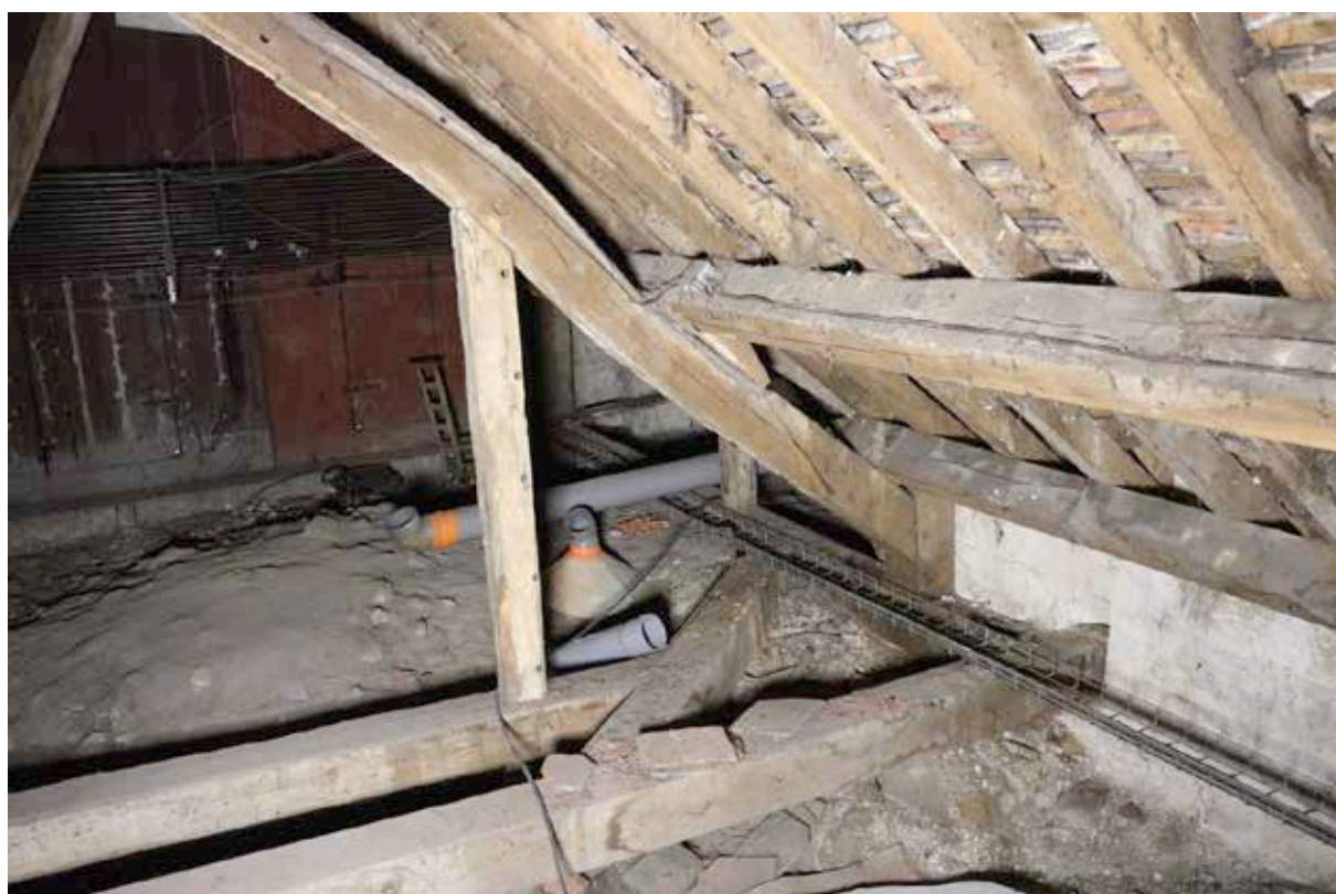
III. 13 — Déambulatoire, travée 4 : enrayure de raccord avec le collatéral du transept sud (cl. F. Épaul, CNRS).
