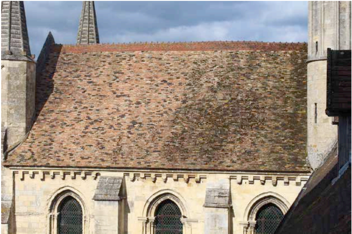
Ill. 61 — Transept nord, versant ouest : pureaux noirs correspondant à des tuiles médiévales glaçurées (cl. S. Aumard, CEM).
