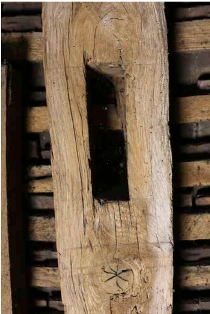
III. 27 — Déambulatoire : chevron de la croupe sud, marquage au crayon et tracés de piquage (cl. F. Épaud, CNRS).
