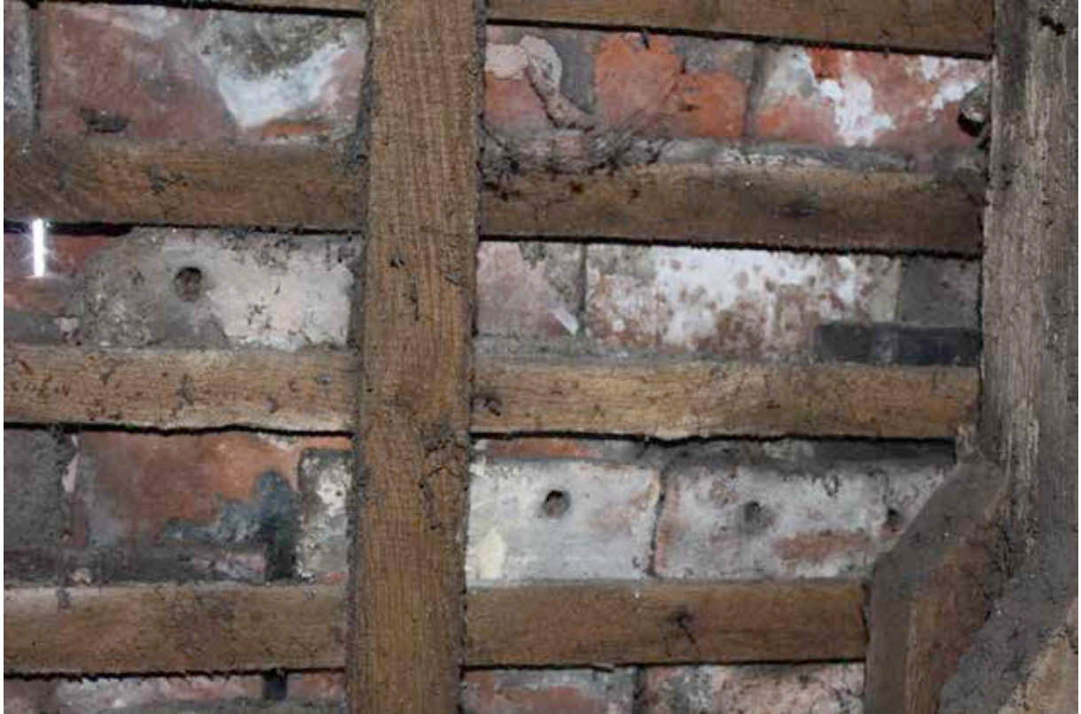
III. 58 — Chœur, versant sud : tuiles médiévales, type sans crochet (cl. S. Aumard, CEM).
