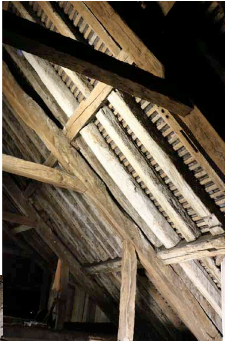
Ill. 31 — Déambulatoire, travée 9 : bois 9, chevron à côté de la ferme (cl. F. Épaul, CNRS).
