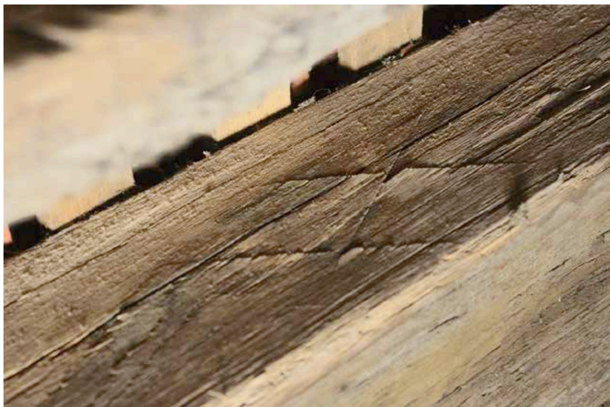
III. 41 — Déambulatoire : bois E, absidiole nord, marque d'assemblage, 1215 (cl. F. Épaud, CNRS).
