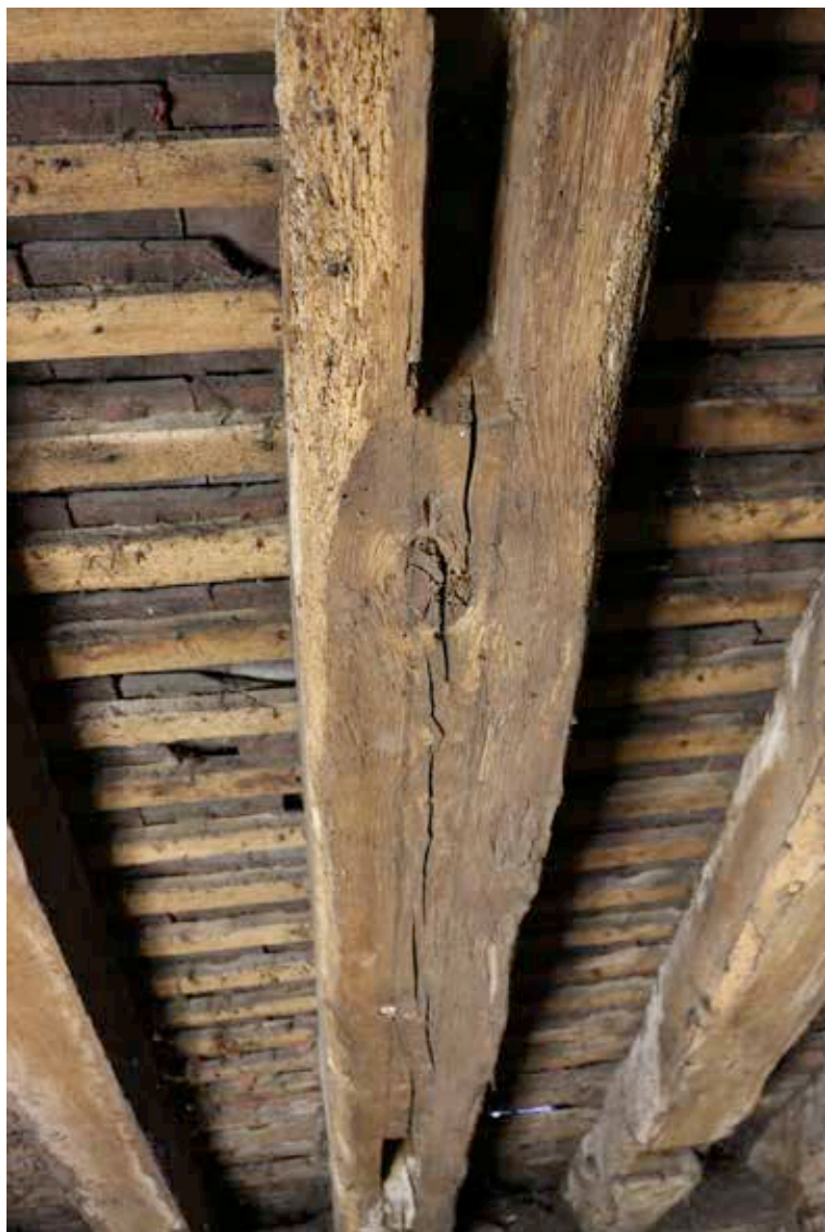
III. 30 — Déambulatoire, travée 8 : bois 8, lignage au graphite (cl. F. Épaul, CNRS).
