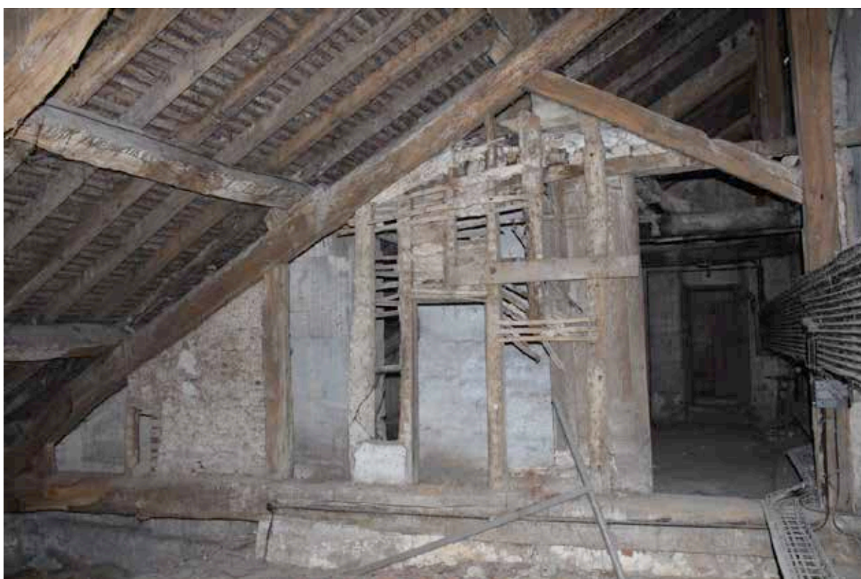
III. 75 — Nef, collatéral sud : vestiges d'un logement d'habitation (sonneur de cloche ?), pan de bois oriental hourdé de torchis (cl. S. Aumard, CEM).
