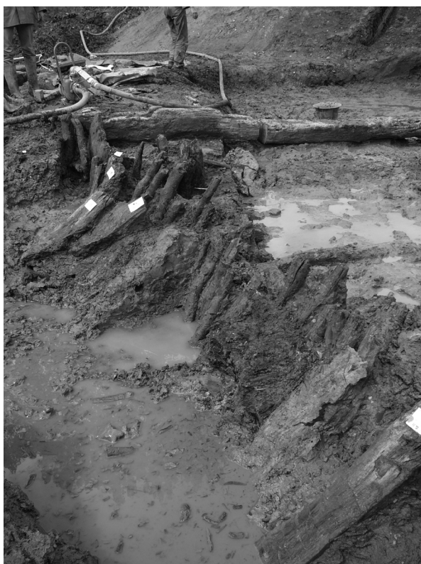
FIG. 5. Colomby, La Perruque. Vue des palplanches de la zone de barrage. (Cliché V. Bernard/CNRS UMR 6566)
