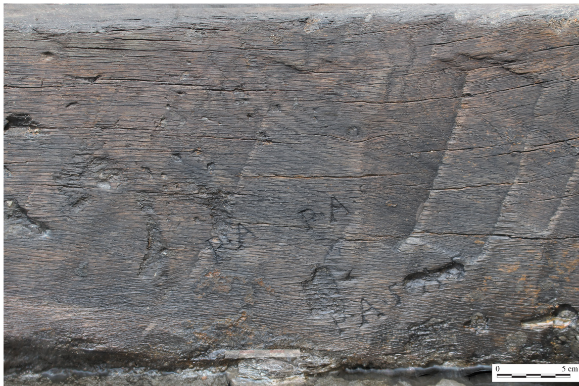
Fig. 18 : Rezé, Saint-Lupien. Sablière SA40715, face sud, vue de détail des estampilles P.A.S (cliché : éq. de fouille, 2014).
