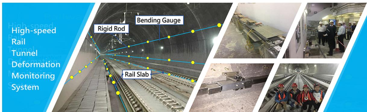
FIGURE 7.2 – Capteurs en fibre optique - Crédit PolyU
