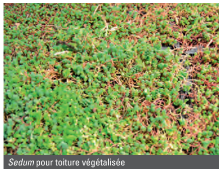
Sedum pour toiture végétalisée
