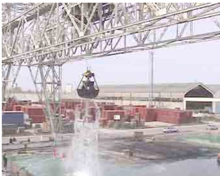
Site du Port Nord avril 2004
