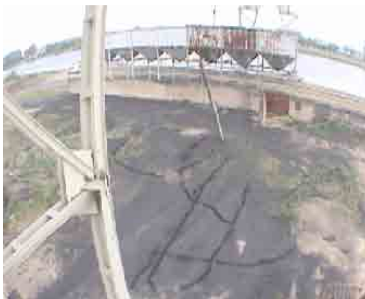
Styler béton Site du Port Nord juin 2003
