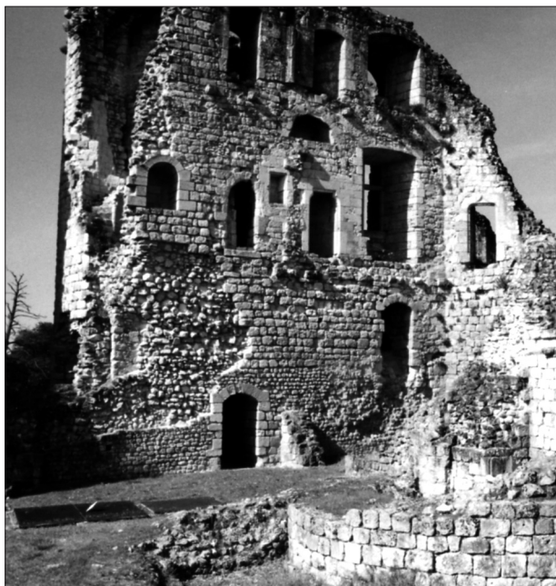
Fig. 24. Vestiges d'une construction en petit appareil à la base du corps de logis du château de Blanquefort.
