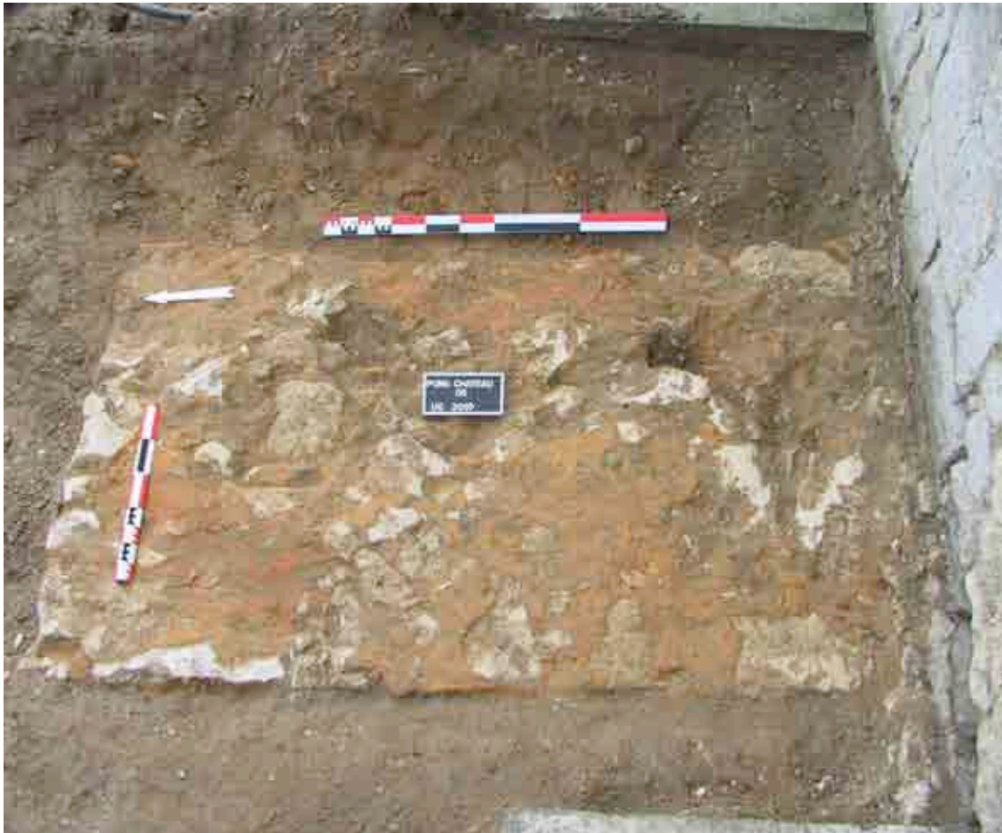
Cliché 32 : fondation de pile d'escalier 3010
