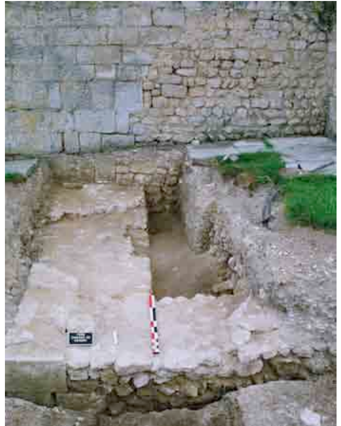
Cliché 30 : bâtiment accolé au donjon 3020
