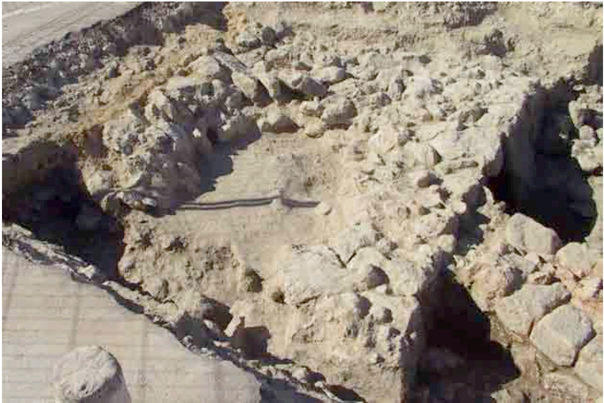
Cliché 4 : Fondation de l'enceinte castrale (US1130) (vue vers le nord)
