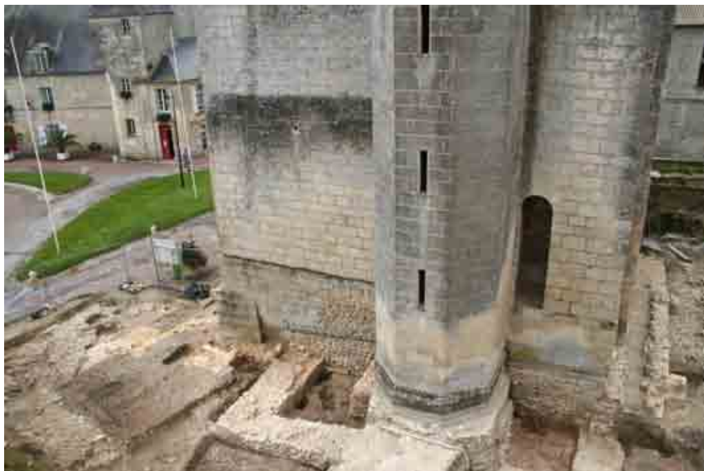
A - vue d'ensemble de la partie basse du mur nord du donjon (F. Mandon)
