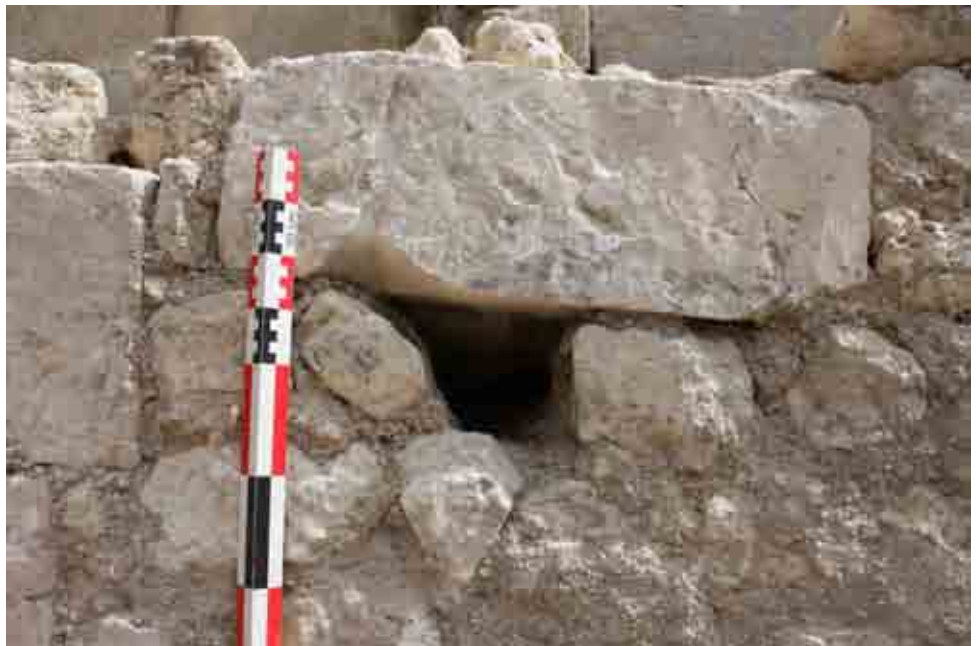
C - vue de détail d'un trou de boulin de l'UA 8001, depuis l'ouest (F. Mandon)
