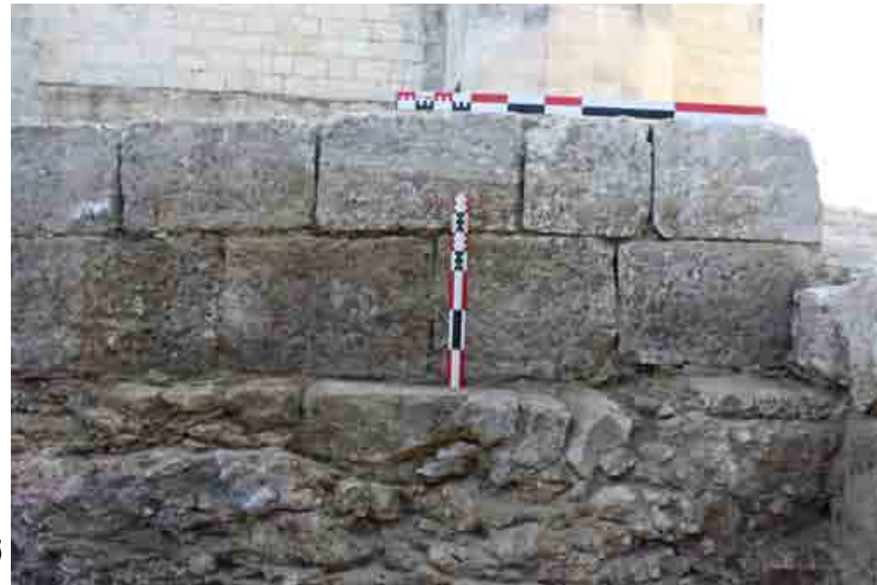
A - ES 2, vue en élévation de l'UA 8016, depuis le nord (F. Mandon)
