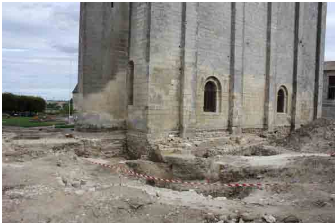
B - vue de l'angle nord-ouest du donjon, en partie basse (F. Mandon)
