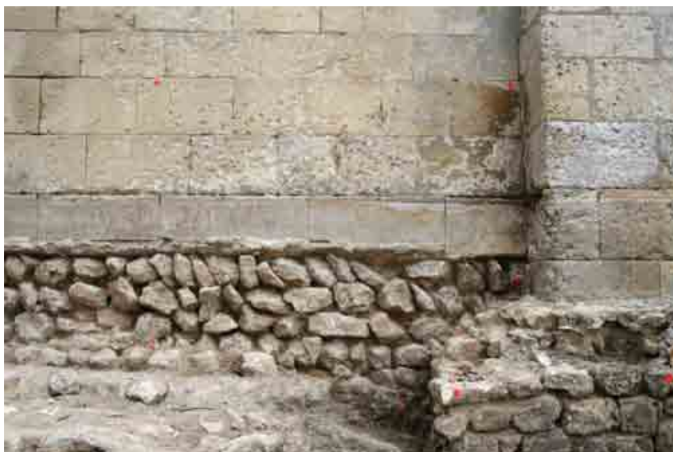
B - mur ouest du donjon, vue des fondations UA 8002 (F. Mandon)
