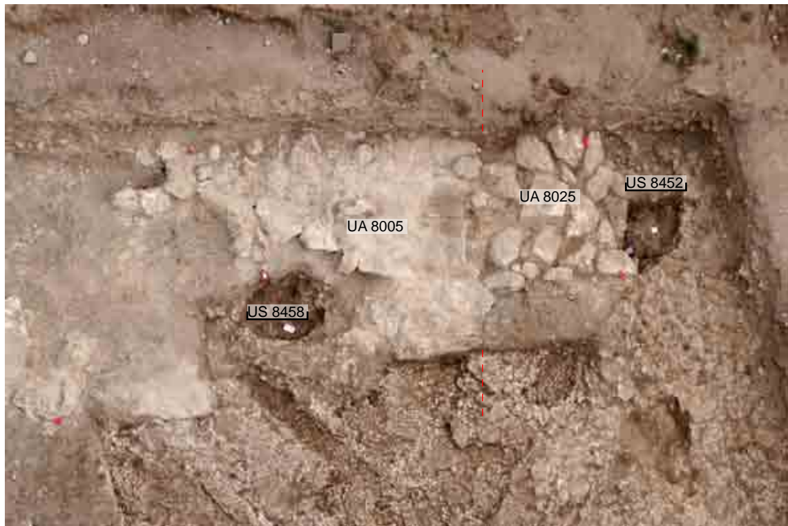
A - ES 1, vue de l'UA 8025 et de la chemise intérieure UA 8005, depuis le sud (F. Mandon). L'UA 8025 se situe à droite. Seul son parement sud a été dégagé. Le mur est recoupé par le mur nord de la chemise du donjon : on peut observer l'alignement des blocs de parement de son extrémité est
