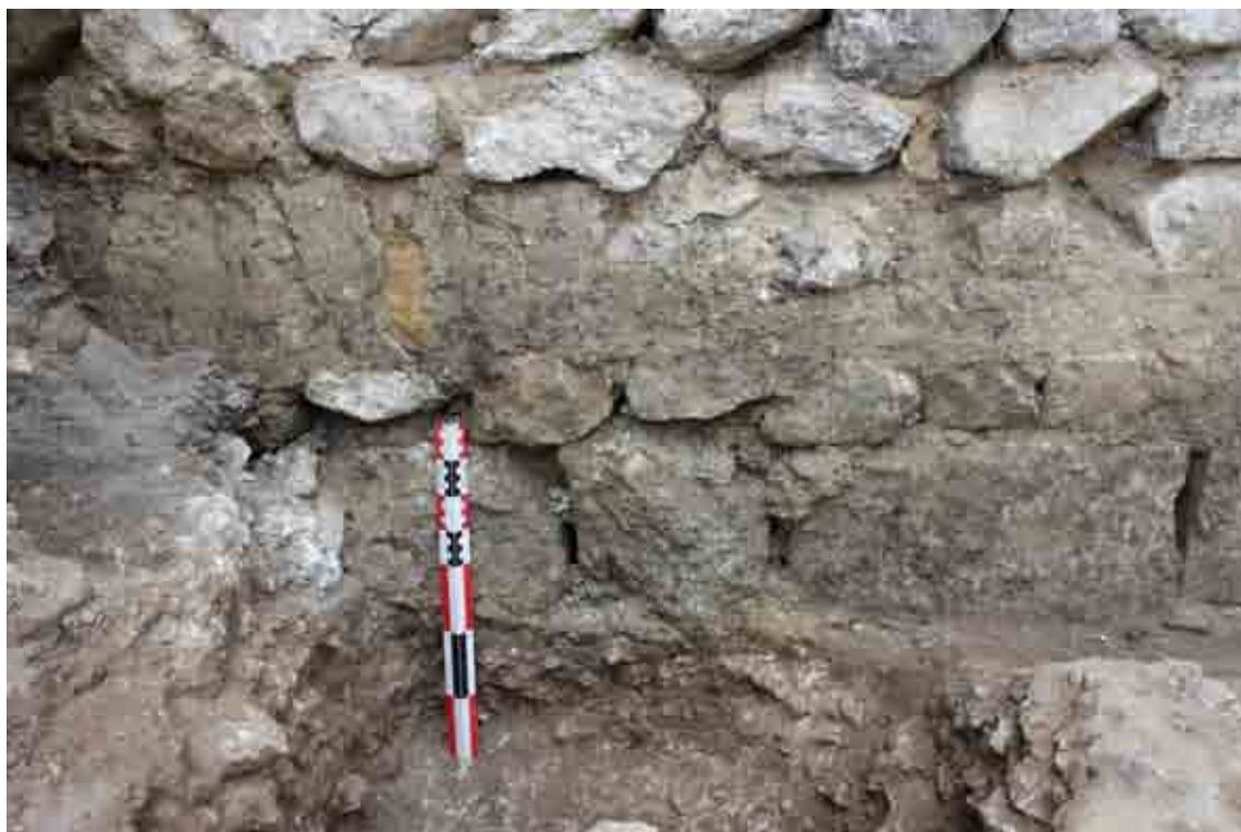
A - vue de détail du mur nord de la 1 e turris : UA 8049 (assise inférieure) et UA 8003 (F. Mandon). La maçonnerie n'est pas fondée sur le substrat rocheux mais repose sur l'US 8179, niveau antique
