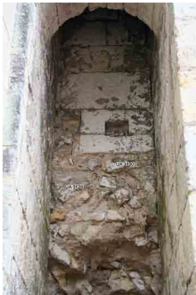
C - paroi sud du conduit de latrines du mur nord du donjon (F. Mandon). En partie inférieure, le parement en moellons correspond aux fondations UA 3120 du 1 er état de l'actuel donjon. La partie haute et les parois latérales (UA 3130) correspondent au 2 e état
