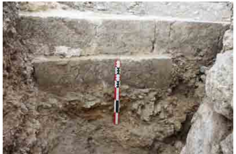
D - [ES 5] vue en élévation de l'extrémité est de l'UA 8008 (F. Mandon). L'assise inférieure en ressaut repose sur le substrat, recoupé par la tranchée de fondation de la glacière moderne. L'assise supérieure correspond à l'amorce du contrefort
