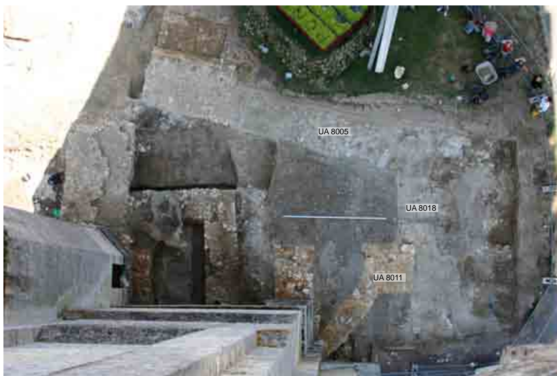
B - vue d'ensemble des ES 1, 3 et 4, depuis le sud (F. Mandon). En limite nord de la fouille, le mur nord de la chemise UA 8005. On distingue la tranchée de récupération du mur Est, UA 8018, avec le décrochement de sa limite ouest, recoupé par la pile UA 8011 datant de 1884
