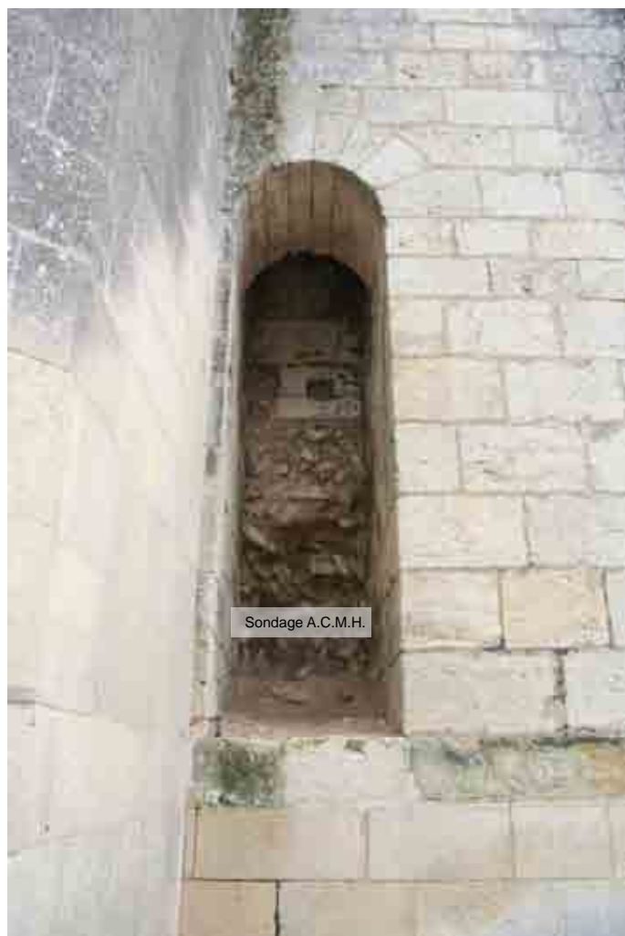
B - vue du débouché du conduit de latrines du mur nord du donjon (F. Mandon)
