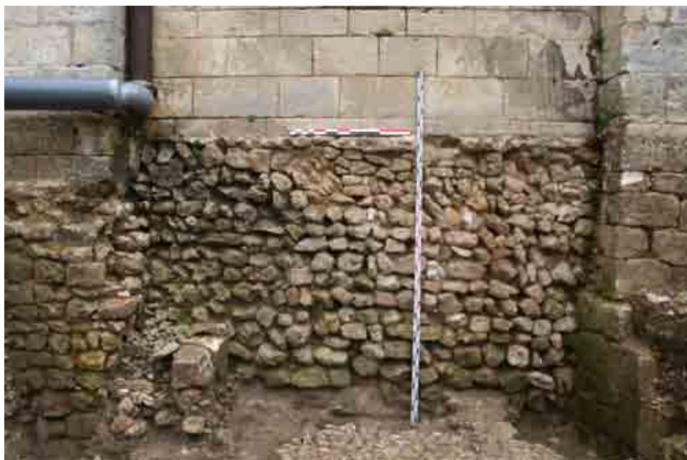
A - mur ouest du donjon, vue des fondations UA 4233 (fouille de 2006, F. Mandon)
