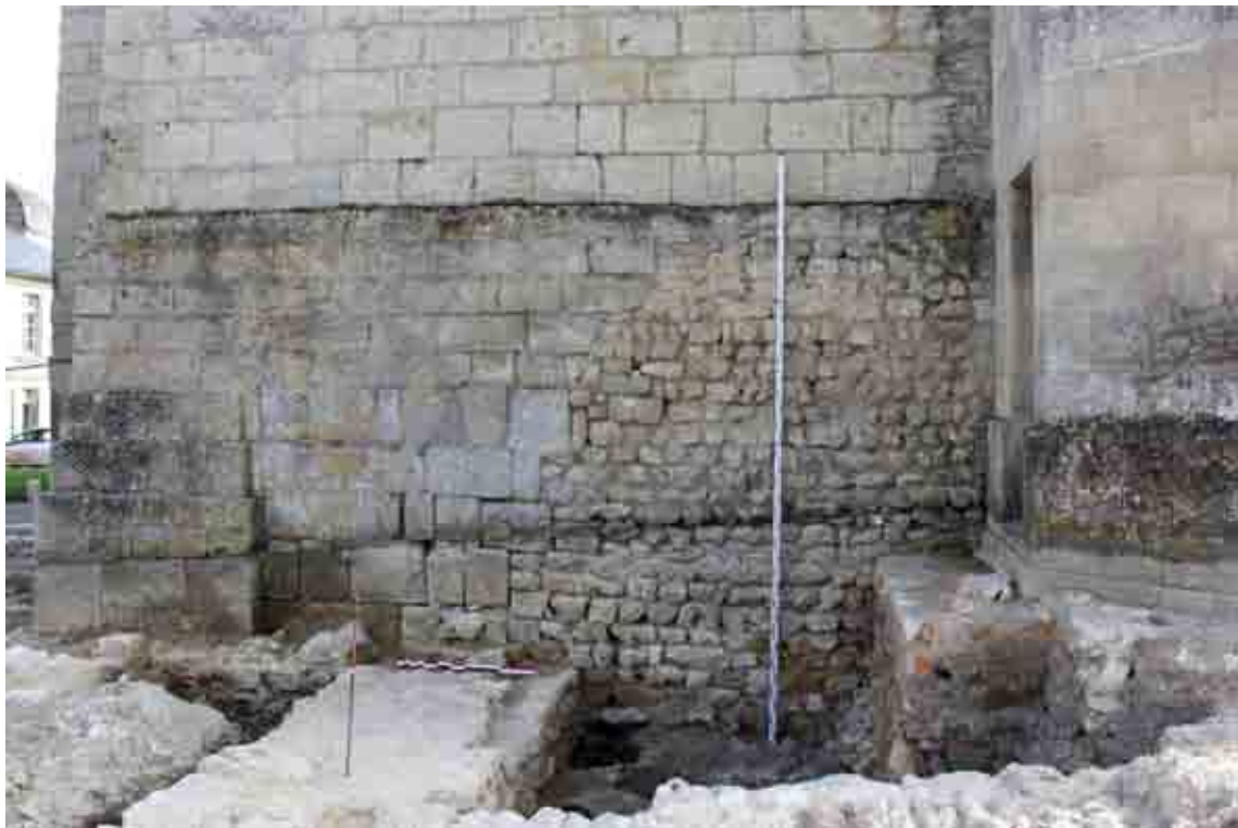
A - vue en élévation de la partie basse du mur nord du donjon (zone est) (F. Mandon)
