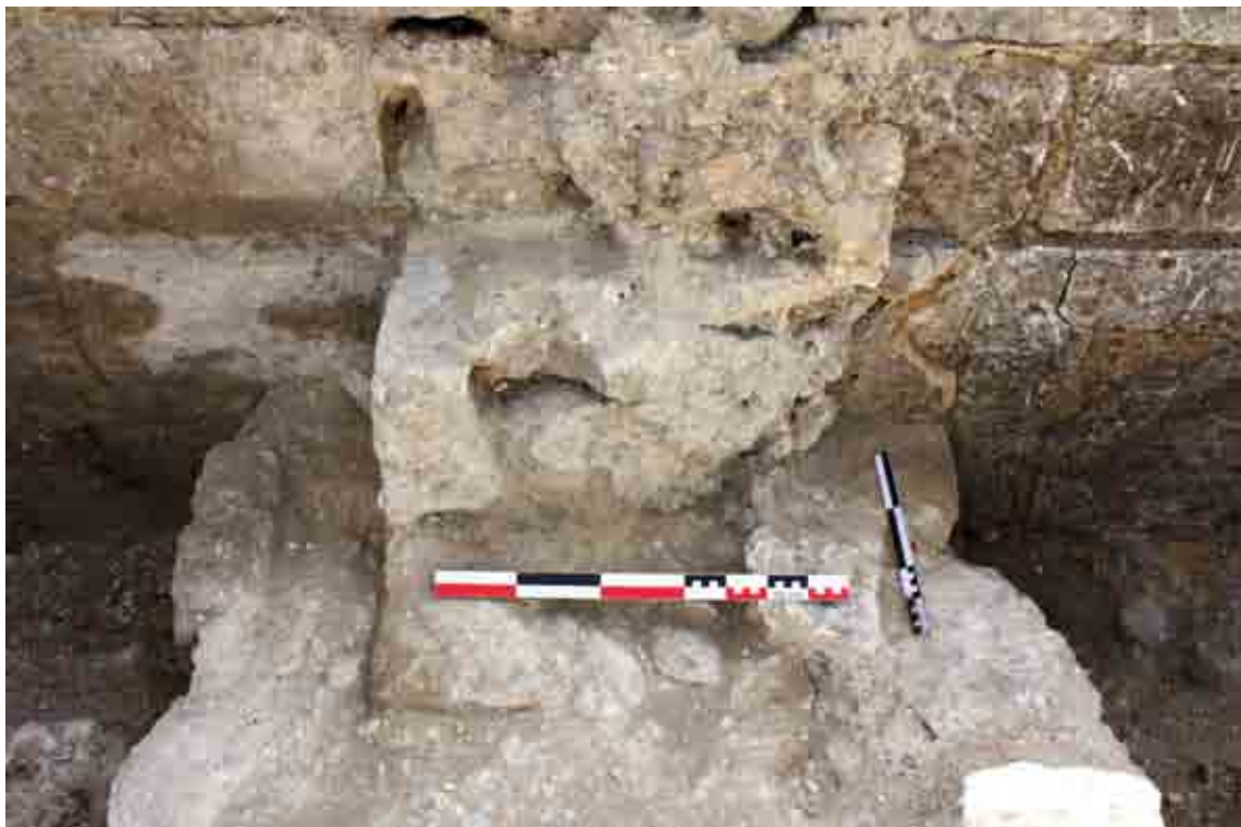
B - contrefort UA 8048, vue depuis le nord (F. Mandon)
