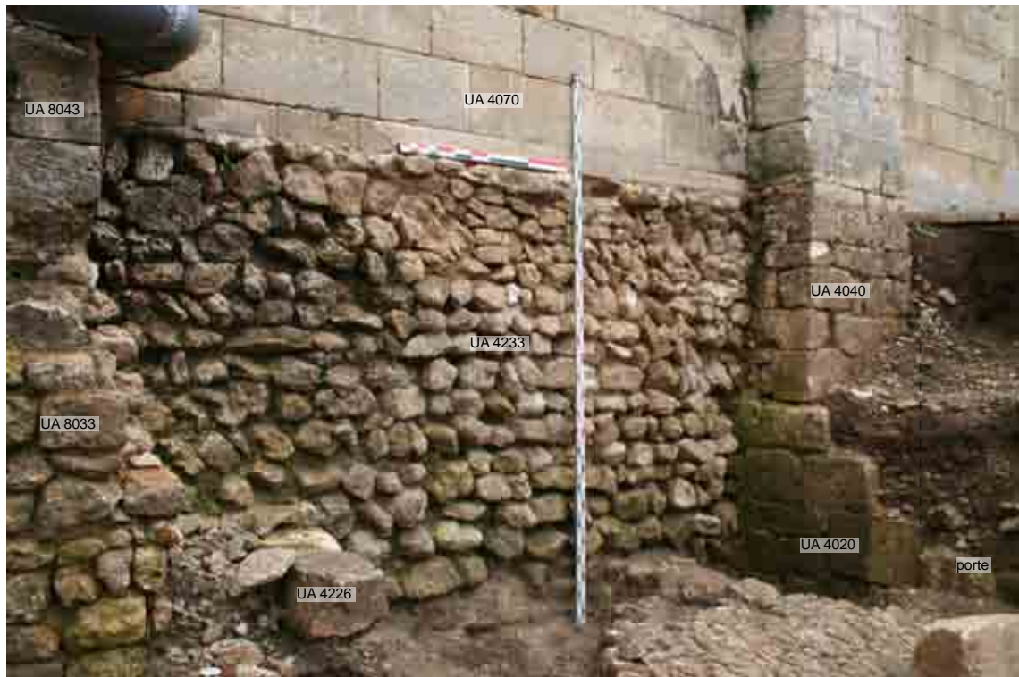
B - Secteur 4, vue d'ensemble de fondations ouest du donjon, depuis le nord-ouest (fouille de 2006, F. Mandon).
