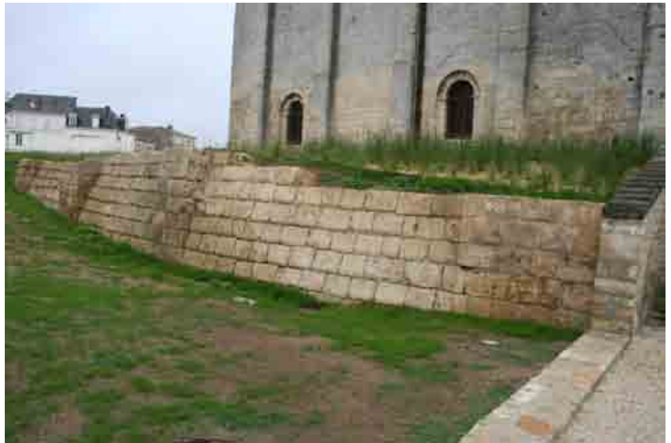
A - [secteur 4] vue d'ensemble du mur de soutènement, depuis le sud-ouest, après travaux (août 2010, F. Mandon)
