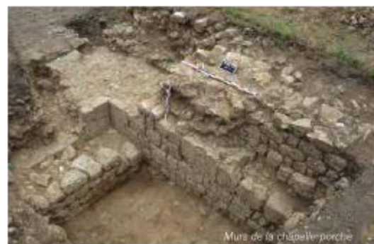
Murs de la chapelle-porche
