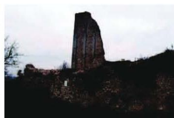
La tour de Broue et le mur d'enceinte. PHOTO M. R.
