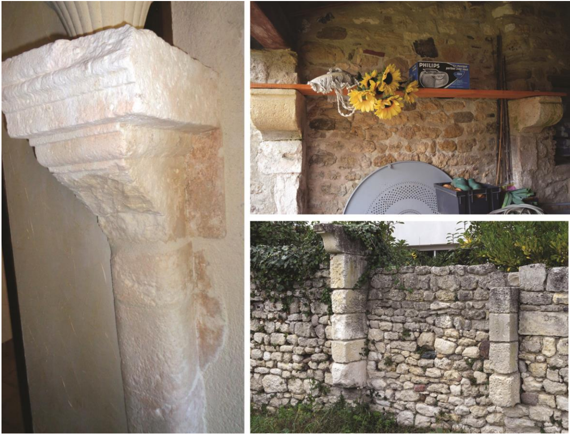
Fig. 4 : 7 rue de la Grotte (à gauche) ; 13 rue du Port (en haut à droite) ; îlot 6 parcelle b913 (en bas à droite). Photographies C. Hubin/M/ Duc
