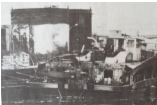
FIGURE 3.3 – Photo mettant en perspective les deux sinistres de 1991 (devant) et de 1987 (en arrière plan) parue dans le Le Progrès du 19.10.1991.
