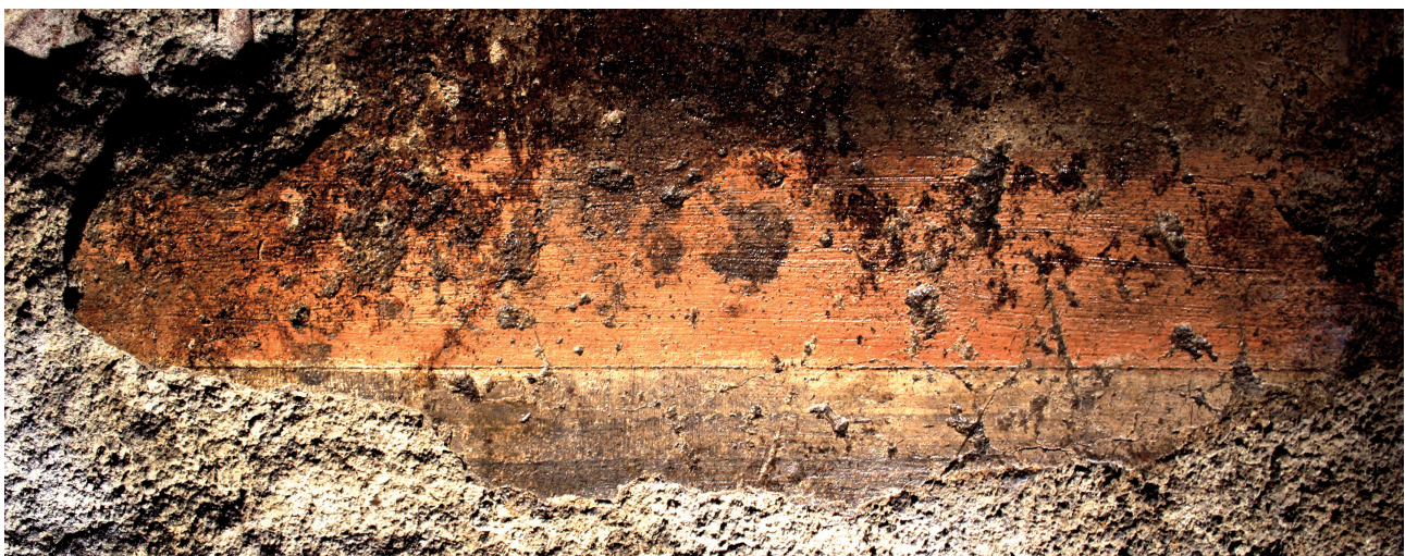
◆ Fig. 5. Détail de la plinthe et du tracé préparatoire incisé (cl. J. Boislève).
