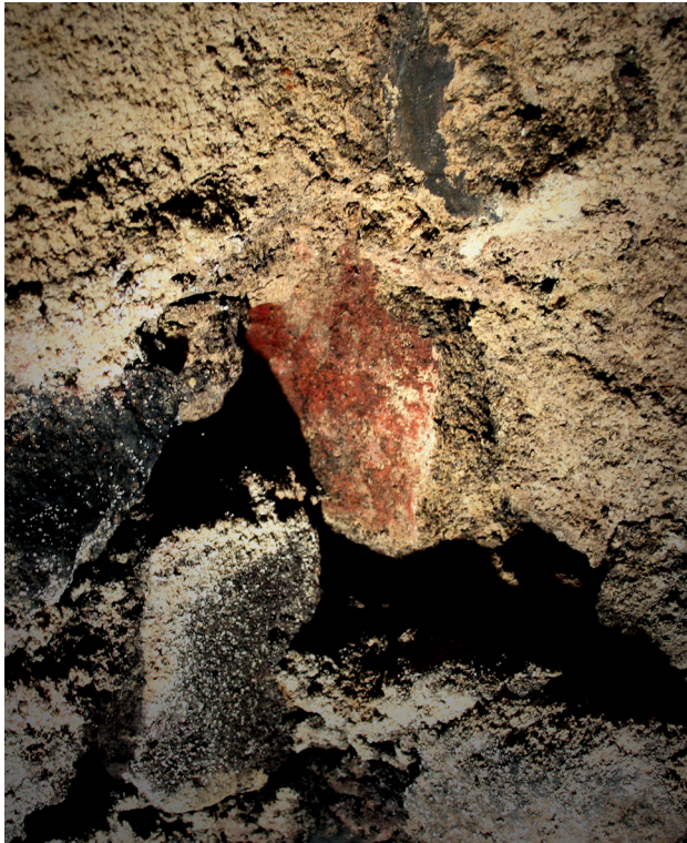
◆ Fig. 4. Enduit du premier état conservé par l'ajout du mur nord-sud (cl. J. Boislève).
