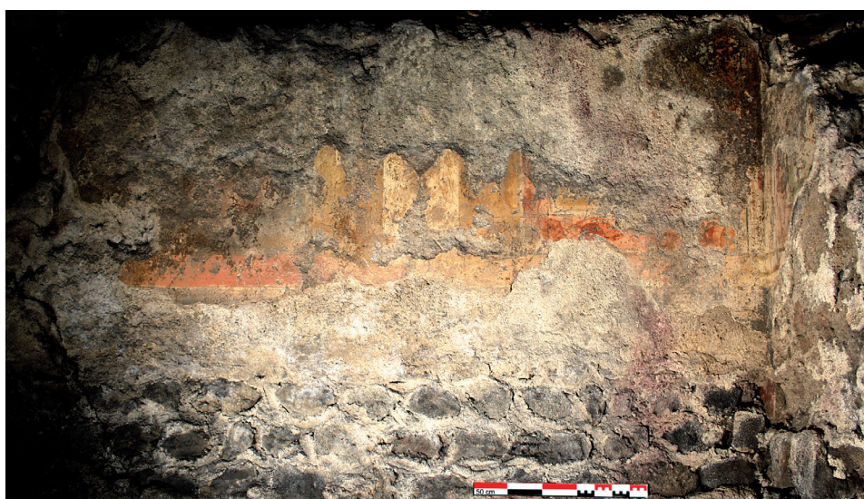
◆ Fig. 3. Vue d'ensemble de l'enduit en place sur le parement principal (cl. J. Boislève).
