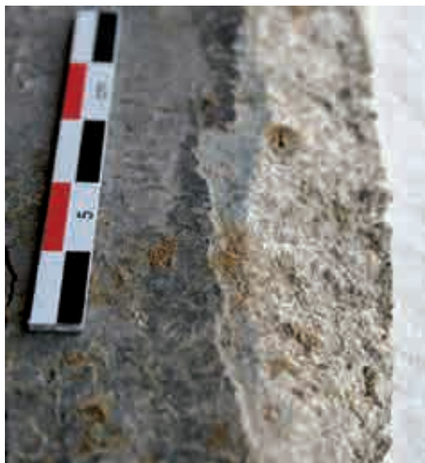
Fig. 5. Détail de la césure et du raccord indiquant la présence d'une ouverture obturée (cliché J. Boislève, Inrap).
