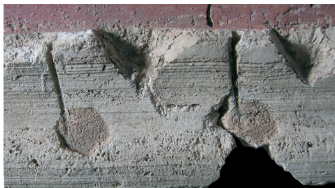
Fig. 38 – Encoches marquant l'emplacement des points roses (cliché : C. Allonsius, CEPMR-APPA).
