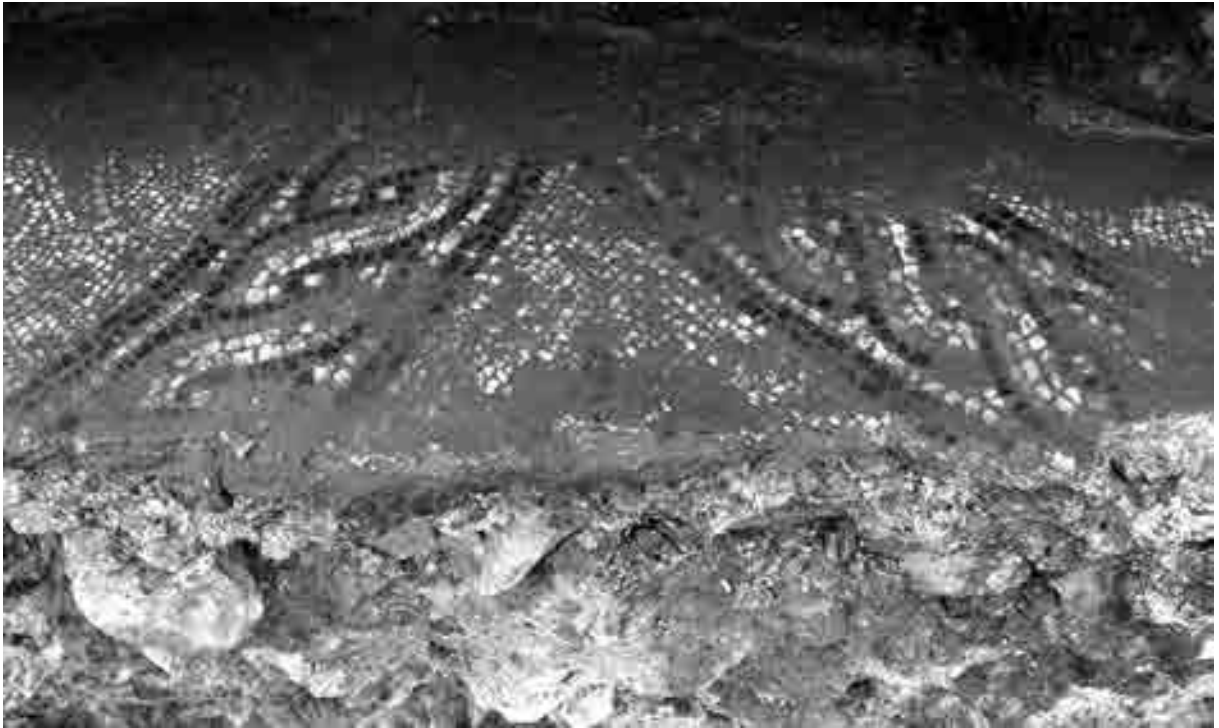
Fig. 6. Domus de l'îlot G. Détail du pavement de la pièce [19] observé seulement en coupe (cl. J. Boislève /INRAP).
