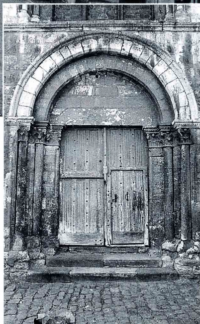
(ill. 5) Portail donnant dans les collatéraux nord du chœur.
