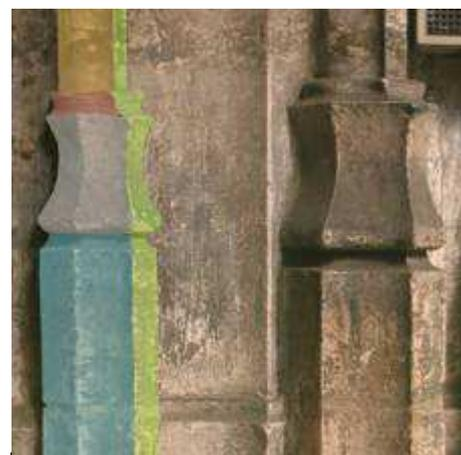
Fig. 12. Rouen, Saint-Maclou, pile de la nef (conçue en 1436), détail : « flacon » (contraction de la plinthe renflée et de la base moulurée)
