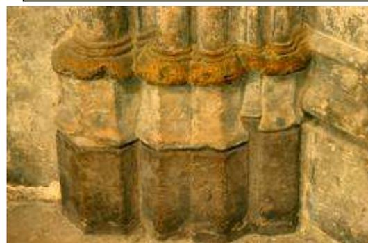
Vers 1320, en revanche, les bases moulurées d'un faisceau de colonnettes n'ont plus toutes la même hauteur, pas plus que les plinthes et, partant, les socles. En effet, chacune des composantes est dorénavant proportionnée en fonction du calibre de la colonnette qu'elle soutient. Le calibre est à son tour déterminé par l'importance que l'architecte assigne à la colonnette au sein de la structure porteuse de son édifice : celle recevant l'arc
