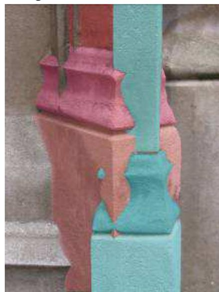
Fig. 34. Avant-portail, pilier médian, détail avec mise en évidence par coloration de l'interpénétration (fictive) des éléments architecturaux
