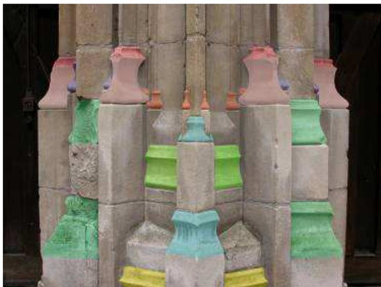
Fig. 29. Avant-portail, pilier central, face sud, mise en évidence par coloration des moulures à profil sinueux
