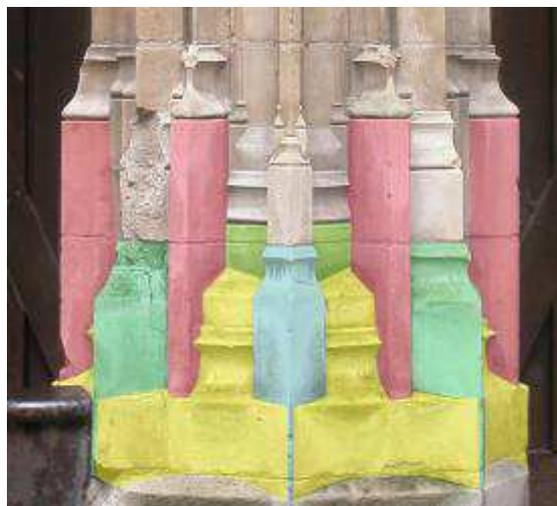
Fig. 31. Avant-portail, mise en évidence par coloration des zones de pénétration entre socle commun et socles particuliers
