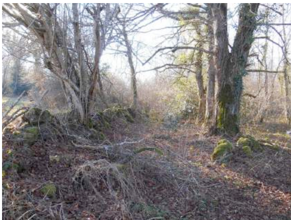
Fig. 36 : MASF.3. Murs de blocs au nord de la tourbière
