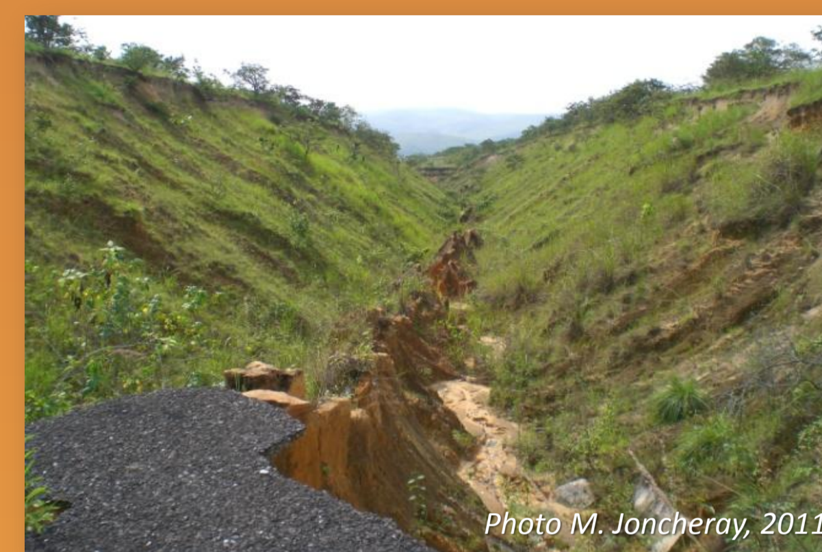
Érosion de la route Brazzaville-Mayama : 25 ans sans entretien.
