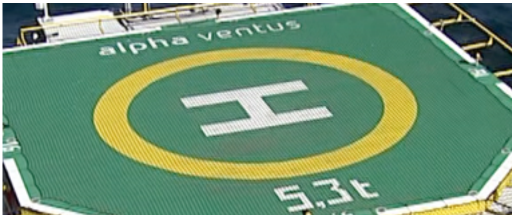
Fig 2 : Cas d'un hélipad recouvert par un filet
