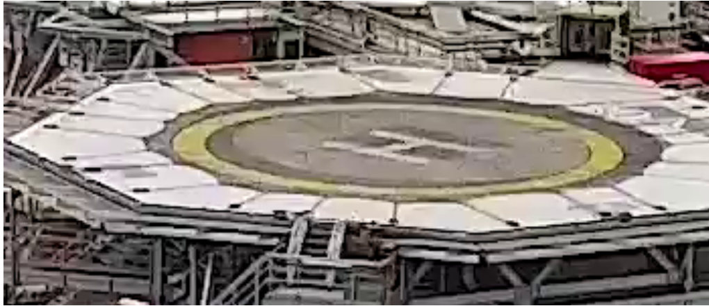
Fig 1 : Cas d'un hélipad vu de très loin.
