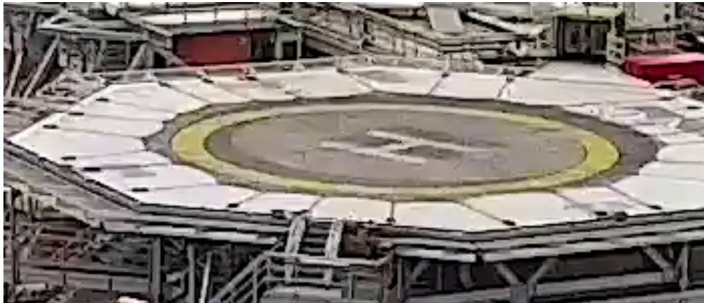
Fig 1 : Cas d'un hélipad vu de très loin.
