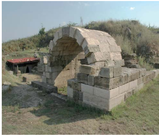
Fig. 4. Au pied de la plateforme nord subsistent les bases de l'élévation des trois magasins. Cette installation de stockage a fait l'objet d'une restauration partielle. Le Service des Monuments albanais a remonté l'une des voûtes avec quelques claveaux et de facsimilés en béton. Photo E. Follain
