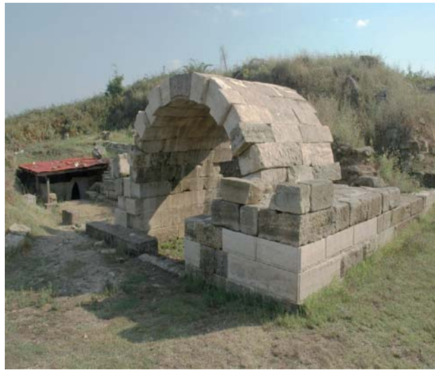
Fig. 4. Au pied de la plateforme nord subsistent les bases de l'élévation des trois magasins. Cette installation de stockage a fait l'objet d'une restauration partielle. Le Service des Monuments albanais a remonté l'une des voûtes avec quelques claveaux et de facsimilés en béton. Photo E. Follain
