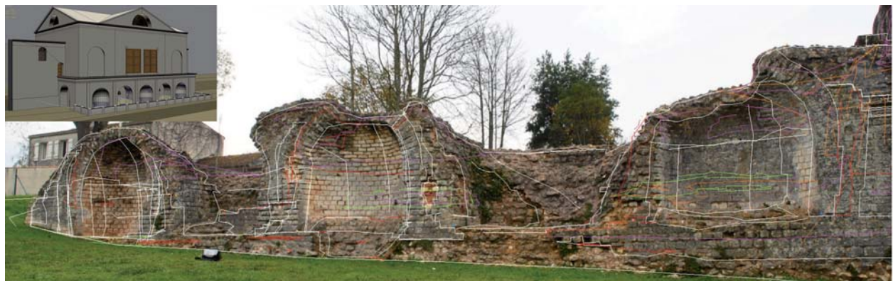
Fig. 4. Exemple de filaire obtenu sur le site des thermes Saint Saloine. Les mesures sur les parties conservées du site ont pu être utilisées avec succès dans le cadre de la restitution des thermes. Les parties ruinées, à la géométrie par conséquent très complexe, n'ont pas pu être relevées avec une résolution élevée. Nous atteignons là les limites de cette méthode, et rentrons dans les champs d'application du scanner 3D.
