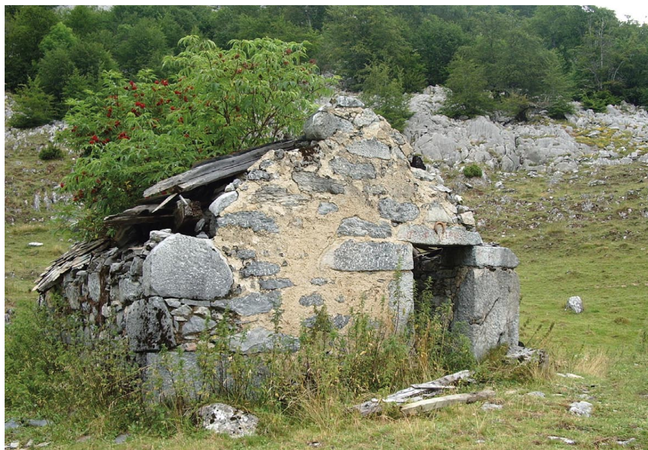
Fig. 21 : Cabane sur l'estive de Jaout, avant sa restauration (photo Maison de la montagne, Pau). L'usage du mortier dans les habitats d'estive remonte aux années 1920-1930.
