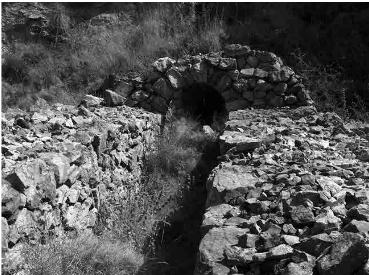
Lámina 6. Pasillo o corredor de entrada a la galería inclinada de la Rambla del Abenque.
