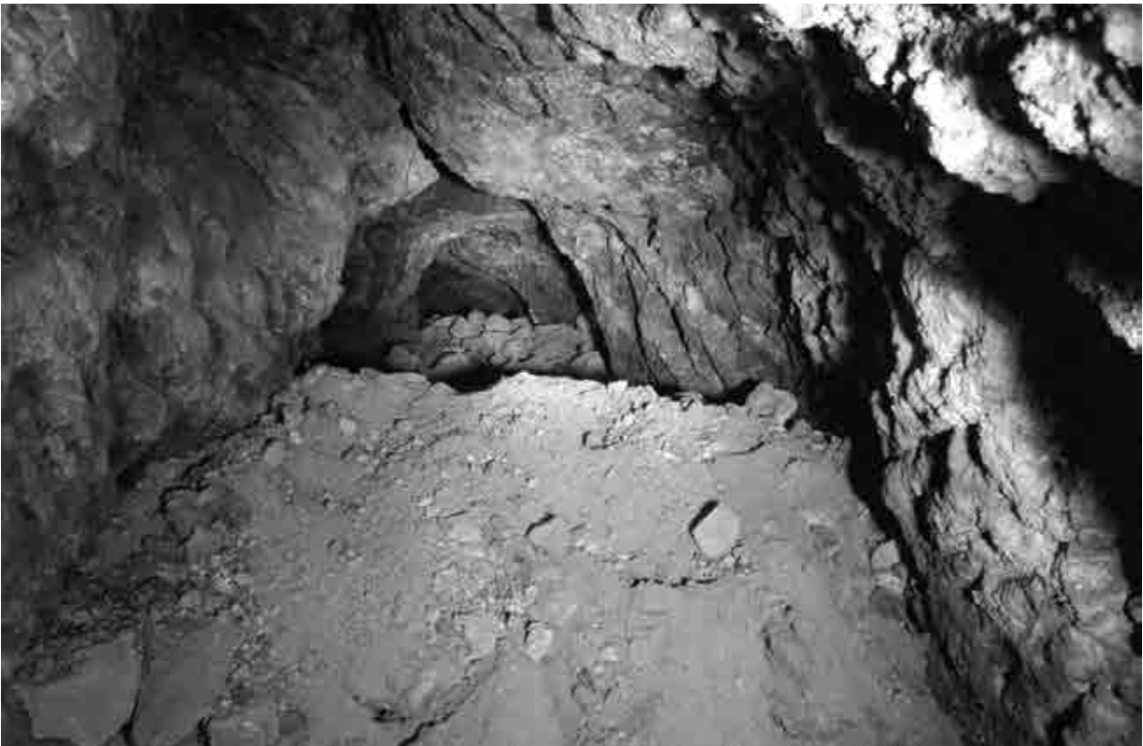
Lámina 19. Cámara de explotación antigua colmatada por depósitos de estériles mineros.
