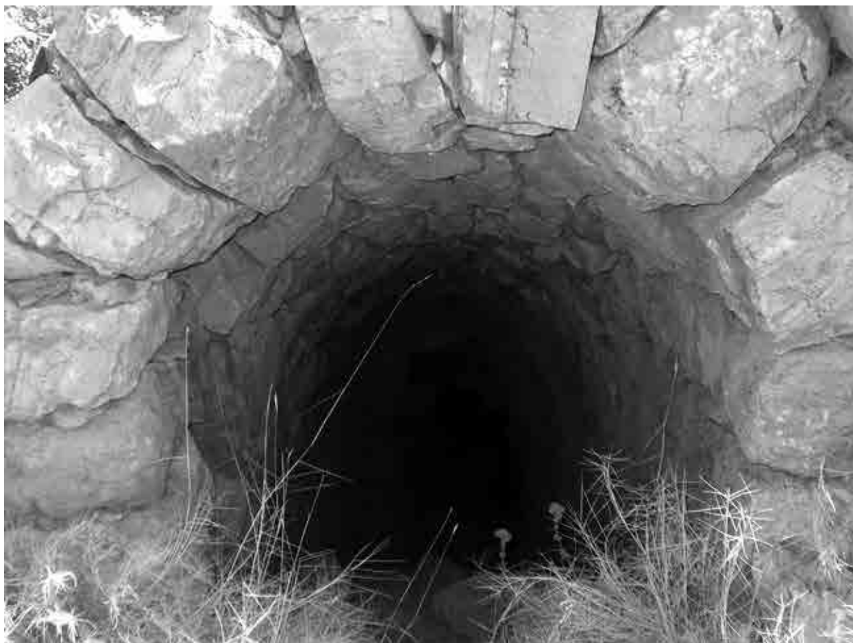
Lámina 5. Galería inclinada de acceso a las labores subterráneas de la Rambla del Abenque.
