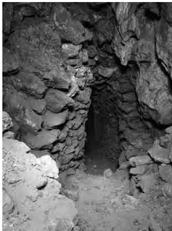
Lámina 13. Muro de contención –realizado con grandes bloques de estériles– para la fortificación de la parte inferior de la rafa.
