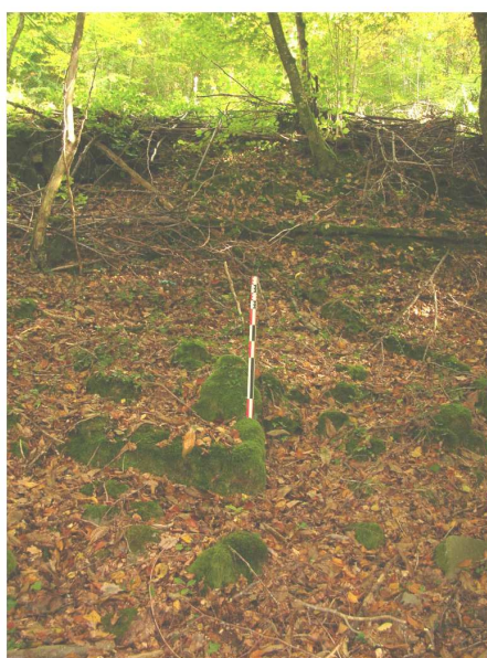
St007001046, neuvième puits de rupture de pente de l'aqueduc de Montjeu, vue vers le sud, en aval de la route (L.B.)
