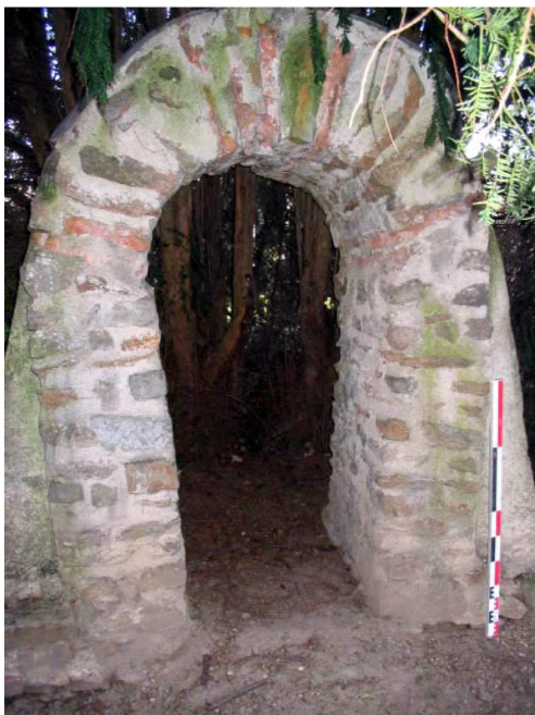
St007004041, tronçon d'égout, musée Lapidaire (L.B.)
