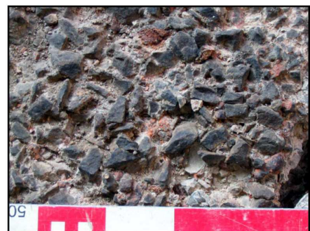
Détail du mortier de tuileau de St007004162, bassin? (Musée Lapidaire, L.B.)
