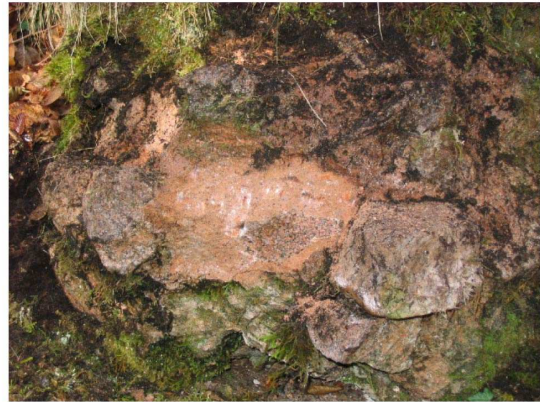
St007001026, détail du premier contrefort de l'aqueduc de Montjeu (L.B.)
