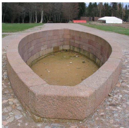
Vue vers le nord du bassin-citerne St013002007 (L.B.)
