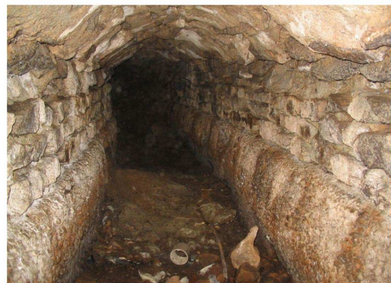
Intérieur de l'aqueduc de Montjeu, vue vers l'ouest (L.B.)
