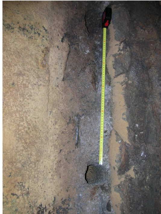
Cn007004177, égout, trous de coffrage au départ de la voûte (L.B.)
