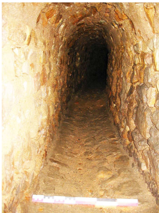
St007004196, égout, vue intérieure (L.B.)
